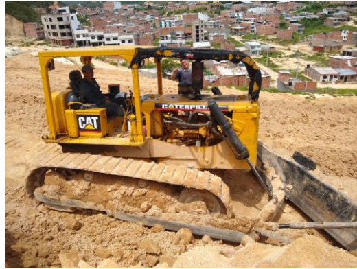
Figura 4. Bulldozer D6B-44A CATERPILLAR Fuente: Autor (2019).
