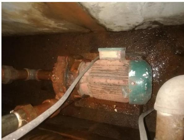
*Figura 34.* Bomba de agua fría #2. Oxidada y sucia, perteneciente al acopio en Astrea-Cesar
