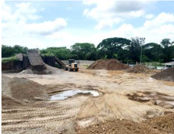
Figura 8. Acopio y pilas de almacenamiento
