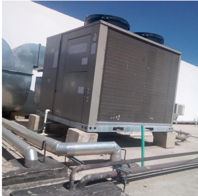
*Figura 14.* Aire central - tipo paquete. Fuente. (Elaboración propia.2020)
