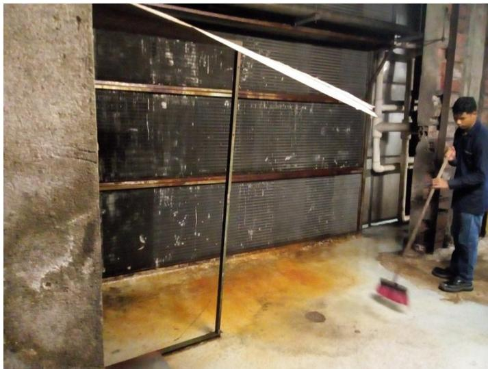
*Figura 3. Evaporadores. Fuente. (Kryotec servicios S.A.S)*
