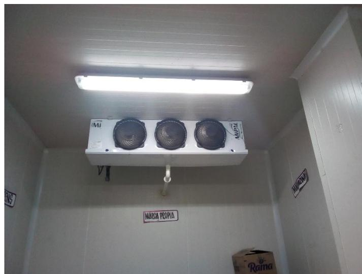
*Figura 12.* Evaporador. Fuente. (Kryotec servicios S.A.S).
