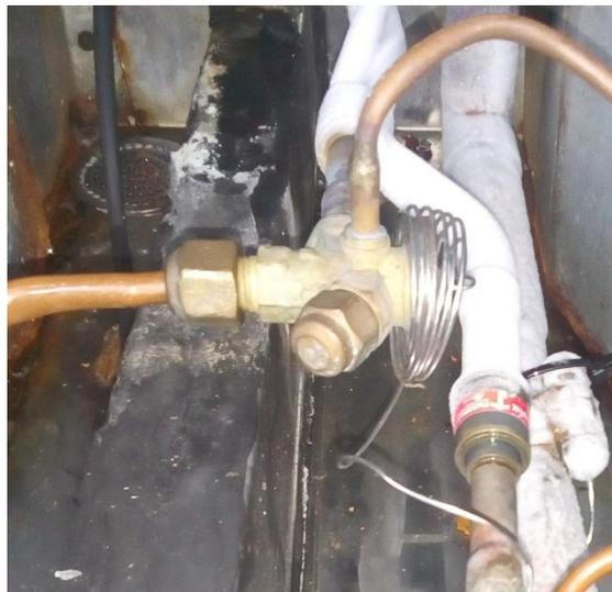
*Figura 5.* Válvula de expansión. Fuente. (Kryotec servicios S.A.S).
