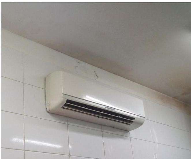
*Figura 15.* Evaporador de Mini Split. Fuente. (Elaboración propia. 2020).
