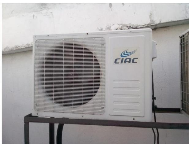
*Figura 16.* Condensadora del Mini Split. Fuente. (Elaboración propia. 2020).
