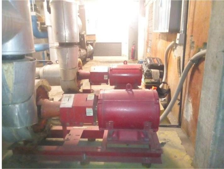
*Figura 7.* Bomba de agua fría. Fuente. (Kryotec servicios S.A.S).
