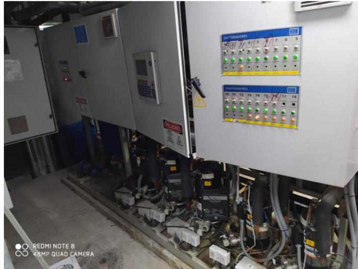
*Figura 8.* Rack de frío. Fuente. (Kryotec servicios S.A.S).
