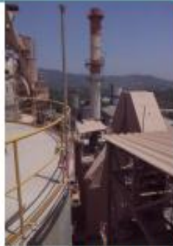
Cambio de tramo Chimenea
