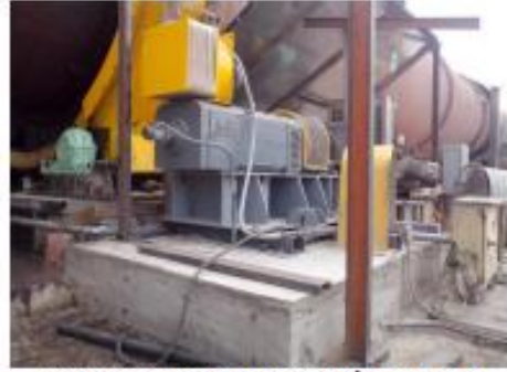
Base de motor, posición actual (lado norte)
