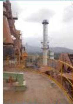
Cambio de tramo Chimenea
