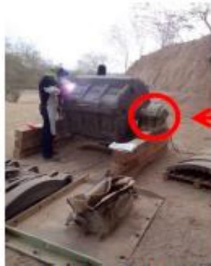
Refuerzo de soldadura
