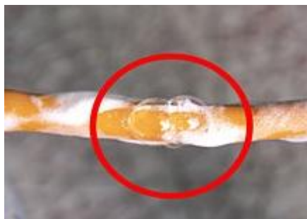
Figura 24. Fuga de gas en manguera detectada por medio de la prueba de agua jabonosa.
