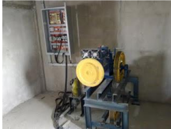
Fotografias 19. Sala de maquinas terminada.
