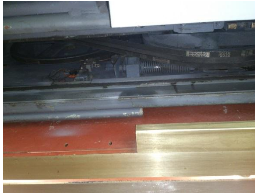
Fotografia 17. Mecanismo que realiza la apertura de las puertas.
