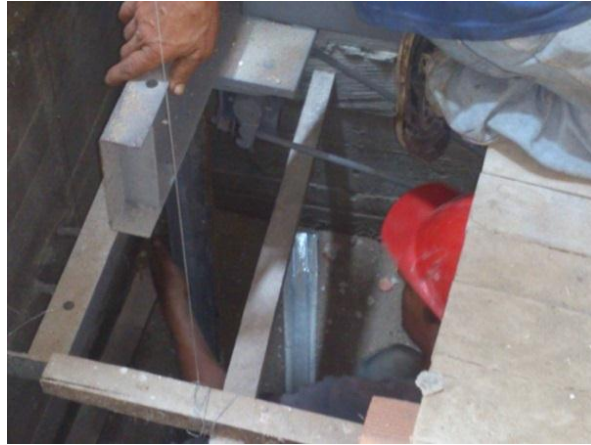
Fotografia 15. Instalando mordazas del sistema de freno o paracaídas.
