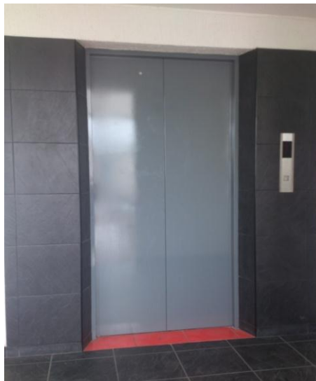
Fotografia 16. Puertas de acceso a cabina.
