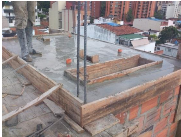
Fotografia 3. Placa sala de maquinas.
