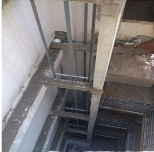
Fotografía 11. Rieles instalados en el foso del ascensor
