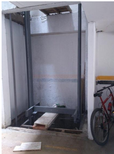
Fotografía 14. Instalando el chasis de la cabina adentro del foso.
