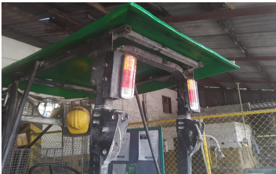
Figura 24. Adecuaciones eléctricas en la maquinaria. Fuente: Autor del proyecto.
