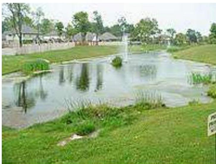
*Nota.* Ejemplo de aplicación de un estanque de detención. Reproducido de: “The Suds Manual”, CIRIA, 2015. Obra de dominio público con fines no comerciales CC-BY-NC.
