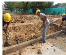
Antes de la extensión del material seleccionado se realiza recorrido para observar la subrasante e identificar posibles afectaciones. El extendido del material se lleva a cabo de forma progresiva, en capas que permitan obtener espesores compactos no mayores de 40 cm; El material seleccionado se extiende configurando un volumen uniforme. A lo largo del proceso, se verifican los niveles definidos en el replanteo topográfico.
