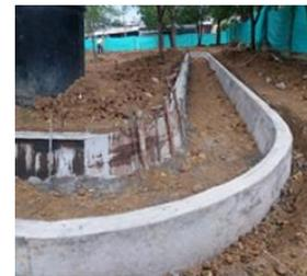
Se verifican los niveles y las dimensiones para poder realizar la construcción de la estructura de forma correcta. Se ejecuta la actividad de armado y colocación del acero de refuerzo, para posterior vaciado del concreto según el control de calidad, se verifica asentamiento de la mezcla por medio del cono de Abraham según la tolerancia
