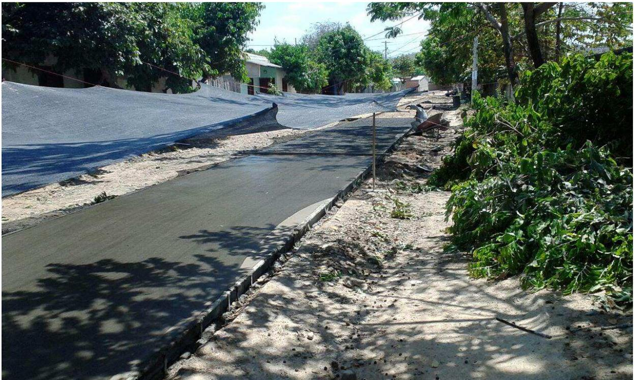
**Foto 18 Concreto acabado con proceso de curado y polisombra para control de temperatura calle 9 con carrera 6 -6ª**
