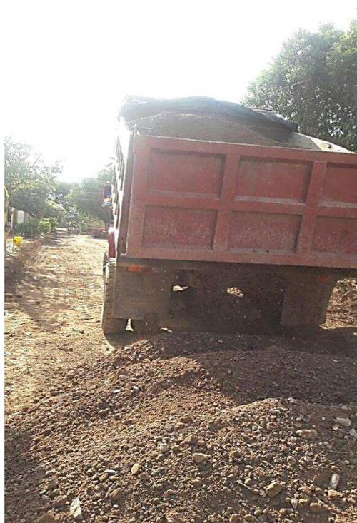
**Foto 04. Extensión de Subbase Nivelada calle 9 entre carreras 4 y 6**
