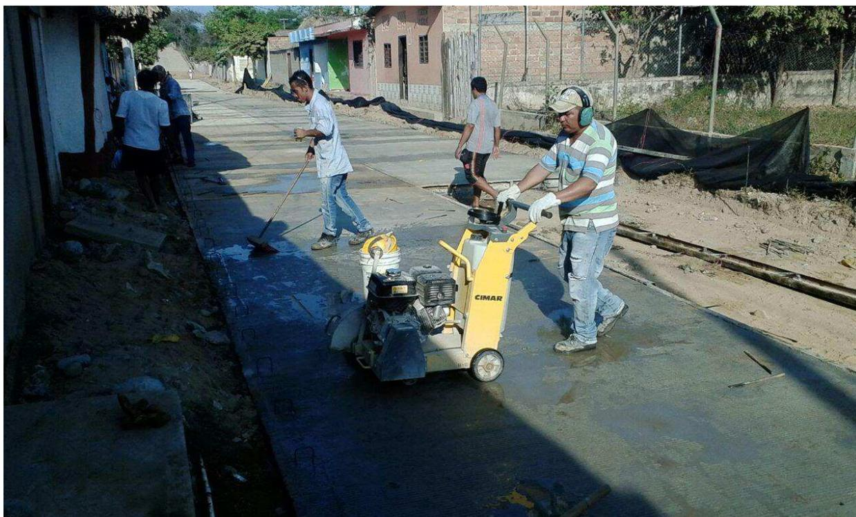
**Foto 16** corte y sellado de juntas en pavimentos de concreto calle 9 con carrera 5
