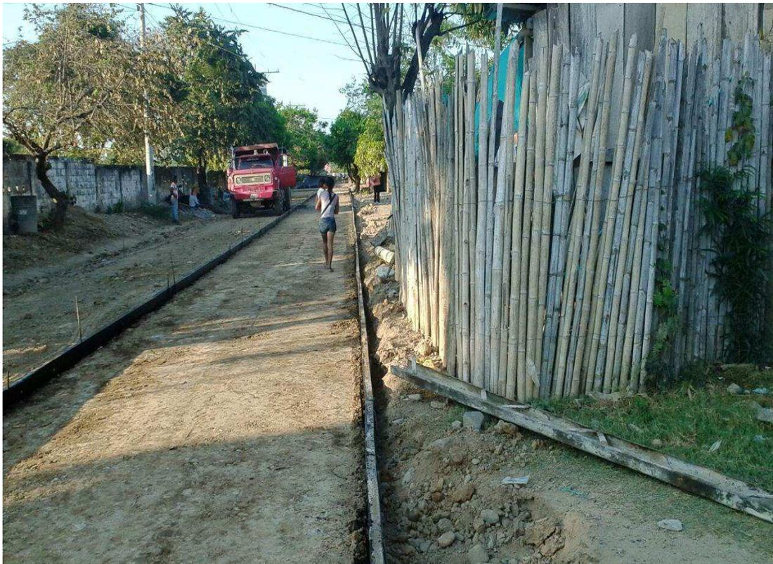
**Foto 06. Subbase Nivelada y Compactada calle 9 entre carreras 5 y 6**
