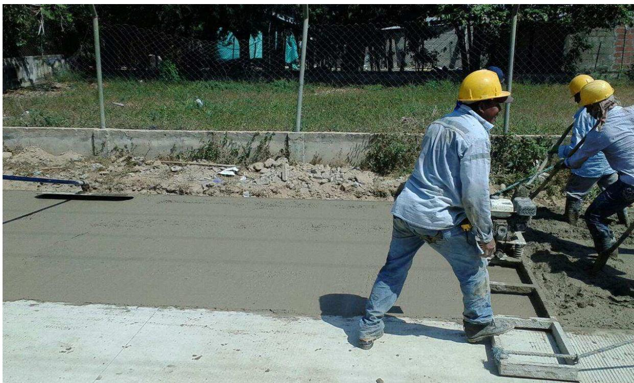
**Foto 10** Vibrado de la mezcla de Concreto, calle 9 con carrera 5
