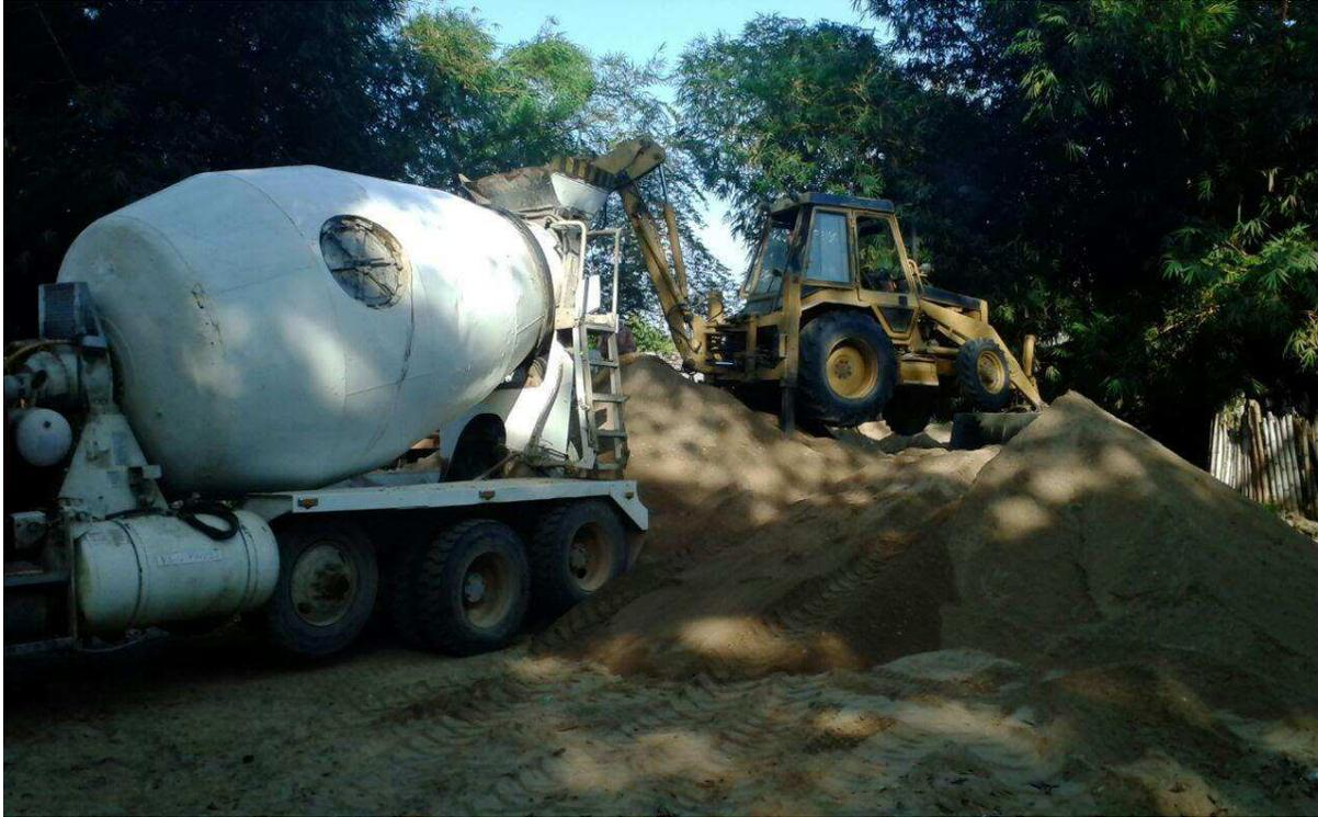
**Foto 07 Preparación de Mezcla de Concreto en Mixer de 7 m3,**
