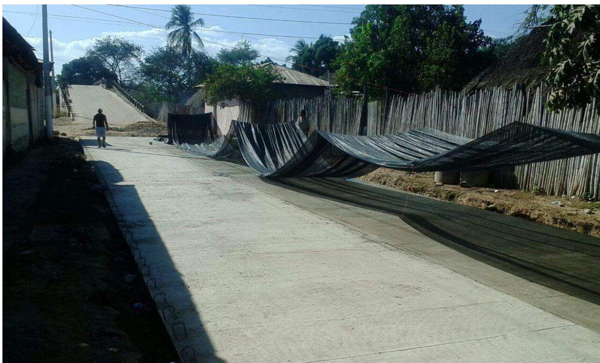
**Foto 12 Polisombra utilizado para control de temperatura calle 9 carreras 2 y 3**
