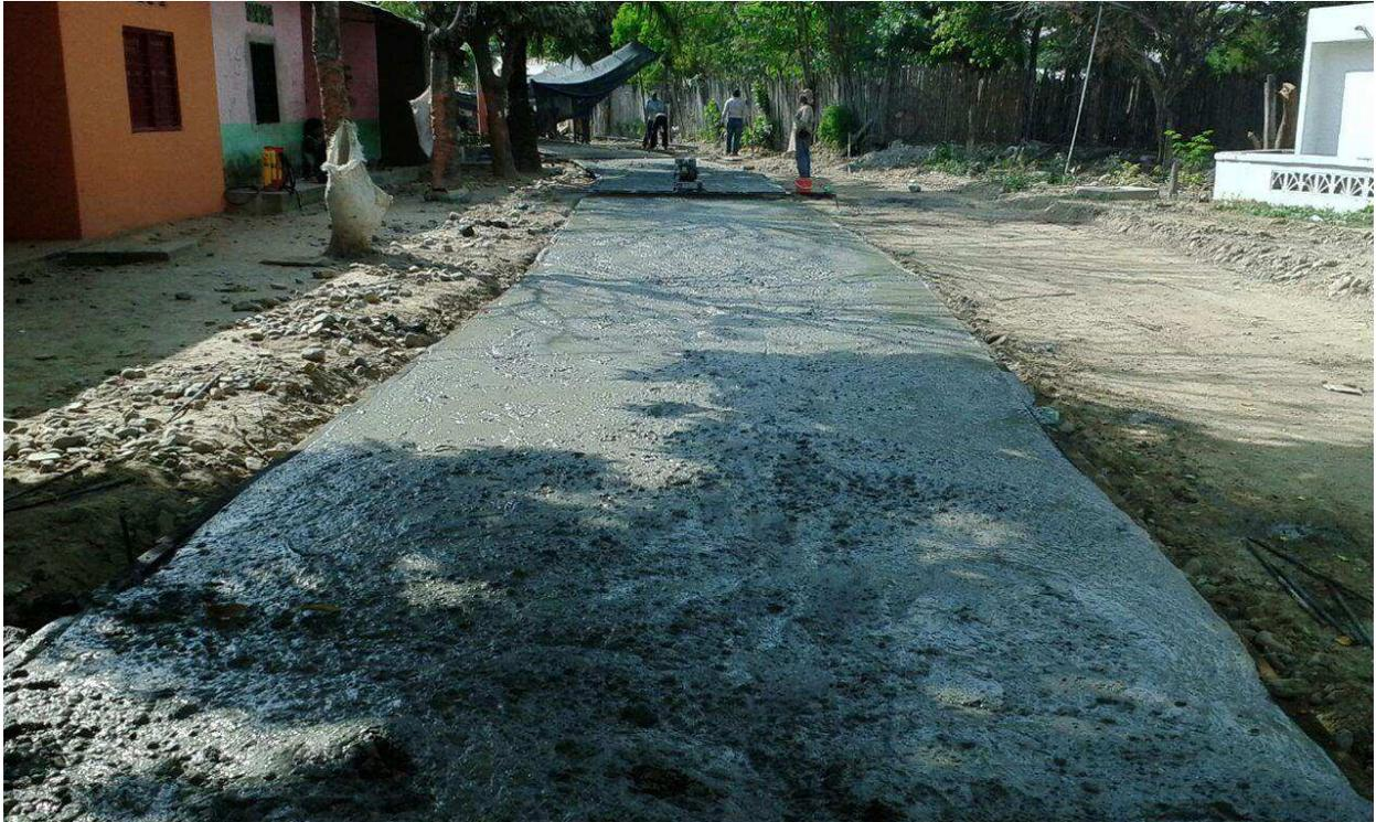
**Foto 17 Mezcla de Concreto colocada pendiente de realizar el vibrado calle 9 con carrera 6**
