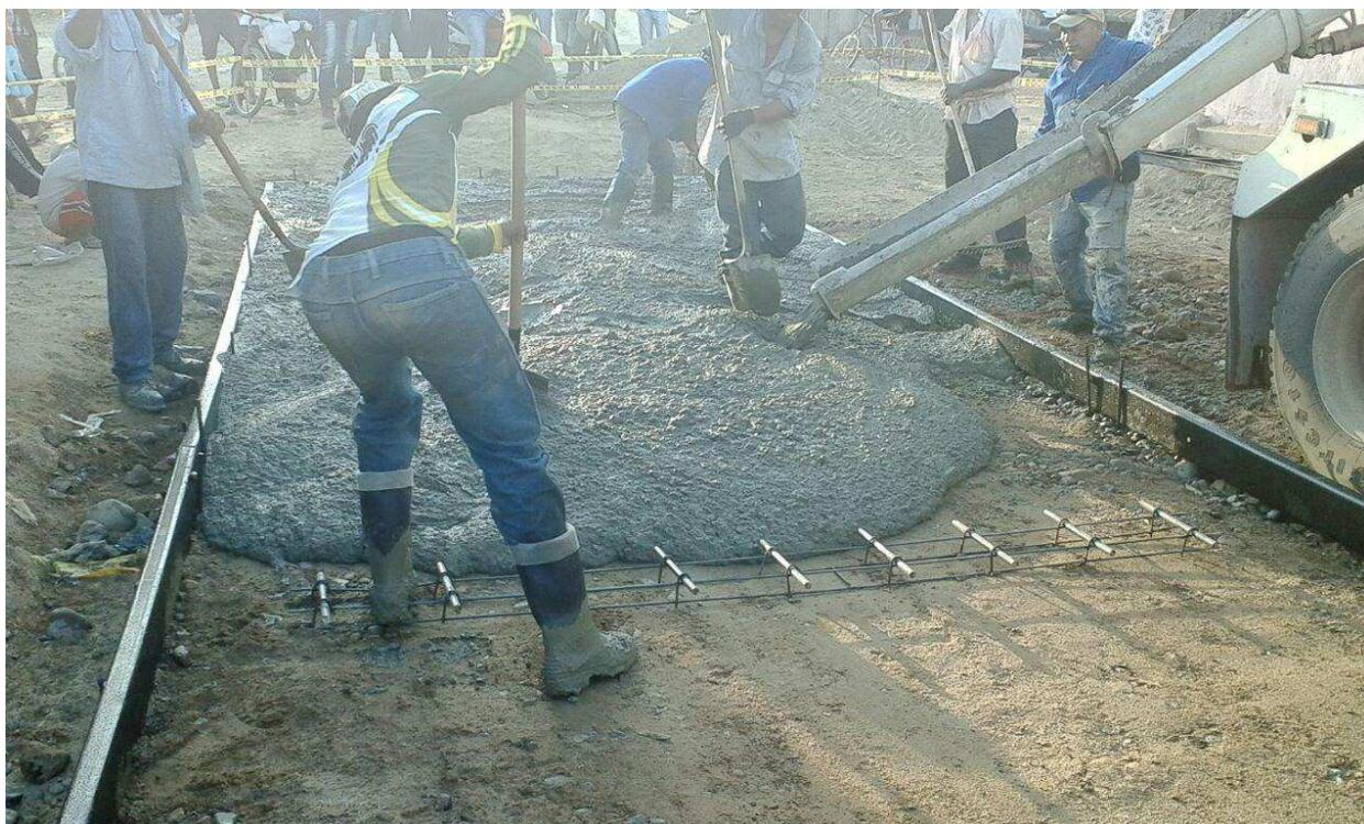
**Foto 09** Extendida de la mezcla de Concreto, calle 9 con carrera 5
