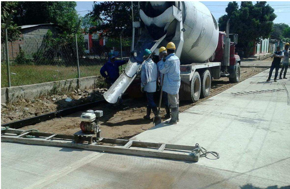
**Foto 08 Suministro y Colocación de la mezcla de Concreto, calle 9 con carrera 5**
