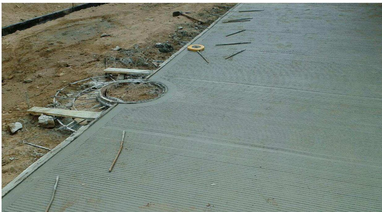
**Foto 22 Detalle refuerzo para pozo de inspección calle 9 carreras 4-5**
