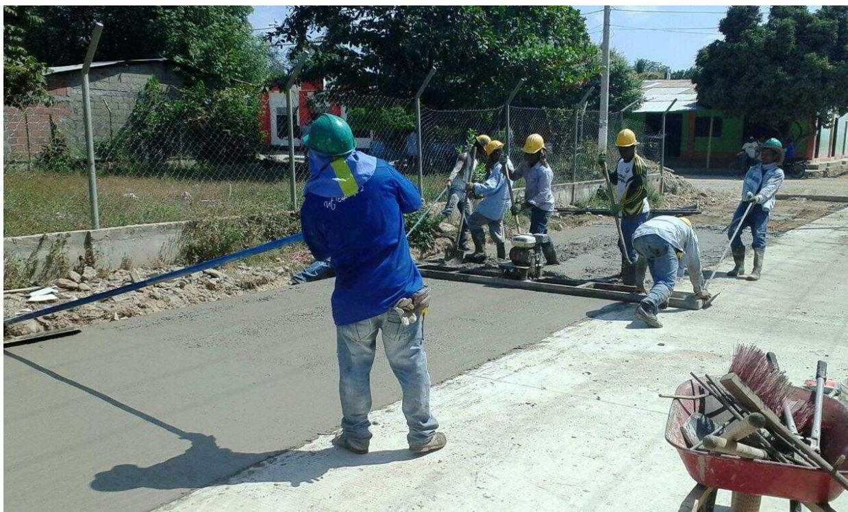
**Foto 11 Vibrado y Acabado de la mezcla de Concreto, calle 9 con carrera 5**
