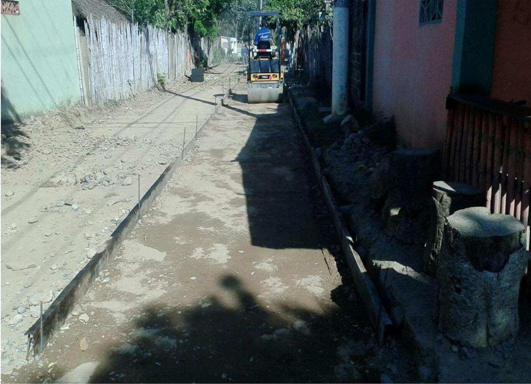
**Foto 05. Compactación de Subbase granular calle 9 entre carreras 3 y 4**
