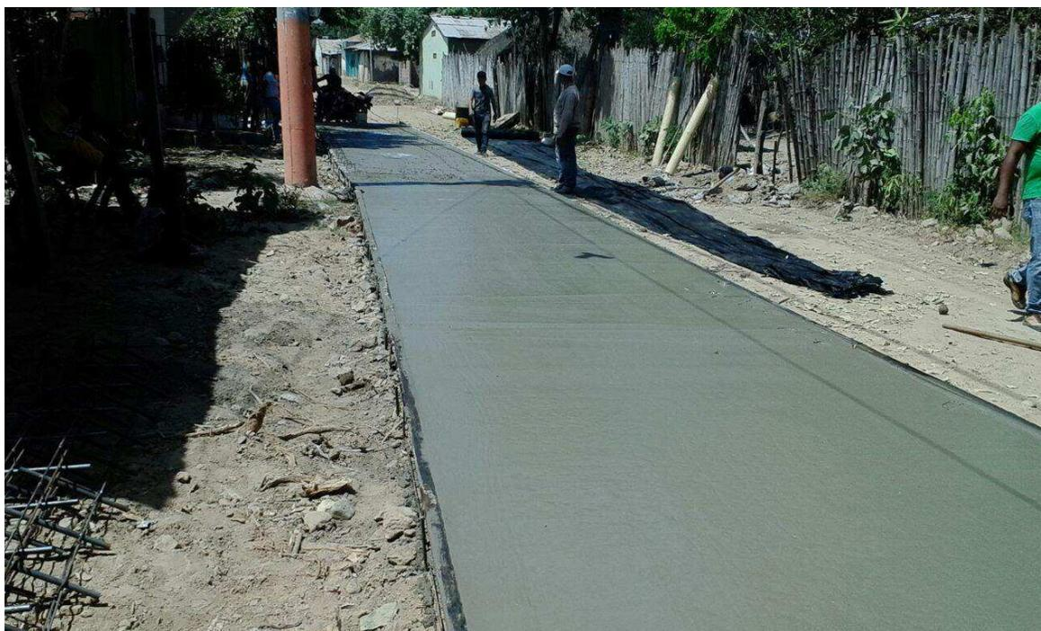
**Foto 15** Concreto colocado en un carril para luego realizar los cortes de las juntas calle 9 carreras 3-4
