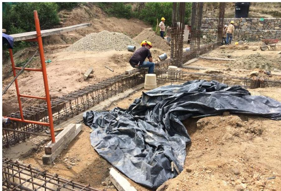
**Figura 39. Instalación de acero de refuerzo en vigas de cimentación (Eje J).**
