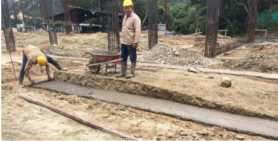
**Figura 35. Concreto de saneamiento para vigas de cimentación.**
