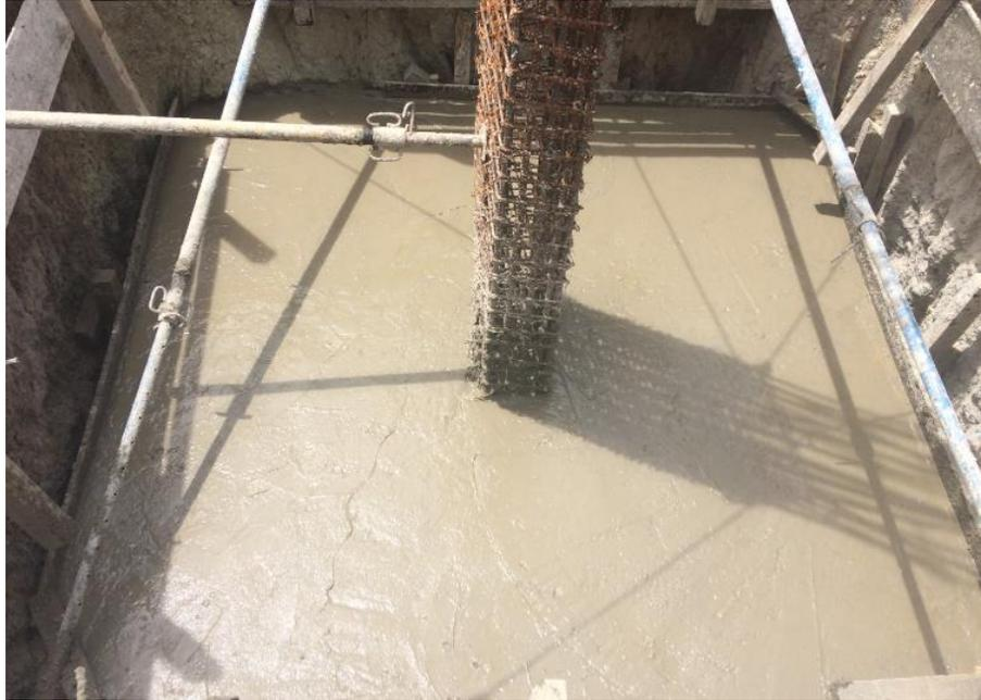
**Figura 61. Concreto para elemento estructural zapatas, nivelación de superficie.**
