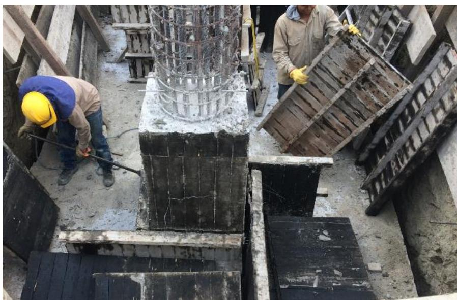
**Figura 66. Concreto para elemento estructural pedestales, desencofrado, acabado final del elemento.**
