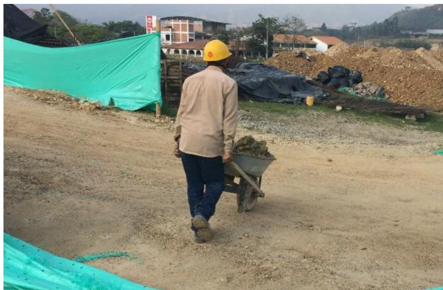
**Figura 32. Traslado manual de material de excavación.**
