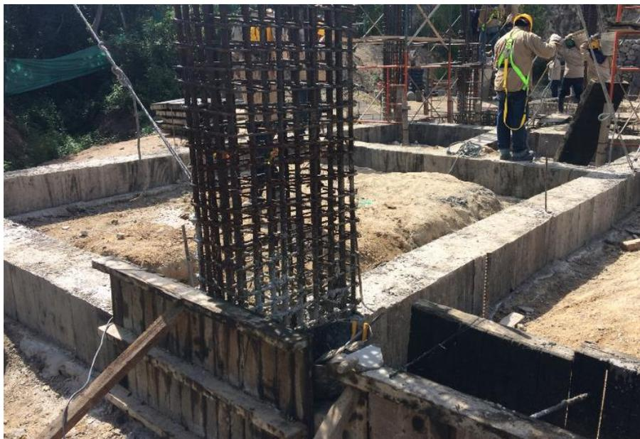
**Figura 69. Concreto para elemento estructural vigas de amarre, desencofrado, acabado final de viga.**
