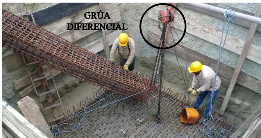
**Figura 45. Instalación de acero de refuerzo en columnas y pedestales.**
