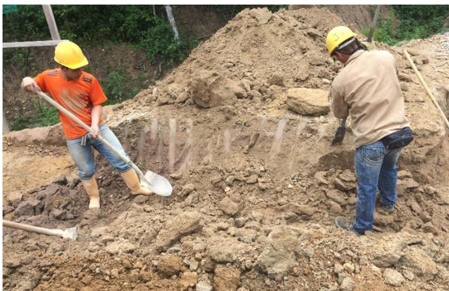
**Figura 50. Excavación para vigas de cimentación (Eje J).**
