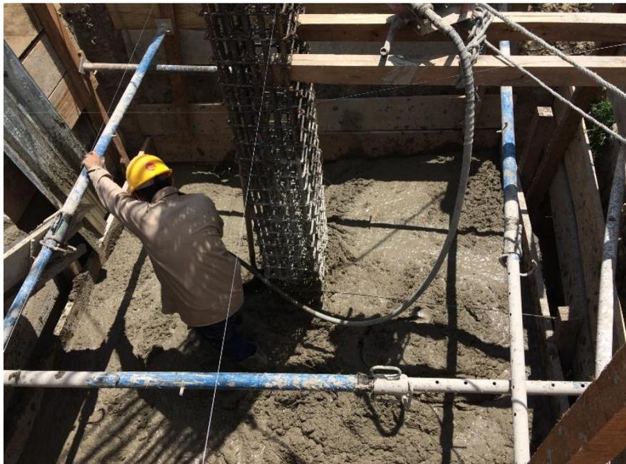
**Figura 60. Concreto para elemento estructural zapatas, distribución del concreto y vibrado.**
