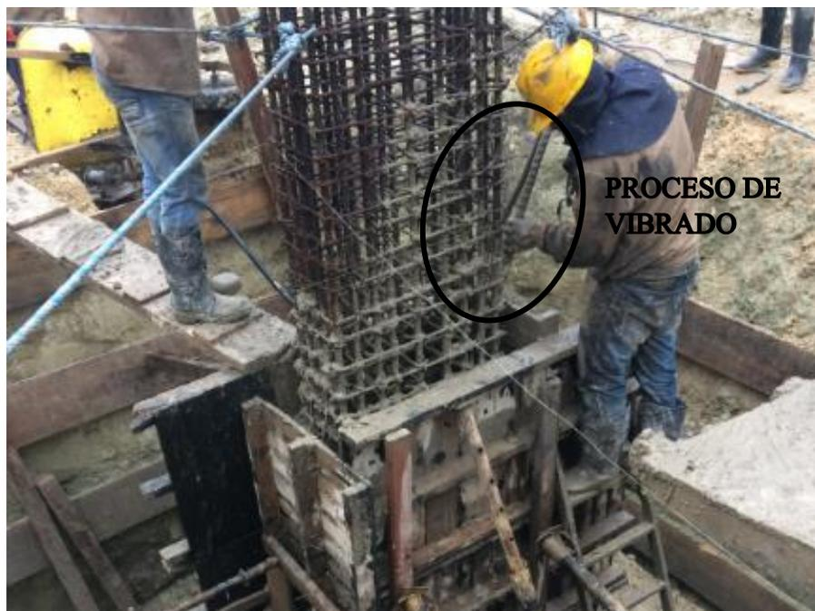
**Figura 65. Concreto para elemento estructural pedestales, vibrado del concreto.**
