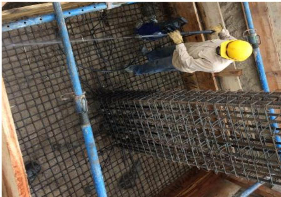
**Figura 57. Concreto para elemento estructural zapatas, limpieza de material contaminante.**
