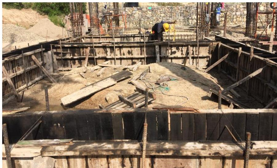
**Figura 67. Concreto para elemento estructural vigas de amarre, instalación de formaleta, se observa fijación del encofrado.**
