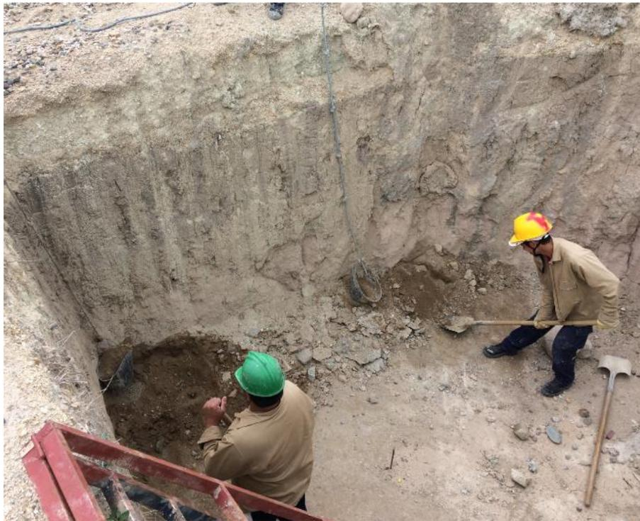
**Figura 47. Excavación manual para zapatas, replanteo.**
