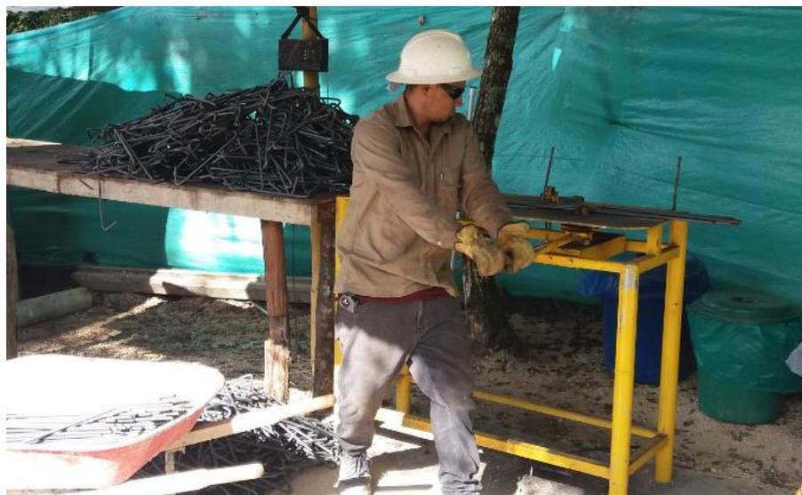
**Figura 38. Figurado de acero de refuerzo para vigas de cimentación.**
