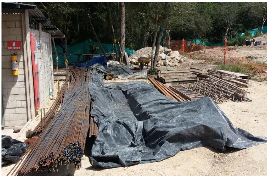
**Figura 77. Almacenamiento del acero de refuerzo.**
