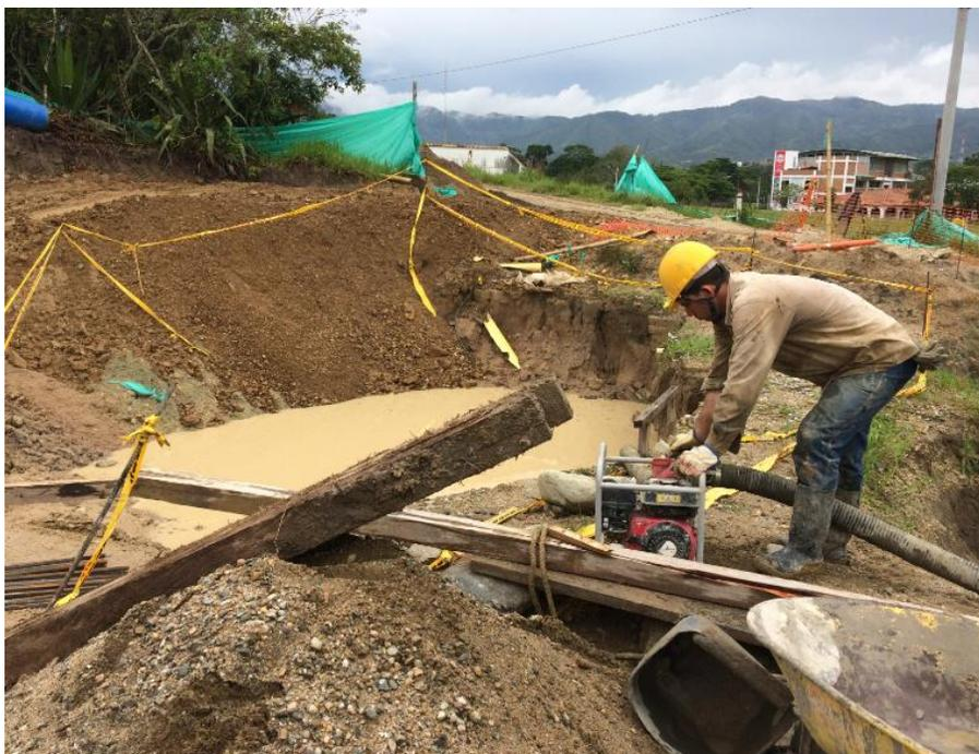
**Figura 13. Bombeo de aguas estancadas provenientes de lluvias fuertes.**
