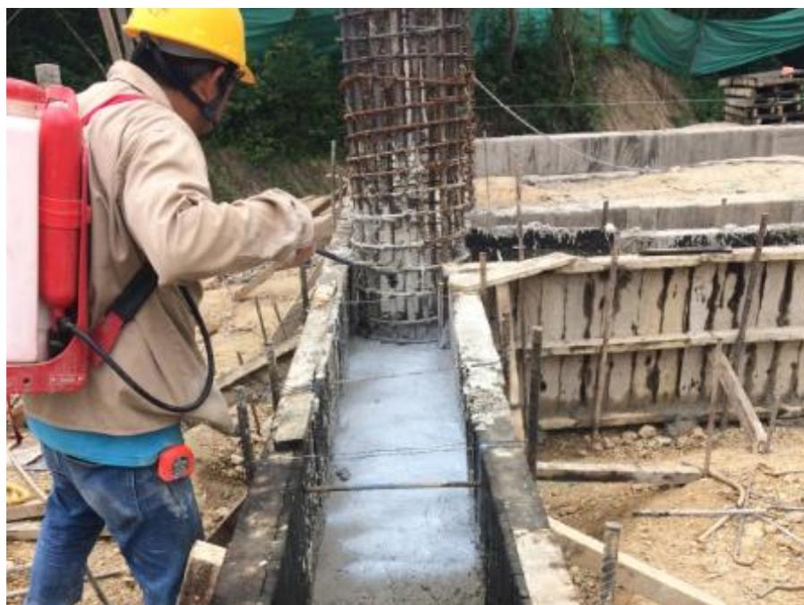
**Figura 72. Aplicación de curador de concreto, elemento estructural vigas de amarre.**
