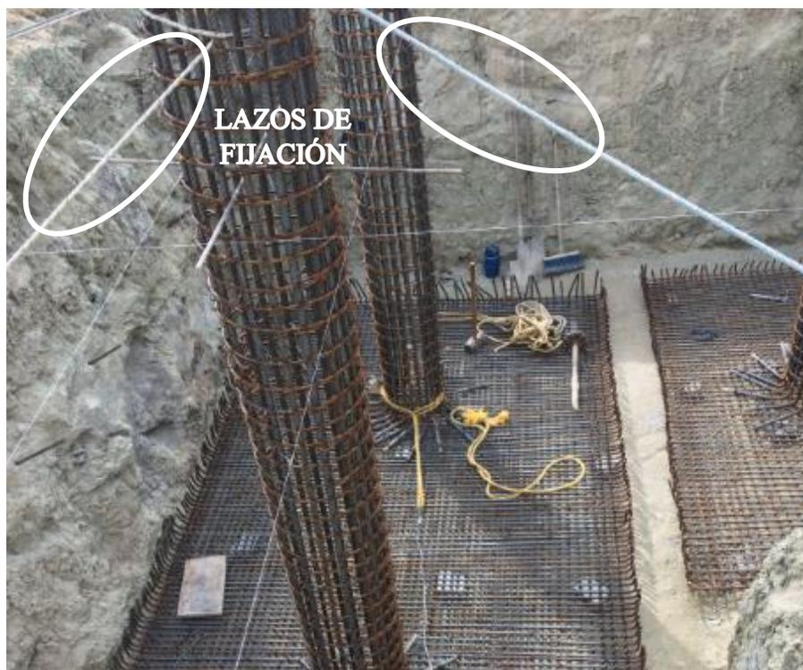
**Figura 46. Instalación de acero de refuerzo en columnas y pedestales.**
