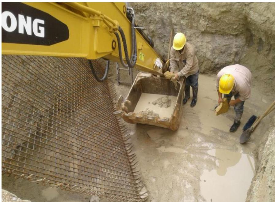
**Figura 10. Limpieza en excavaciones debido a lluvias, desprendimiento de material.**
