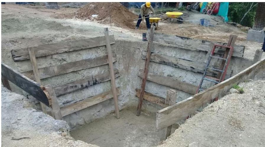
**Figura 51. Entibado para excavación, instalación de tableros en las 4 caras de la excavación.**
