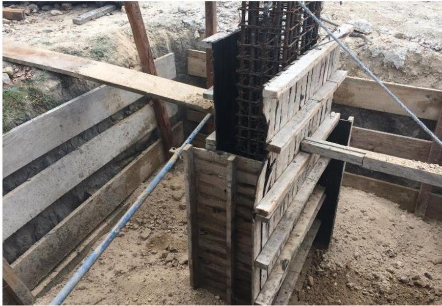
**Figura 62. Concreto para elemento estructural pedestales, instalación de formaleta.**
