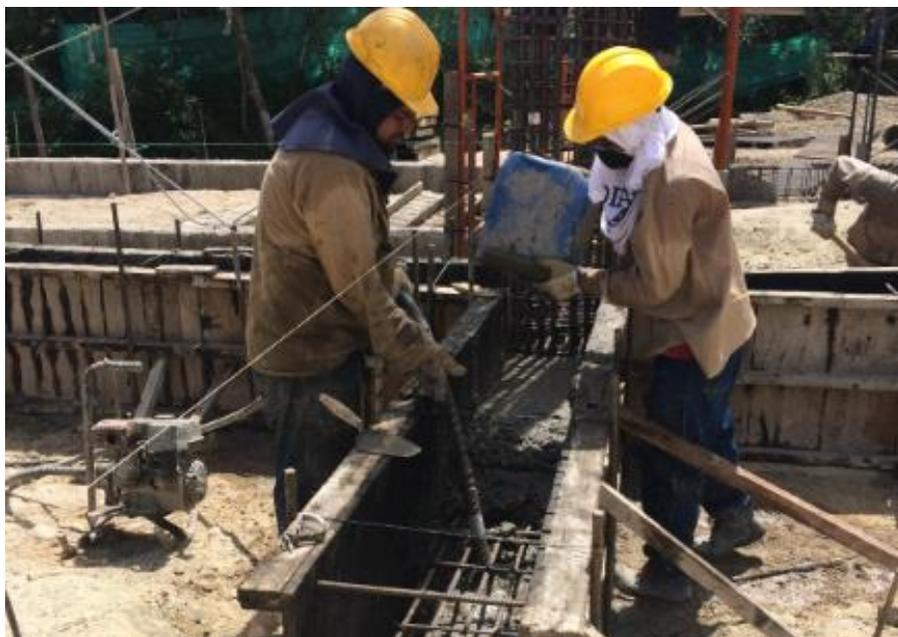
**Figura 68. Concreto para elemento estructural vigas de amarre, vaciado y vibrado del concreto.**
