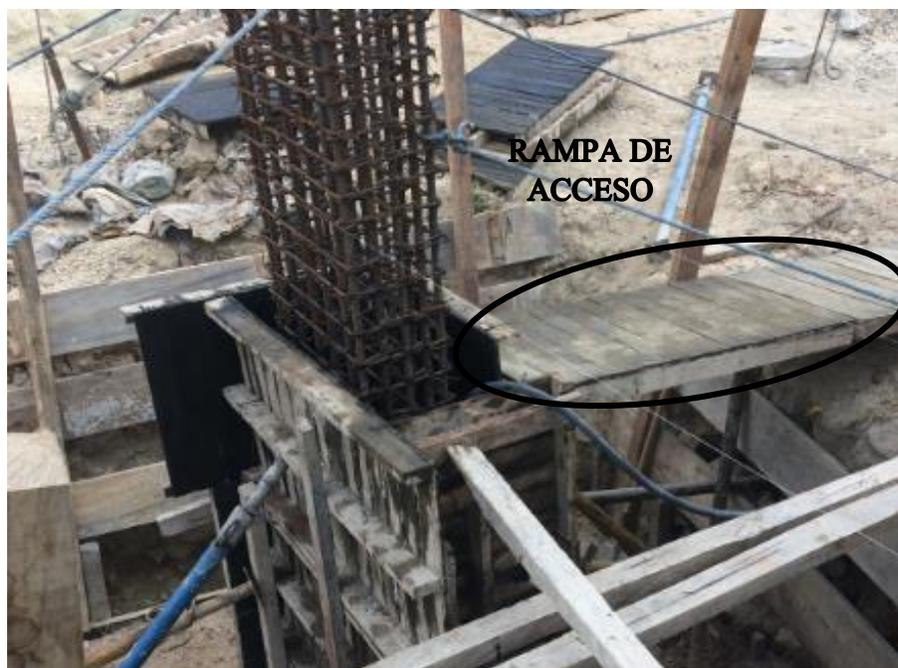
**Figura 63. Concreto para elemento estructural pedestales, ubicación de rampa de acceso.**
