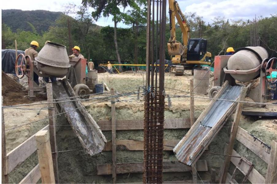
**Figura 59. Concreto para elemento estructural zapatas, transporte en canaletas.**
