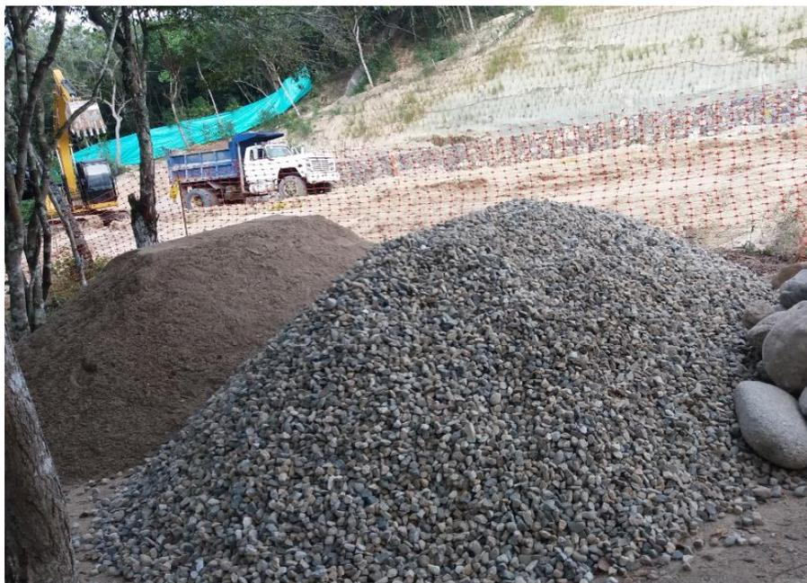
**Figura 79. Almacenamiento de agregados fino y grueso.**
