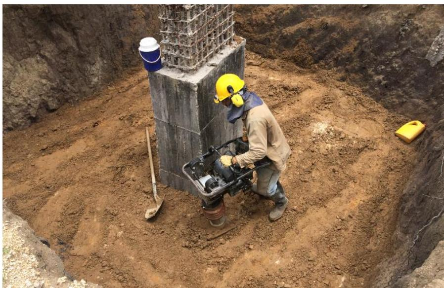
**Figura 55. Relleno compactado, compactación del terreno, utilización de vibro compactador manual tipo canguro.**
