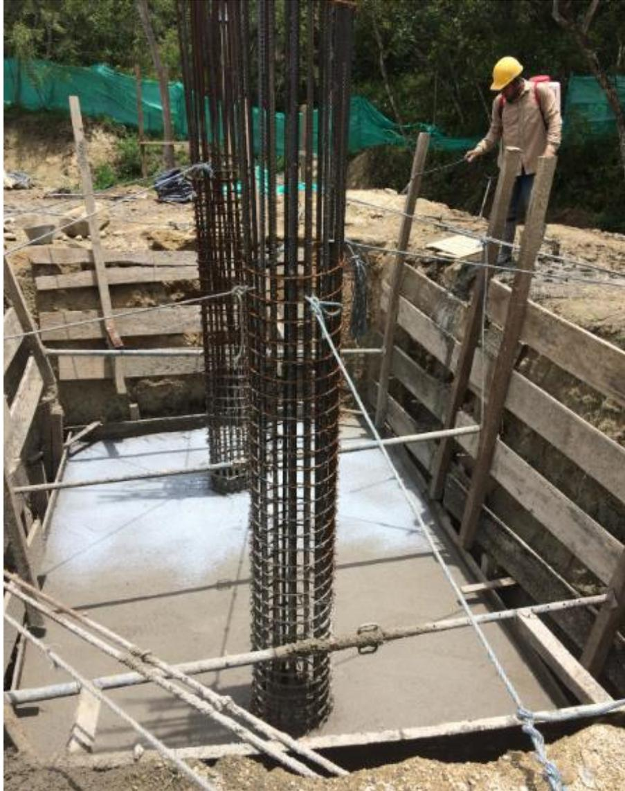
**Figura 70. Aplicación de curador de concreto, elemento estructural zapata.**
