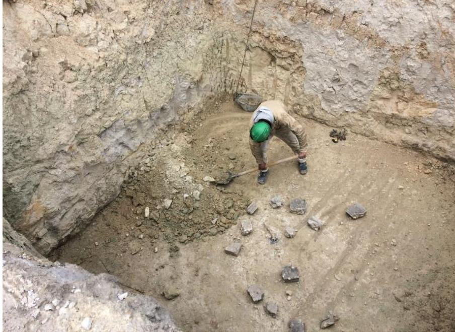
**Figura 48. Excavación manual para zapatas, remoción de material desprendido.**
