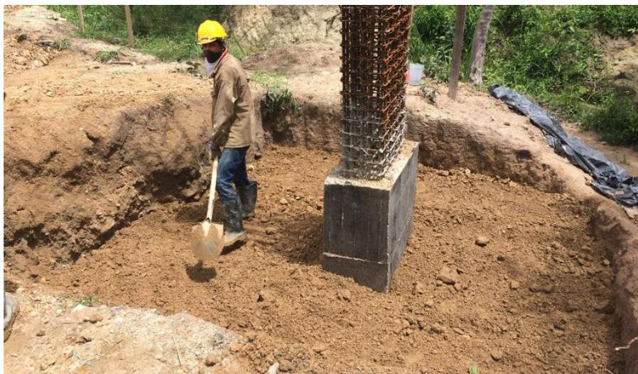
**Figura 54. Relleno compactado, distribución del material en capas de 15cm.**
