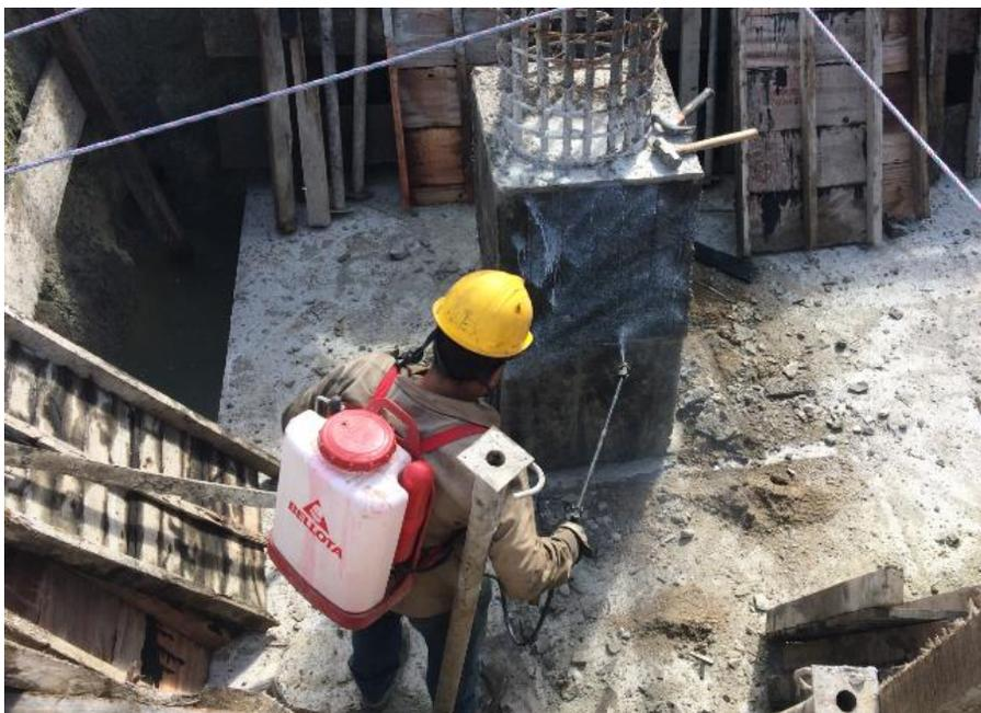
**Figura 71. Aplicación de curador de concreto, elemento estructural pedestal.**
