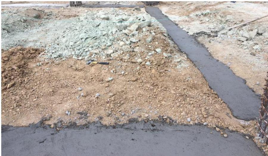
**Figura 34. Concreto de saneamiento para vigas de cimentación.**
