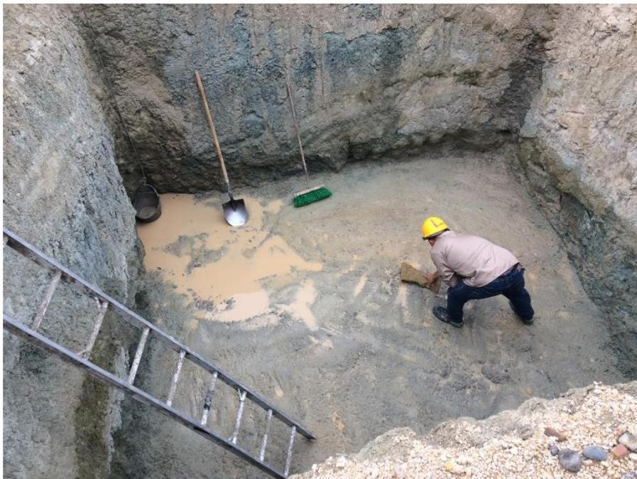
**Figura 12. Limpieza de lodos base de cimentación.**
