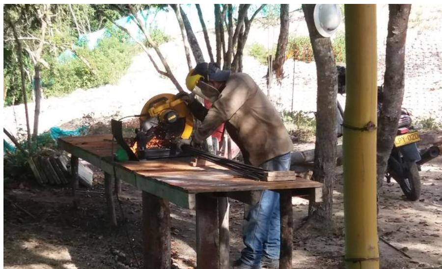
**Figura 42. Corte de acero de refuerzo para columnas y pedestales.**
