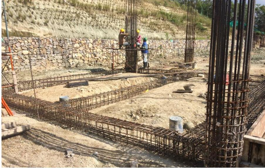
**Figura 40. Instalación de acero de refuerzo en vigas de cimentación (Ejes 1-2-3).**
