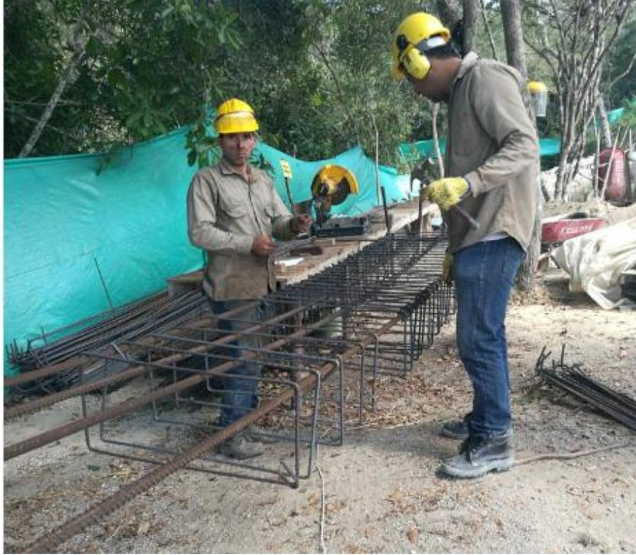
**Figura 44. Amarrado de acero de refuerzo para columnas y pedestales.**
