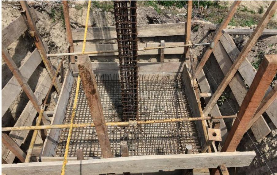
**Figura 58. Concreto para elemento estructural zapatas, instalación de formaleta.**
