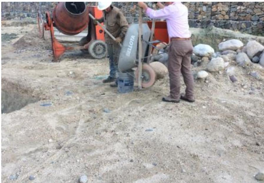
**Figura 14. Medida de dosificación de materiales pertinente al diseño de mezclas suministrado.**
