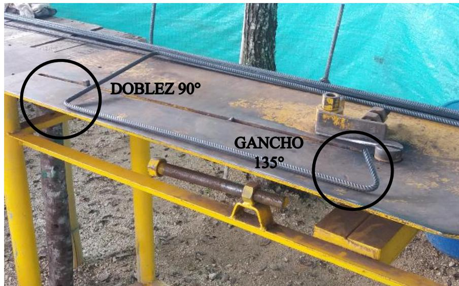
**Figura 43. Figurado de acero de refuerzo para columnas y pedestales.**
