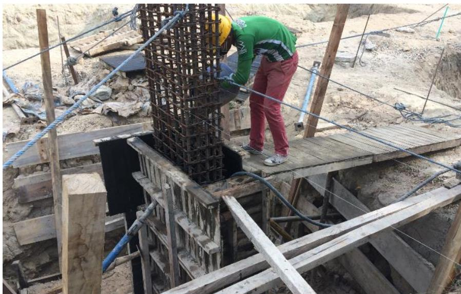
**Figura 64. Concreto para elemento estructural pedestales, vaciado y transporte del concreto.**
