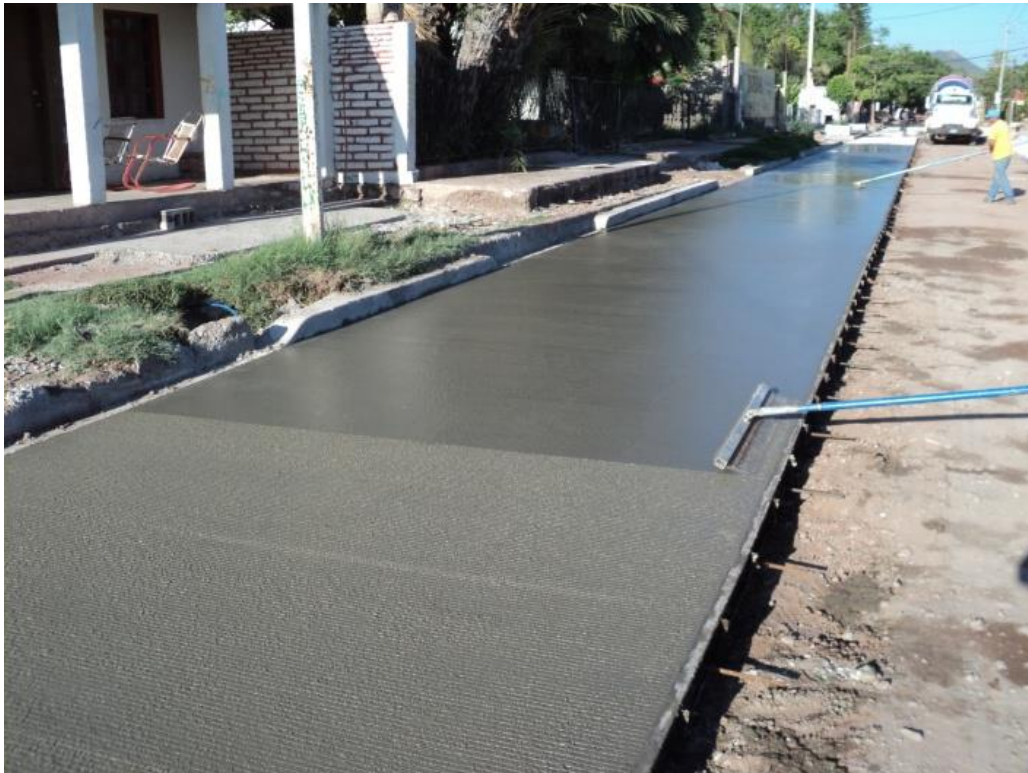
Figura 1 Construcción de Pavimento en Concreto
