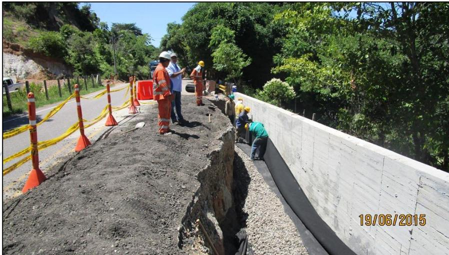
**Ilustración 54.** Desencofrado de la pantalla del muro en voladizo
