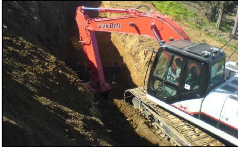
**Ilustración 22.** Excavación de terreno con retroexcavadora. Piñar, R. (2008) obtenido de: <https://repositoriotec.tec.ac.cr/bitstream/handle/2238/6034/construcci%C3%B3n-muro-gaviones.pdf?sequence=1>
