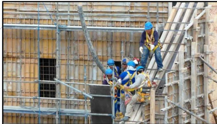
**Ilustración 52.** Vaciado de concreto en la pantalla del muro
