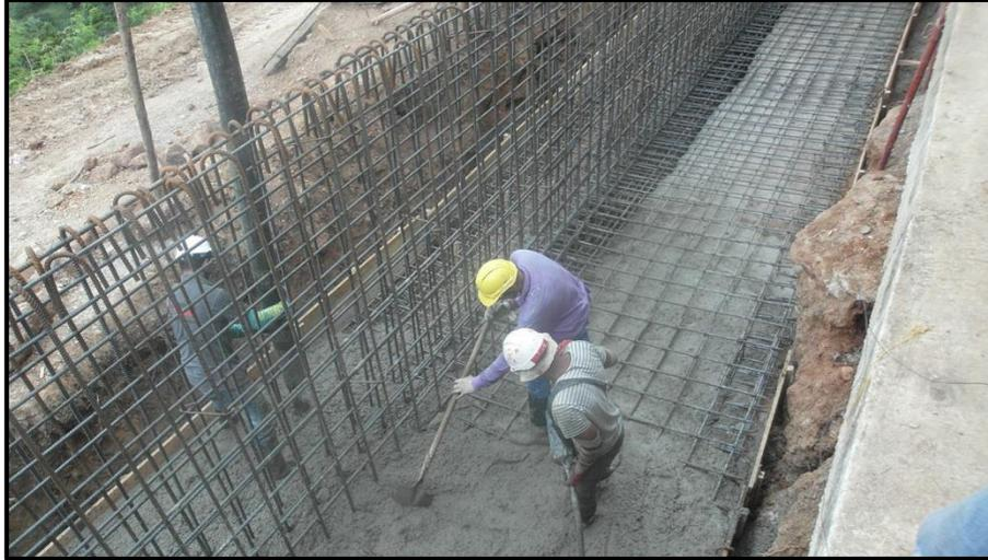
*Ilustración 50.* Vaciado de concreto en base del muro en voladizo
