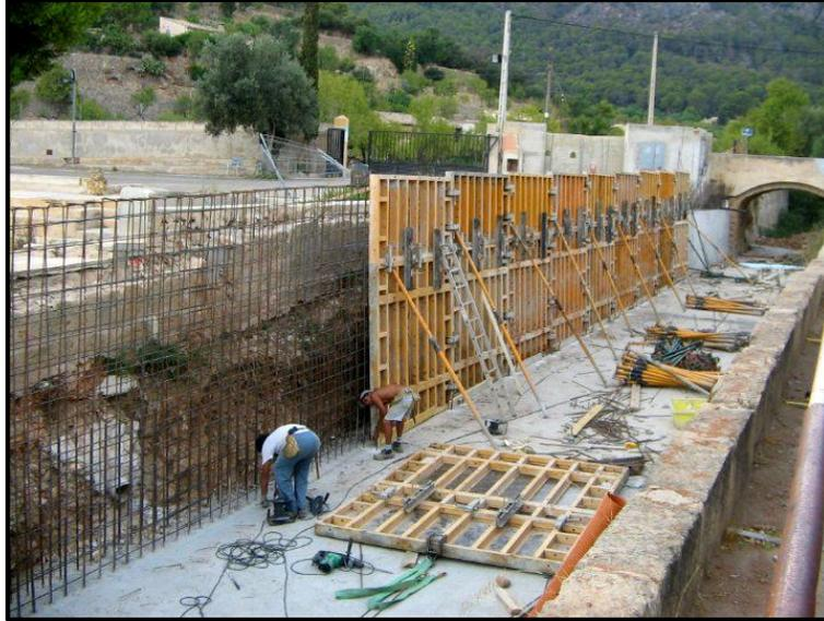
**Ilustración 51.** Encofrado de la pantalla de un muro en voladizo
