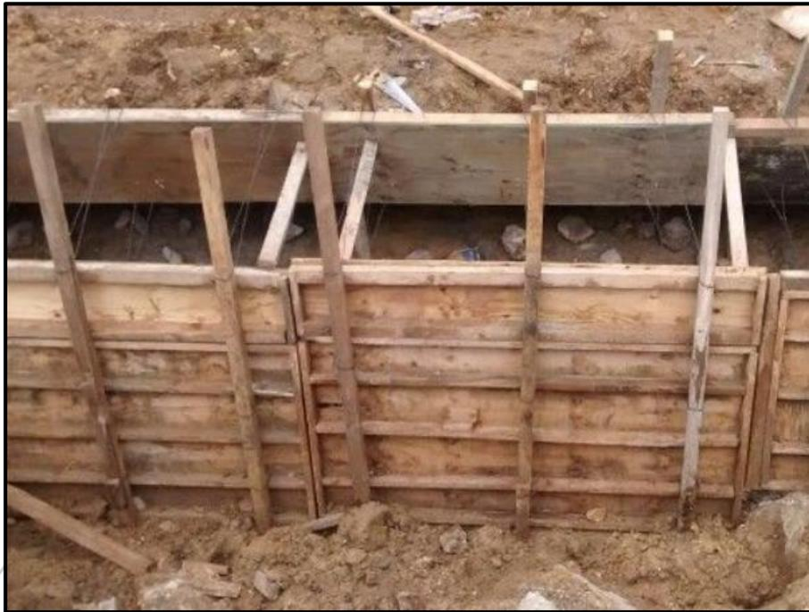
**Ilustración 11.** Formaletas de cimentación de muro ciclópeo
