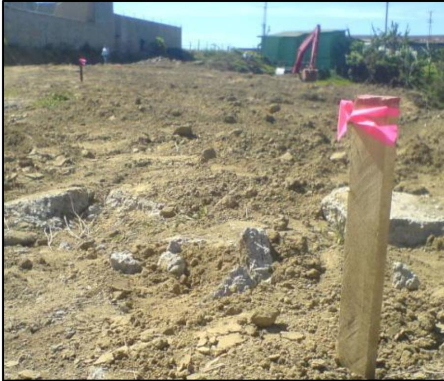
*Ilustración 21.* Replanteo de base de muro de gaviones. Piñar, R. (2008) obtenido de: <https://repositoriotec.tec.ac.cr/bitstream/handle/2238/6034/construcci%C3%B3n-muro-gaviones.pdf?sequence=1>
