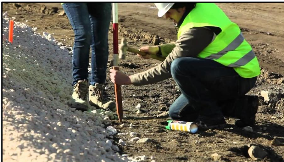
*Ilustración 8.* Replanteo de cimentación de muro de gravedad.
