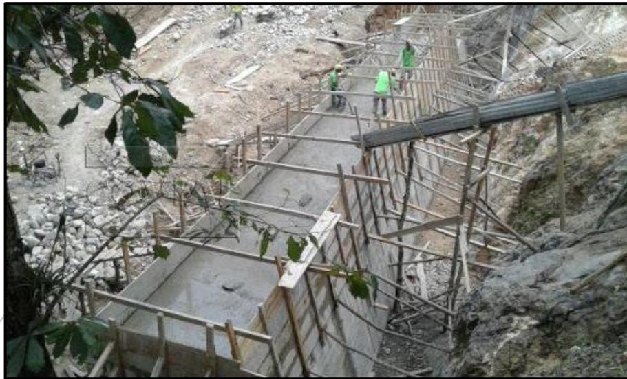
Ilustración 14. Vaciado de concreto del cuerpo de un muro ciclópeo
