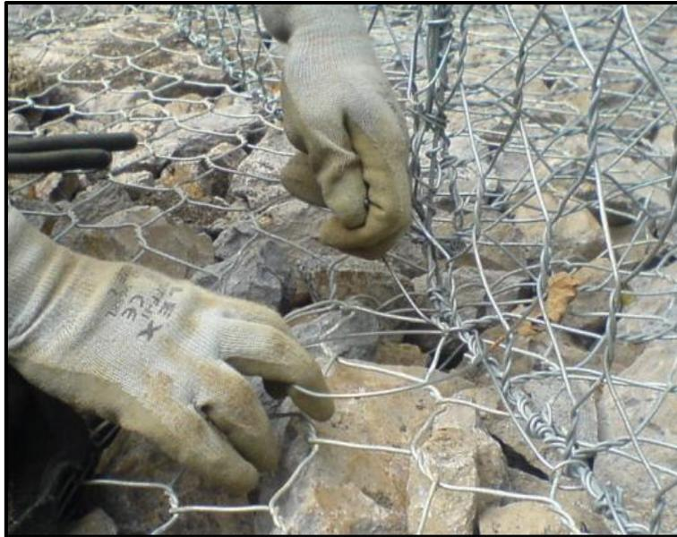
**Ilustración 31.** Amarre de las camadas superiores del gavión. Fuente: Piñar, R. (2008) obtenido de: <https://repositoriotec.tec.ac.cr/bitstream/handle/2238/6034/construcci%C3%B3n-muro-gaviones.pdf?sequence=1>
