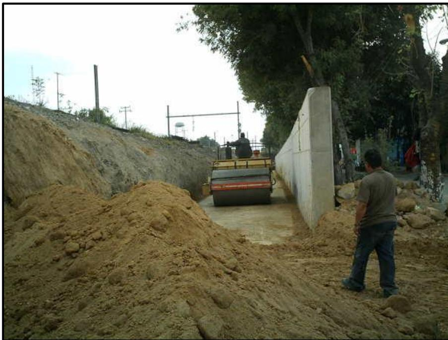
***Ilustración 55.*** Compactación del relleno de muro en voladizo
