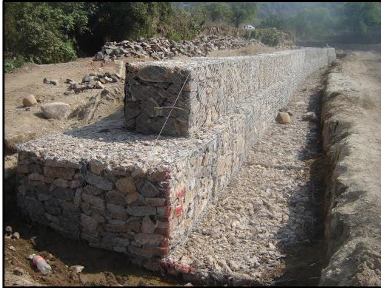
**Ilustración 32.** Gaviones uniformes y bien conformados.
