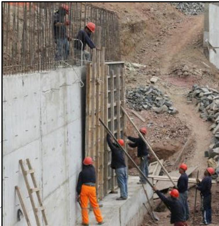
***Ilustración 53.*** Desencofrado de la pantalla del muro en voladizo
