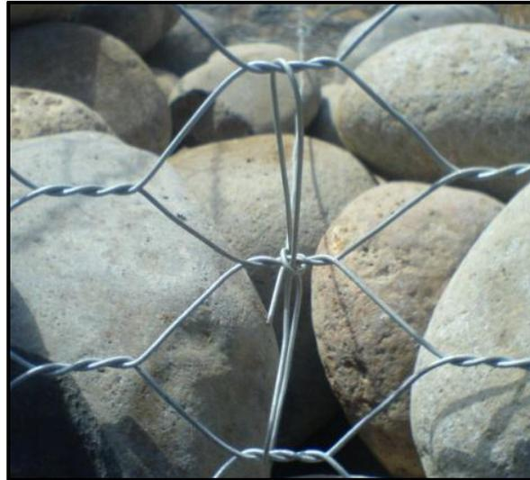
**Ilustración 27.** Instalación de tensores de gaviones. Piñar, R. (2008) obtenido de: <https://repositoriotec.tec.ac.cr/bitstream/handle/2238/6034/construcci%C3%B3n-muro-gaviones.pdf?sequence=1>
