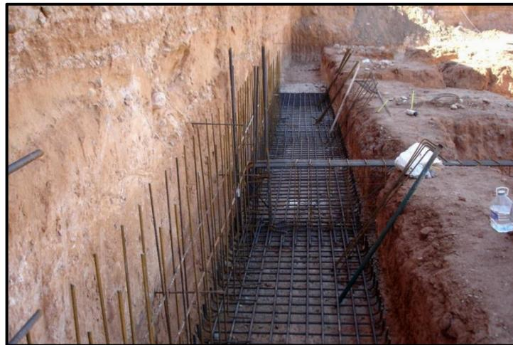
**Ilustración 48.** Armado de acero de la base del muro
