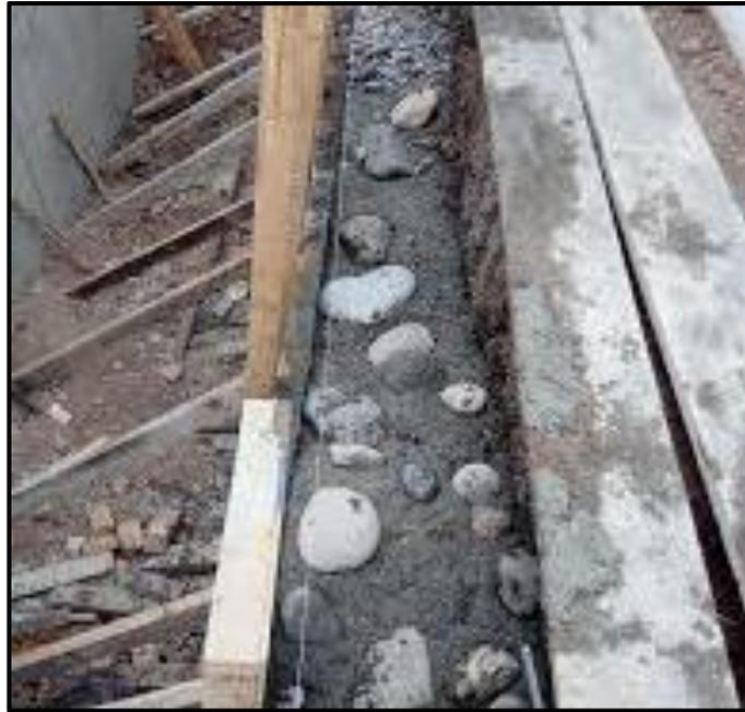
*Ilustración 12.* Vaciado de concreto en muro ciclópeo
