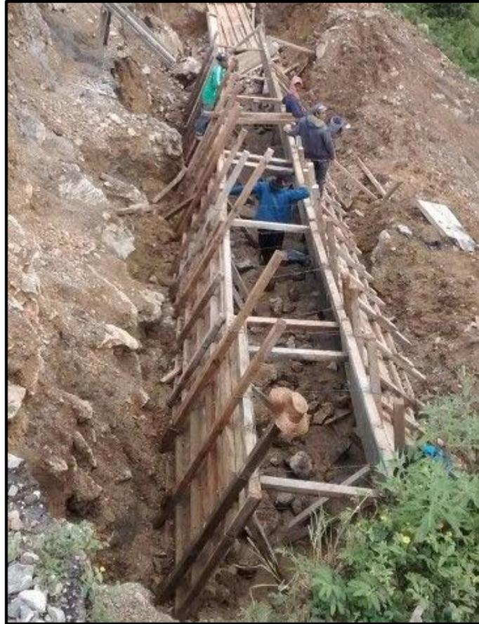
**Ilustración 13.** Encofrado del cuerpo de un muro ciclópeo
