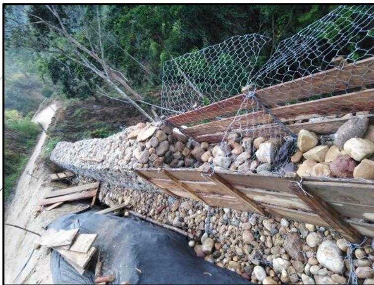
**Ilustración 29.** Geotextil para separar terreno de los gaviones.
