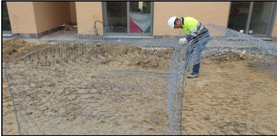
**Ilustración 25.** Armado de una unidad de gavión
