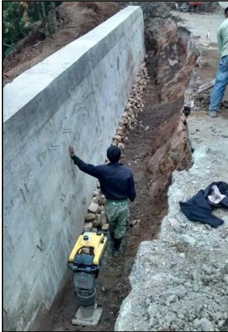
**Ilustración 16.** Compactación del relleno de muro ciclópeo
