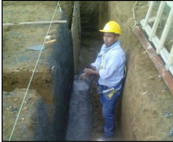
**Ilustración 47.** Mejoramiento de la base de cimentación con concreto solado
