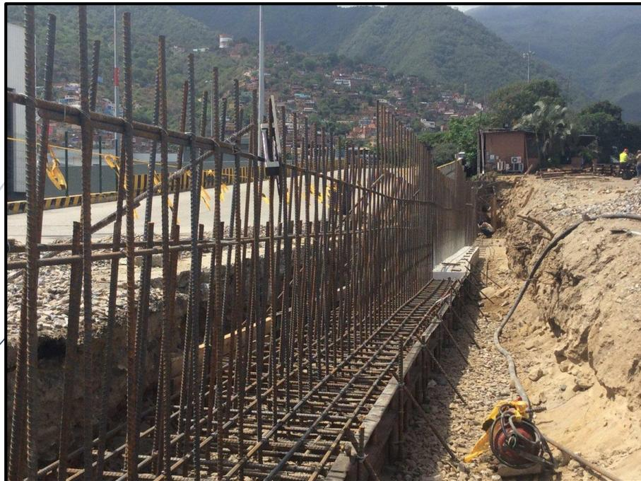
**Ilustración 49.** Encofrado de la base del muro en voladizo
