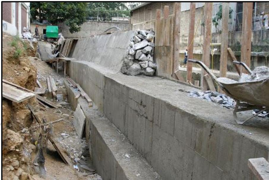
***Ilustración 15.*** Desencofrado del cuerpo de un muro ciclópeo
