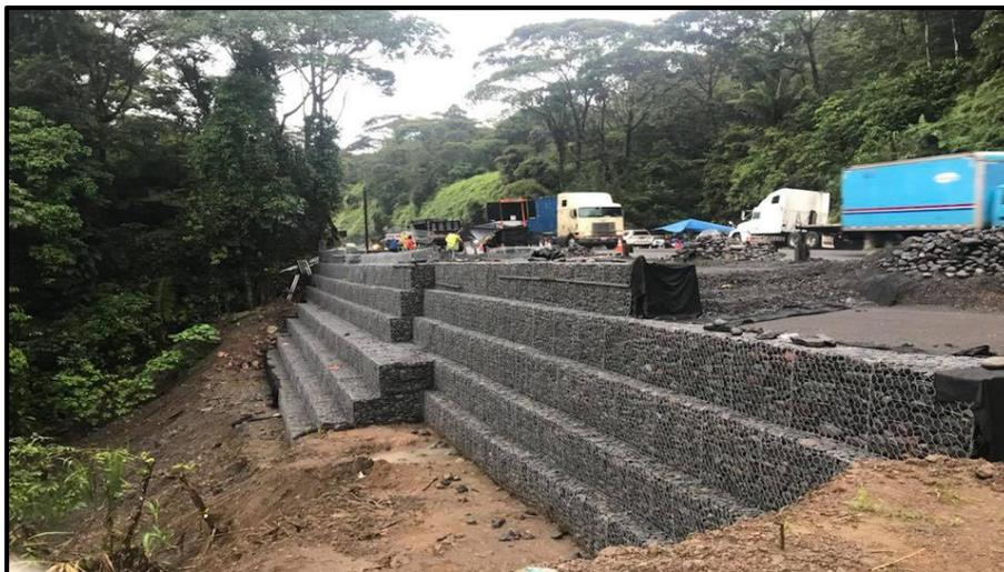
**Ilustración 33.** Gaviones con relleno compactado
