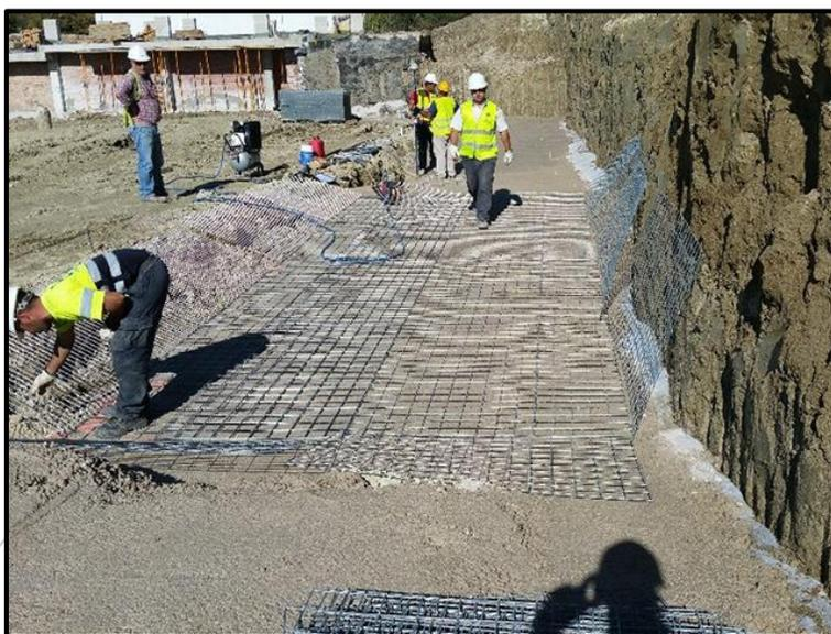
*Ilustración 24.* Armado de gaviones
