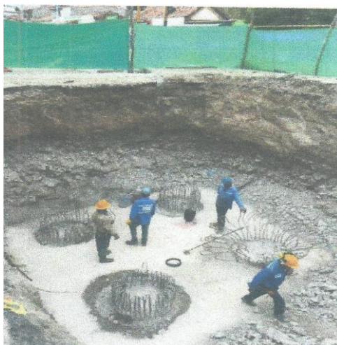
Figura 7. Vista de los pilotes preparados para la prueba PIT
