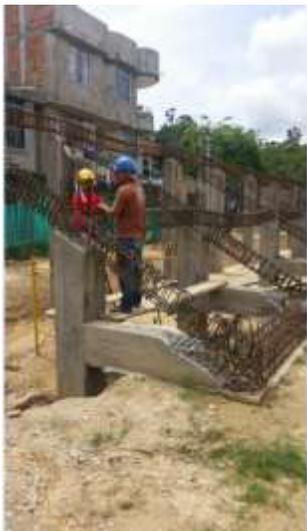
Imagen 27. Acero de refuerzo Vigas de amarre gradería.
