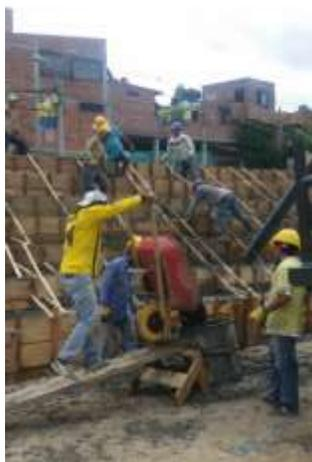
Imagen 29. Fundición de gradería
