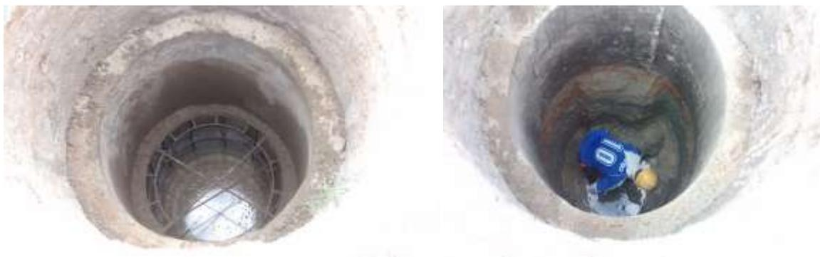
**Imagen 10** Excavación manual y fundición de anillos.
