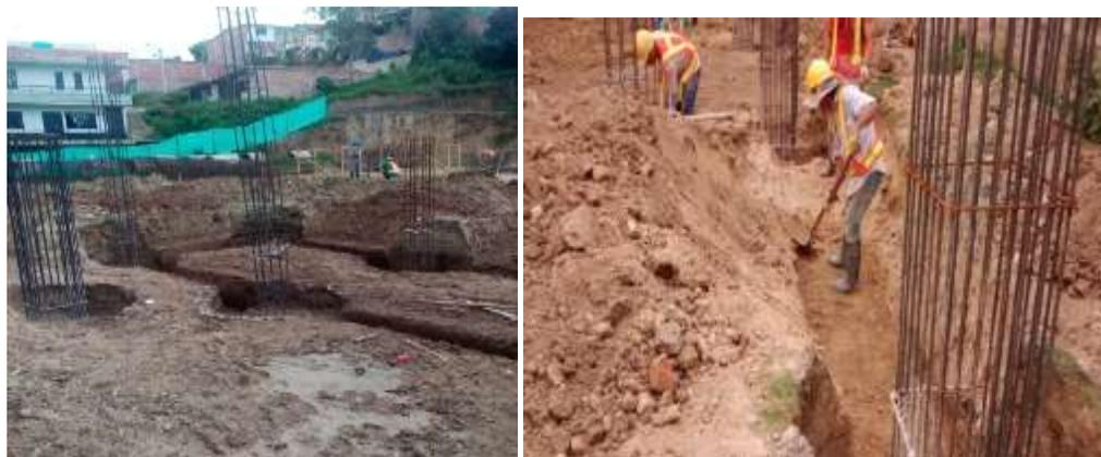
Imagen 18 Excavación vigas de cimentación..
