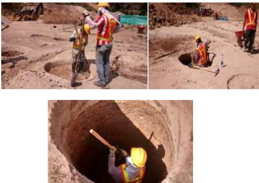
**Imagen 6.** Excavación manual para pilas.
