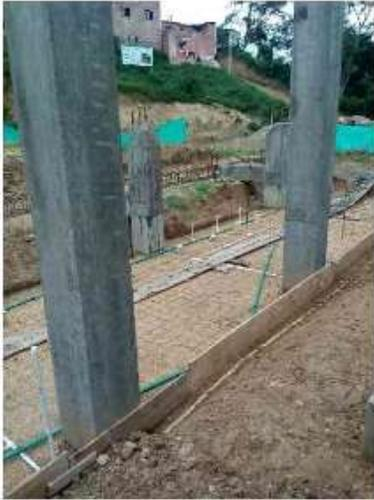
Imagen 26. Armado de acero malla electrosoldada para losa camerinos (piso)
