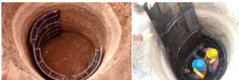
**Imagen 9** Encofrado de formaletas para anillos
