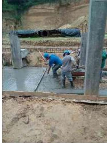
Imagen 25. Vaciado de concreto losa camerinos (piso).
