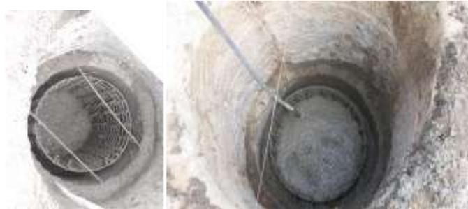
Imagen 17 Fundición en concreto para pilotes.
