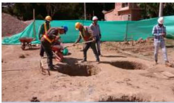
**Imagen 11** Fundición de solado para pilotes.
