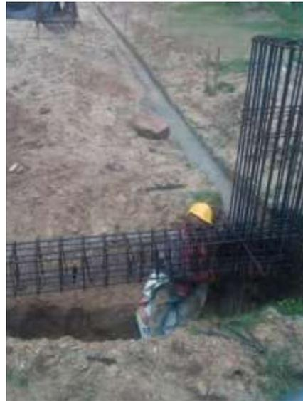
Imagen 19 Acero de refuerzo viga
