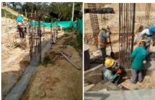
Imagen 23 Acero de refuerzo para columnas Cubiertas.
