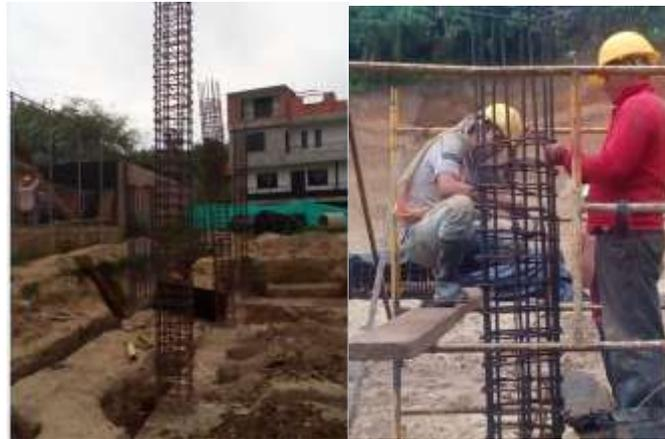
Imagen 22 Acero de refuerzo para columnas de graderías.
