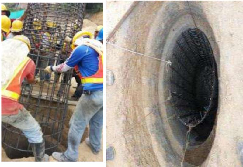
Imagen 16 Colocación de la armadura para pilotes.
