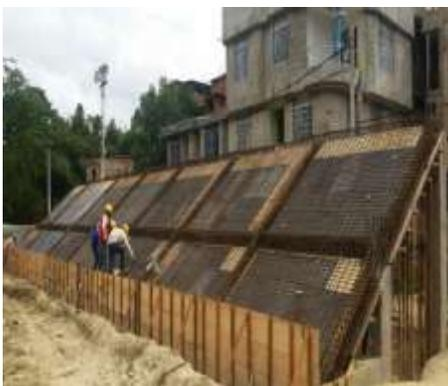
Imagen 28. Acero de refuerzo losa gradería
