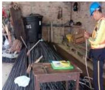
Imagen 13 Almacenamiento varillas longitudinales  $\frac{5}{8}$ "
