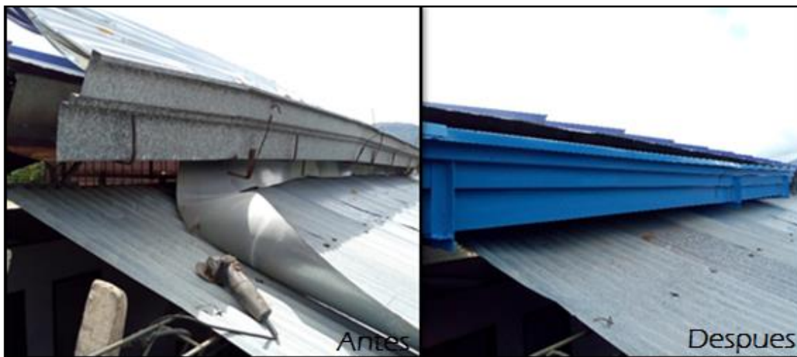
Figura 23. Instalación de canal en lámina galvanizada antes y después. Fuente: Autor de la pasantía.
