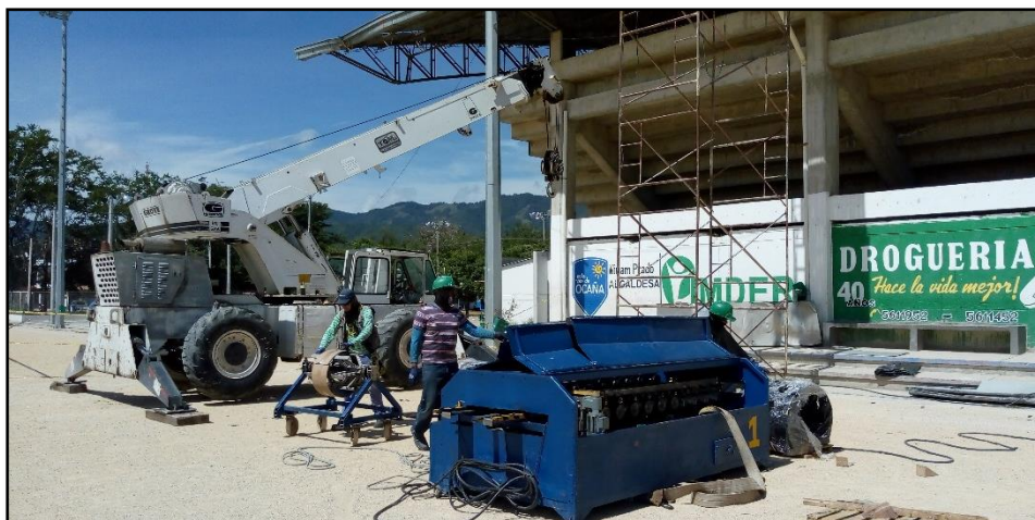
Figura 21. Maquinaria utilizada en obra para cubierta. Fuente: Autor de la pasantía.
