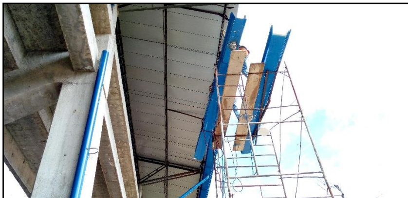
Figura 24. Instalación de bajantes de aguas lluvias. Fuente: Autor de la pasantía.
