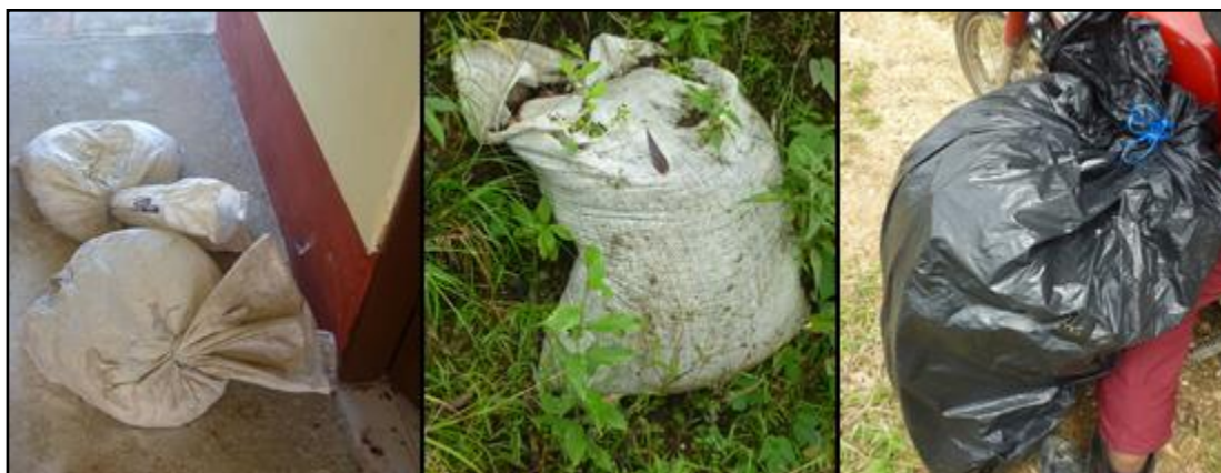
Figura 12. Retiro de material proveniente del retiro de pañetes. Fuente: Autor de la pasantía.
