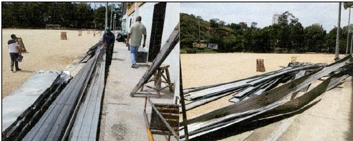
Figura 20. Desmonte de lámina de cubierta existente. Fuente: Informe contratista (2018).
