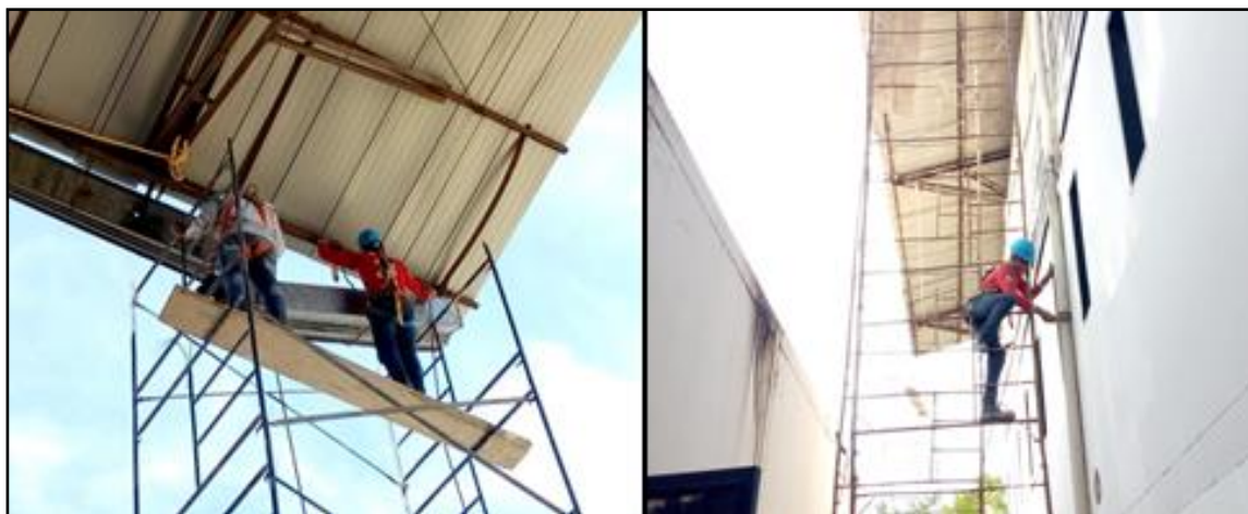
Figura 19. Trabajo en alturas con implementos de seguridad. Fuente: Autor de la pasantía.
