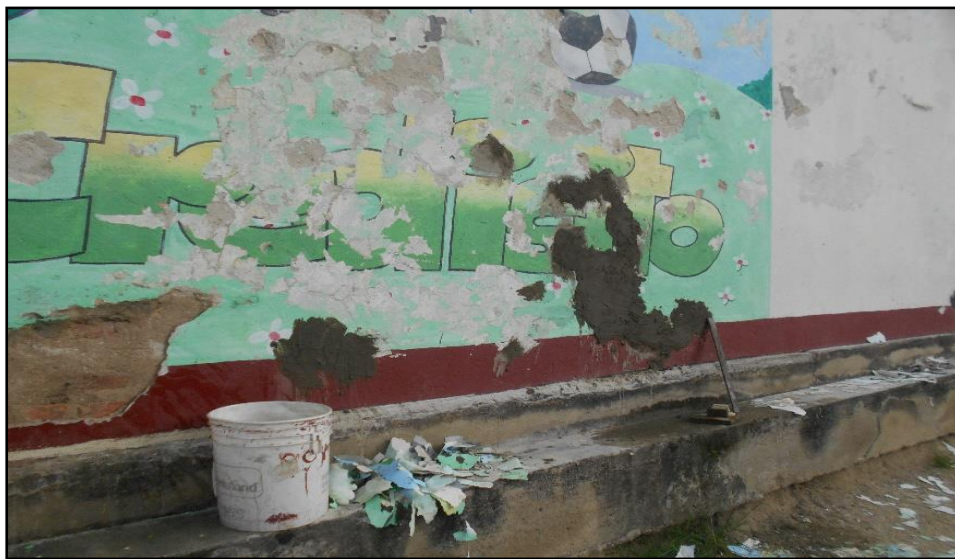
Figura 6. Material resultante del retiro de pañetes existentes. Fuente: Autor de la pasantía.
