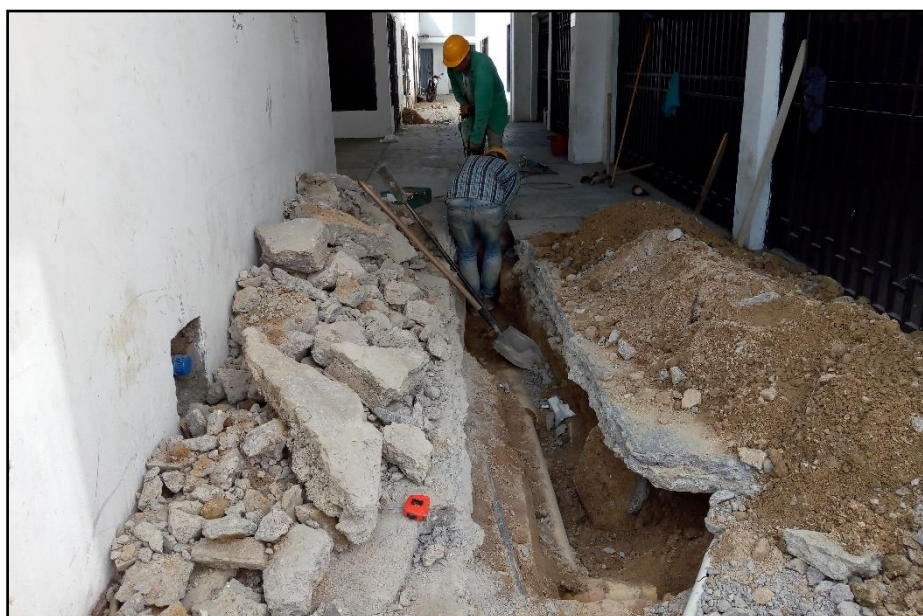
Figura 25. Excavación manual sin clasificar incluye demolición. Fuente: Autor de la pasantía.
