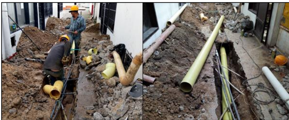
Figura 26. Suministro e instalación de alcantarillado pluvial. Fuente: Autor de la pasantía.
