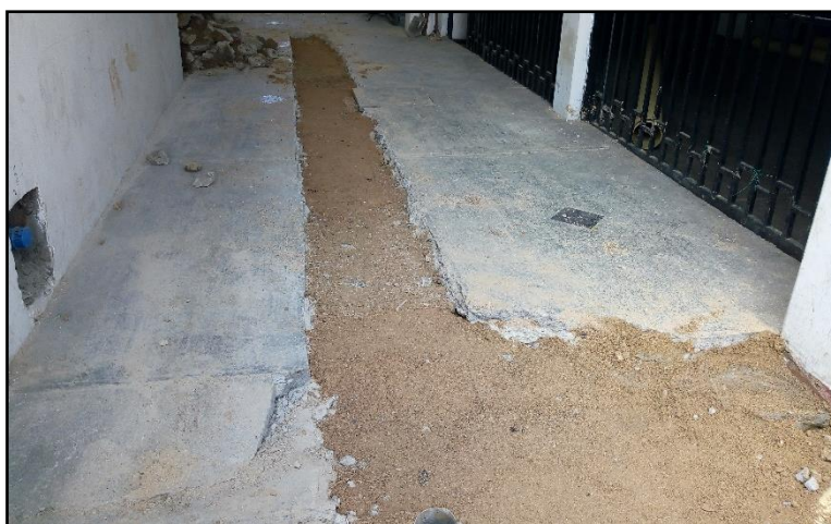
Figura 27. Relleno con material seleccionado compactado. Fuente: Autor de la pasantía.
