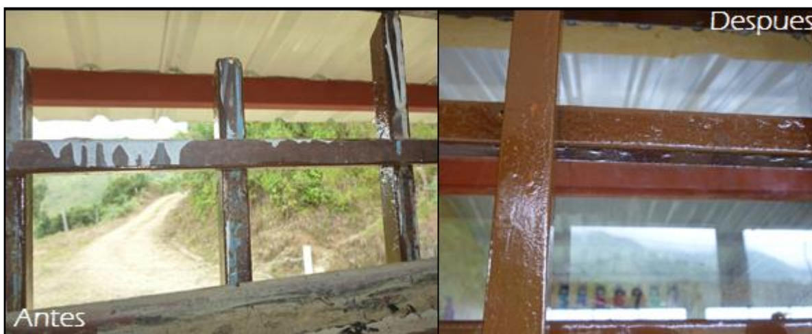
Figura 15. Marco de ventana antes y después de pintar. Fuente: Autor de la pasantía.
