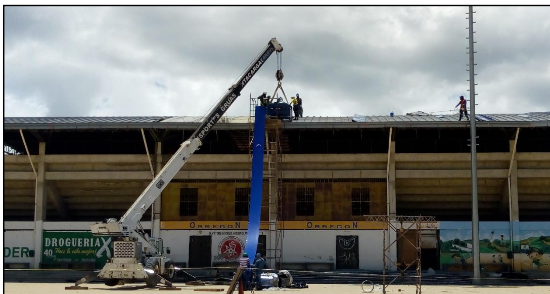
Figura 22. Procedimiento de instalación de cubierta. Fuente: Autor de la pasantía.
