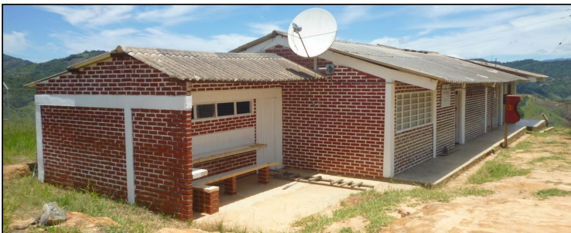
Figura 13. Barniz sobre muros en ladrillo a la vista Sede Corralitos, del Centro Educativo Rural Edmundo Velásquez. Fuente: Autor de la pasantía.
