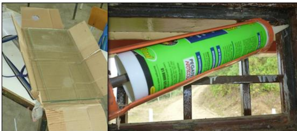
Figura 11. Vidrio Incoloro 4mm para ventanas y silicona Sede Curos Bajos. Fuente Autor de la pasantía.
