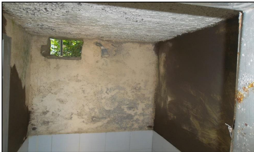
Figura 8. Pañete para muro empleando mortero 1:4 para la sede educativa La Enllana del Centro Educativo Rural Pueblo Nuevo. Fuente: Autor de la pasantía.
