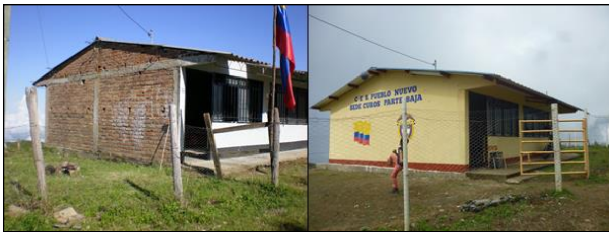
Figura 7. Instalación de pañete en muros exteriores sede Curoos parte bajos. Fuente: Autor de la pasantía.
