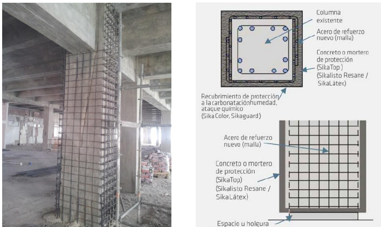
Figura 6. Recrecido con malla de concreto. Fuente Sika,2017
