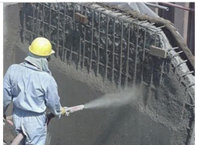
Ilustración 14. Refuerzo en hormigón lanzado 13
