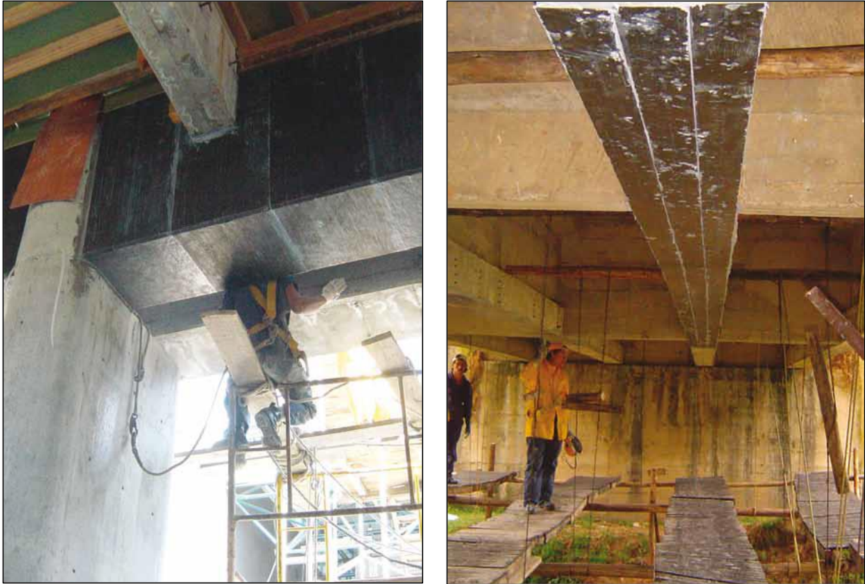
Figura 11. Enchaquetado en vigas con láminas metálicas Fuente: izquierdo J, 2015
