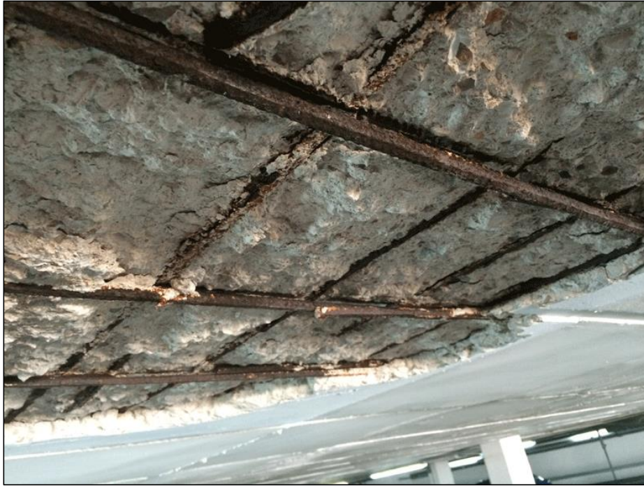
Figura 14. Escarificación de recubrimiento de una losa Fuente: e- Struc.com
