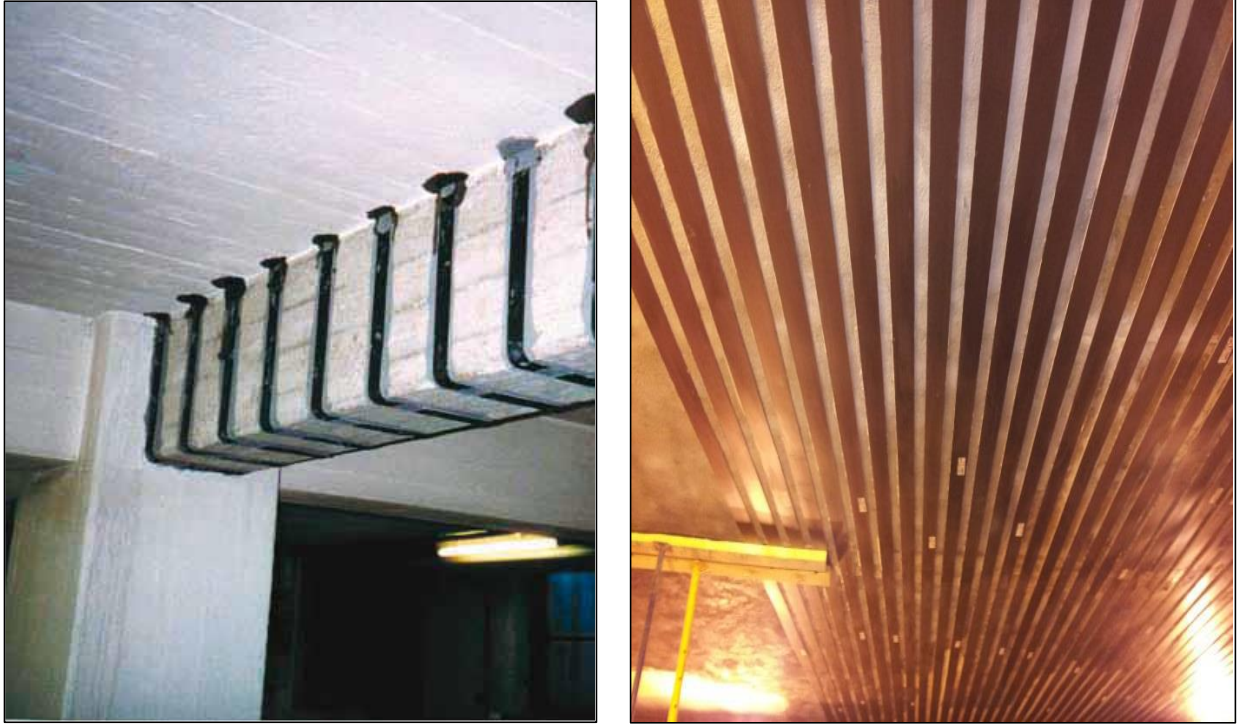
Figura 12. Reforzamiento con láminas en viga y losa Fuente: izquierdo J, 2015
