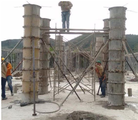
Figura 38. Encofrado metálico para columnas. Fuente: Autores
