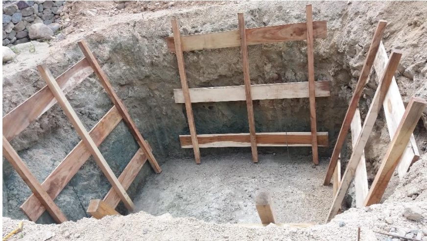
Figura 9. Proceso de entibación. Fuente: Autores
