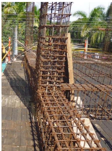
Figura 23. Acero de refuerzo de columna Fuente: Autores
