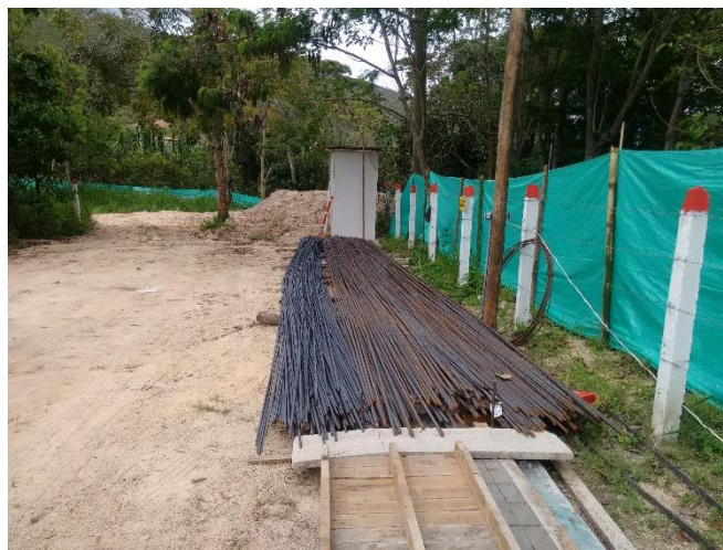
Figura 4. Almacenamiento acero de Refuerzo Fuente: Autores
