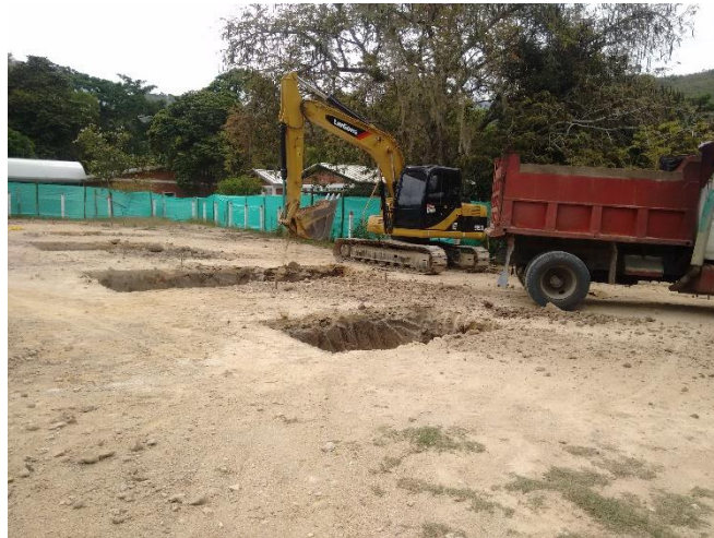
Figura 8. Excavación mecánica. Fuente: Autores
