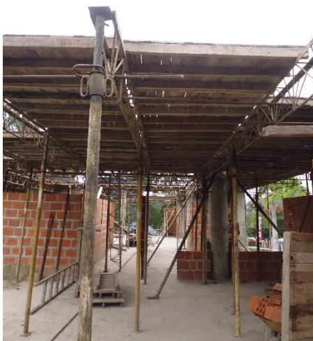
Figura 39. Encofrado para losa aligerada Fuente: Autores
