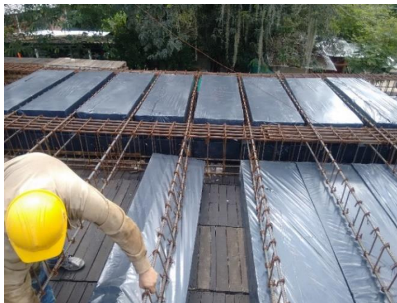
Figura 32. Acero de refuerzo y aligeramiento de losa en una dirección. Fuente: Autores
