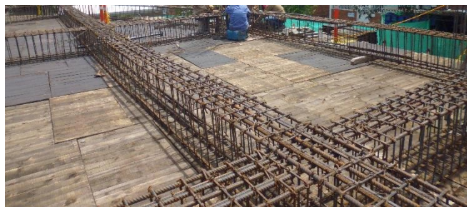
Figura 21. Acero de Refuerzo longitudinal y transversal para vigas. Fuente: Autores
