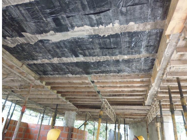
Figura 40. Retiro de cimbra Fuente: Autores
