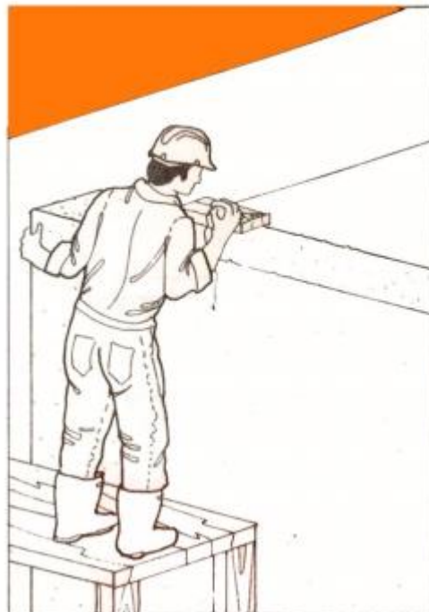
Figura 43. Nivelación y plomo Fuente: Escobar, J. E., Prieto Paz, J. M., & González, M. (1986). Armado de encofrados en madera.
