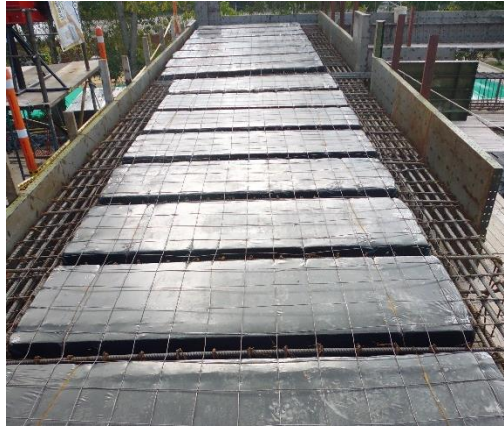
Figura 31. Malla electrosoldada para losa aligerada. Fuente: Autores
