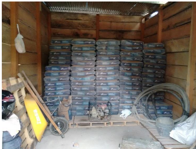
Figura 6. Almacenamiento de cemento en obra. Fuente: Autores
