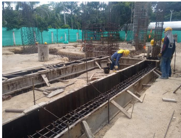
Figura 37. Encofrado metálico para viga de cimentación Fuente: Autores
