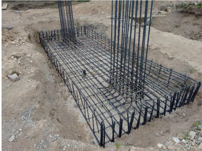
Figura 12. Acero de refuerzo para zapata rectangular. Fuente: Autores
