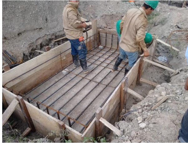
Figura 36. Encofrado en madera para zapata. Fuente: Autores
