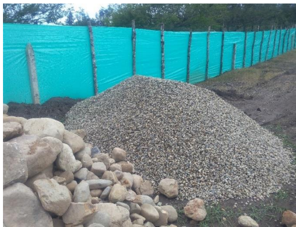
Figura 7. Almacenamiento de agregados pétreos en obra. Fuente: Autores
