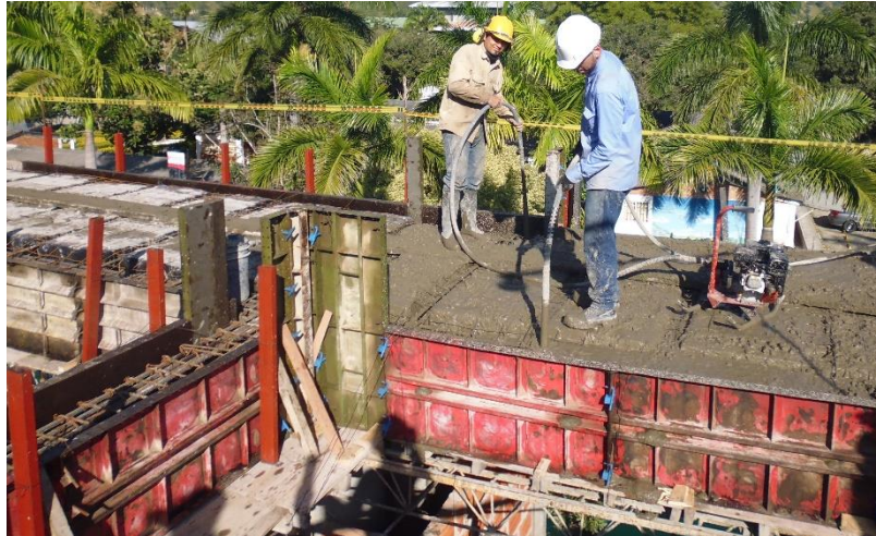
Figura 35. Vibrado del concreto. Fuente: Autores
