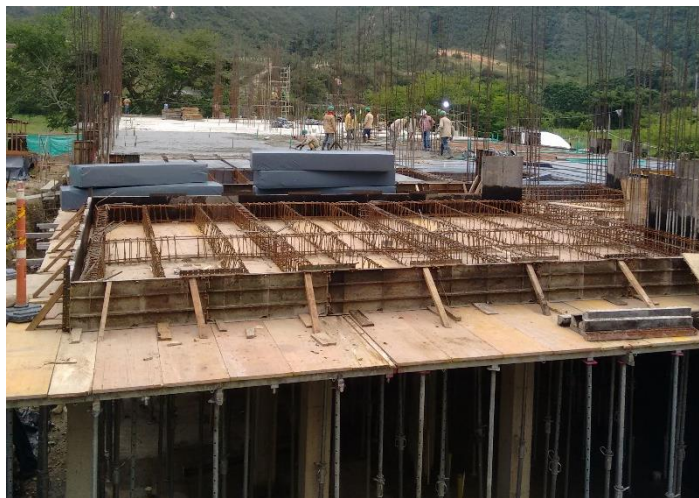
Figura 41. Refuerzo de cimbra Fuente: Autores
