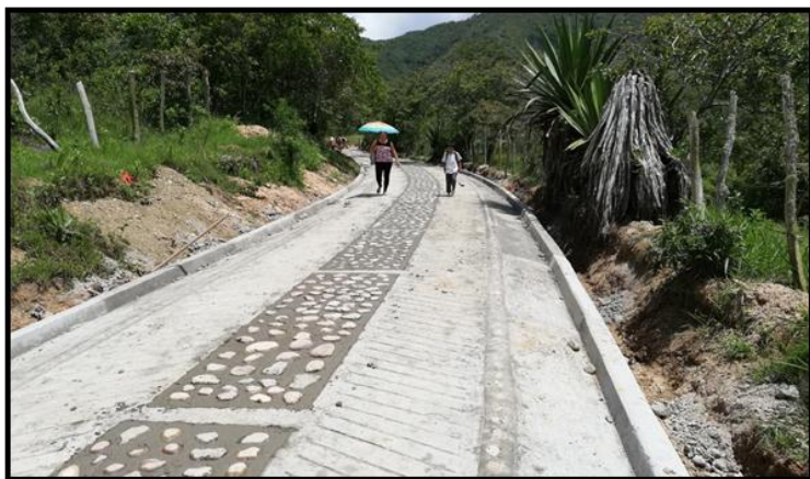
Figura 18. Tramo placa-huella Ramal 1 PR0+700-PR0+800
