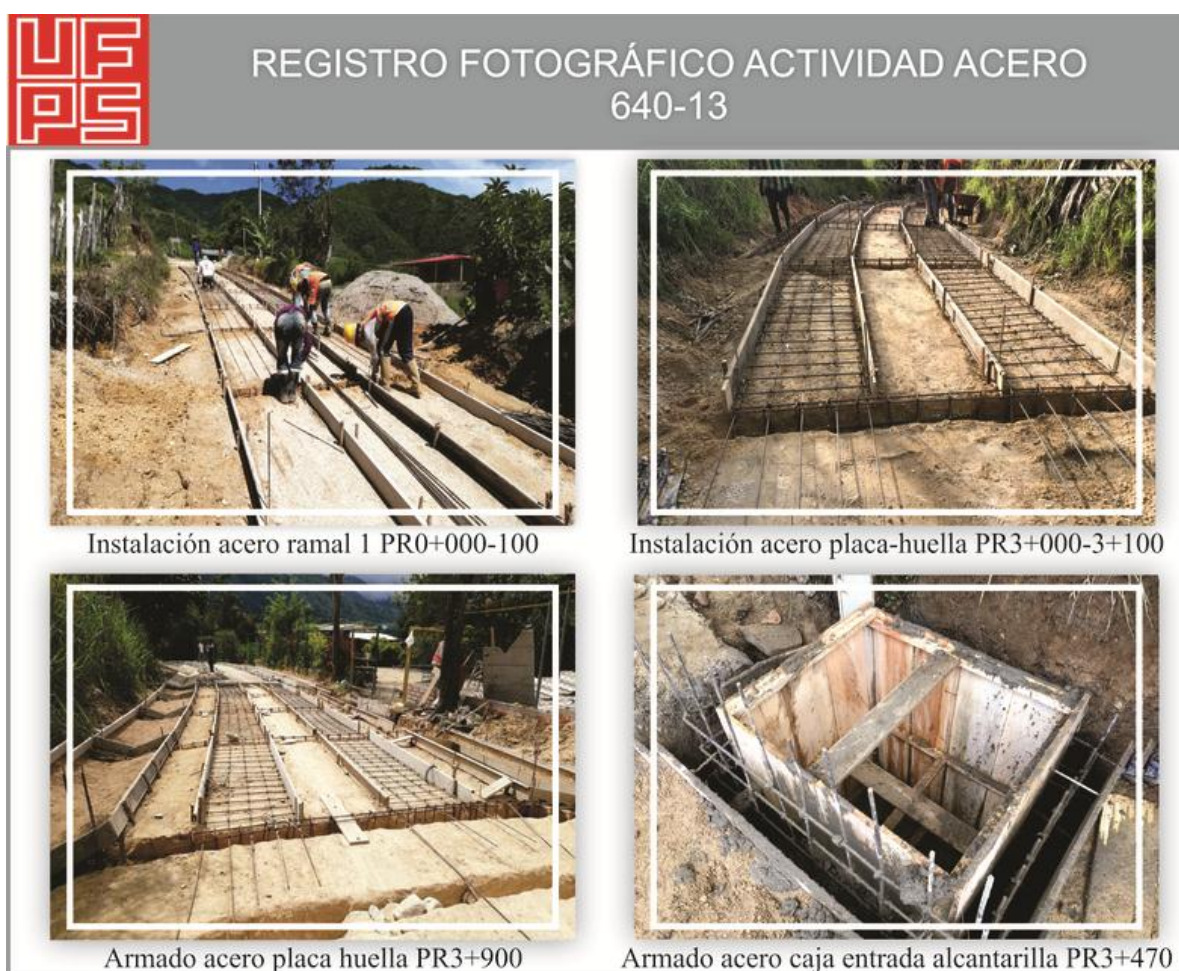
Figura 25. Registro fotográfico actividad Acero 640-13. Fuente: Pasante del proyecto.
