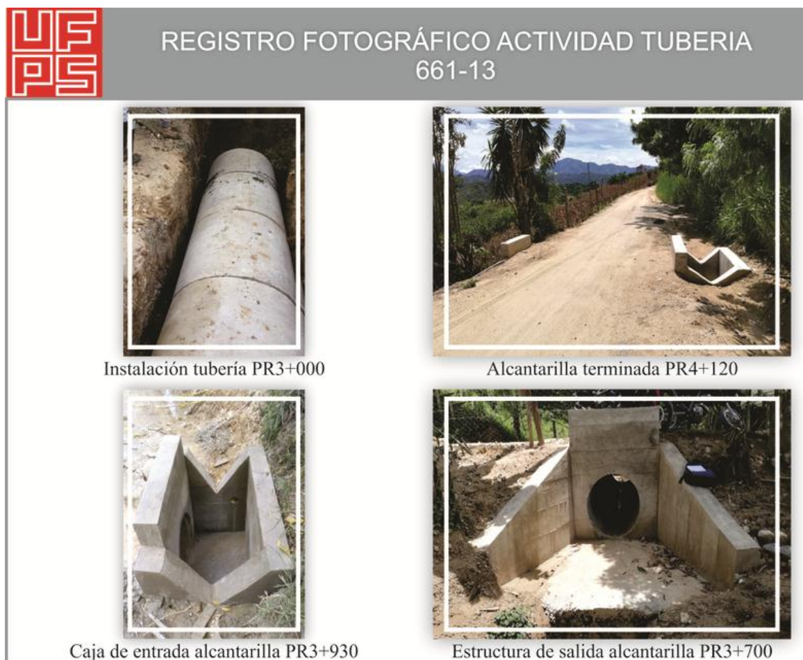
Figura 26. Registro fotográfico actividad Tubería 661-13.
