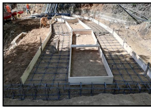
Figura 17. Instalación acero PR0+500 Fuente: Interventoría.
