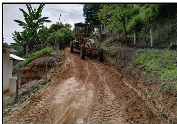
Figura 16. Mejoramiento con adición PR3+100 Fuente: Interventoría.
