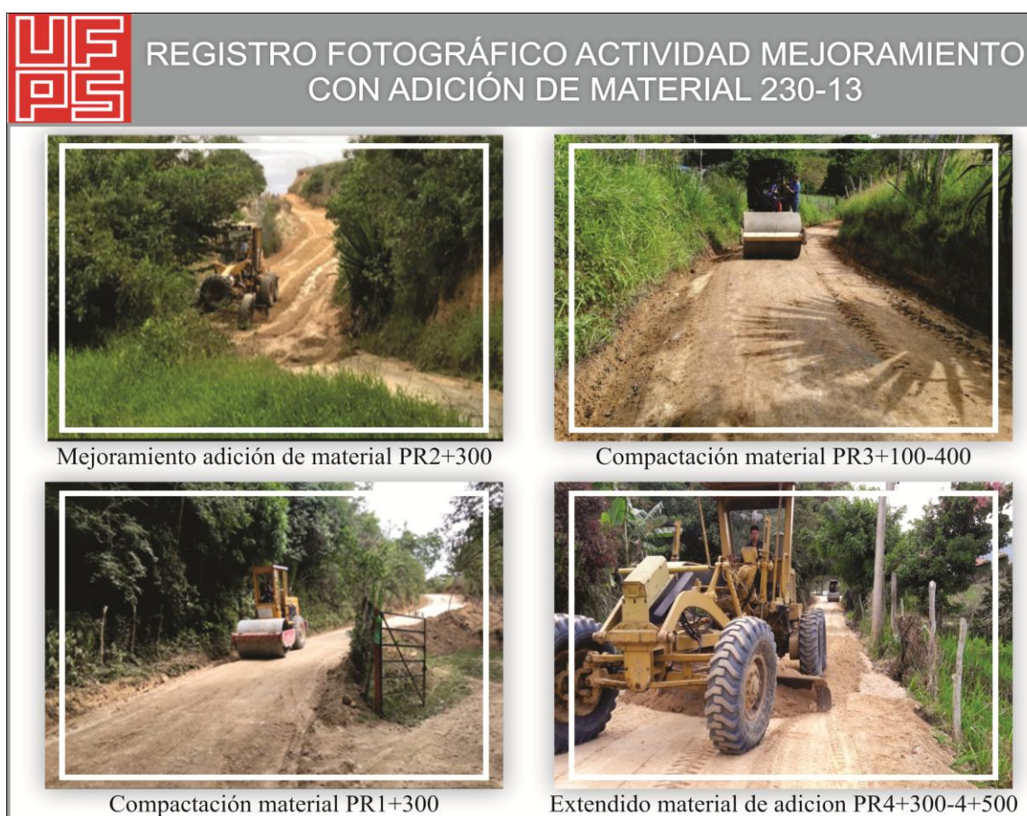
Figura 21. Registro fotográfico actividad Mejoramiento 230-13.
