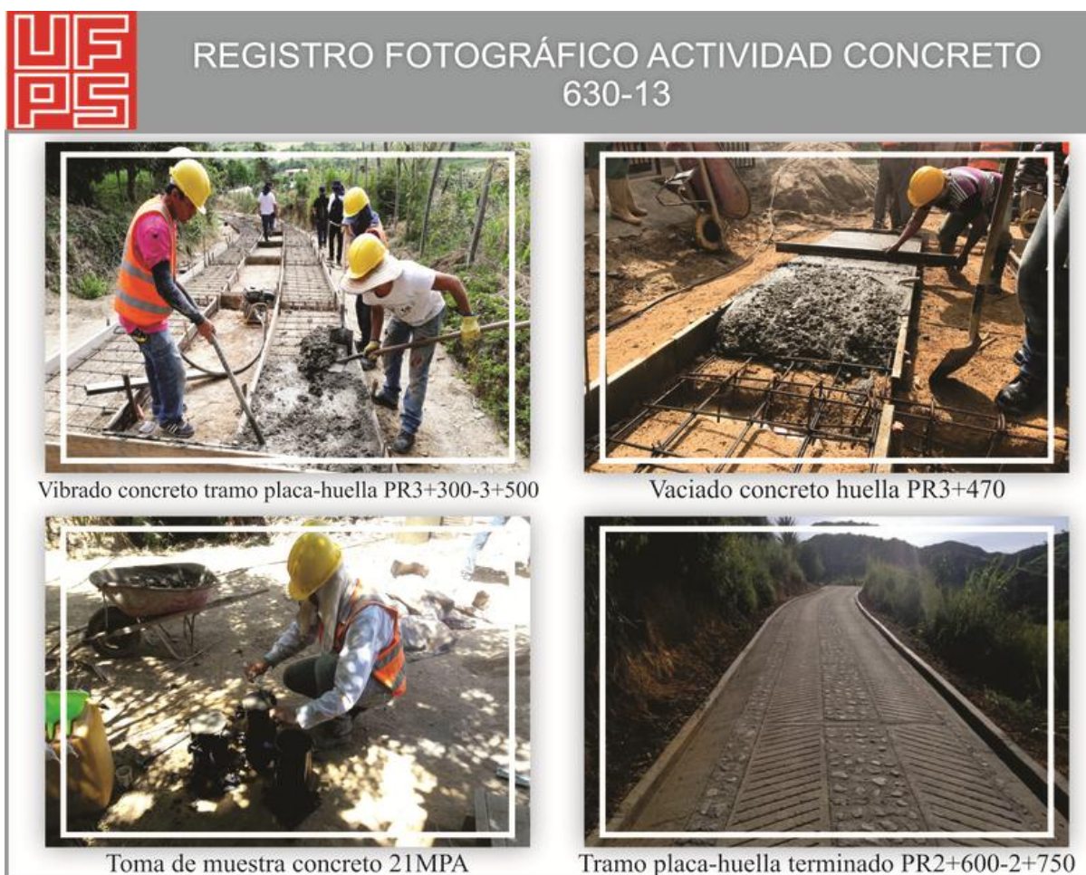
Figura 24. Registro fotográfico actividad Concretos 630-13. Fuente: Pasante del proyecto.
