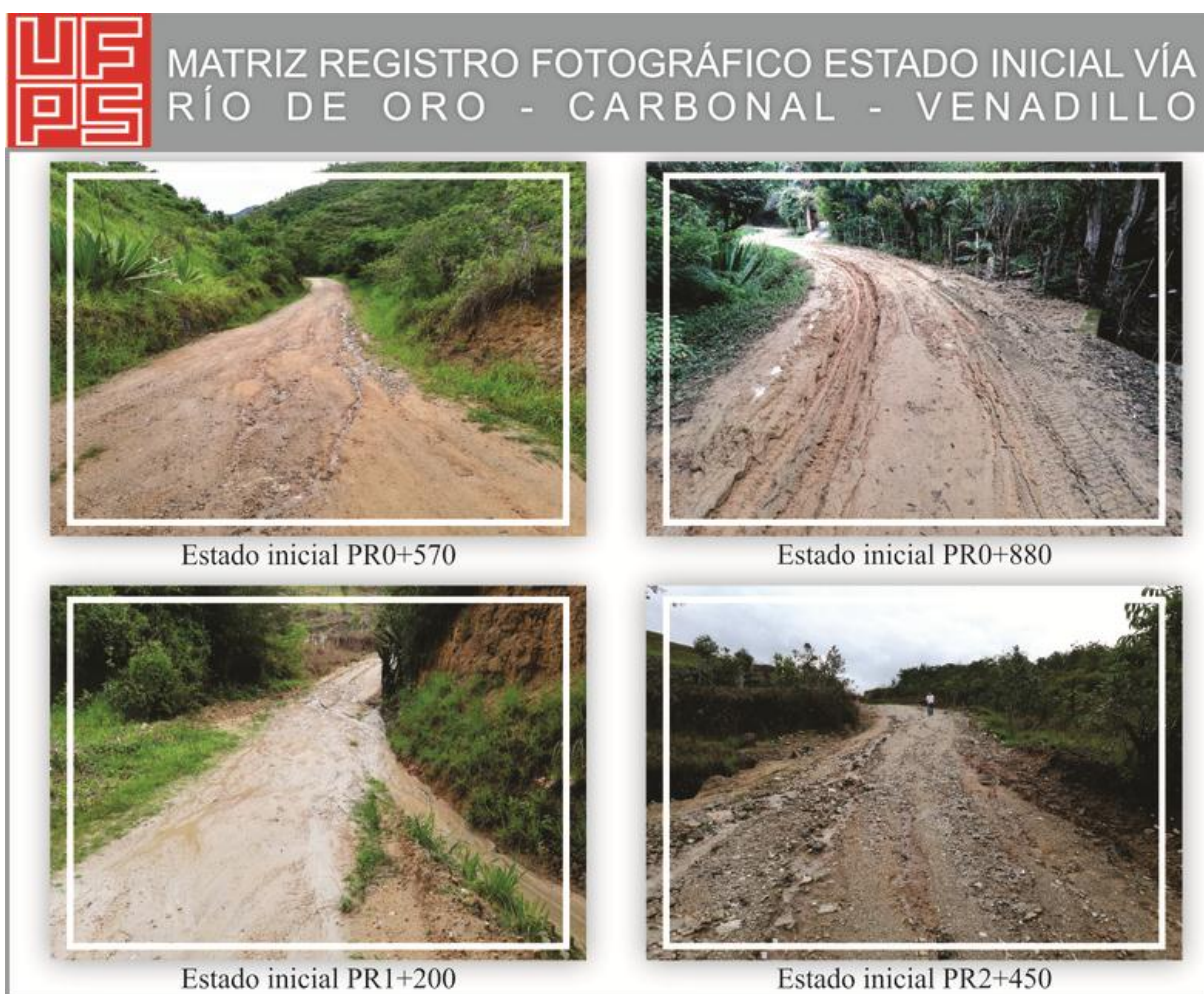
Figura 8. Matriz Registro Fotográfico Estado Inicial Fuente: Pasante del proyecto.
