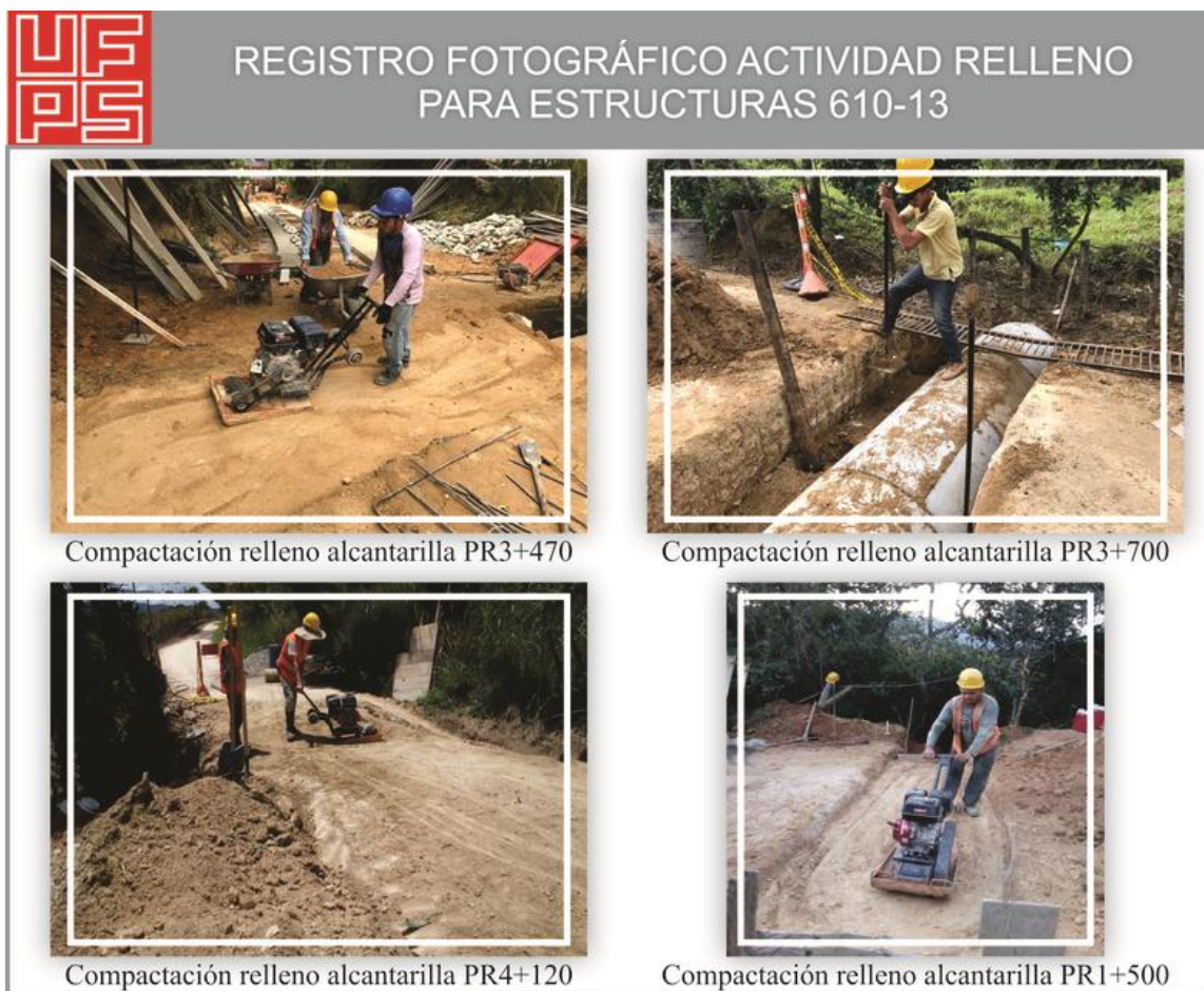
Figura 23. Registro fotográfico actividad Rellenos 610-13. Fuente: Pasante del proyecto.
