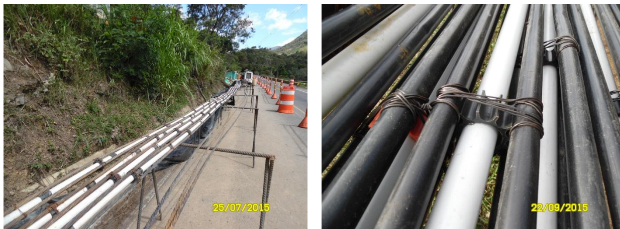
Figura 28. Armado del anclaje. Autores, 2020.
