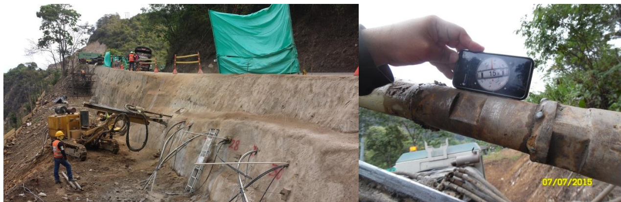
Figura 23. Inclinación de perforación. Autores, 2020.
