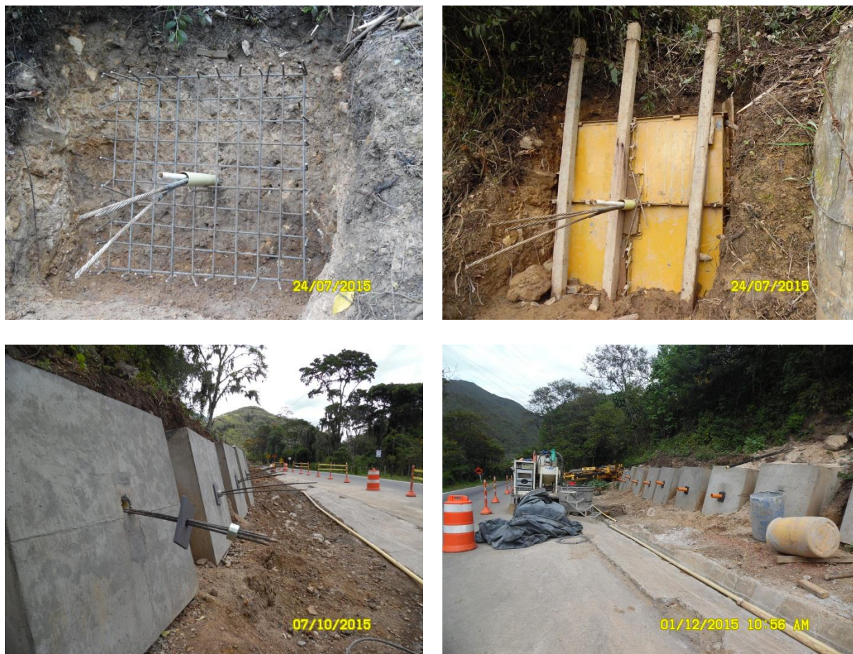
Figura 31. Armado y proceso de fundida de dado de apoyo. Autores, 2020.
