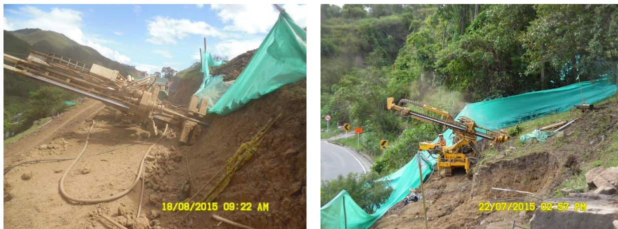
Figura 24. Perforación del anclaje. Autores, 2020.
