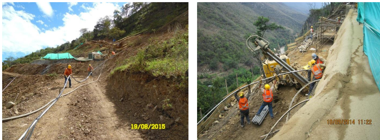
Figura 27. Instalación del anclaje. Autores, 2020.
