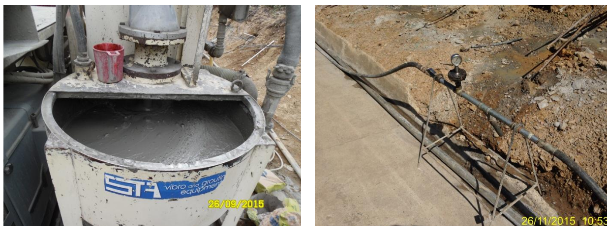
Figura 26. Inyección del anclaje. Autores, 2020.
