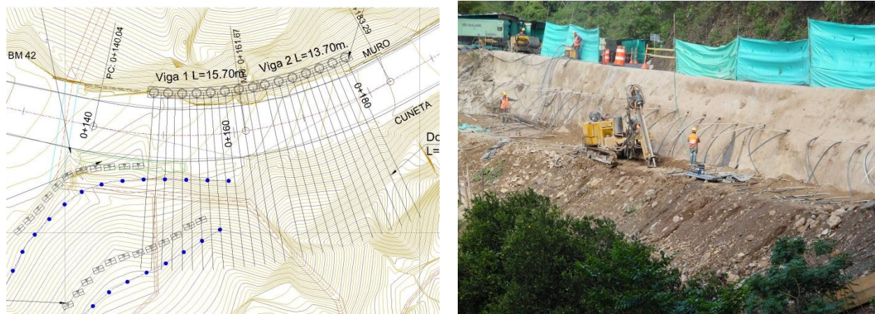
Figura 21. Localización de anclajes. Autores, 2020.
