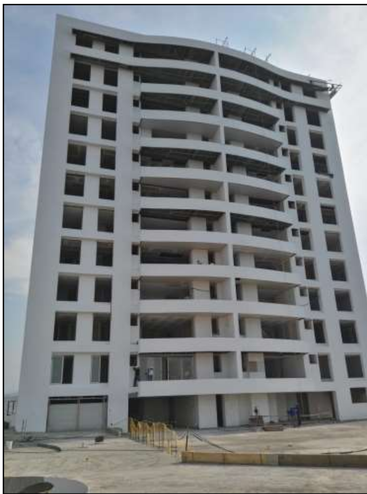
Figura 8. Torre Fragatta en su etapa final. Fuente: INGESCOL, 2019
