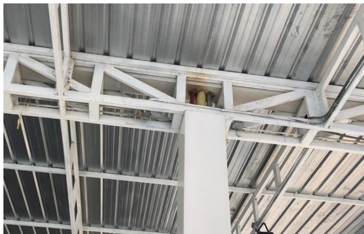
Figura 56. Columnas. Fuente. Autores del proyecto.
