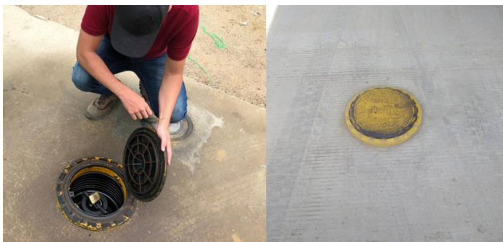
Figura 46. Inspección de bocas de llenado. Fuente. Autores del proyecto.
