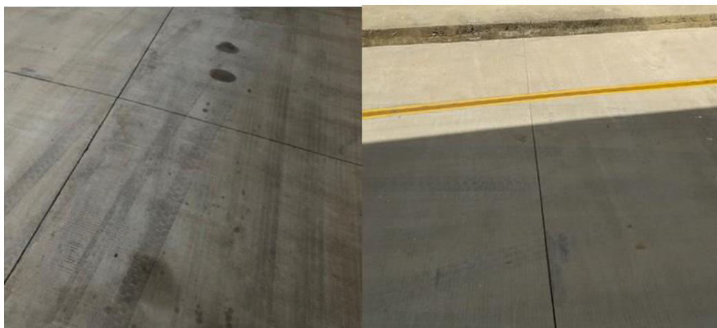
Figura 60. Juntas de dilatación. Fuente. Autores del proyecto.
