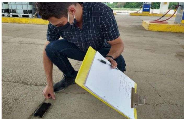
Figura 44. Verificación de la pendiente de la losa. Fuente. Autores del proyecto.
