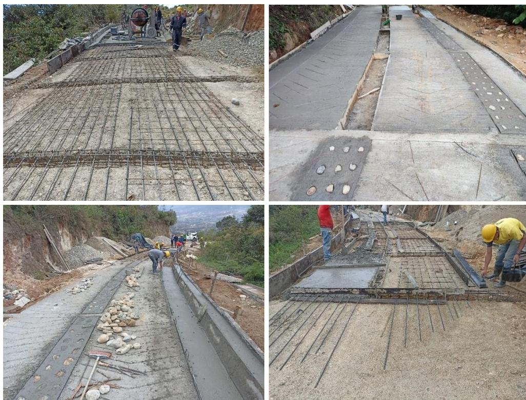
En la ejecución de este proyecto se observa el uso de formaleta metálica. No se aprecia el uso de vibrador de concreto. La piedra pegada utilizada para esta placa huella se observa muy superficial, ya que se utiliza una piedra lavada de rio de tamaño pequeño. Se observa que el personal en obra cuenta con los elementos de protección personal EPP.
