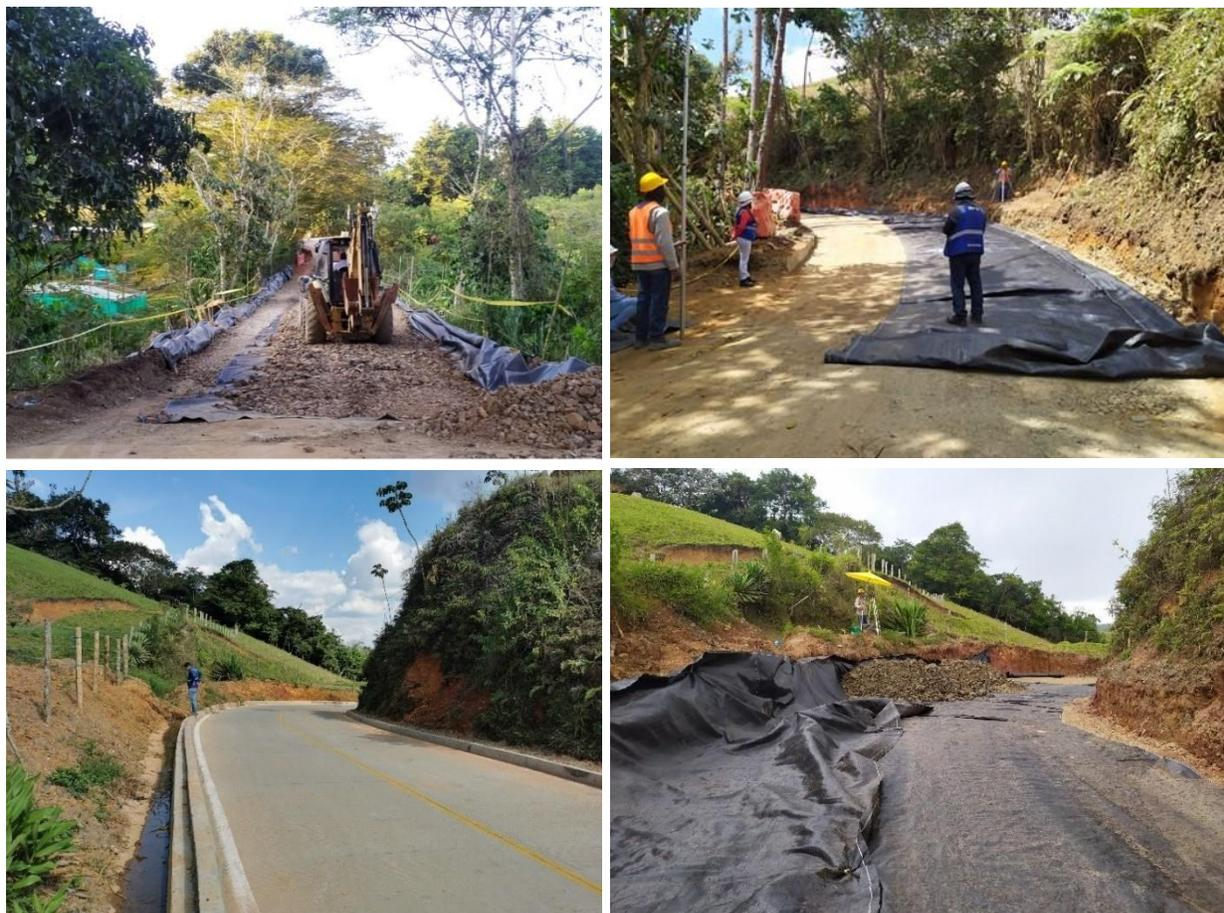
De acuerdo a la figura 34, en este proyecto, se realiza la construcción de pavimento rígido, sobre subbase granular, en donde fue necesario realizar un mejoramiento de terreno con roca muerta en capas de 0,20m encapsuladas en geotextil T-2400, para conformar la subrasante de la estructura de pavimento.
