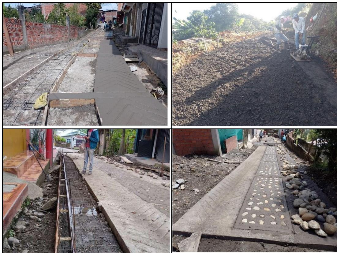
De acuerdo a la figura 37, se observa en la ejecución de este proyecto, un proceso constructivo no recomendado, ya que las riostras o vigas de amarre de la estructura de pavimento de placa huella se funde por partes, en este caso, la mejor opción es fundir el elemento monolíticamente. Igualmente se observa falta de protocolo de seguridad y uso de EPP, además se observa la compactación de la capa de subbase granular con un compactador operado manualmente.
