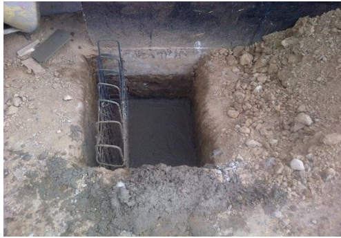
Fotografía 25. Fundida de concreto con dosificación 1:2:3 en cimentación de escalera
