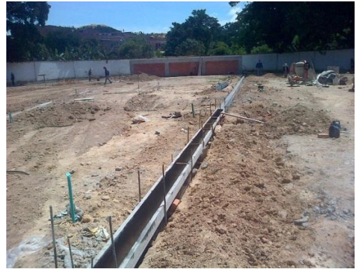
Fotografía 56. Construcción de sardineles
