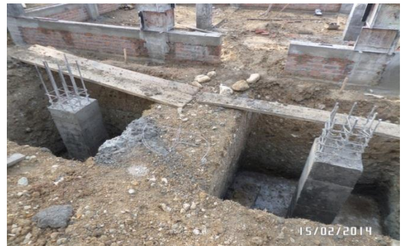
Fotografía 32. Pedestales fundidos con concreto de dosificación 1:2:3
