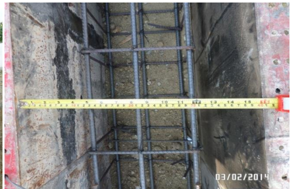
Fotografía 8. Chequeo de dimensiones de viga de cimentación
