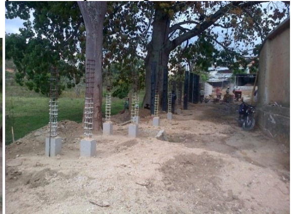
Fotografía 78. Construcción de pedestales y columnas para manga de acceso
