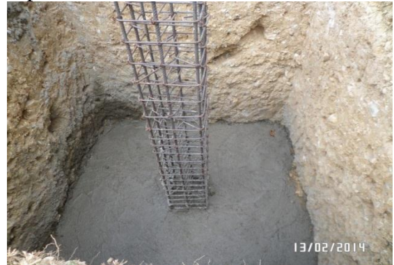
Fotografía 30. Fundida de concreto para zapata de cubierta
