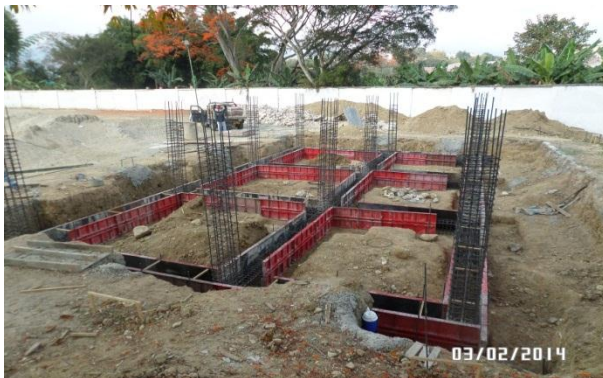
Fotografía 7. Encofrado de vigas de cimentación
