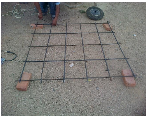
Fotografía 109. Parrilla acero para base de pozo de inspección
