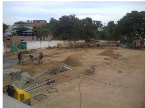
Fotografía 58. Construcción de pisos área izq.
