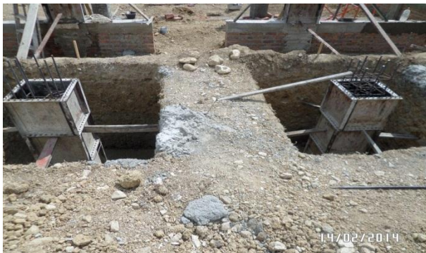
Fotografía 31. Encofrado de pedestales de cimentación posterior a camerinos
