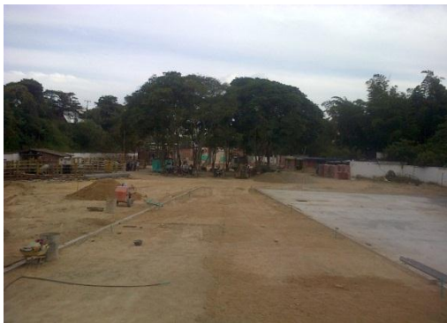
Fotografía 57. Construcción de pisos área central
