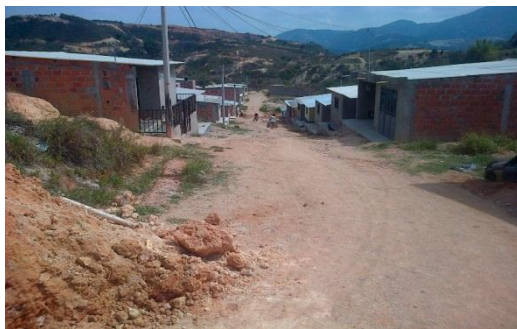
Fotografía 87. Topografía de la zona (pendientes pronunciadas)
