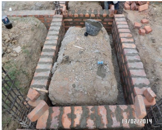
Fotografía 33. Pega de ladrillos en taquilla anexa a oficina de A.E.C.O.
