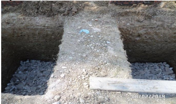
Fotografía 29. Mejoramiento en piedra laja en zapatas de cubierta metálica
