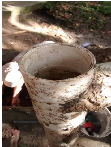
Foto 25. Área afectada en la tubería de 2”.
