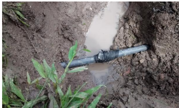
Foto 21. Tubo de ½” para agua de riego.
