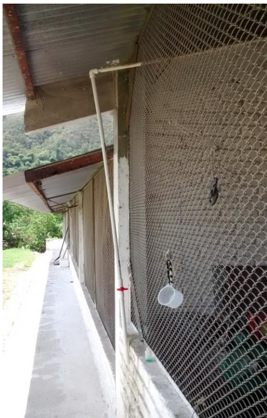
Foto 9. Tubo de 1" con llave de palanca galpón 2".
