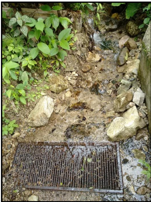
Foto No 2 Captación existente quebrada Montenegro.
