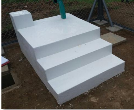
Fotografía 5. Apoyo para torre central tipo gradas. Fuente. Pasante.
