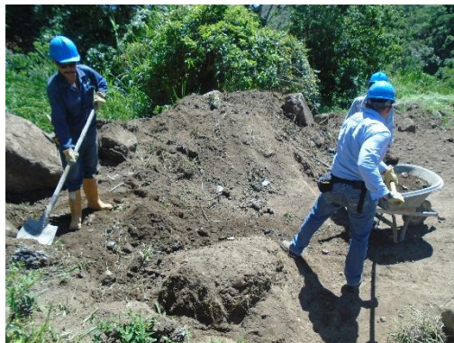
Figura 2. Desmonte y limpieza. Fuente. Pasante
