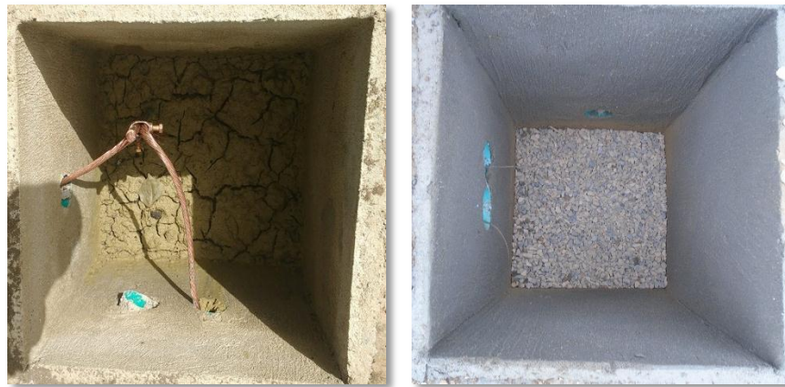
Fotografía 4. Caja de inspección Fuente. Pasante
