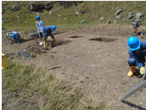
Figura 3. Explanación del terreno. Fuente. Pasante
