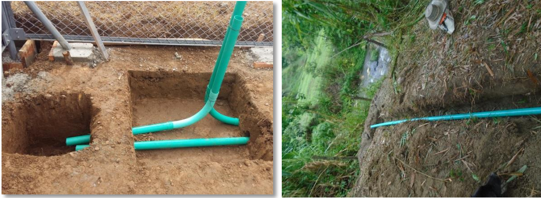
Fotografía 2. Instalación de tubería Fuente. Pasante
