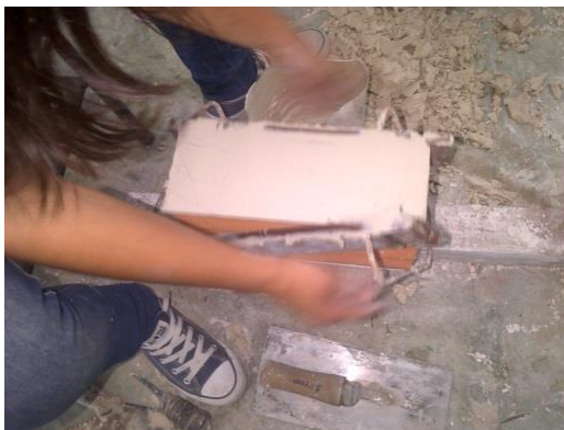
Fotografía 15. Retiro de las reglas guía.
