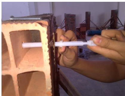
Fotografía 102. Deslizamiento del capuchón del anclaje.
