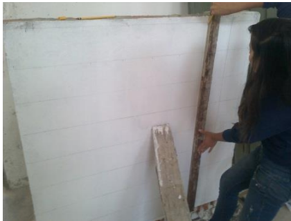
Fotografía 117. Marcado de la cuadrícula en el murete.
