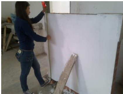
Fotografía 118. Medición de las dimensiones del murete reforzado.
