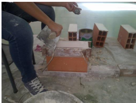
Fotografía 14. repartición homogéneo de la mezcla
