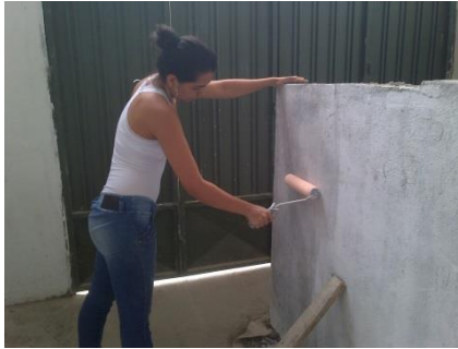
Fotografía 116. Pintado de los muretes con cal.
