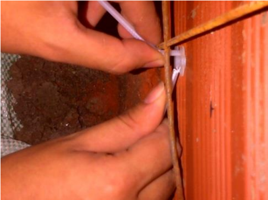
Fotografía 103. Quiebre de las guías a ras del capuchón.
