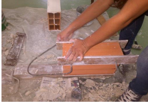
Fotografía 9. Instalación de reglas y soportes de cada unidad.
