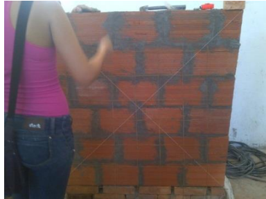
Fotografía 97. Colocación de la malla electrosoldada en el muro.
