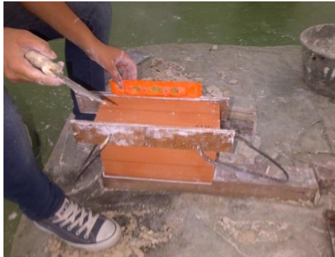
Fotografía 10. Nivelación de las reglas
