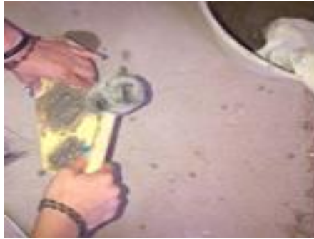
Fotografía 55. Golpeado de la segunda capa de mortero.
