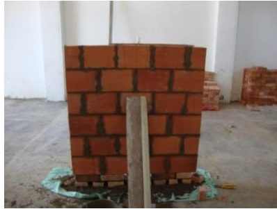
Fotografía 91. Muro terminado y apuntalado.
