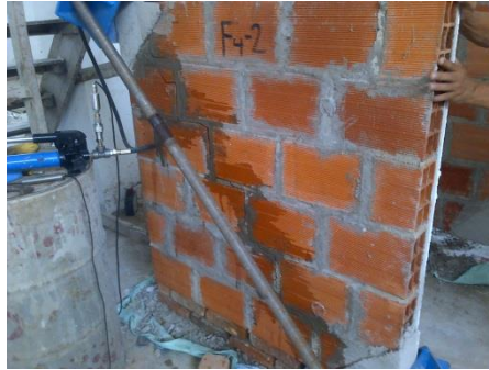
Fotografía 127. Falla por tracción diagonal del murete reforzado.
