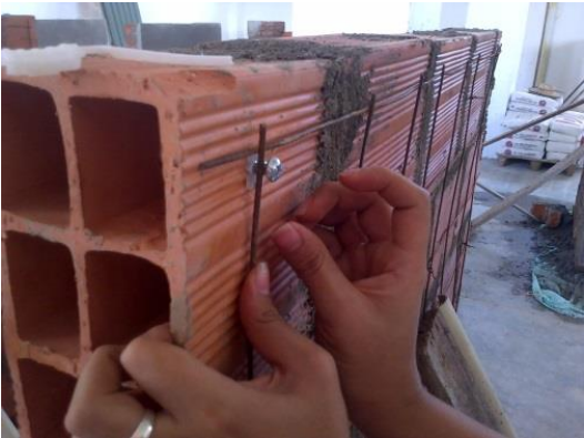
Fotografía 104. Colocación del tornillo en el anclaje
