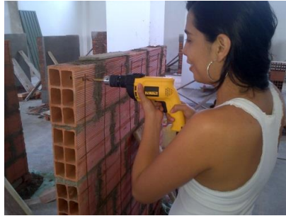
Fotografía 100. Perforación para anclajes.
