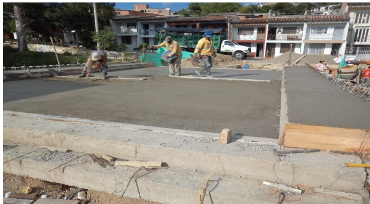
Fotografía 40. Concreto para losa maciza
