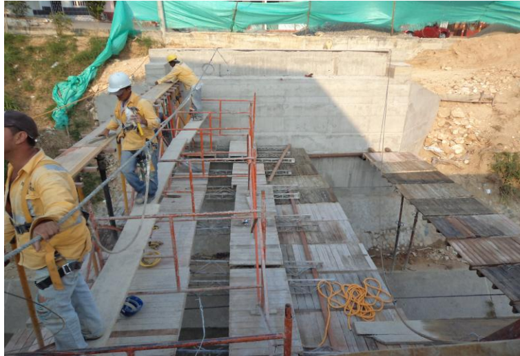
Fotografía 26 .instalación de tarima
