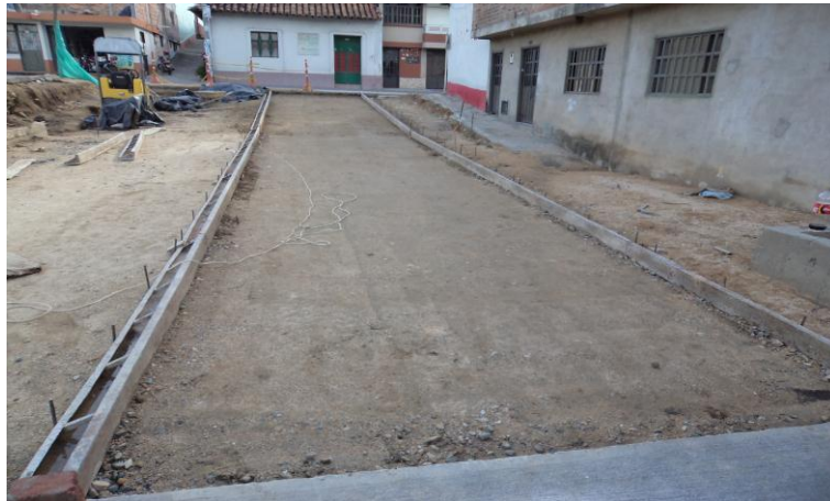
Fotografía 51. Vía de acceso
