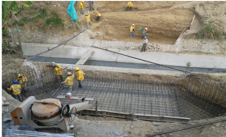
Fotografía 19. Figurado del acero
