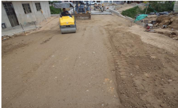
Fotografía 47. Primera capa de la vía
