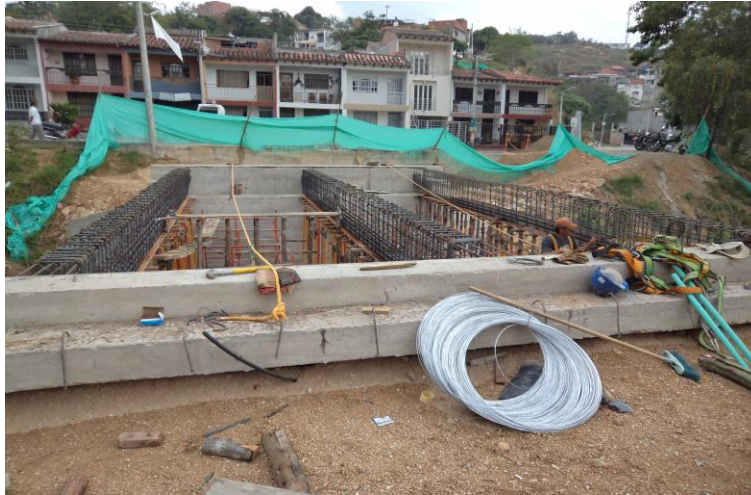
Fotografía 28. Acero para vigas
