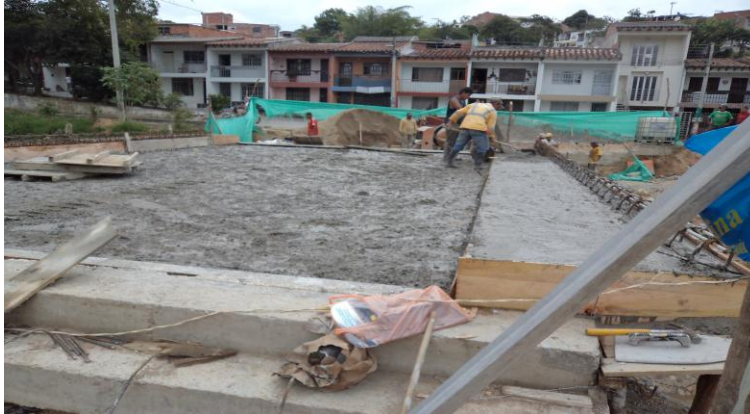
Fotografía 39. Concreto para losa maciza
