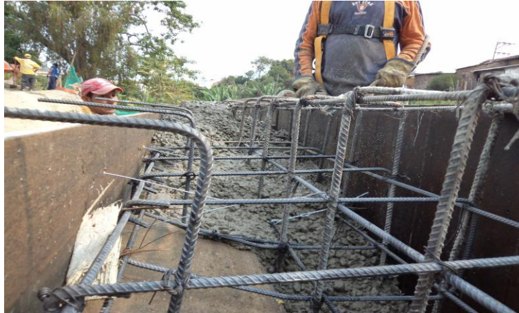
Fotografía 32. Concreto para viga
