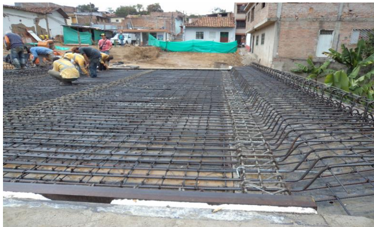
Fotografía 38. Instalación de acero
