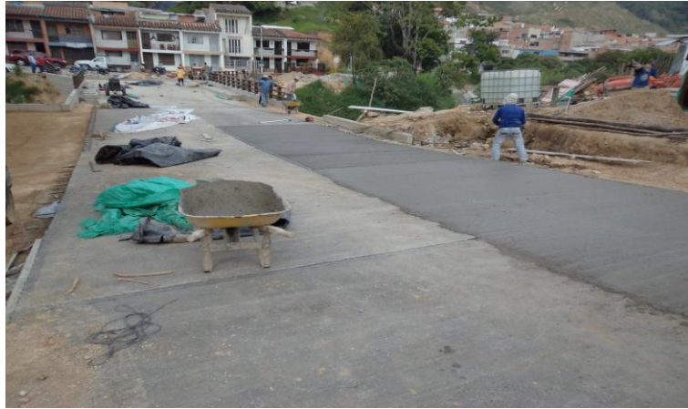
Fotografía 53. Concreto para vía
