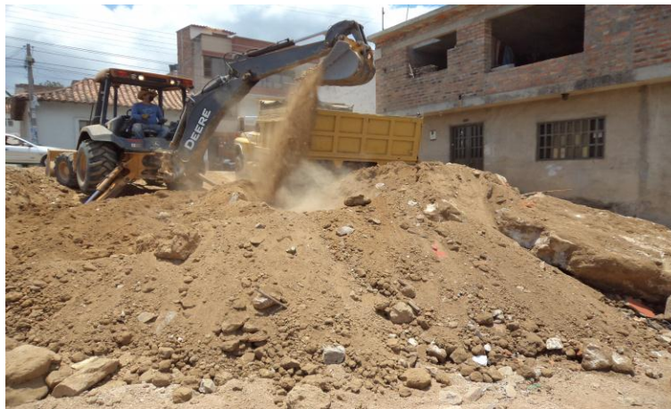
Fotografía 41. Nivelación del terreno
