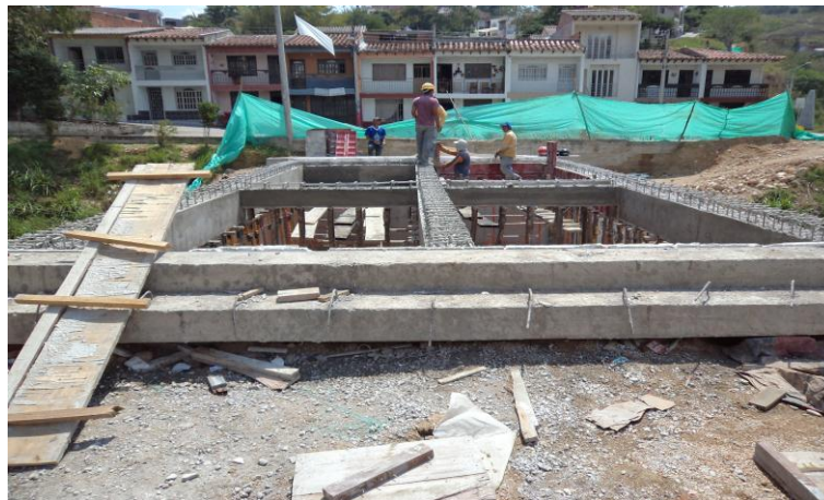
Fotografía 34. Desencofrado de vigas
