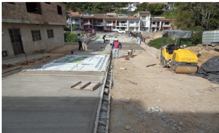
Fotografía 52. Vía de acceso
