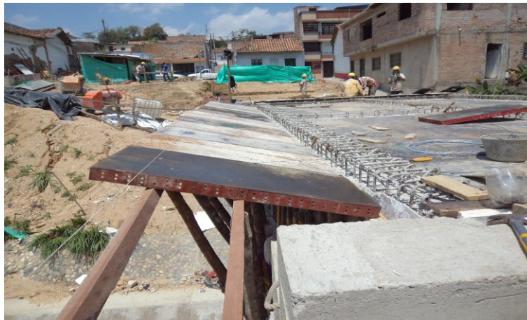
Fotografía 36. Formaleta para losa maciza
