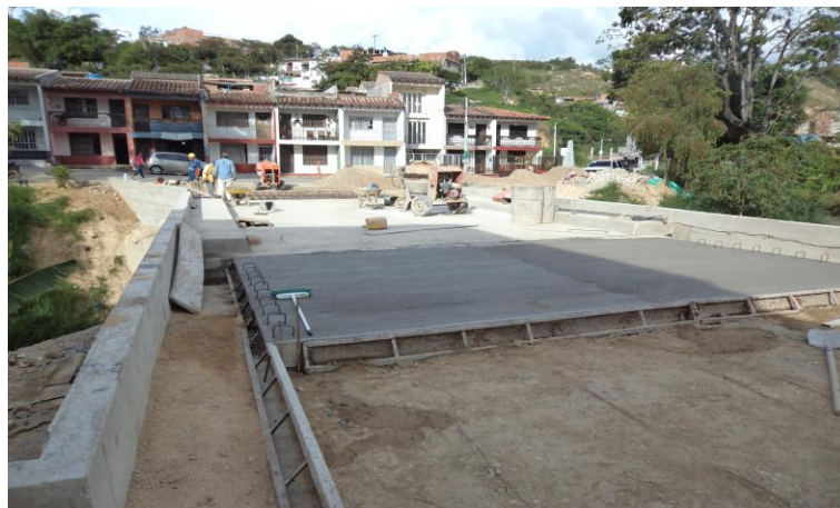
Fotografía 50. Concreto para la vía de acceso
