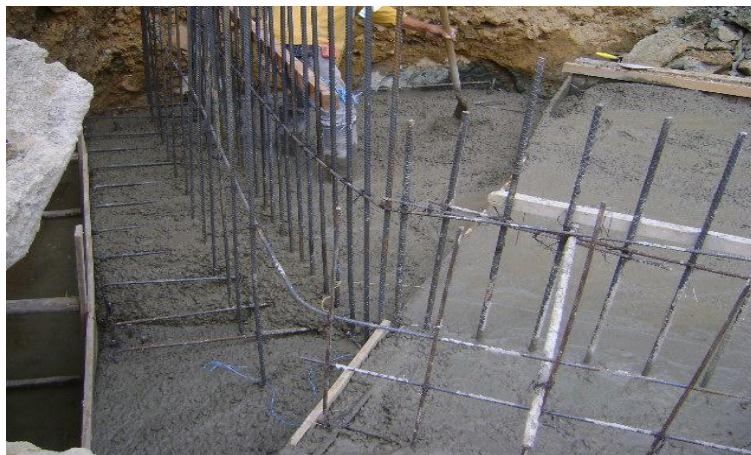
Fotografía 20. Concreto para zarpa
