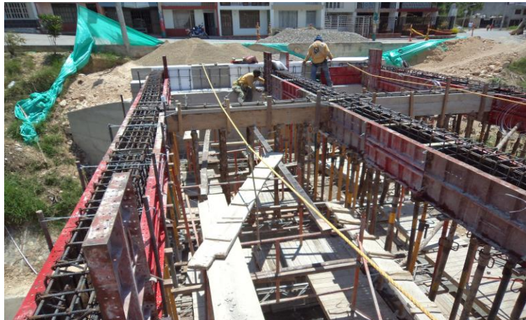
Fotografía 31. Formaleta para viga
