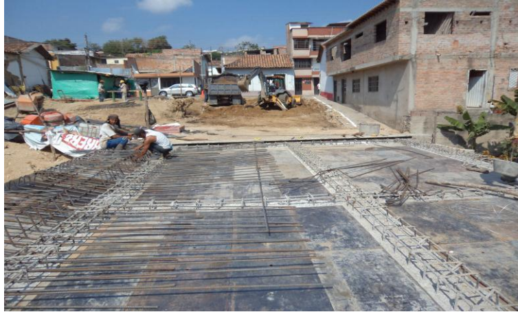
Fotografía 37. Instalación de acero para losa maciza
