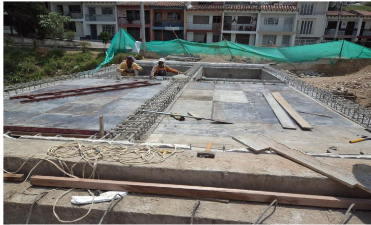
Fotografía 35. Formaleta para losa maciza
