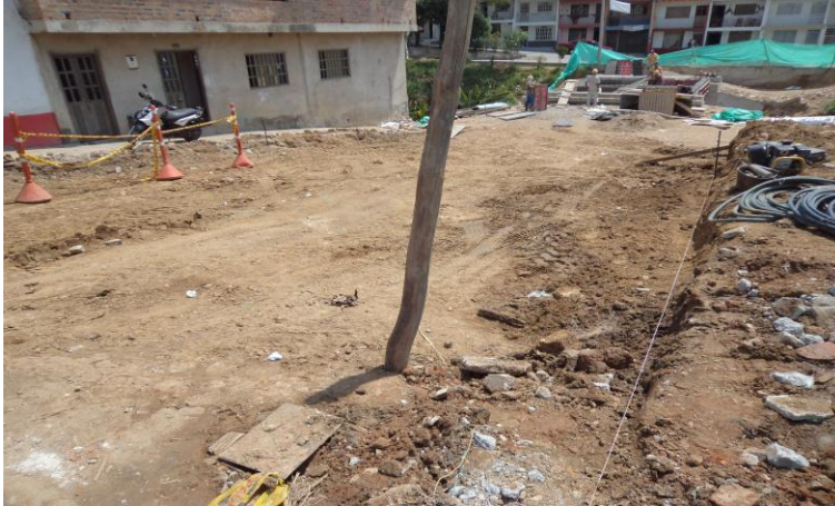
Fotografía 43. Vía de acceso
