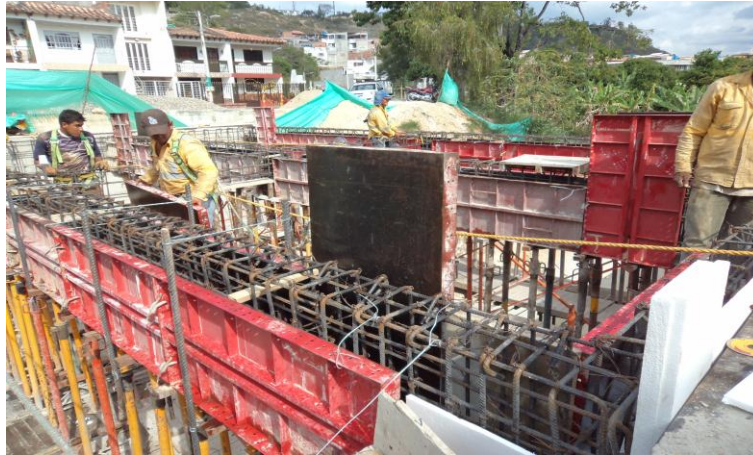
Fotografía 30. Formaleta para viga
