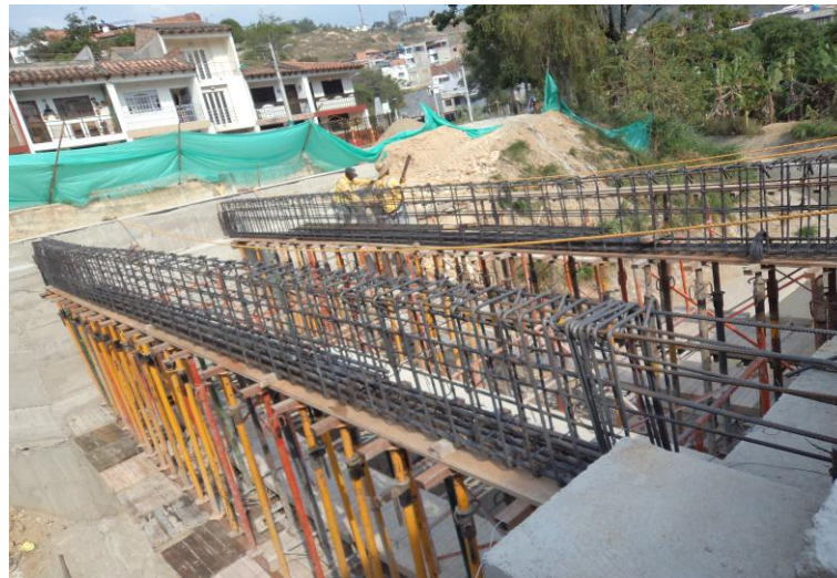
Fotografía 27: acero para vigas
