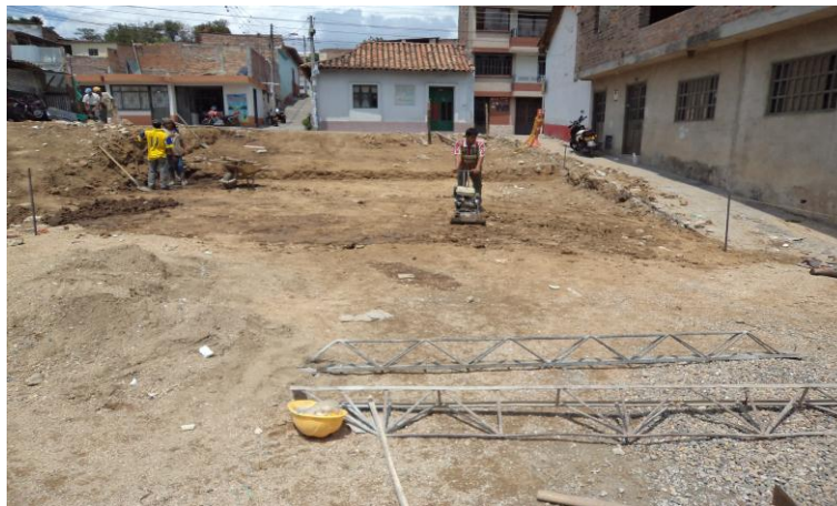
Fotografía 44. Vía de acceso
