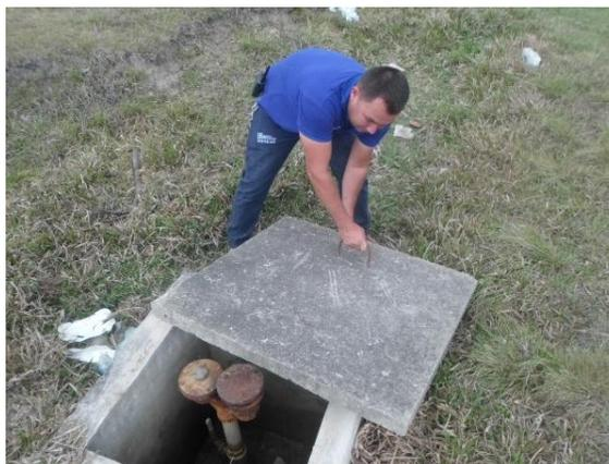
Figura 38. Identificación de los accesorios de la tubería de 18" A.C. en el tramo 1. Fuente. Pasante del proyecto.
