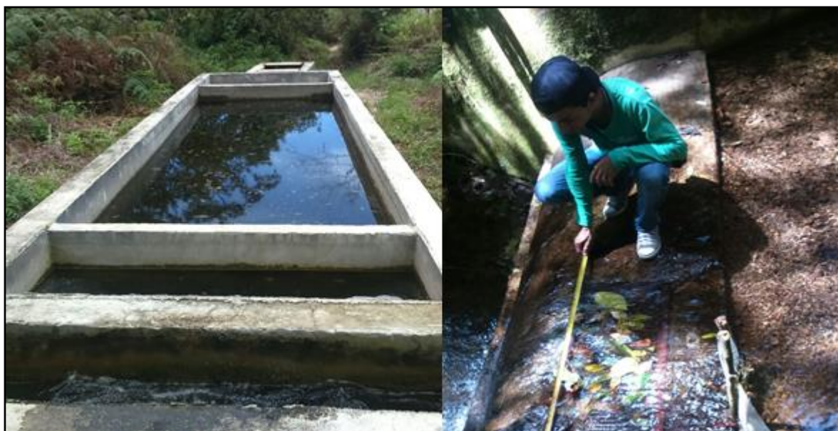
Figura 16. Inspección visual de bocatoma, desarenador. Fuente: Autores del proyecto.
