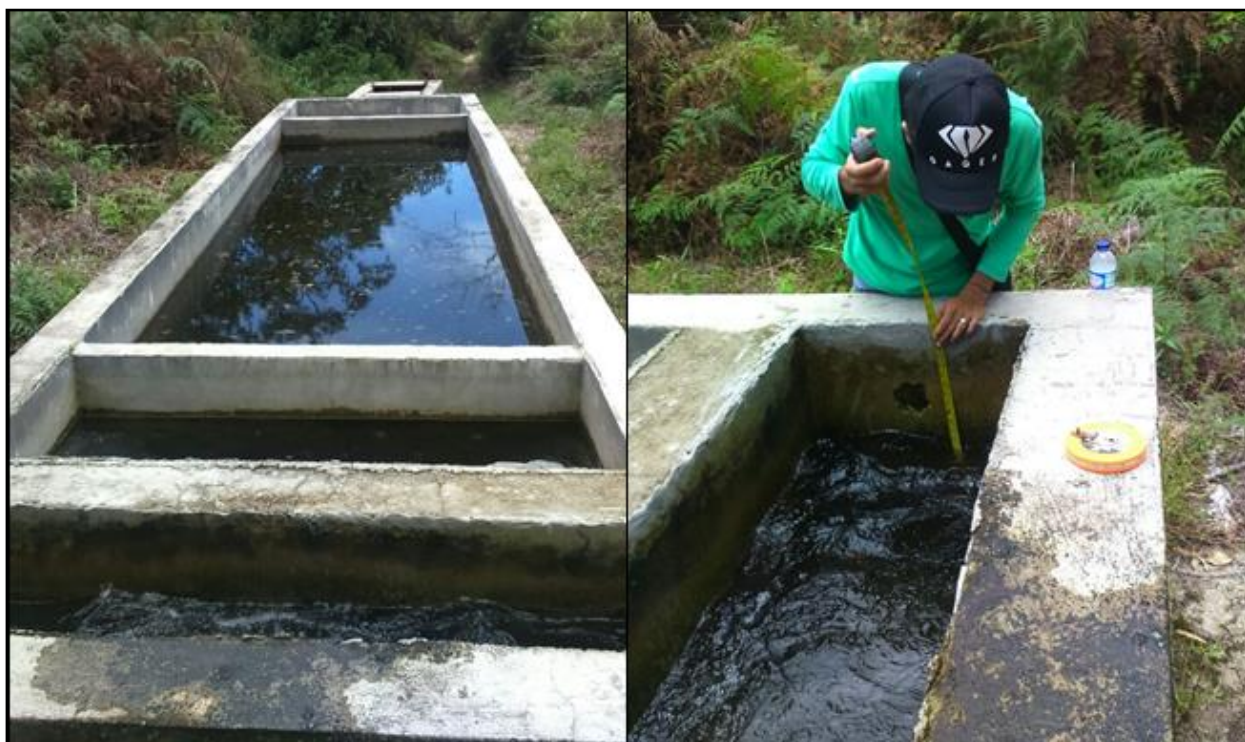
Figura 35. Infraestructura de desarenador existente. Fuente: Autores del proyecto.
