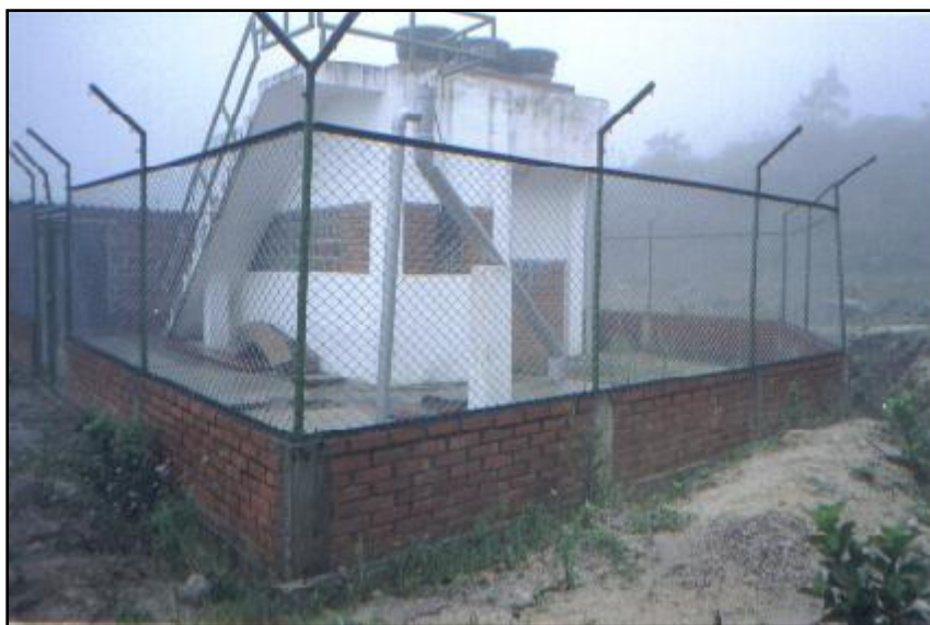
Figura 40. Estructura física de la planta de tratamiento. Fuente: Autores del proyecto.
