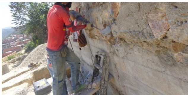
Figura 25. Demolición de concreto ciclópeo.
