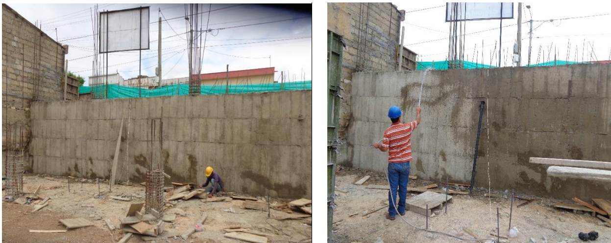
Figura 48. Muro de contención finalizado y Proceso de curado.
