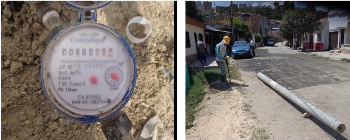
Figura 22. Instalación de medidor y Excavación para poste de luz
