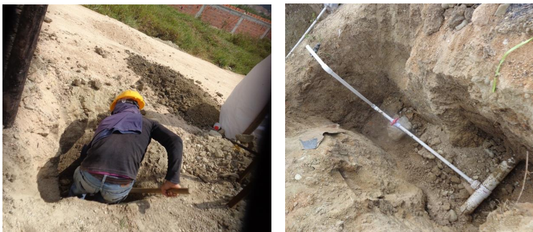
Figura 21. Excavación para agua potable e Instalación de tubería
