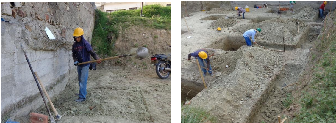
Figura 14. Replanteo de zapatas y Excavacion de zapatas
