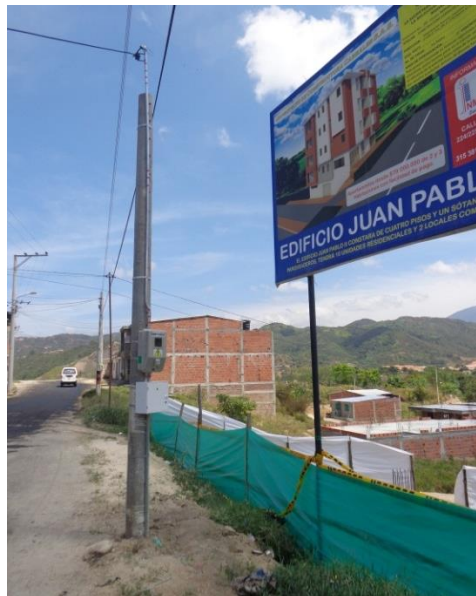
Figura 23. Instalación de Poste de luz
