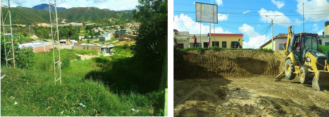
Figura 10. Lote antes de la adecuación y Descapote mecánico y limpieza
