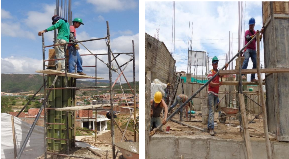
Figura 51. Encofrado de columnas y Ubicación de puntales
