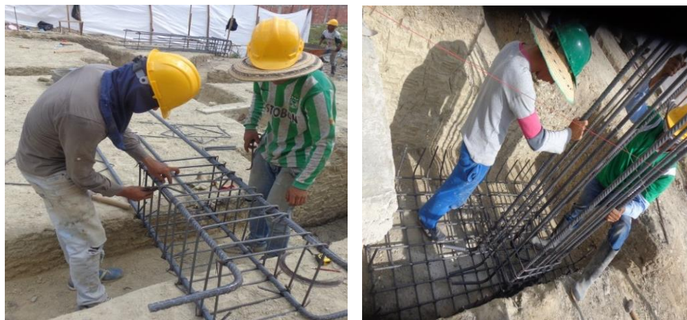
Figura 33. Instalacion de flejes para pedestal y Ubicación de columna
