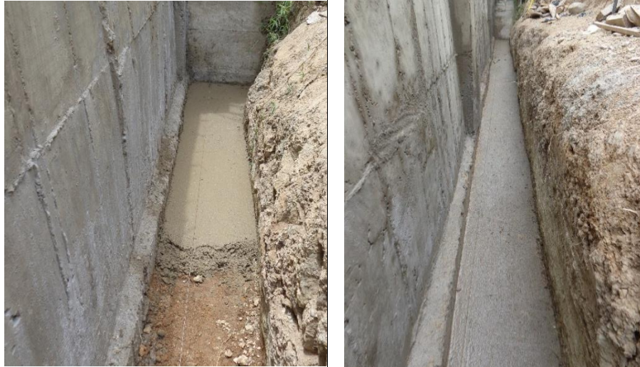
Figura 55. Preparacion de superficie y Impermeabilización.
