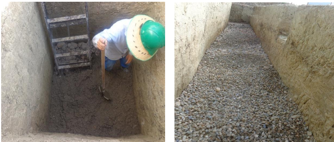
Figura 20. Vaciado de concreto y Pedraplén en zapata combinada
