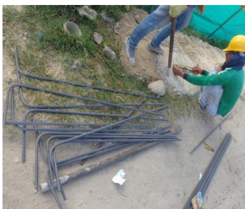
Figura 26. Figurado de acero y Armado de parrillas Fuente: Pasante
