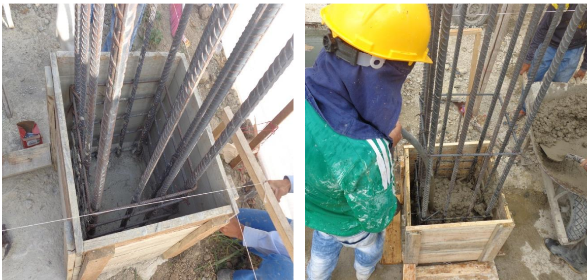
Figura 35. Encofrado de pedestales y Fundición de pedestales
