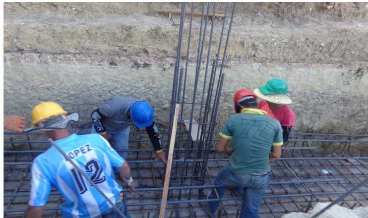
Figura 30. Armado de parrila superior de zapada combinada
