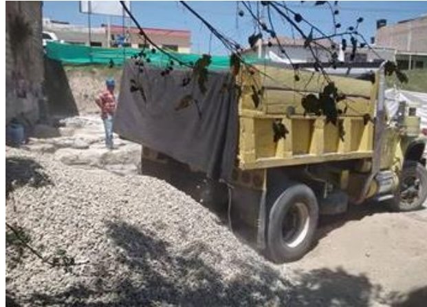
Figura 61. Descargue de triturado.
