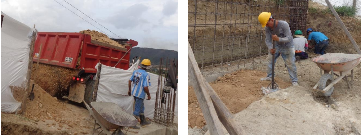
Figura 43. Descargue de material de relleno y Compactación de relleno.
