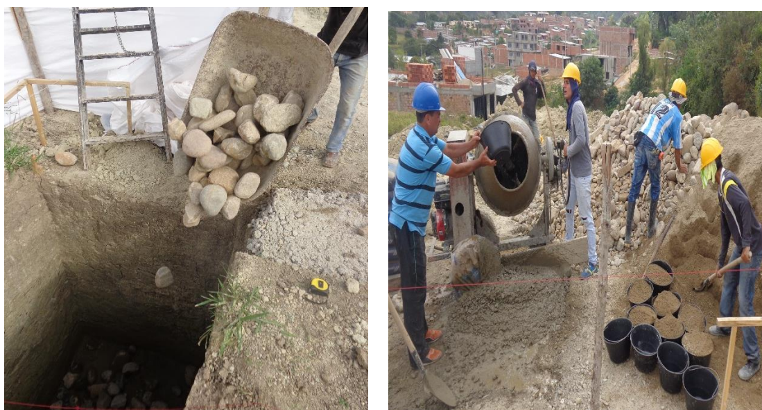
Figura 19. Ubicación de las piedras y Preparación de la mezcla
