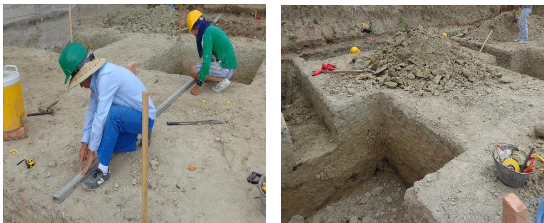
Figura 17. Replanteo de vigas de amarre y Excavacion de vigas de amarre
