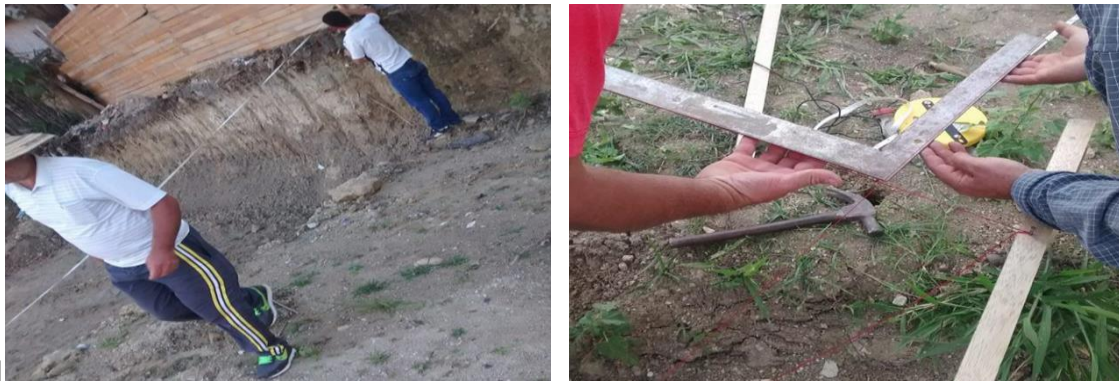
Figura 11. Localización y replanteo y Trazado de ejes.
