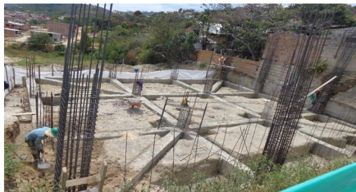
Figura 42. Fundida de vigas de amarre finalizado.
