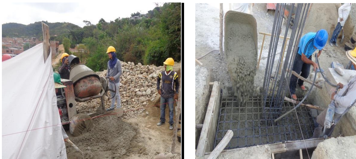
Figura 32. Preparacion de la mezcla y Fundición y vibrado
