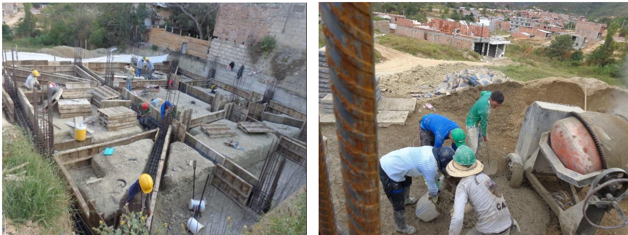
Figura 39. Ecofrado de vigas de amarre y Preparación de la mezcla.
