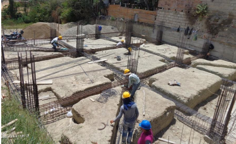
Figura 38. Armado de vigas de amarre finalizado.
