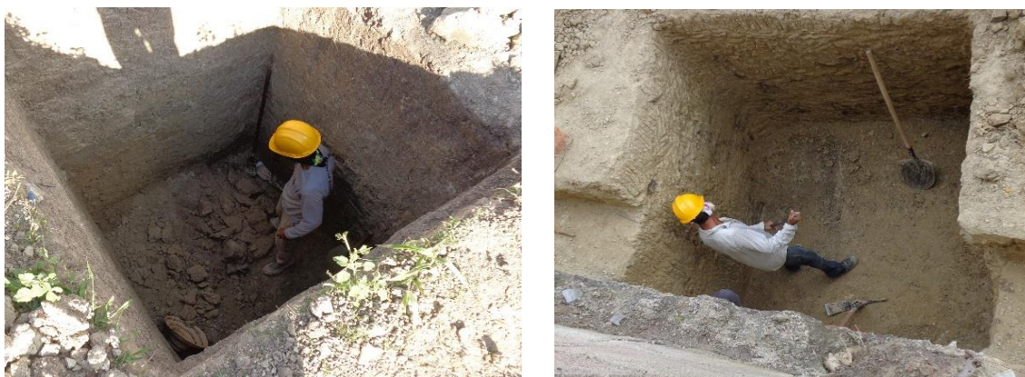
Figura 15. Excavación de la zapata C1 y Excavación de la zapata C14
