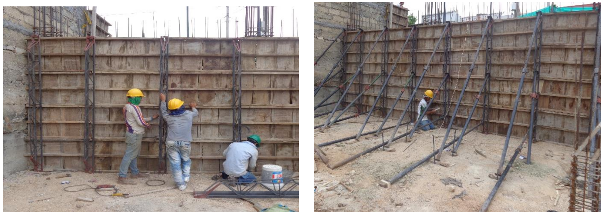
Figura 46. Ubicación de cerchas metálicas y Apuntalamiento de muro.
