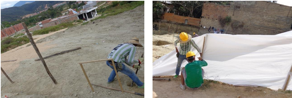
Figura 13. Ubicación de los postes e Instalación del cerramiento.
