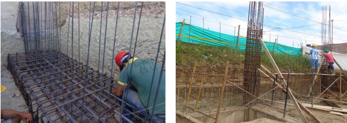
Figura 44. Armadura transversal y Armadura longitudinal.
