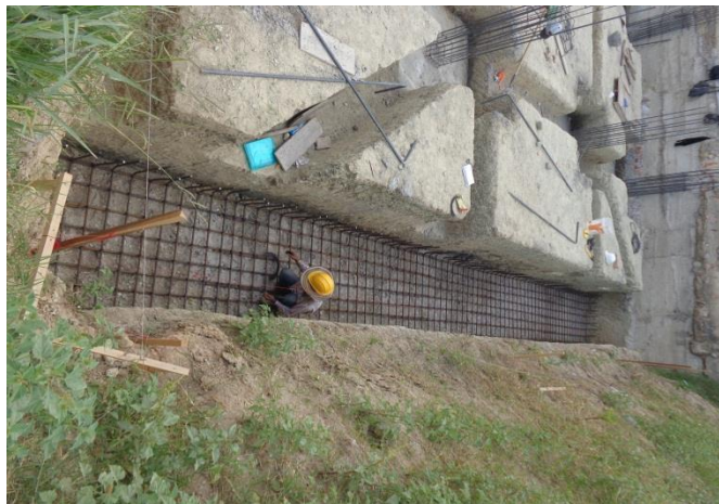
Figura 28. Armado de parrilla inferior de zapata combinada
