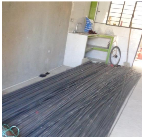
Figura 59. Almacenamiento del acero de refuerzo.
