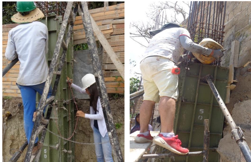
Figura 52. Aplome de columna y Vertido de concreto
