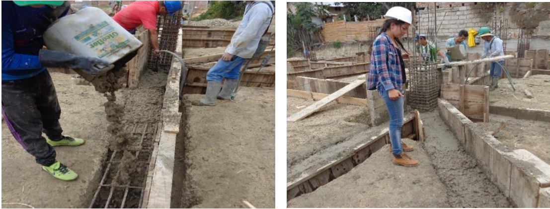
Figura 40. Vaciado de concreto y Revisión de concreto de vigas
