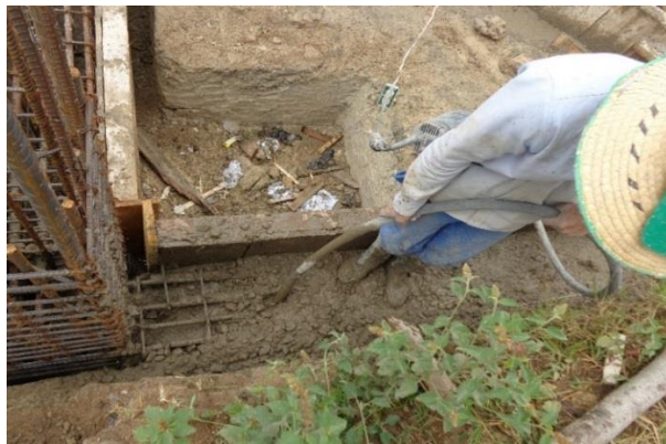
Figura 41. Vibrado de concreto.
