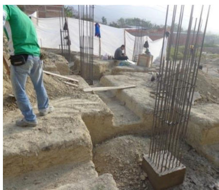
Figura 36. Relleno hasta nivel de pedestal.
