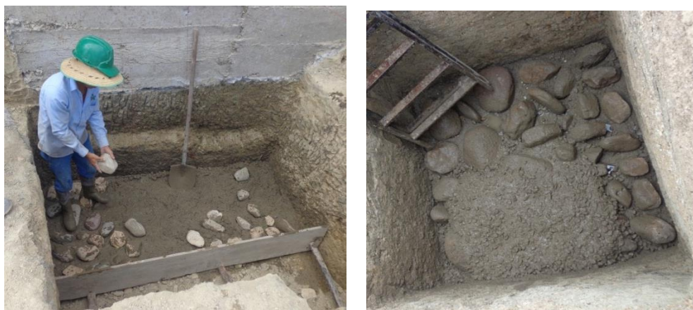
Figura 24. Ubicación de piedras (40%) y Vertido de concreto 1:2:3 (60%)
