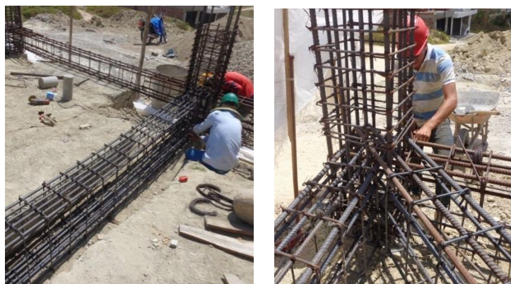
Figura 37. Armado de vigas de amarre y Anclajes de viga y columna
