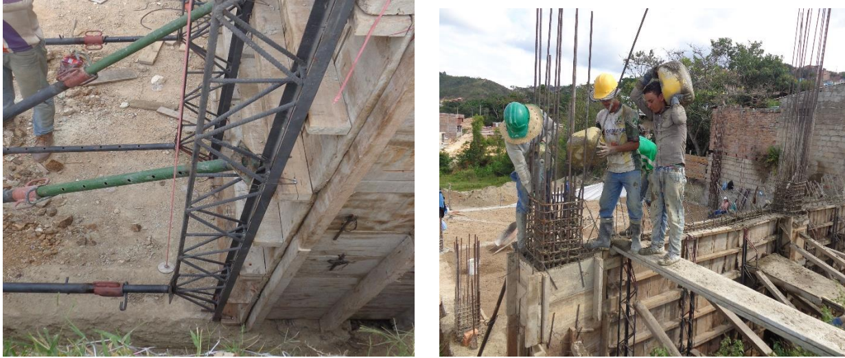
Figura 47. Aplome de muro y Vertido y vibrado de concreto.
