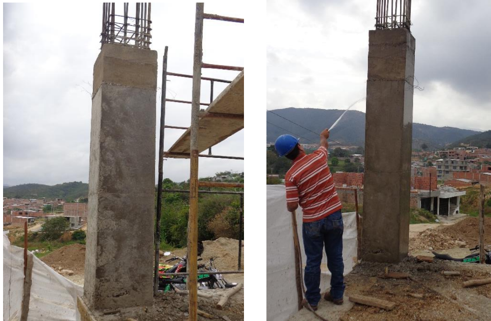
Figura 53. Columna C1 y Curado de columnas
