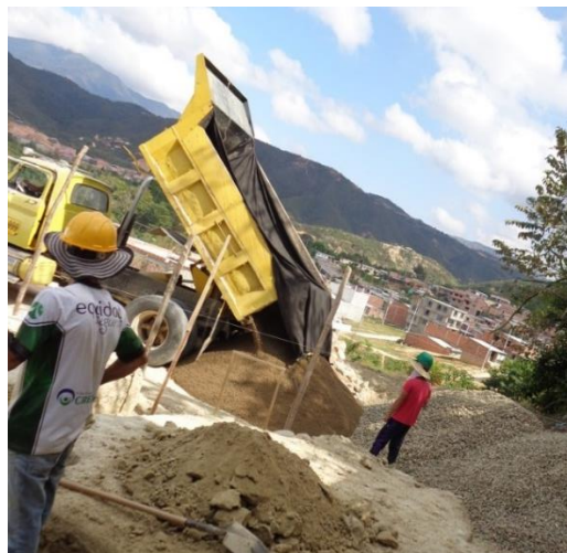
Figura 62. Descargue de arena.
