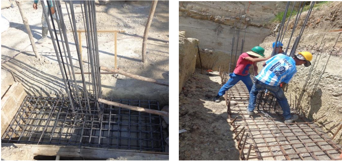
Figura 34. Armado terminado de C5 y Ubicación de columnas en zapata combinada
