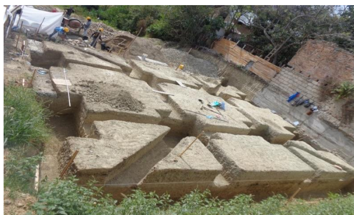
Figura 18. Finalización de excavaciones.
