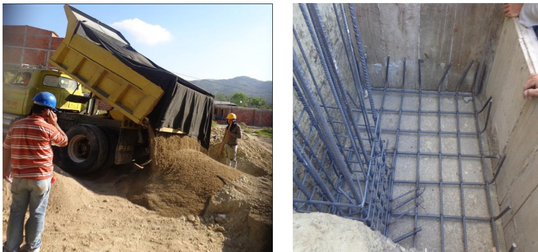
Figura 31. Descargue de arena y Ubicación de tableros
