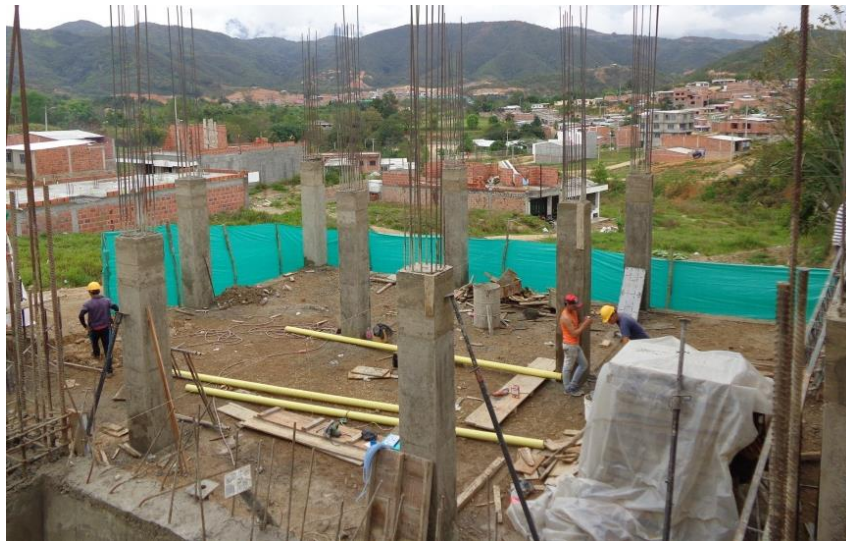
Figura 54. Fundición de columnas finalizada.
