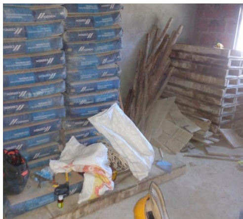
Figura 60. Almacenamiento de cemento.
