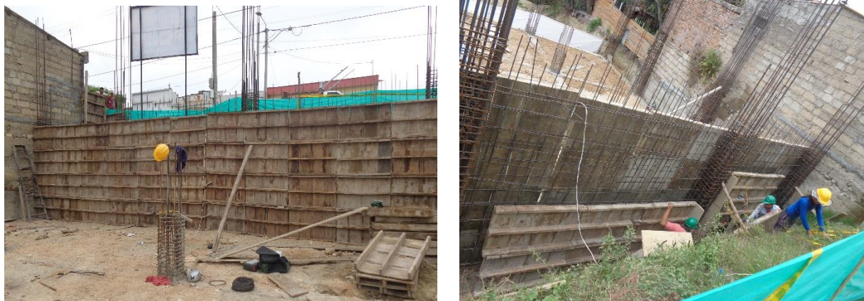
Figura 45. Encofrado parte frontal del muro y Encofrado parte trasera del muro.
