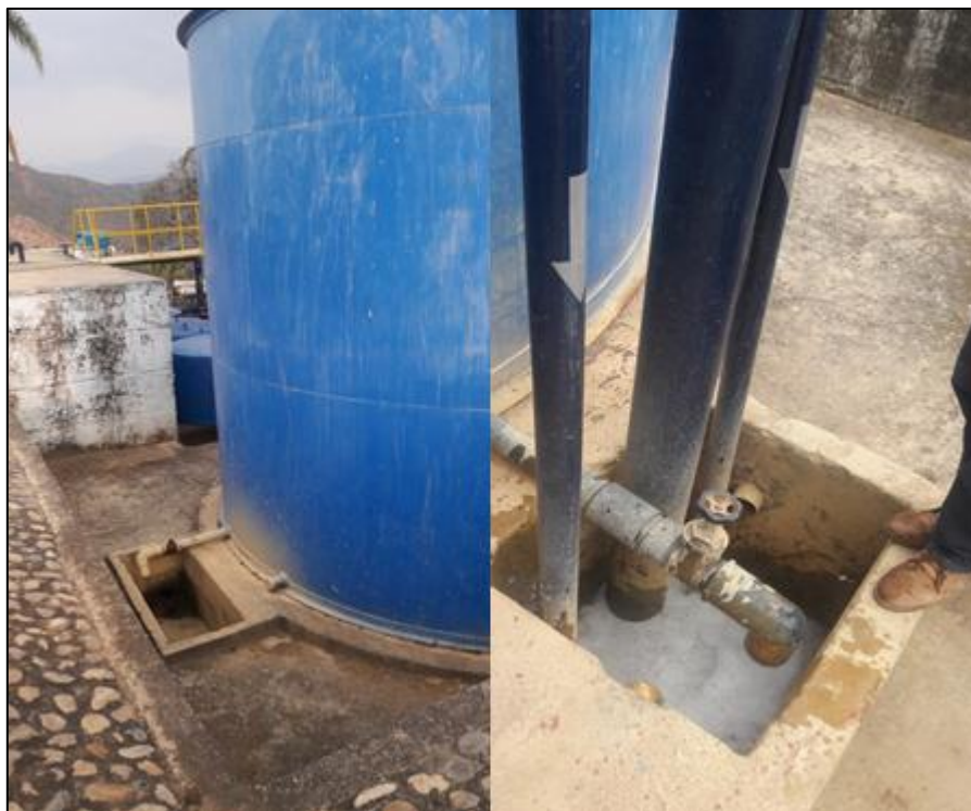
Figura 21. Válvula de cerrado rápido
