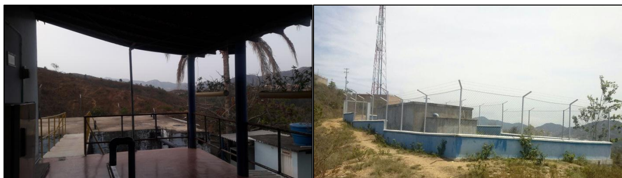
Figura 29. Tanques de almacenamiento N°3 y N°4
