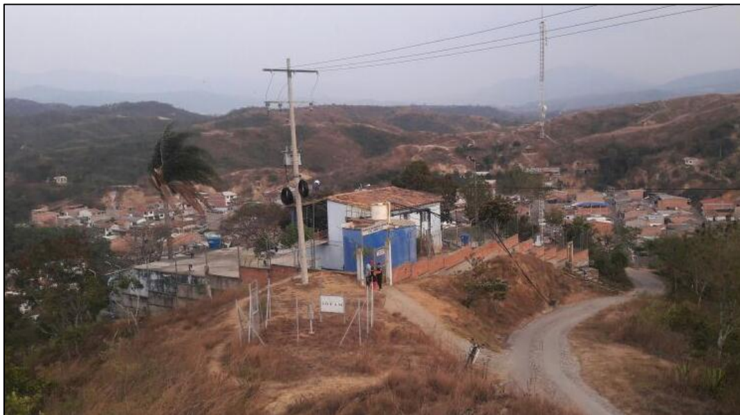
Figura 18. Planta de tratamiento de agua potable
