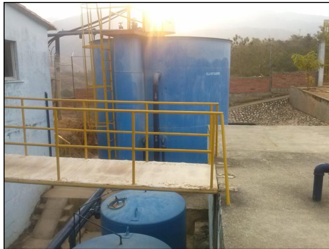
Figura 20. Tanque clarificador
