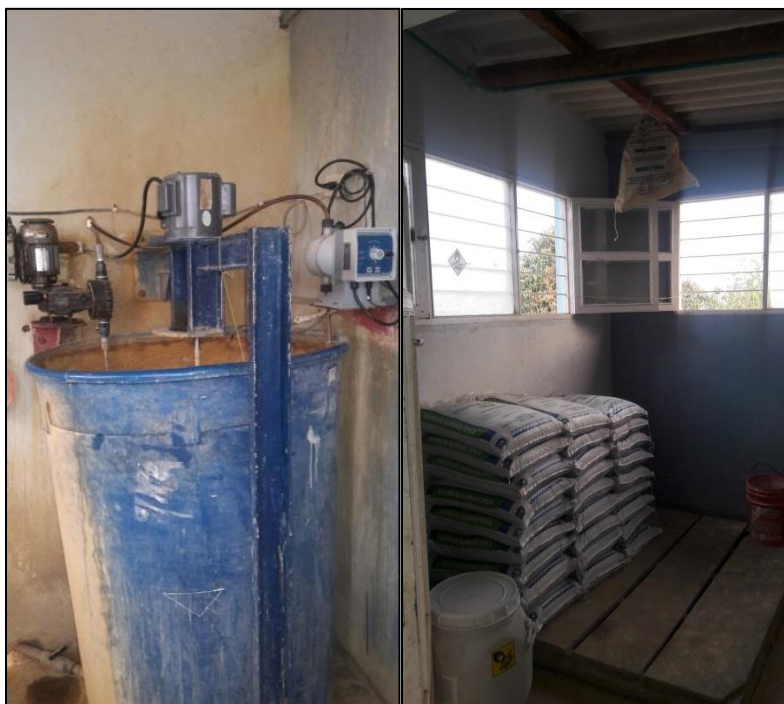
Figura 19. Equipo de coagulación y almacenamiento de sulfato de aluminio tipo b
