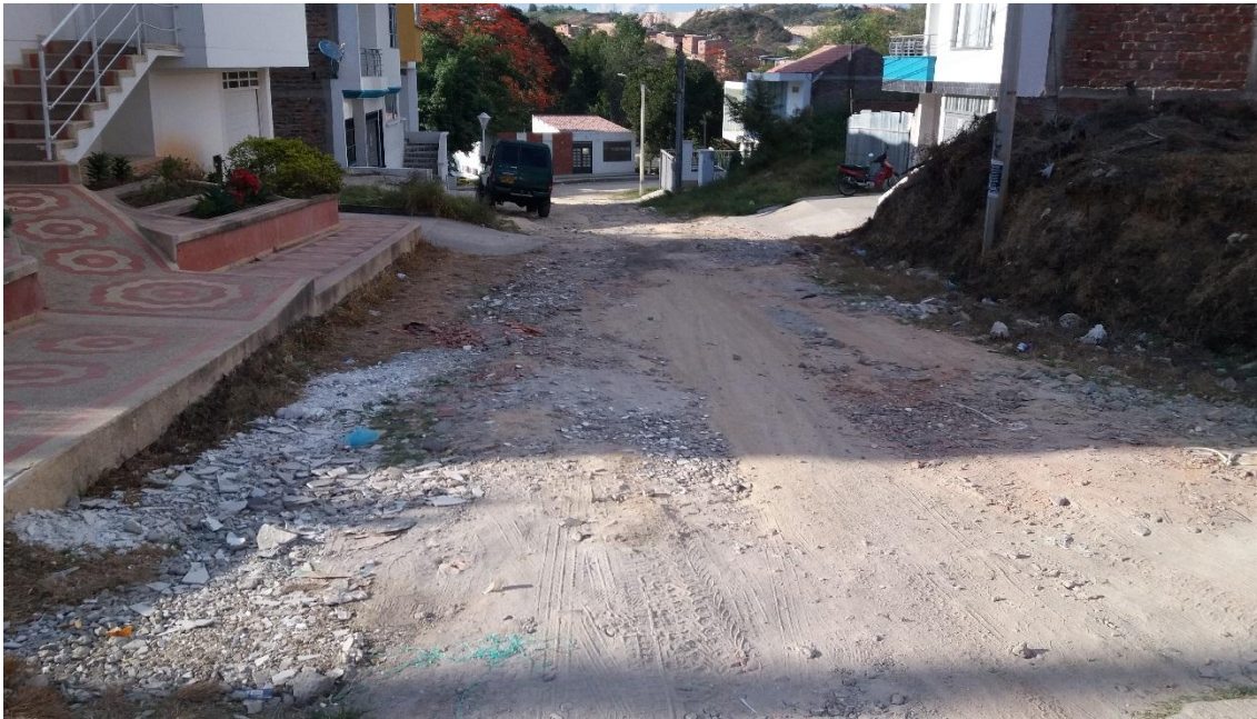
Ilustración 4 RCD en calles de Ocaña Fuente. Autores, 2017.
