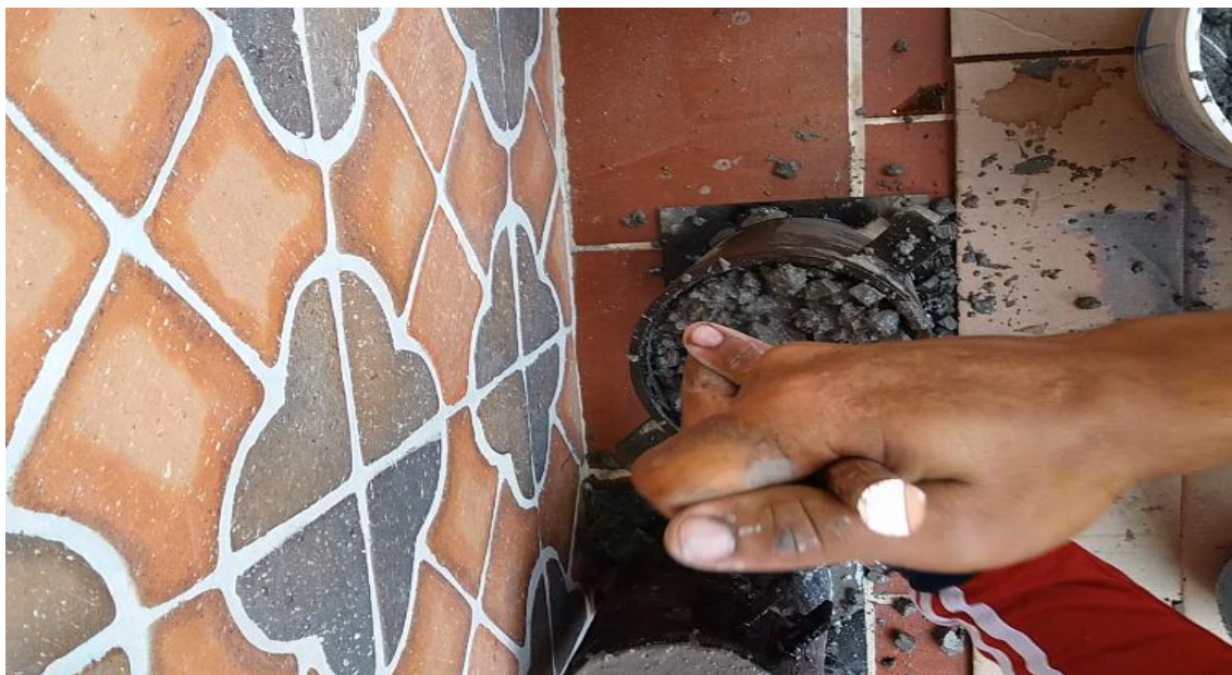
Ilustración 31 Compactado de capas Fuente. Autores, 2017.
