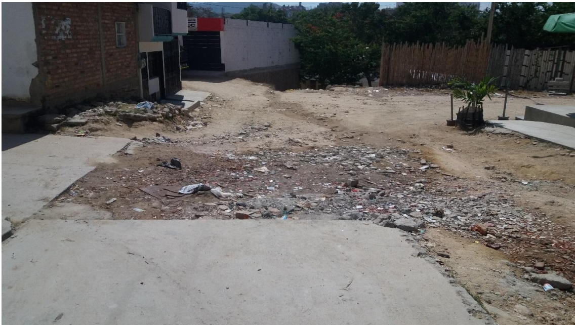
Ilustración 2 RCD en calles de Ocaña Fuente. Autores, 2017.
