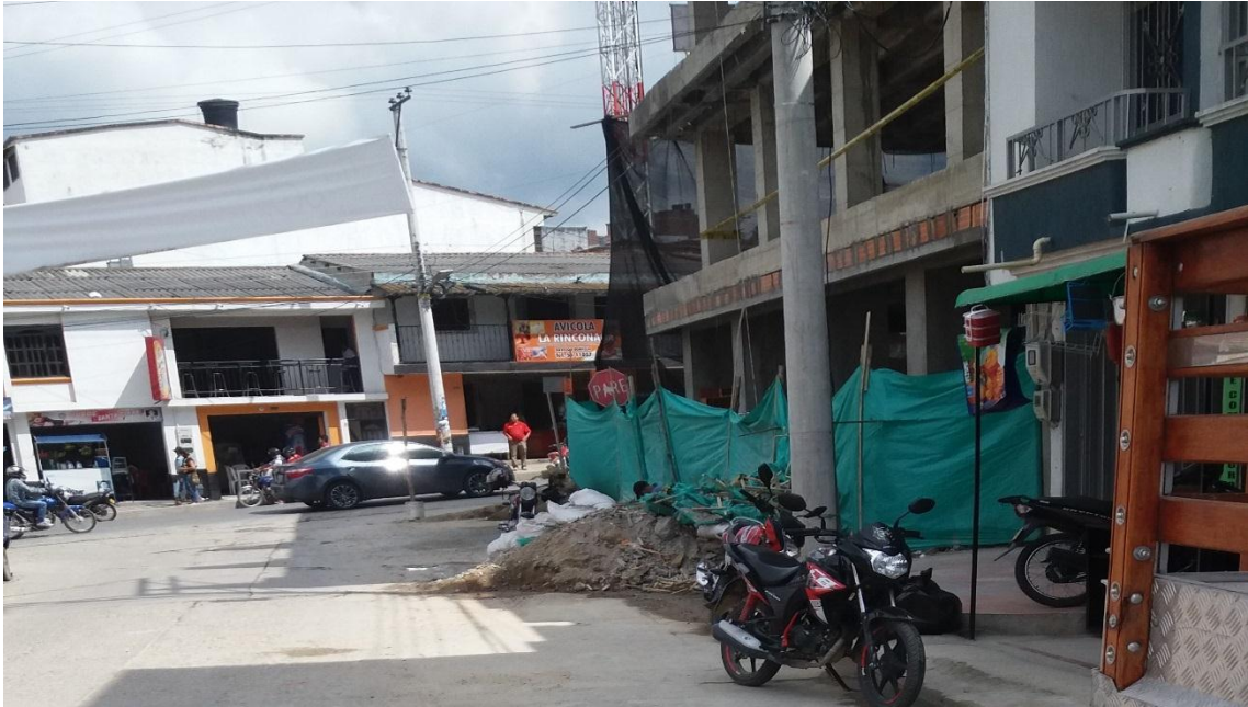
Ilustración 10 RCD en obras
