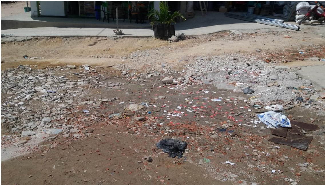
Ilustración 1 RCD en calles de Ocaña Fuente. Autores, 2017.
