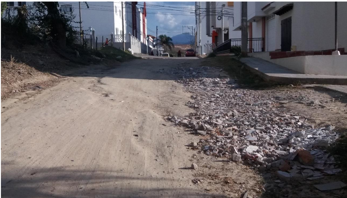
Ilustración 7 RCD en calles de Ocaña Fuente. Autores, 2017.
