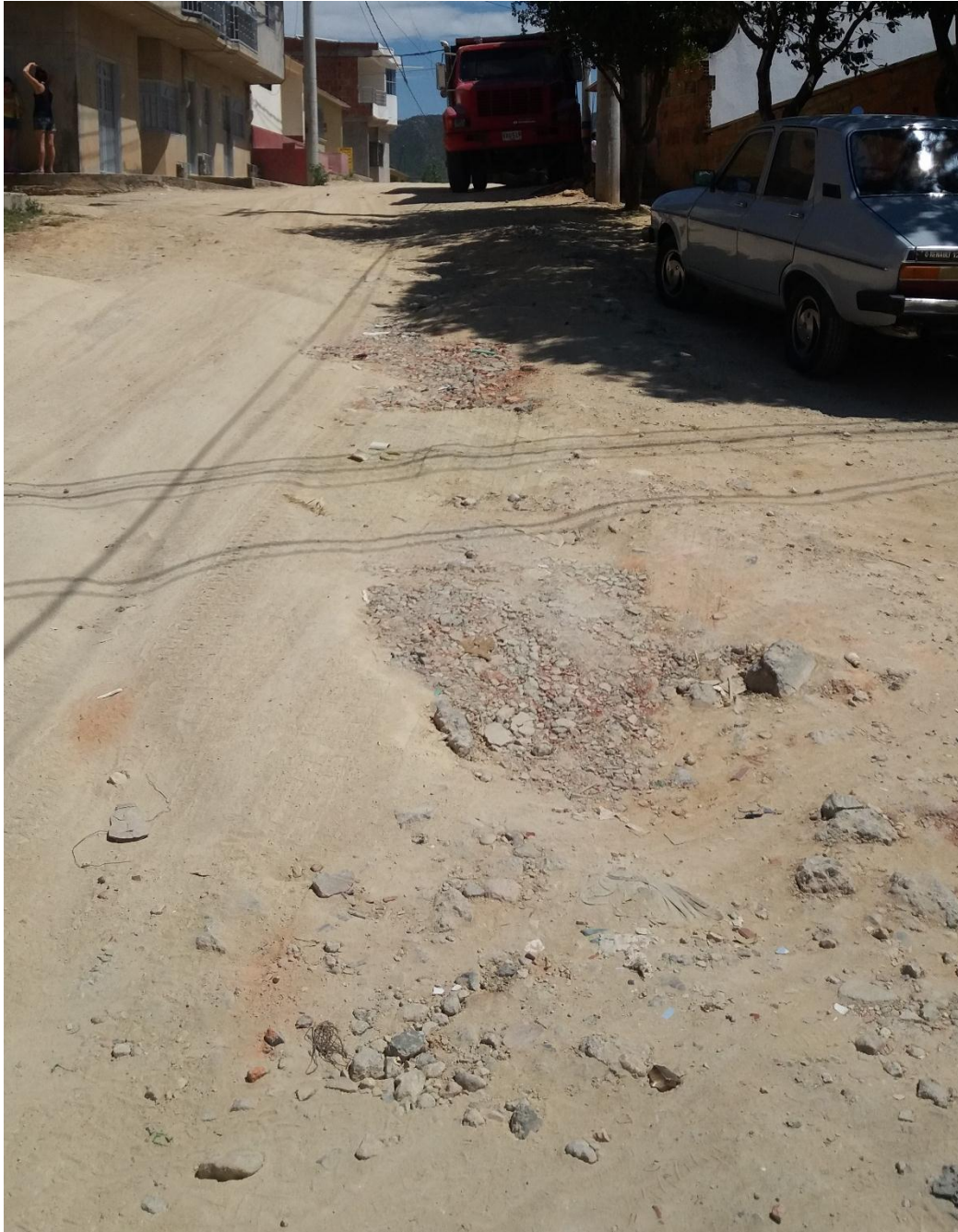
Ilustración 3 RCD en calles de Ocaña Fuente. Autores, 2017.
