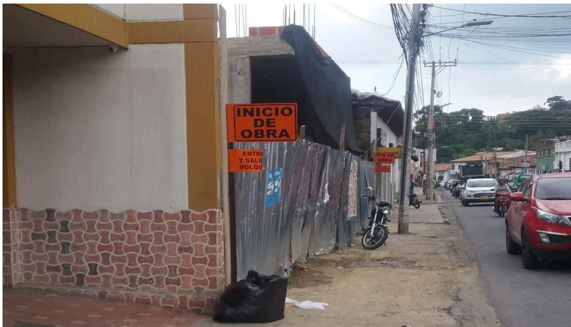
Ilustración 13 RCD en obras
