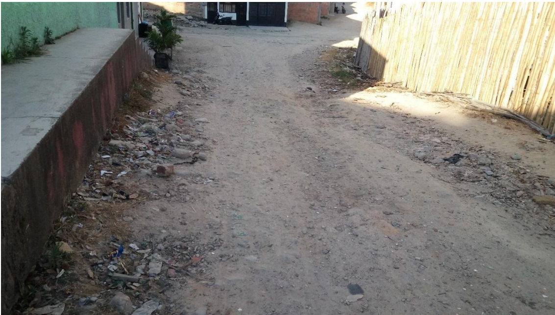
Ilustración 9 RCD en calles de Ocaña Fuente. Autores, 2017.
