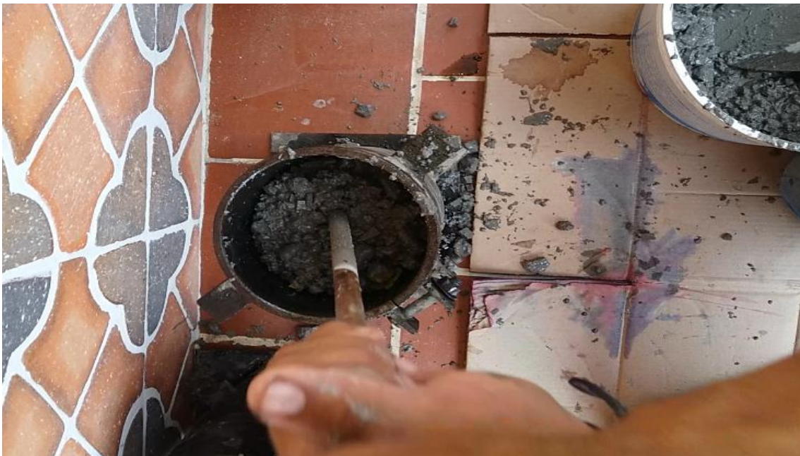
Ilustración 30 Compactado de capas Fuente. Autores, 2017.
