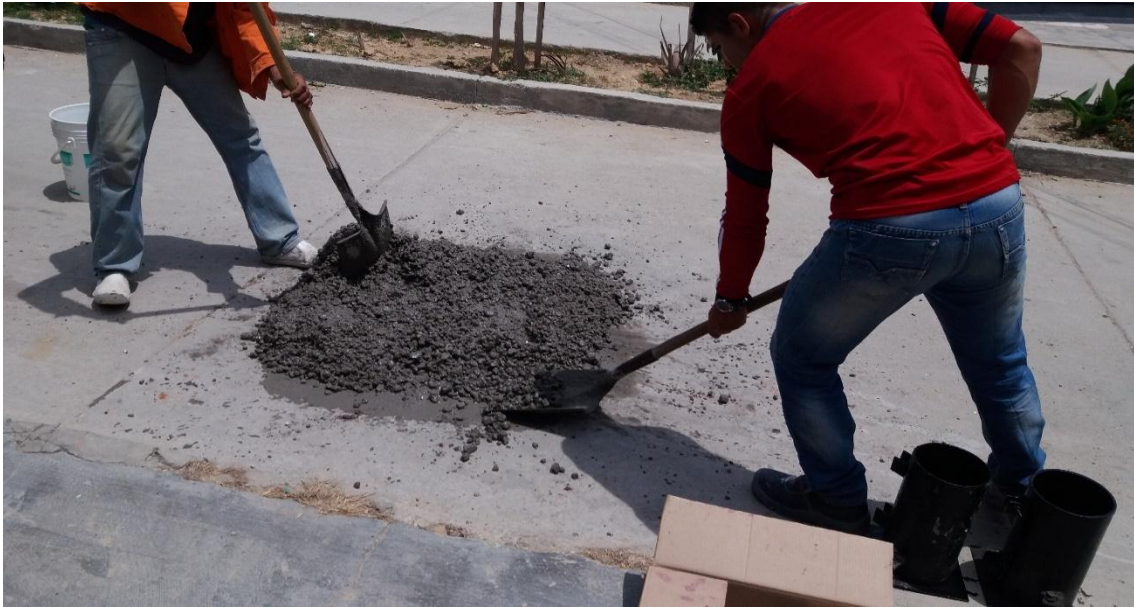
Ilustración 27 Preparación de la mezcla
