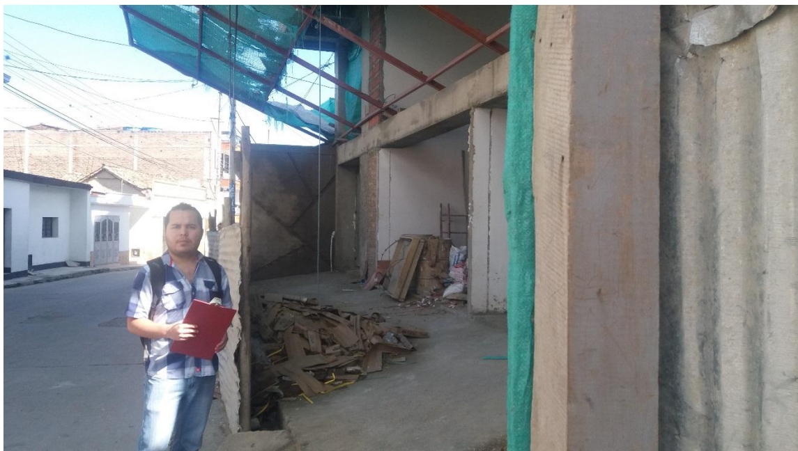
Ilustración 11 RCD en obras
