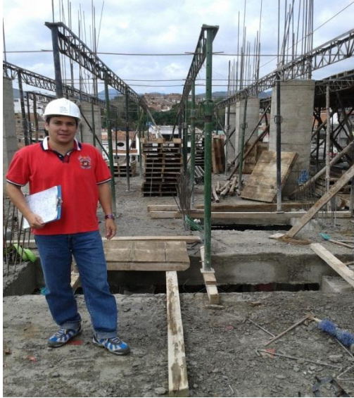
Fotografía 5. Armado de Formaleta para Losa.
