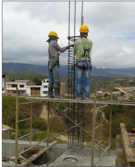
Fotografía 3. Armado de Columnas.
