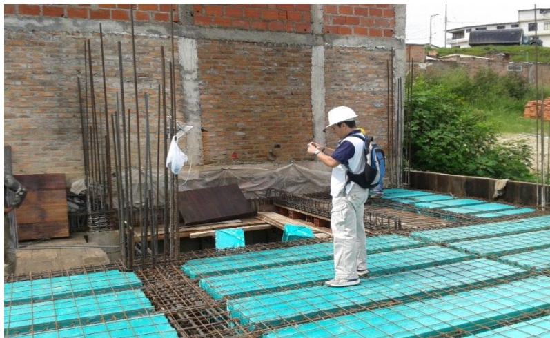
Fotografía 6. Armado de Losa.
