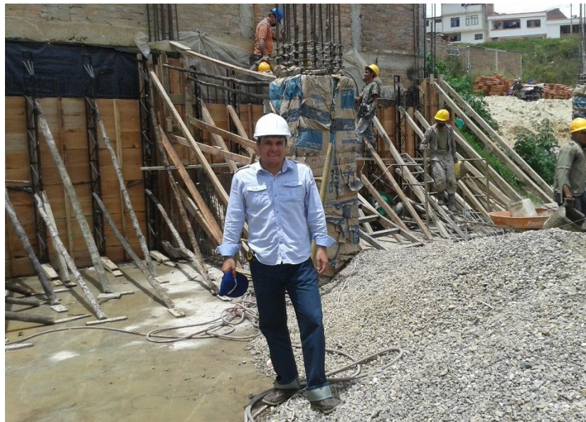
Fotografía 4. Fundida de concreto para columna.
