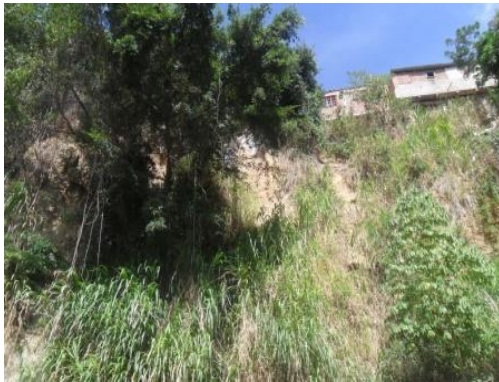
Foto 54. Deslizamiento Activo y Propenso Tipo Caído KRA 115-38
