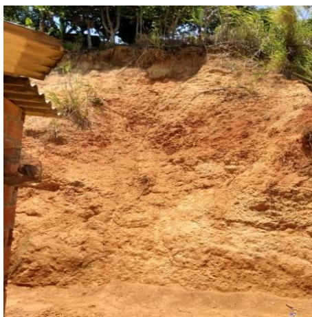
Foto 78. Deslizamiento Activo Tipo Traslacional KDX 405-280
