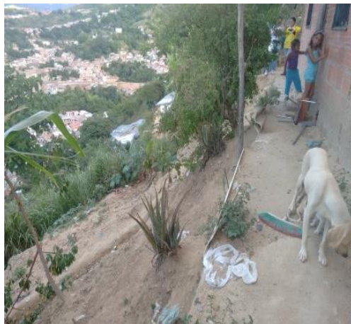
Foto 49. Deslizamiento Inactivo Tipo Propenso Traslacional – Caído KDX 286-670
