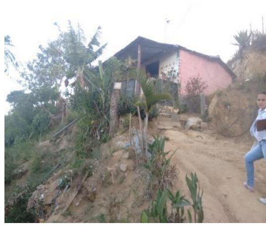
Foto 50. Deslizamiento Inactivo Tipo Propenso Traslacional – Caído KDX 287-870
