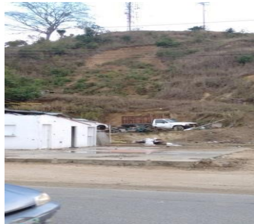
Foto 83. Deslizamiento Activo Tipo Traslacional
