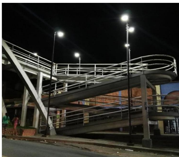
Figura 54. Zona de acceso puente peatonal. Fuente: Autores del proyecto.
