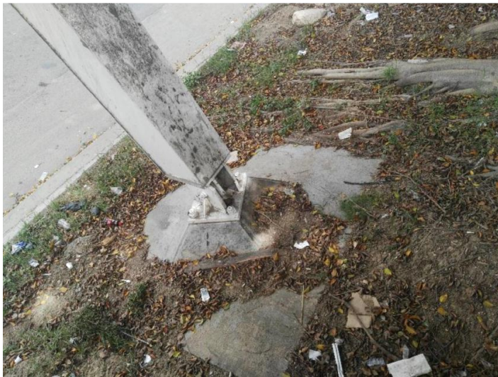
Figura 45. Pedestales y anclaje al arco metálico. Fuente: Autores del proyecto.
