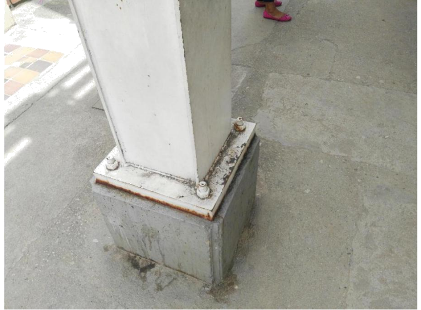
Figura 63. Base o pedestal que soporta columna metálica Fuente: Autores del proyecto.
