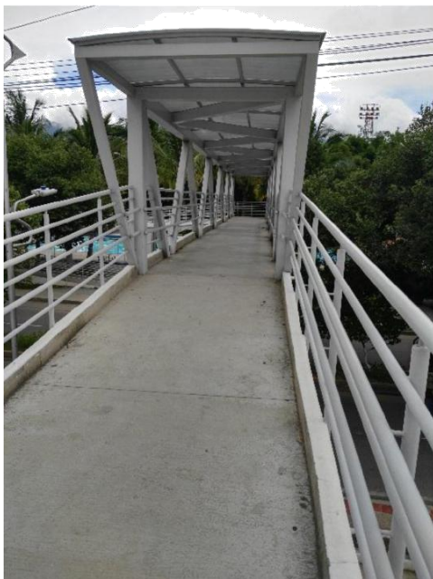
Figura 23. Cubierta y elementos metálicos Fuente: Autores del proyecto.
