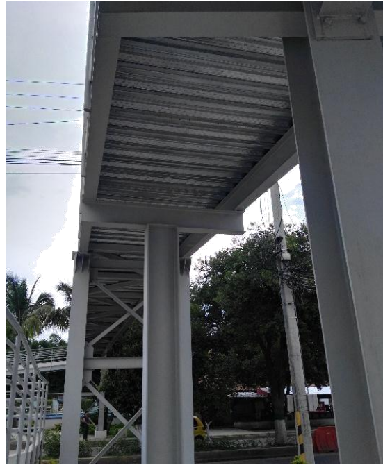
Figura 26. Elementos metálicos Fuente: Autores del proyecto.
