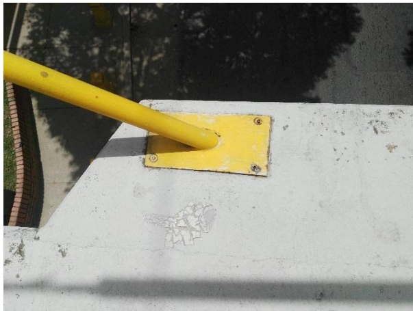
Figura 2. Protección cables sistema atirantado. Fuente: Autores del proyecto.
