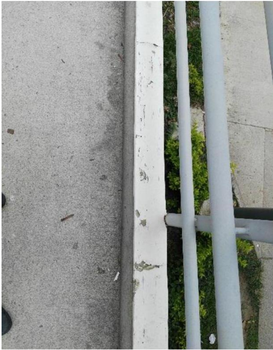
Figura 29. Acabado de bordillos Fuente: Autores del proyecto.
