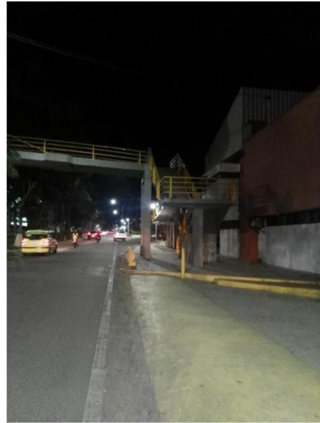
Figura 20. Acceso en escaleras calzada sur sin iluminación Fuente: Autores del proyecto.
