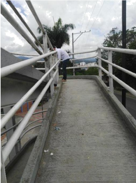
Figura 47. Rampa de acceso. Fuente: Autores del proyecto.
