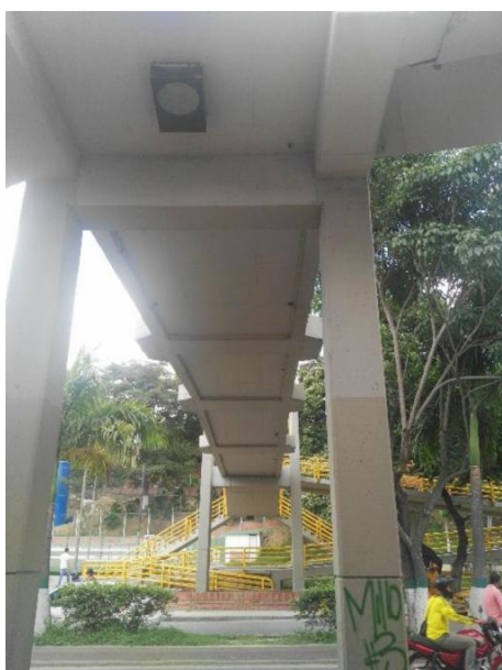
Figura 6. Pórticos que soportan la superestructura. Fuente: Autores del proyecto.
