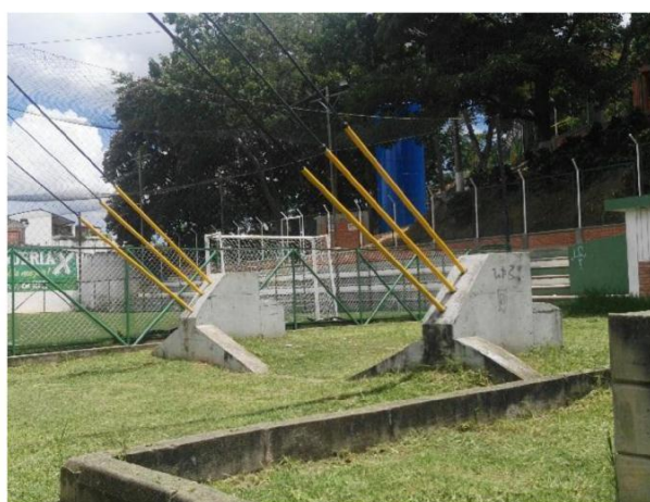
Figura 5. Apoyos sistema atirantado. Fuente: Autores del proyecto.
