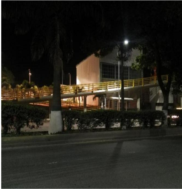
Figura 19. Poca iluminación acceso en rampa calzada sur. Fuente: Autores del proyecto.
