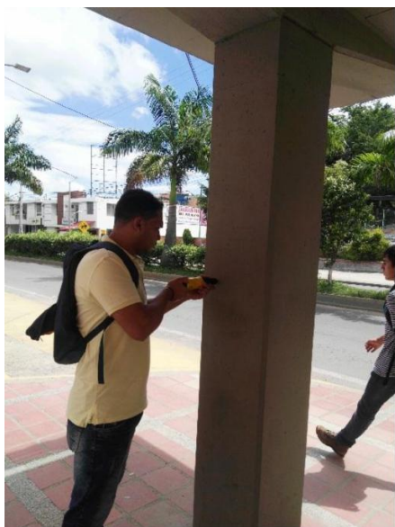
Figura 55. Prueba de esclerómetro. Fuente: Autores del proyecto.
