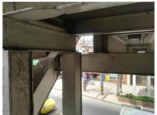
Figura 38. Elementos metálicos estructurales. Fuente: Autores del proyecto.
