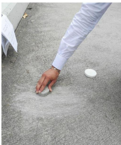
Figura 57. Limpieza de asperezas en la superficie. Fuente: Autores del proyecto.
