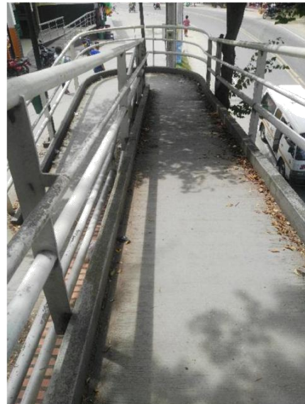
Figura 48. Pasa manos y losa de rampa Fuente: Autores del proyecto.
