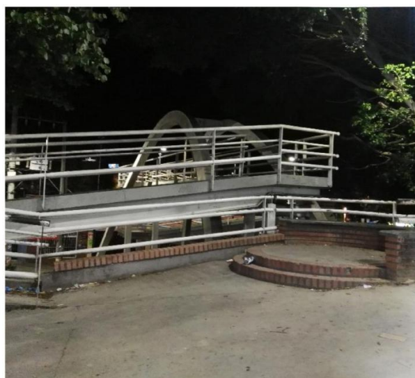
Figura 52. Perfecto estado del alumbrado. Fuente: Autores del proyecto.
