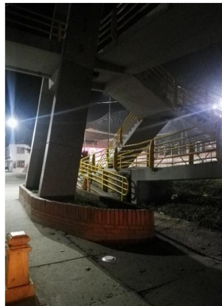
Figura 18. Poca iluminación accesos calzada norte Fuente: Autores del proyecto.
