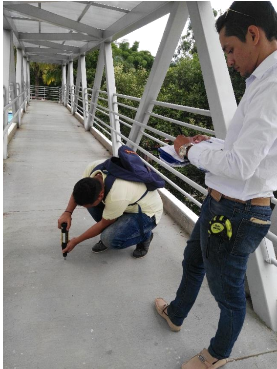
Figura 61. Ensayo esclerómetro losa del tablero Fuente: Autores del proyecto.
