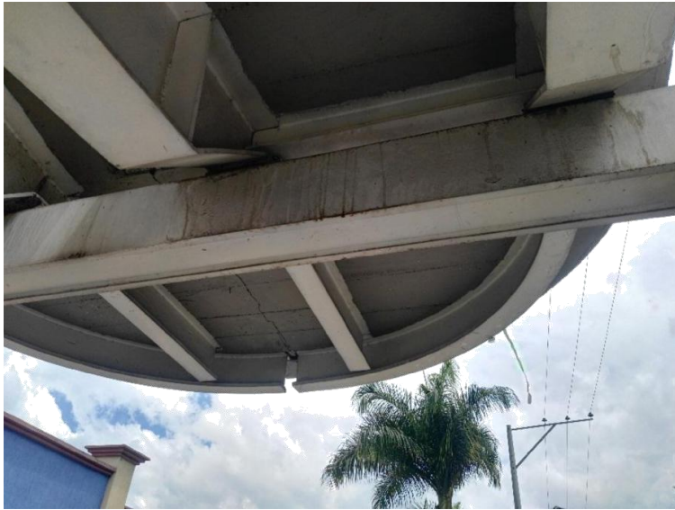
Figura 39. Voladizo y elementos metálicos. Fuente: Autores del proyecto.
