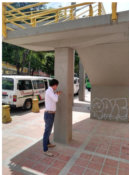
Figura 10. Apoyo acceso en escaleras.
