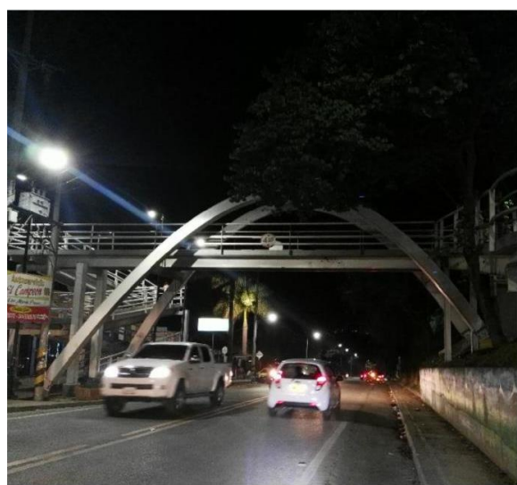
Figura 53. Alumbrado vía Francisco Fernando. Fuente: Autores del proyecto.
