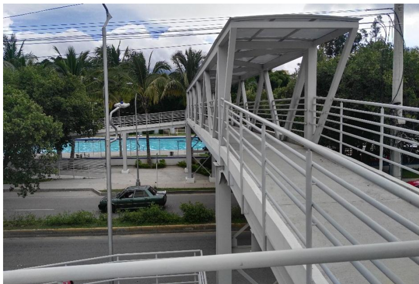
Figura 25. Estado óptimo del puente Peatonal Fuente: Autores del proyecto.
