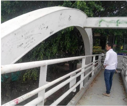
Figura 41. Arco metálico. Fuente: Autores del proyecto.
