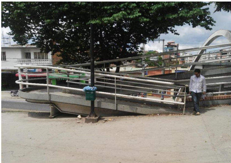
Figura 49. Fin o inicio de rampa de acceso. Fuente: Autores del proyecto.
