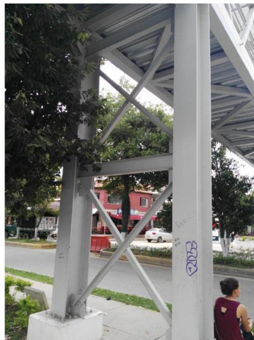
Figura 22. Columnas y viguetas metálicas Fuente: Autores del proyecto.
