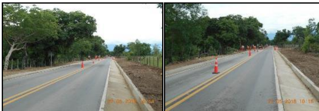
Fotografías 131 y 132. Construcción de cunetas PR 3+770 al PR 4+000.
