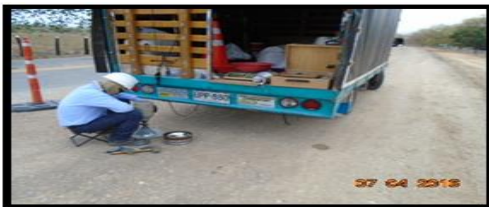
Fotografía 184. Toma de densidades ensayo cono de arena por parte de Gipsas
