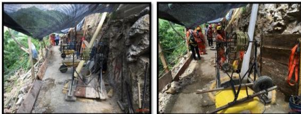
Fotografías 76 y 77. Excavación caissons para muro PR 20 + 523 – PR 20 + 558.
