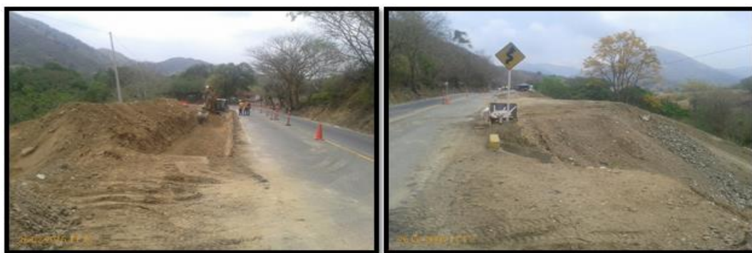
Fotografías 13 y 14. Excavación para mejoramiento de terreno PR 19 + 830.
