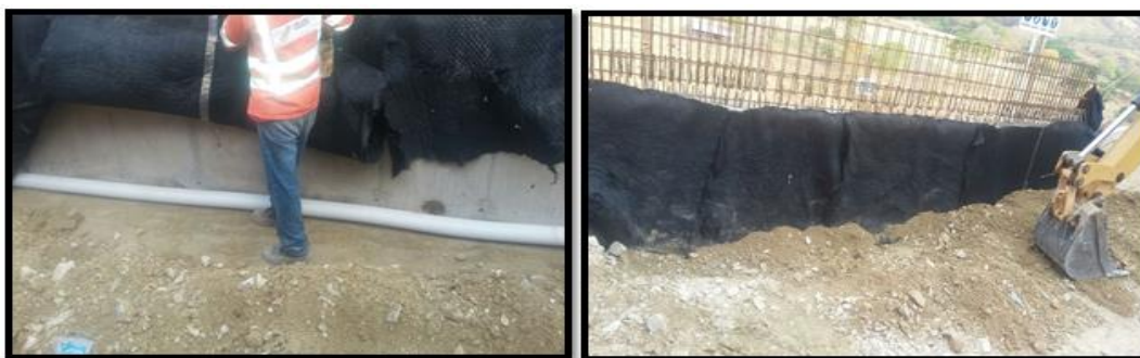
Fotografías 23 y 24. Corrección tubo de drenaje y subdren.
