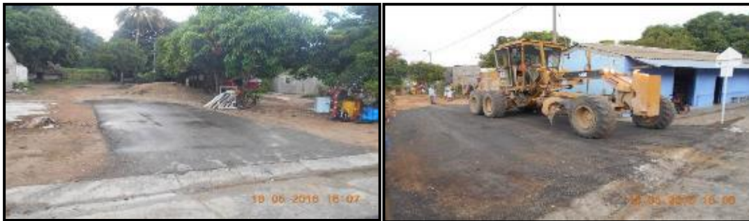
Fotografías 55 Y 56. Acceso PR 6+460.
