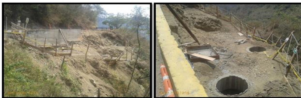
Fotografía 27 y 28. Seguimiento excavación caissons puente 10.
