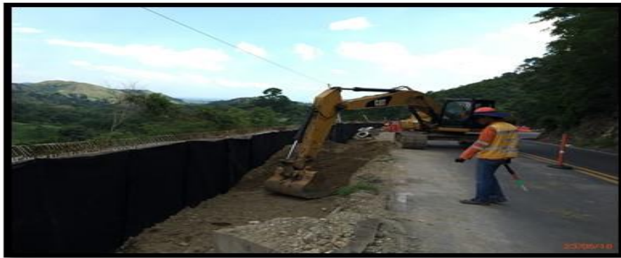
Fotografía 69. Relleno y compactado de material para muro PR 20 + 390 al PR 20 + 420.
