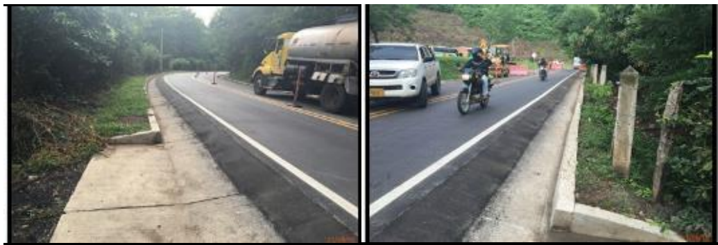
Fotografías 57 Y 58. Construcción de chaflán.
