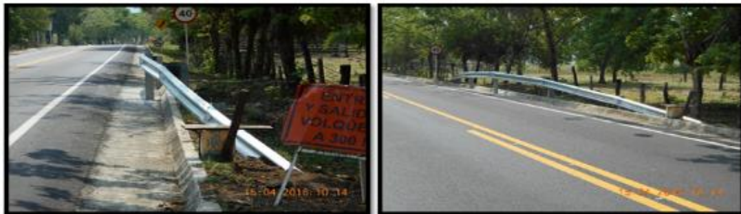
Fotografías 53 y 54. Instalación de Barreras Metálicas PR 5+600.
