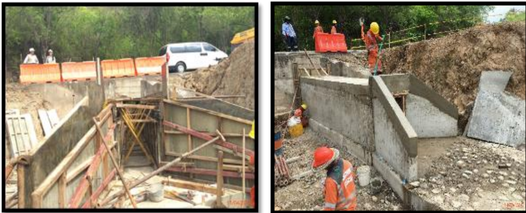
Fotografías 140 y 141. Prolongación Box Culvert PR 20+227.
