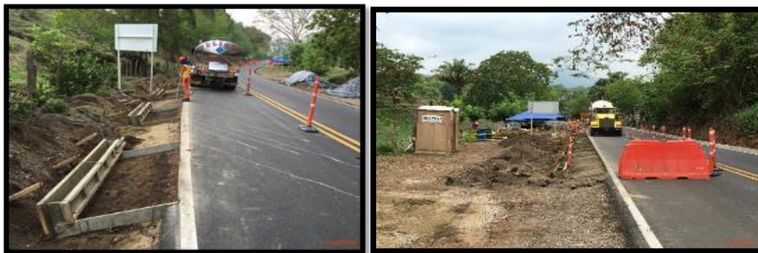
Fotografías 123 y 124. Vaciado de cunetas margen Derecha e izquierda.
