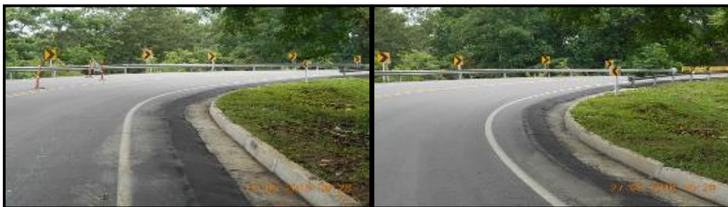
Fotografías 59 y 60. Bordillos pavimento PR 9+170.
