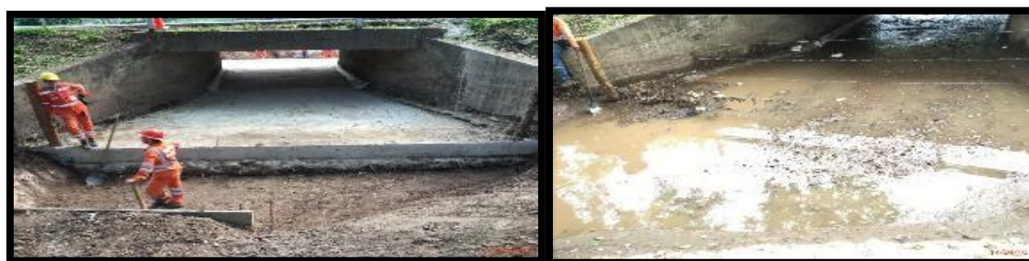
Fotografías 127 y 128. Prolongación de Box Culvert.
