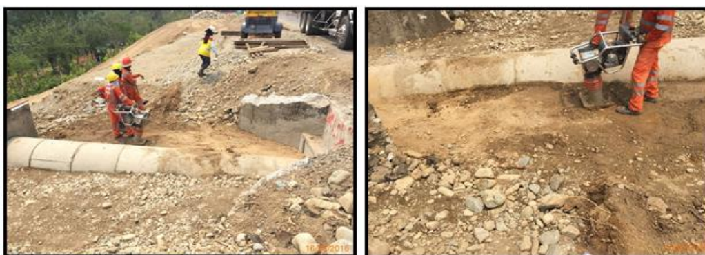
Fotografías 182 y 183. Descapote alcantarilla PR 19 + 830.
