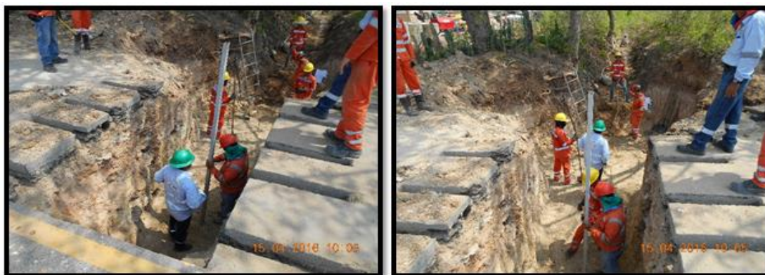
Fotografías 121 y 122. Excavación Alcantarilla PR 3+770.
