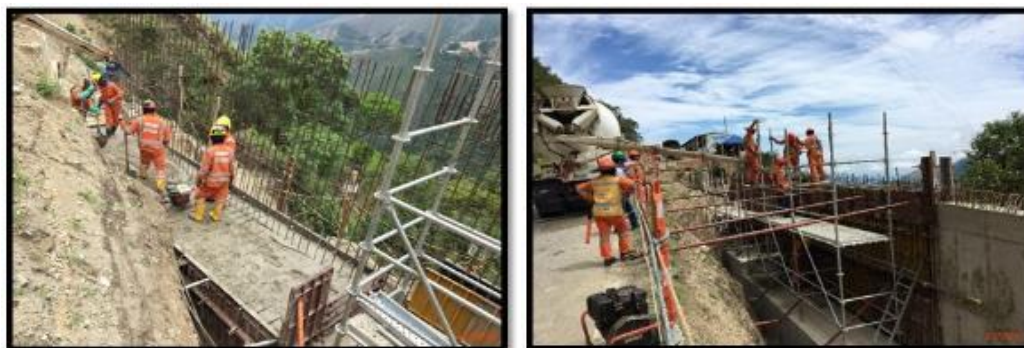
Fotografías 85 y 86. PR 33+117- PR 33+201,72. Excavaciones para construcción de muro.
