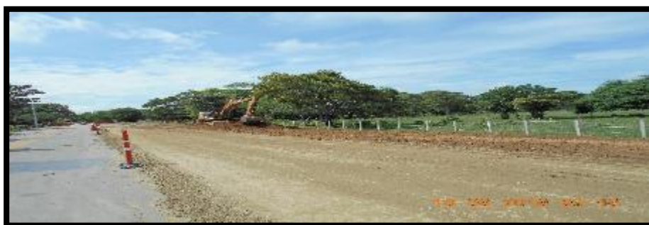
Fotografía 98. Conformación de terraplén.
