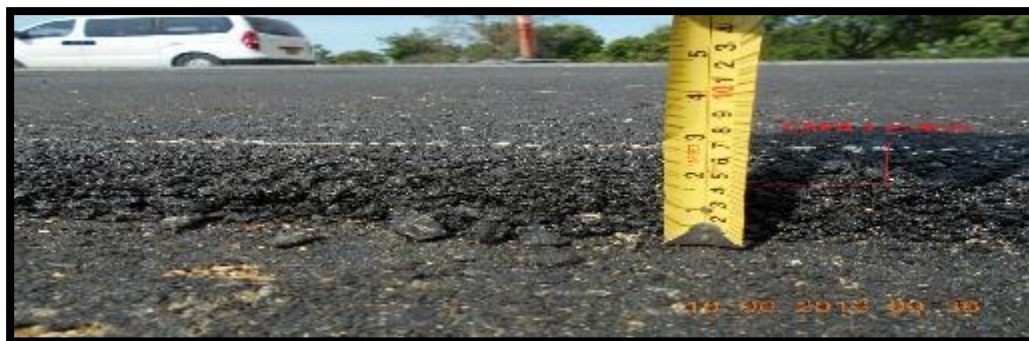
Fotografía 96. Instalación Pavimento Capa 1.
