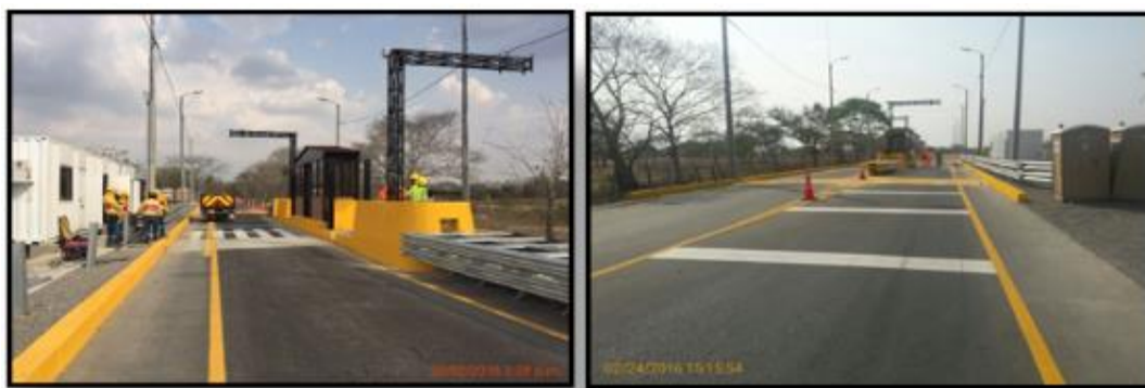
Fotografías 1 y 2. Intervenciones realizadas peaje Gamarra.
