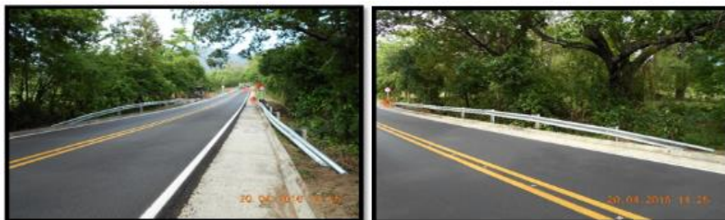
Fotografías 51 y 52. Instalación de Barreras Metálicas PR 6+800.
