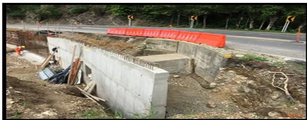
Fotografía 143. Prolongación Box Culvert.
