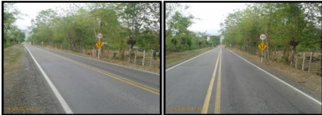
Fotografías 67 y 68. Zona Pesaje Platanal.
