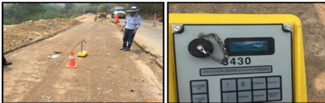
Fotografías 180 y 181. Toma de densidad y humedad sub-base granular entre los K19 + 830 – K19 + 870.
