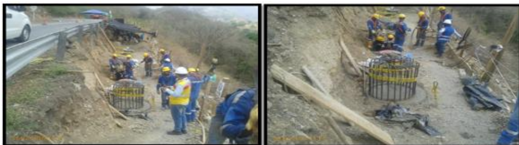
Fotografías 17 y 18. Excavación de caissons PR 20 + 067.
