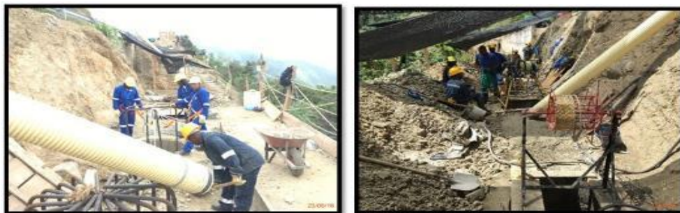
Fotografías 83 y 84. Excavación de Caisson PR 33+006.
