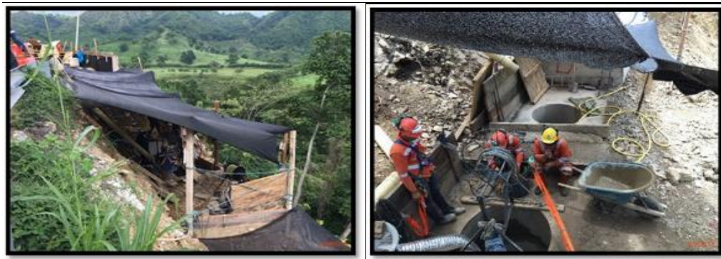
Fotografías 70 y 71. Excavación de caissons PR 20 + 324,95 al PR 20+367,12.
