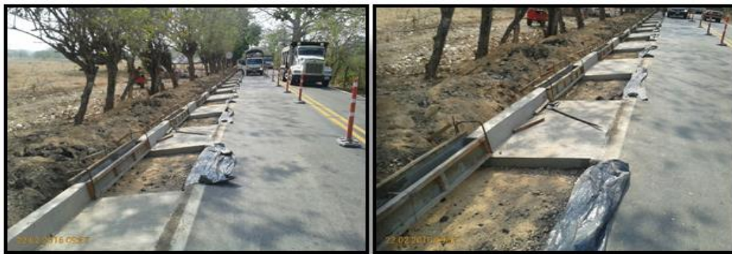
Fotografías 107 y 108. Construcción de cunetas
