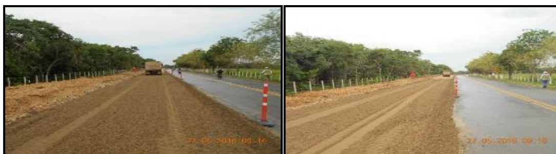
Fotografías 45 y 46. Instalación base granular PR 6 + 680 al PR 7 + 440.
