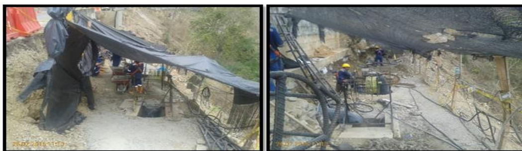
Fotografías 15 y 16. Armado de hierro e instalación de concreto para muros.
