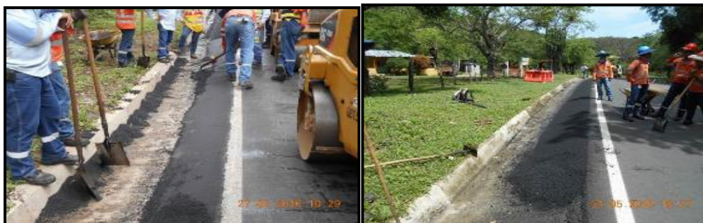
Fotografías 91 y 92. Bordillos de pavimento.
