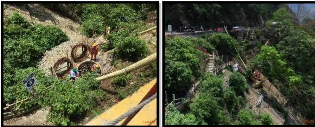
Fotografías 78 y 79. Excavación caisson 3 y fundida caisson 6.
