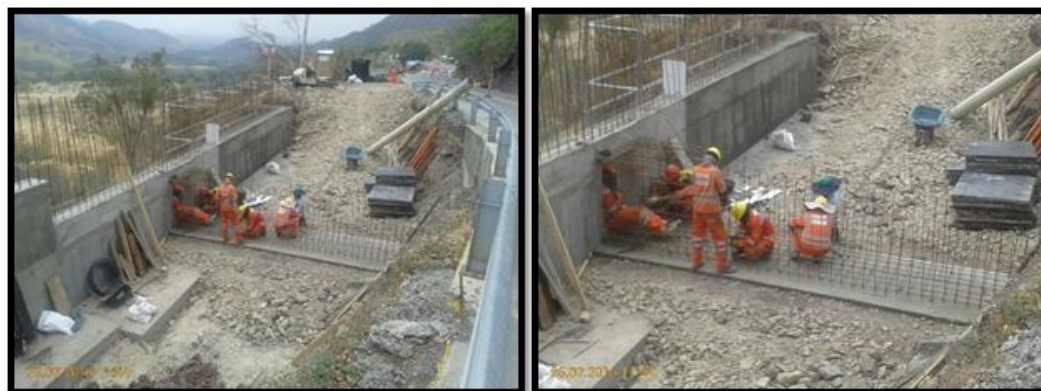
Fotografías 117 y 118. Extensión de muros mayores y prolongación de Box Culvert.
