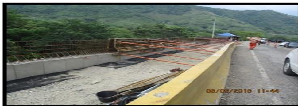
Fotografía 72. Construcción de New Jersey.
