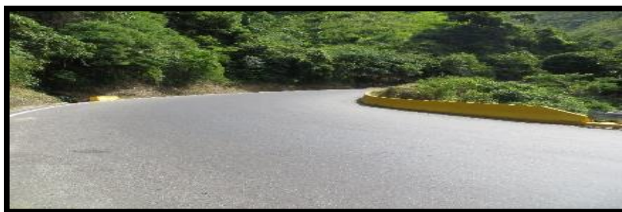
Fotografía 160. Sector del Hito 62 en donde se han hecho reparaciones.
