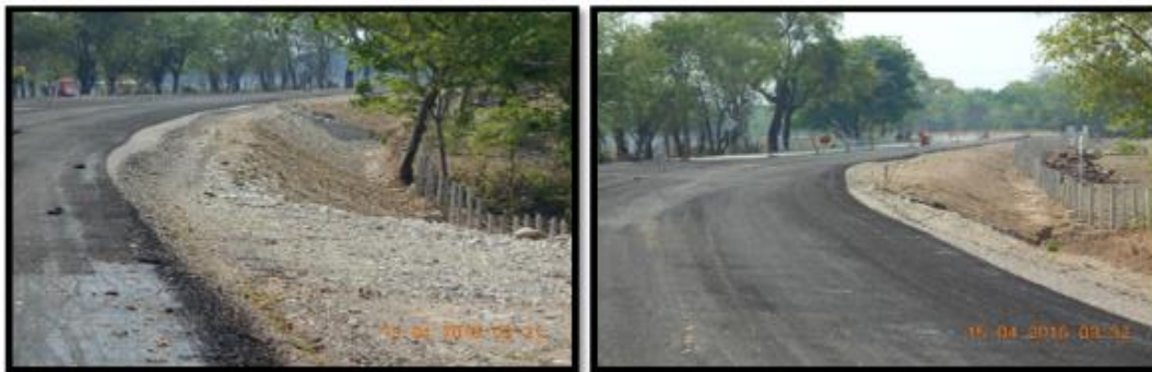
Fotografías 39 y 40. Verificación Sección Transversal.
