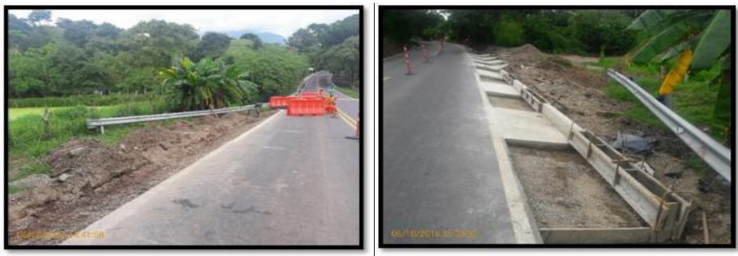
Fotografías 147 y 148. Construcción de cunetas.
