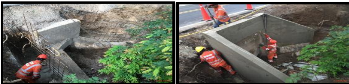
Fotografías 125 y 126. Alcantarilla PR 12+480.
