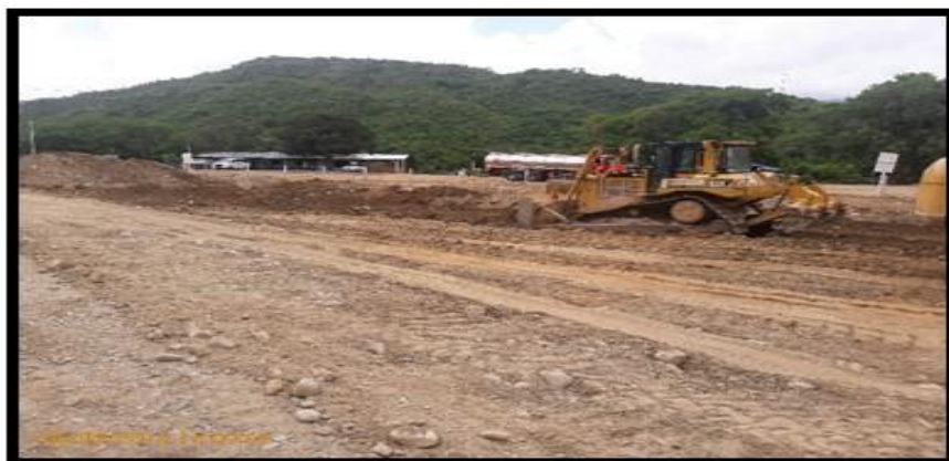
Fotografía 99. Adecuación de terreno en área peaje definitivo Platanal.
