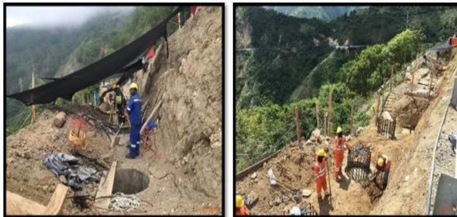
Fotografías 87 y 88. PR 33+260. Excavación de Caisson.
