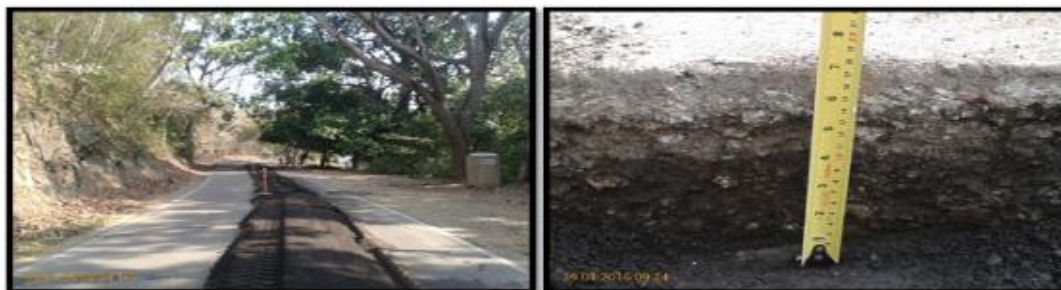
Fotografías 31 y 32. Verificación espesor de capas.
