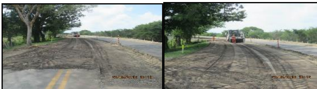
Fotografías 41 y 42. Reciclado de pavimento PR 4 + 440 al PR 6 + 560.
