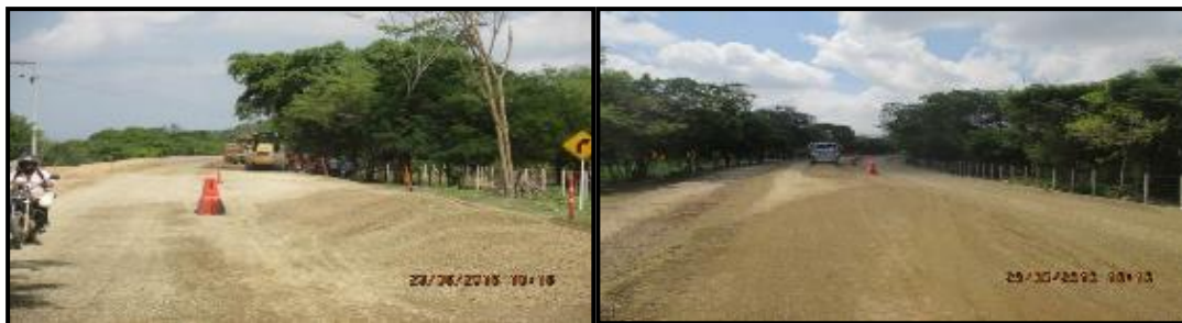
Fotografías 43 y 44. Instalación base granular PR 5 + 780 al PR 6 + 020.
