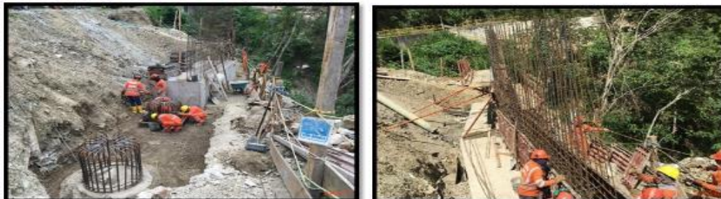
Fotografías 89 y 90. Excavación de caissons.
