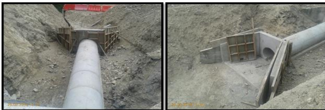
Fotografías 115 y 116. Prolongación alcantarilla.
