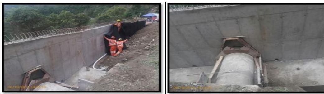
Fotografías 149 y 150. Segundo tramo de tercer carril. Vaciado atraque de Alcantarilla e instalacion de filtro.
