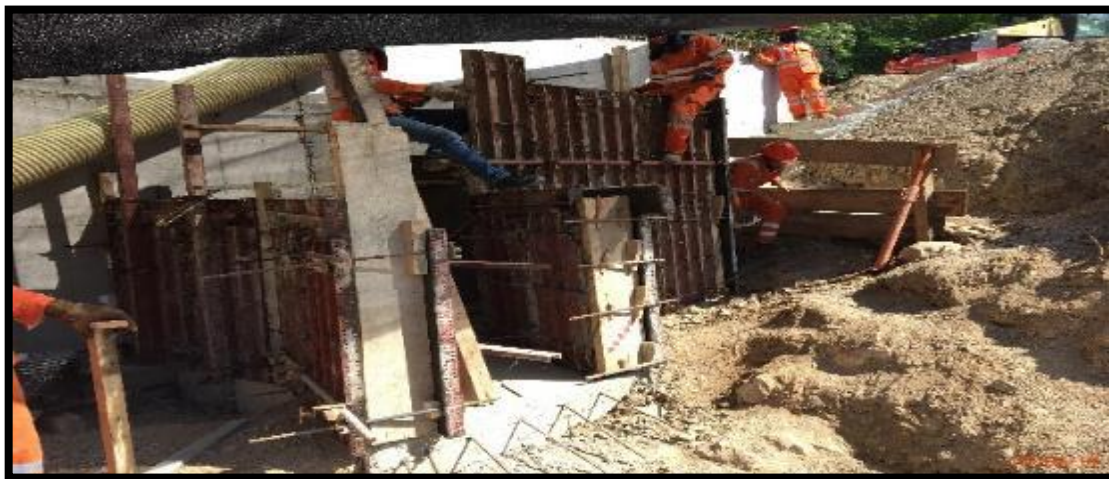
Fotografía 139. Construcción de Alcantarilla (Disipador)
