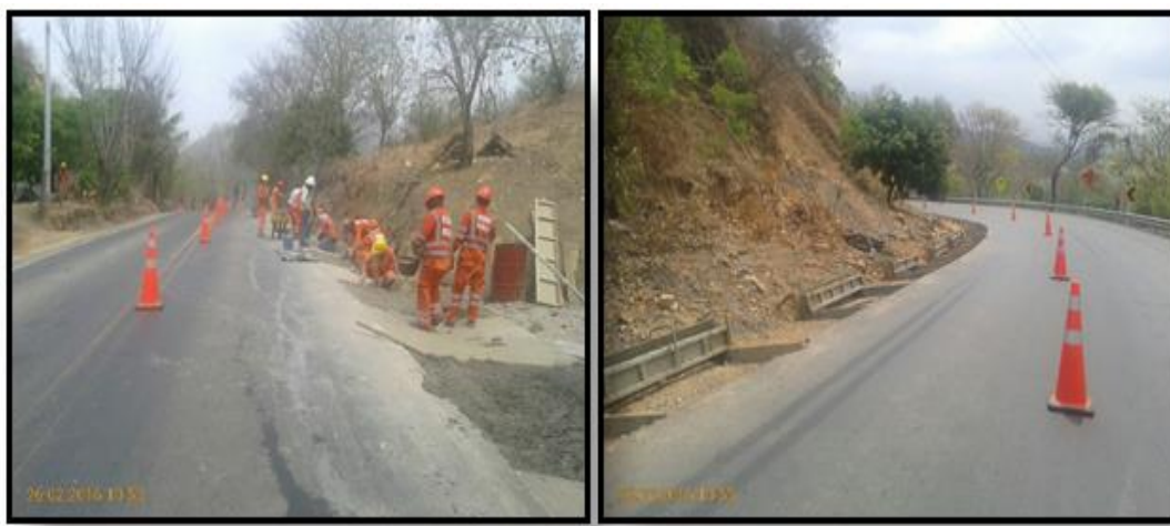
Fotografías 113 y 114. Proceso de fundición de cunetas.
