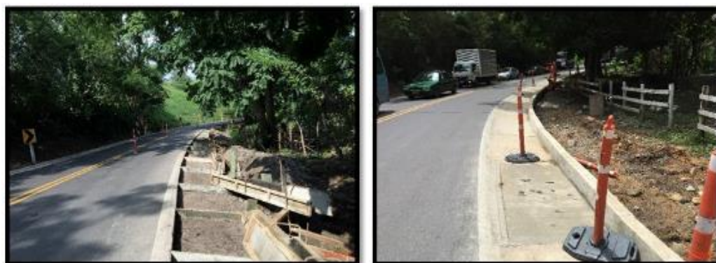
Fotografías 133 y 134. Construcción de cunetas PR 16 + 120 al PR 16 + 690.
