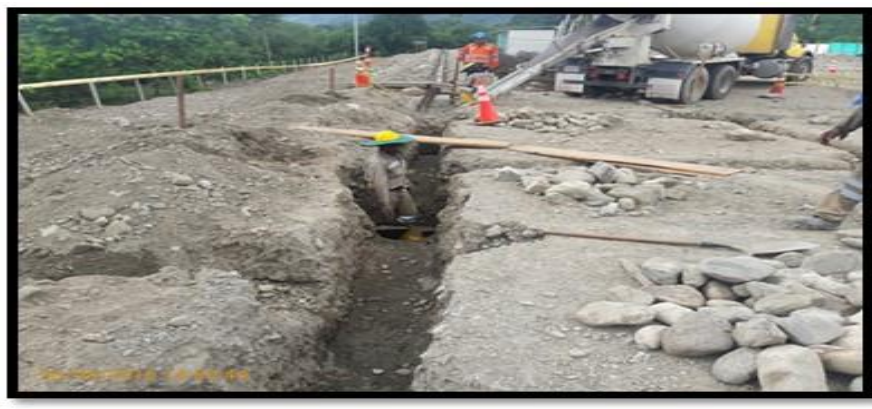
Fotografía 100. Construcción de cerramiento definitivo áreas administrativas, vaciado solado para zapatas.
