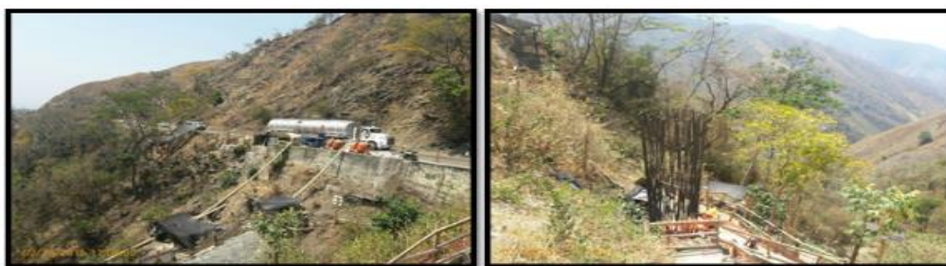
Fotografías 27 y 28. Avances caissons puente 3.
