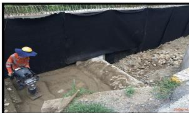
Fotografía 73. Relleno y compactación de material para alcantarilla PR 20 + 420.
