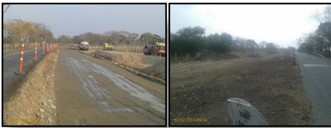
Fotografías 3 y 4. Instalación de lleno y compactación de material para corona.
