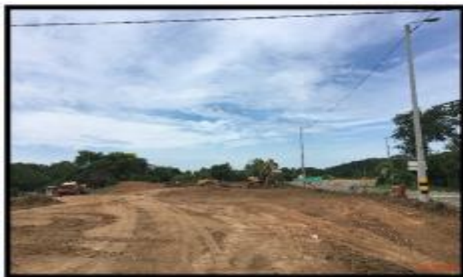
Fotografía 66. Descapote e instalación de material.
