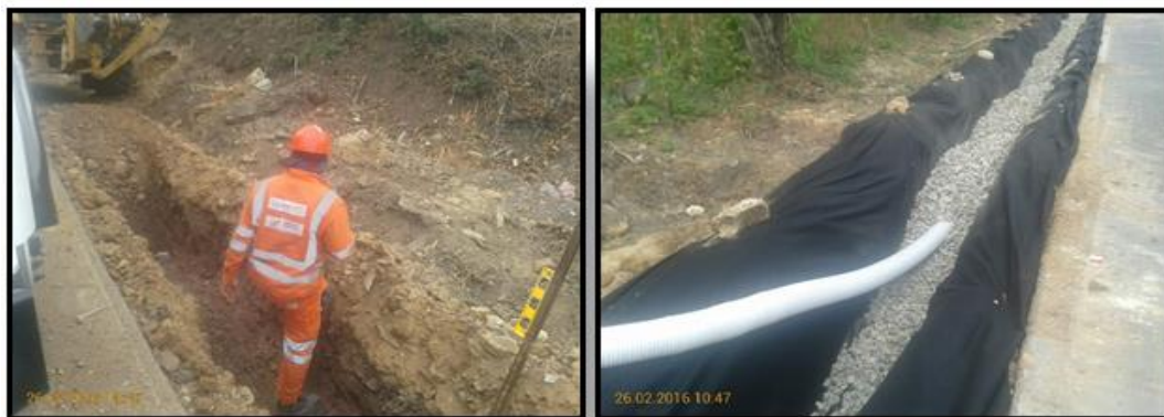
Fotografía 111 y 112. Colocación de filtros.
