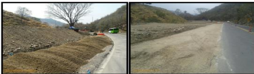
Fotografías 19 y 20. Instalación de Subbase.
