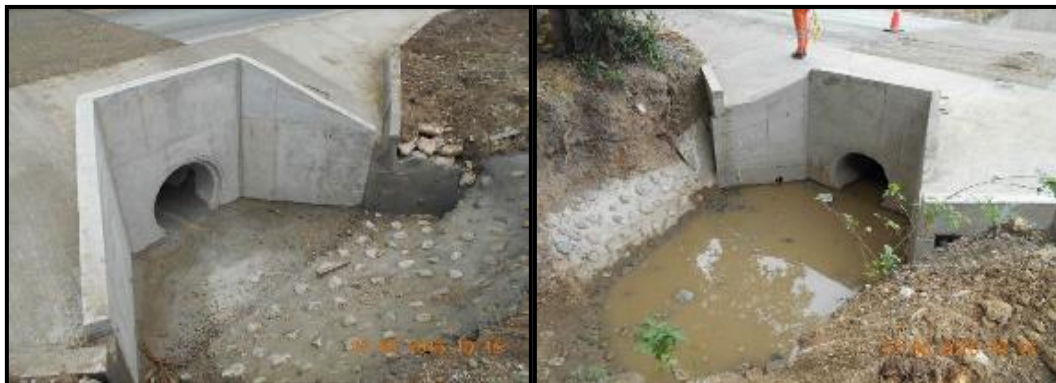
Fotografías 129 y 130. Construcción alcantarilla ubicada en el PR 3+925.
