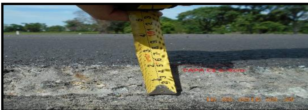
Fotografía 97. Instalación Pavimento PR 5 + 260 al PR 6 + 560 con una longitud igual a 1300m y un espesor de e=9\text{cm} .
