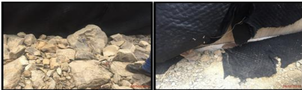
Fotografías 21 y 22. Relleno de muro.
