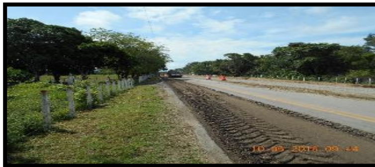
Fotografía 93. Reciclado Pavimento.
