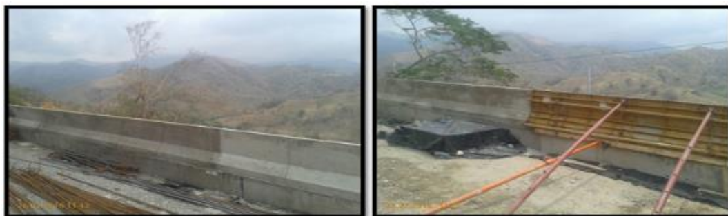
Fotografías 25 y 26. Construcción de New Jersey.
