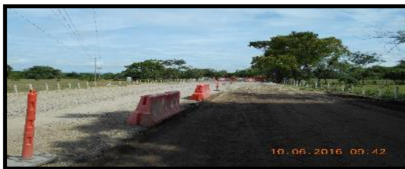
Fotografía 94. Instalación Sub-Base Granular.
