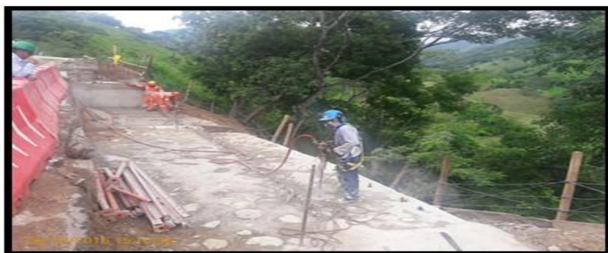
Fotografía 101. Construcción de muro.
