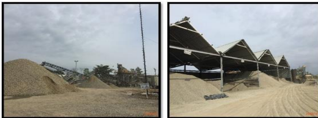
Fotografías 187 y 188. Planta de triturado y acopio de agregado.
