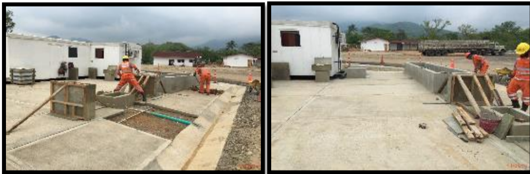
Fotografías 62 y 63. Adecuación campamento.
