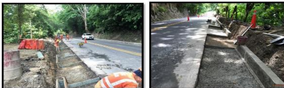
Fotografías 135 y 136. Construcción de cunetas PR 19 + 100 al PR 19 + 280.
