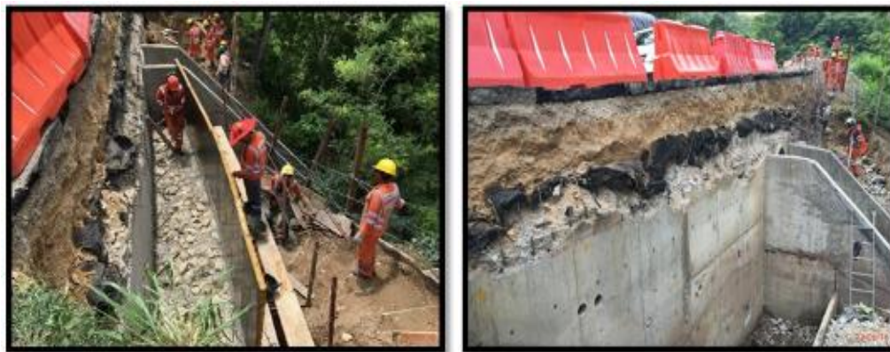
Fotografías 74 y 75. Demolición de muro existente PR 20 + 480.
