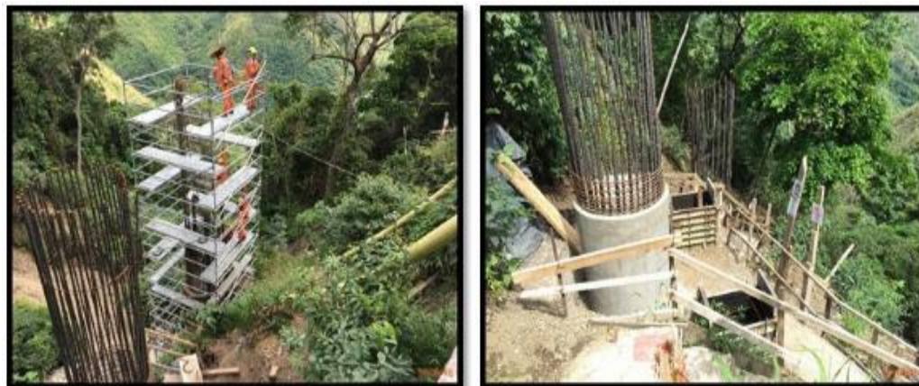
Fotografías 80 y 81. Armado de acero para pilas.
