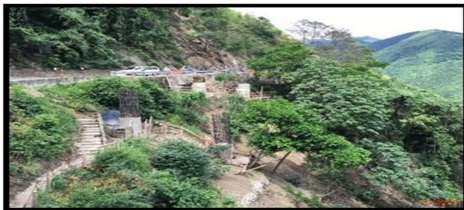
Fotografía 82. Armado de aceros para pilas.
