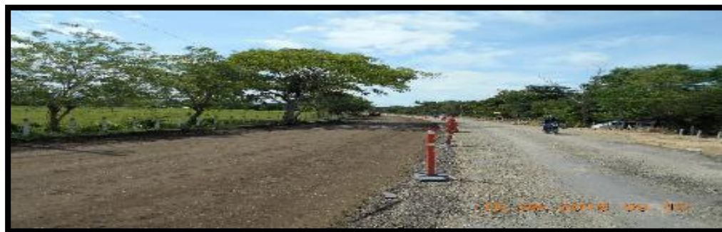
Fotografía 95. Instalación Sub-Base Granular PR 6 + 020 al PR 6 + 560 y del PR 7 + 000 al PR 7 + 440. Margen izquierdo.
