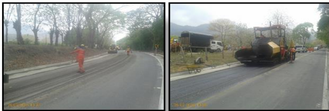
Fotografías 7 y 8. Reparcheo asfalto existente.
