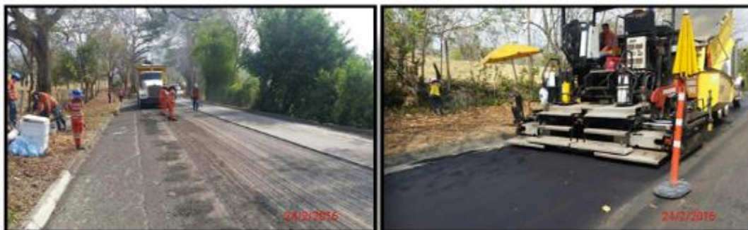
Fotografías 5 y 6. Reparcheo asfalto existente.
