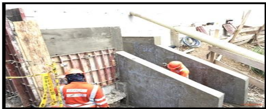
Fotografía 142. Desenfofrada estructura de alcantarilla.
