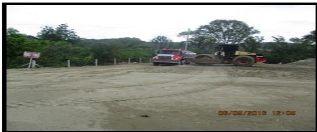
Fotografía 65. Adecuación de terreno en área peaje definitivo Platanal.
