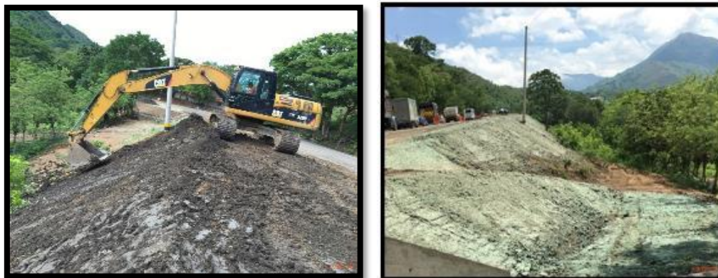
Fotografías 198 y 199. Protección de talud.
