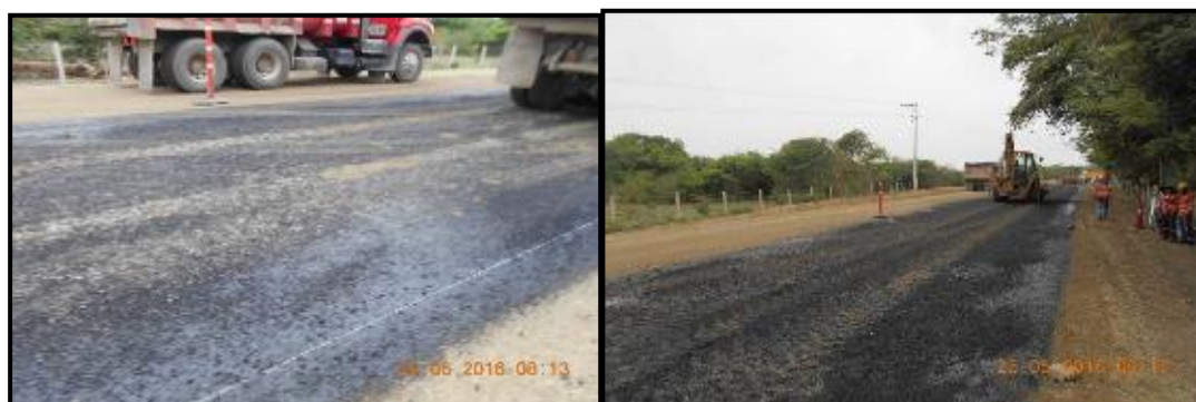
Fotografías 47 y 48. Imprimación base granular.
