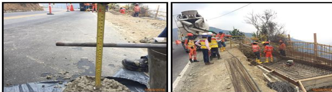
Fotografías 176 y 177. Vaciado de concreto para zapatas y muros en el K33 + 240.
