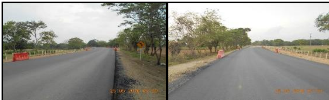
Fotografías 49 y 50. Instalación de pavimento del PR 6 + 020 al PR 6 + 560.
