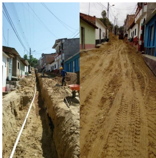
Figura 39. Durante la ejecución se sector Santa Lucia.
