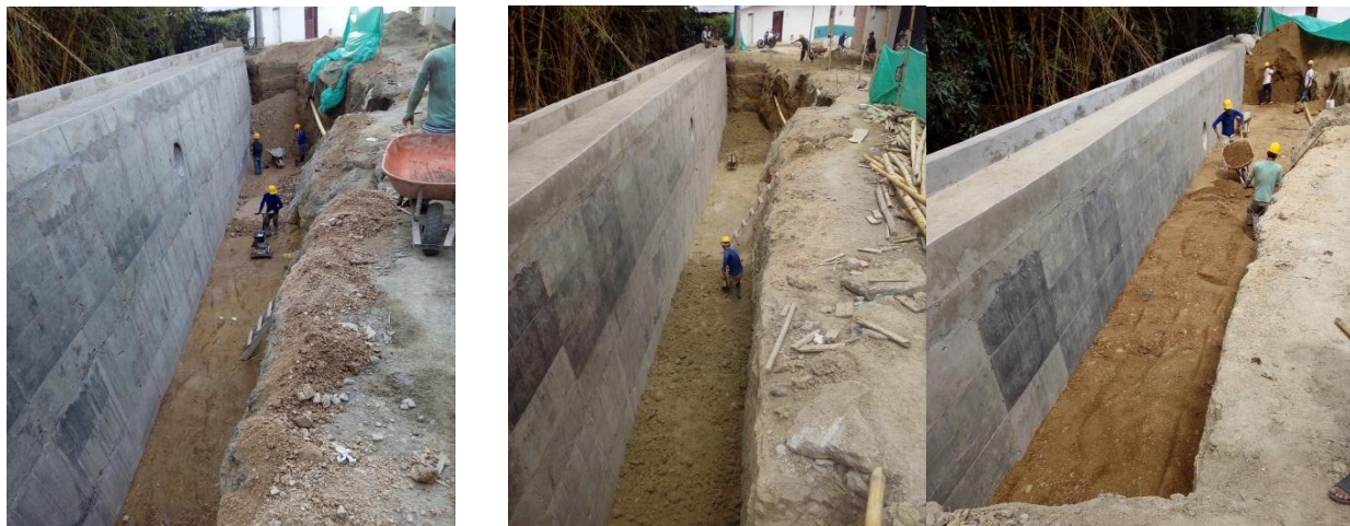
Figura 11. Relleno de la estructura con material seleccionado.
