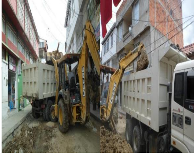
Figura 22. Retiro de sobrante con acarreo. Fuente. Autor del proyecto
