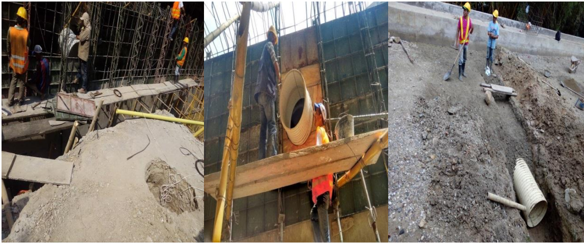
Figura 7. Instalación Tubería 24”.
