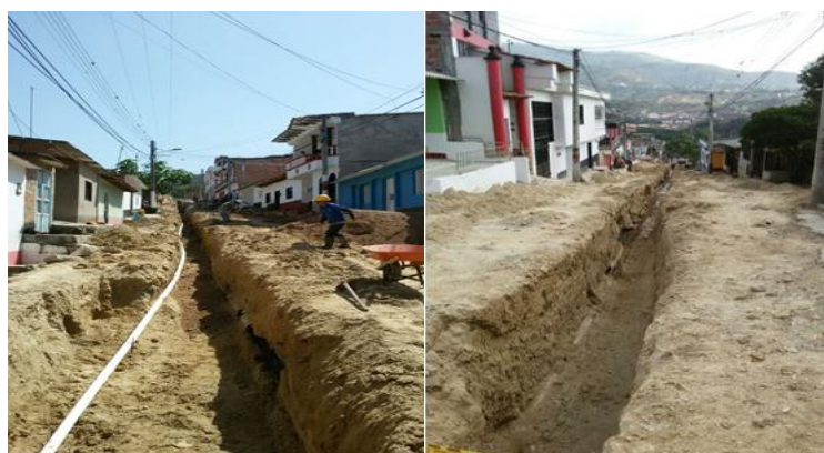
Figura 34. Excavación material común para instalación de tubería
