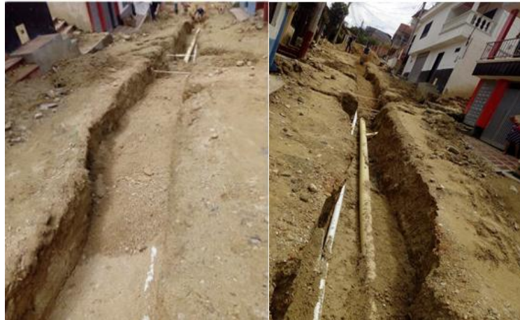
Figura 36. Instalación del relleno conformado.
