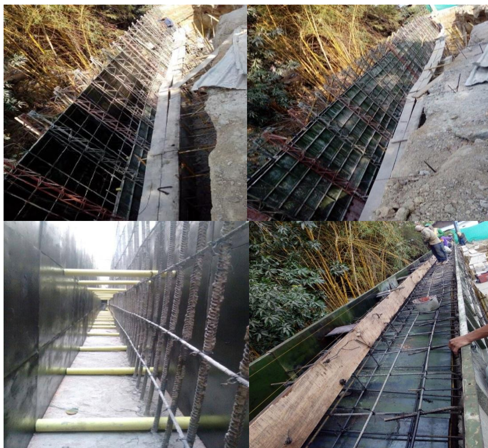
Figura 6. Apuntalamiento del Muro (formaletas).
