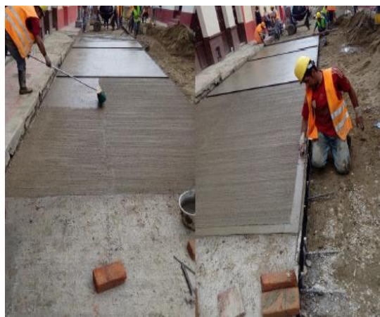
Figura 28. Acabados de las losas. Fuente. Autor del proyecto.
