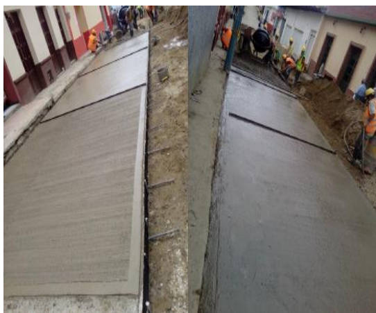
Figura 27. Fundida de losas. Fuente. Autor del proyecto
