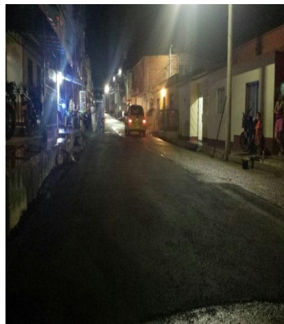
Figura 46. Después. Fuente. Autor del proyecto.
