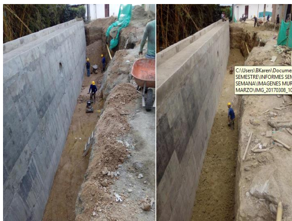
Figura 17. Durante la ejecución del muro.
