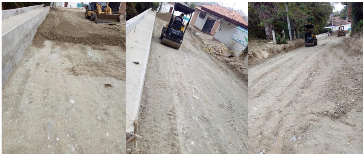
Figura 12. Aplicación, extendido y compactación de la base granular.
