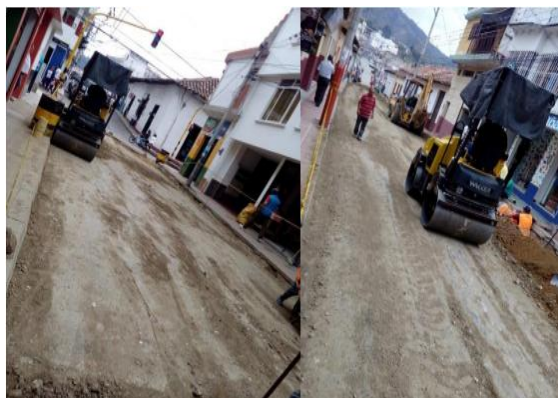
Figura 24. Compactación Base Granular
