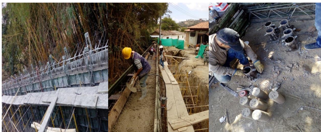
Figura 9. Vaciado Concreto clase d de 3000 PSI.
