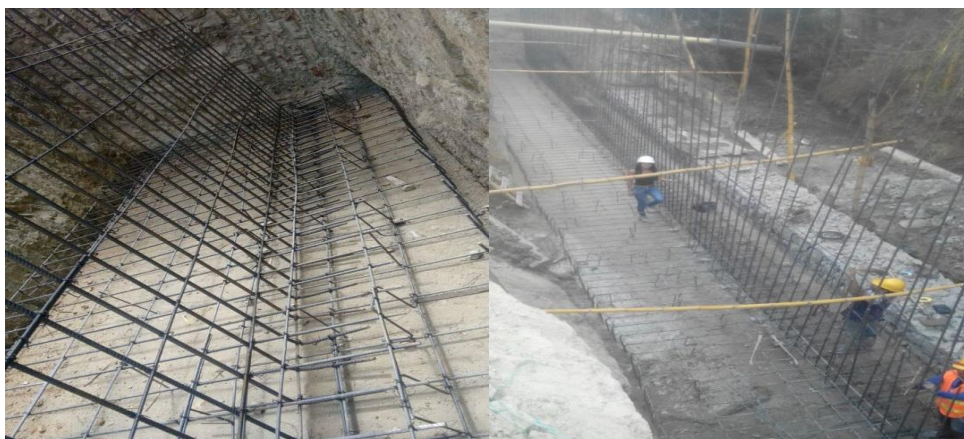
Figura 8. Instalación y figurado del acero de refuerzo de 60000 PSI”.
