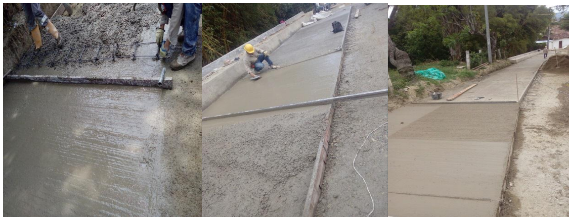
Figura 13. Fundida de losas en concreto.
