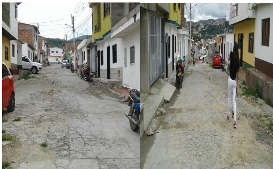
Figura 52. Visita Sector la Libertad inspección de Calle.
