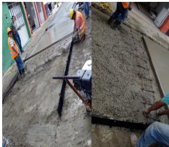
Figura 26. Colocación Parrilla de acero. Fuente. Autor del proyecto.
