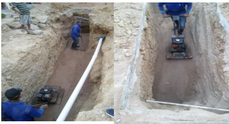
Figura 35. Instalación cama de arena para apoyo de Tubería.
