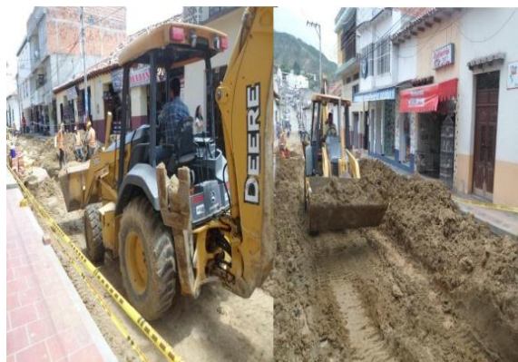
Figura 21.. Excavación Mecánica Fuente: Autor del proyecto
