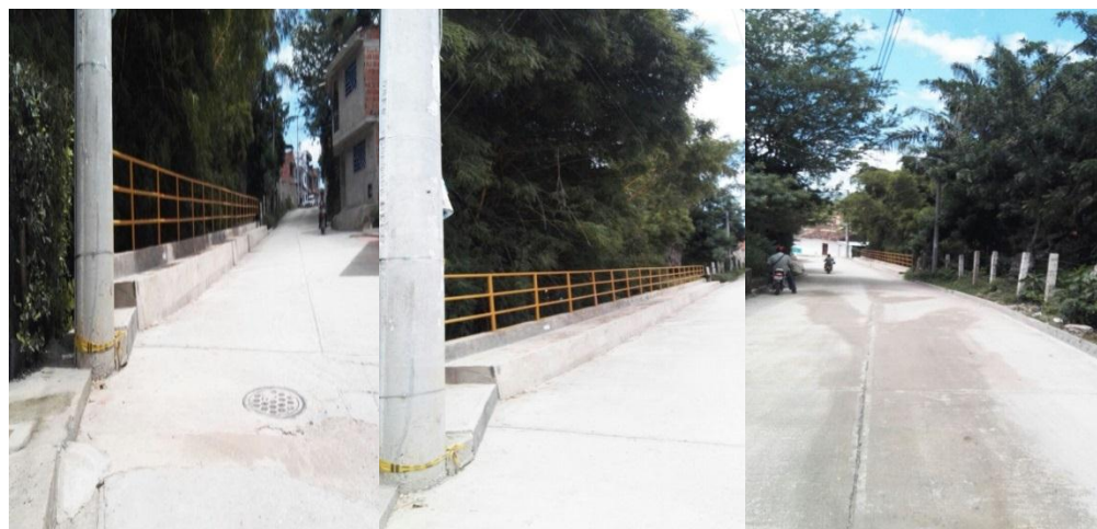
Figura 18. Después de ser intervenido el Muro.
