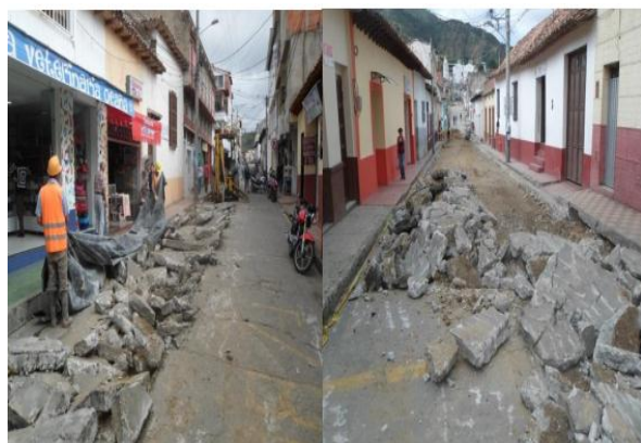
Figura 20. Demolición del pavimento.. Fuente: Autor del proyecto
