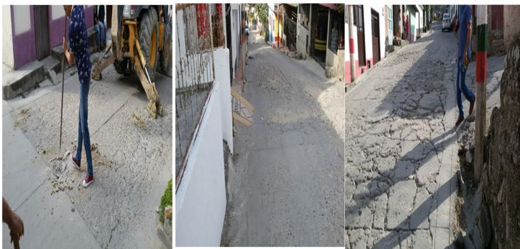
Figura 31. Localización y replanteo de la vía a intervenir sector Santa Lucia.
