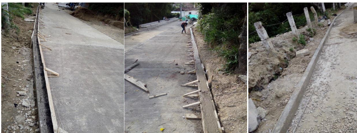
Figura 14. Bordillo en concreto h = 40.00 cms.
