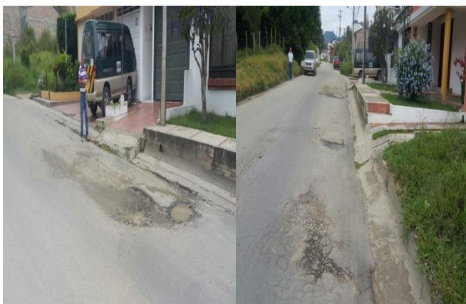
Figura 47. Antes de la ejecución Sector Lago. Fuente. Autor del proyecto
