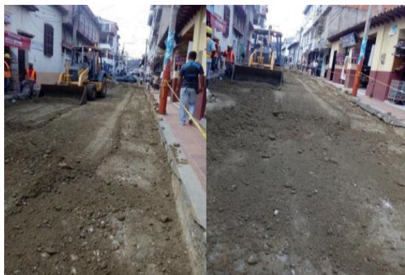
Figura 23. Extendido de la Base granular.
