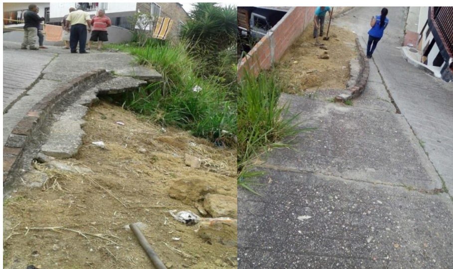
Figura 53.. Visita Sector la Libertad inspección para muro en mampostería.
