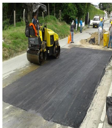
Figura 48. Después. Fuente. Autor del proyecto.
