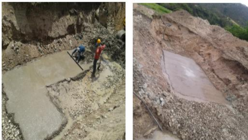
Figura 36. Piso de mejoramiento en concreto
