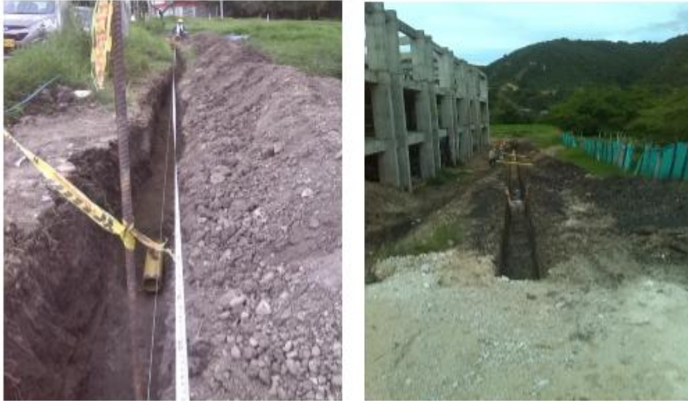
Figura 54. Instalación tubería 6”
