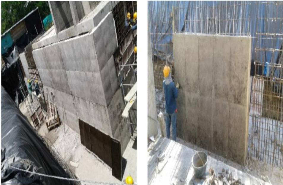
Figura 20. Concreto elevación de muro
