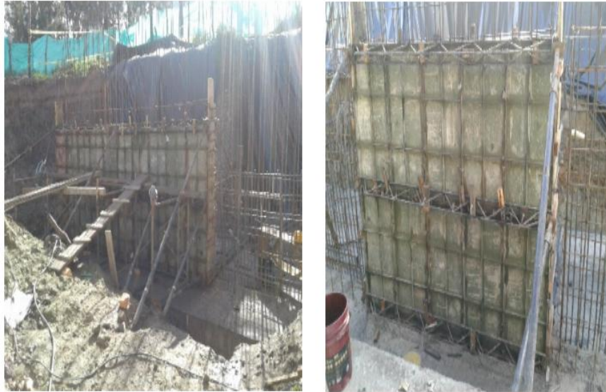
Figura 17. Encofrado sección 1
