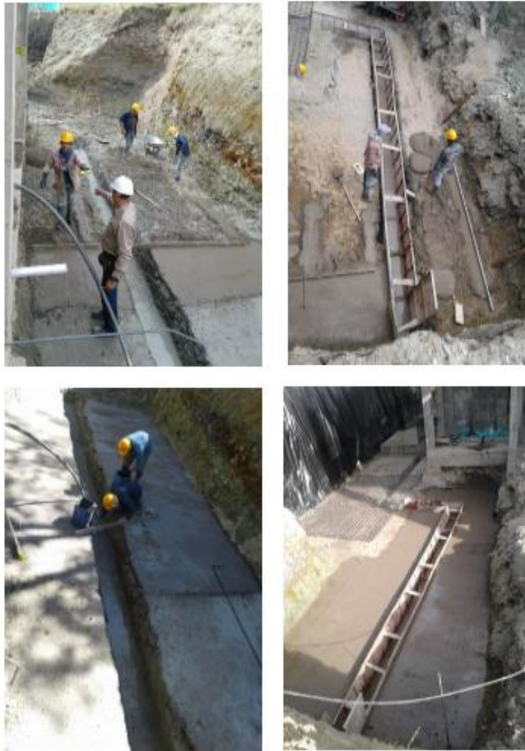
Figura 12. Concreto de limpieza
