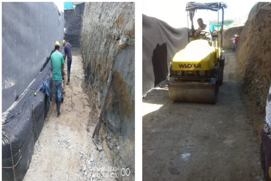
Figura 10. Compactación del relleno
