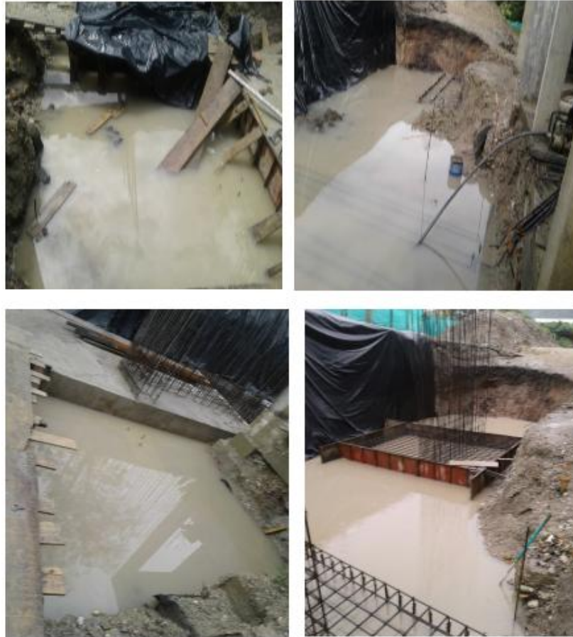
Figura 61. Encofrado de trampa
