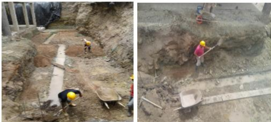
Figura 51. Traslado interno de excavación manual
