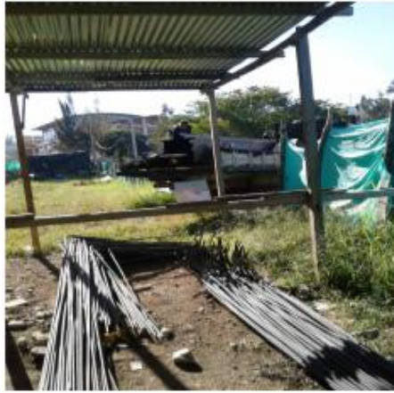
Figura 67. Almacenamiento de acero de refuerzo
