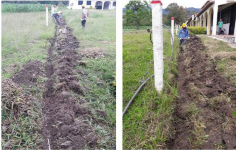
Figura 57. Excavación manual
