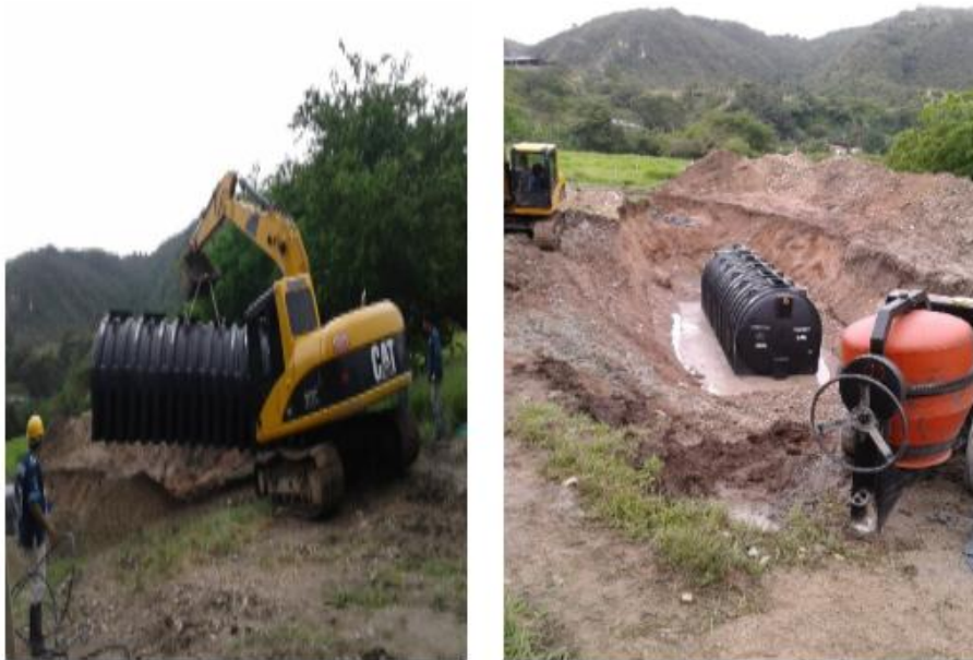
Figura 37. Instalación del Tanque
