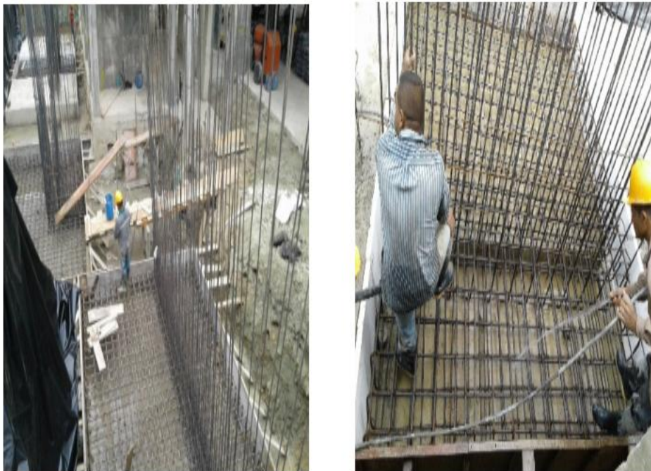
Figura 14. Limpieza del acero
