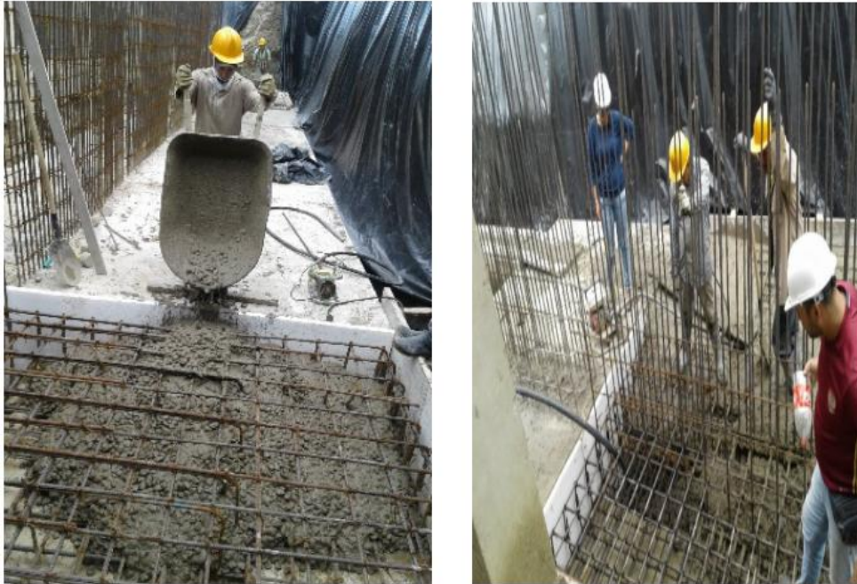
Figura 15. Vaciado de concreto
