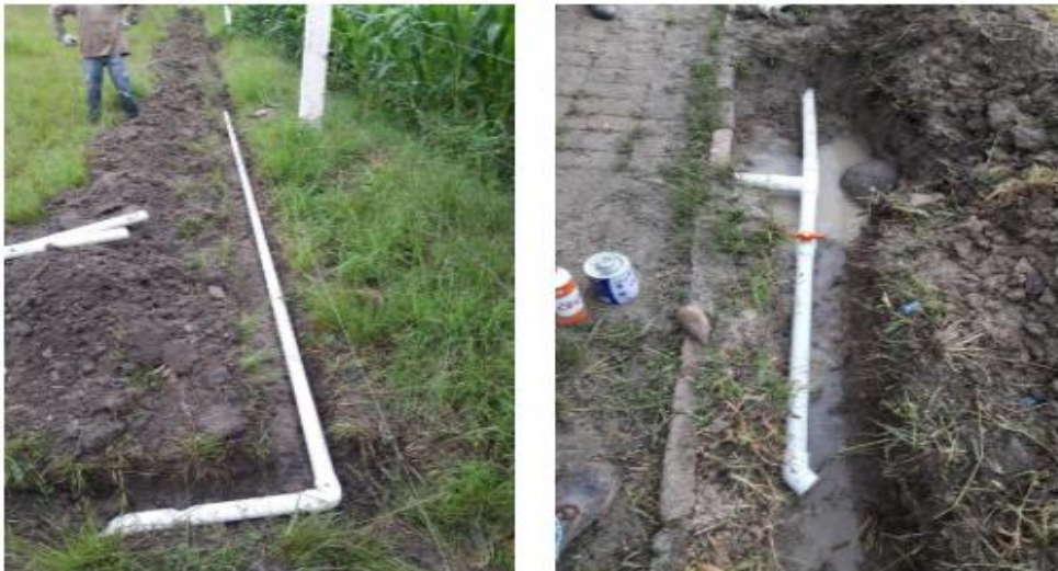
Figura 58. Instalación tubería 2”
