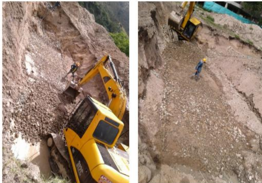
Figura 45. Mejoramiento en pedraplén
