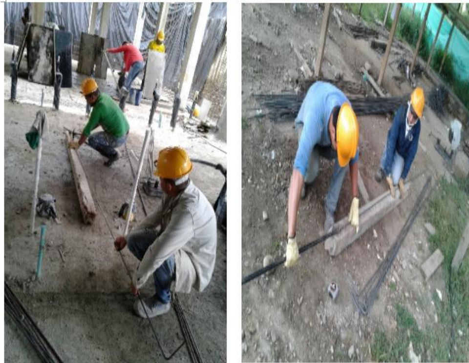
Figura 21. Figurado del acero
