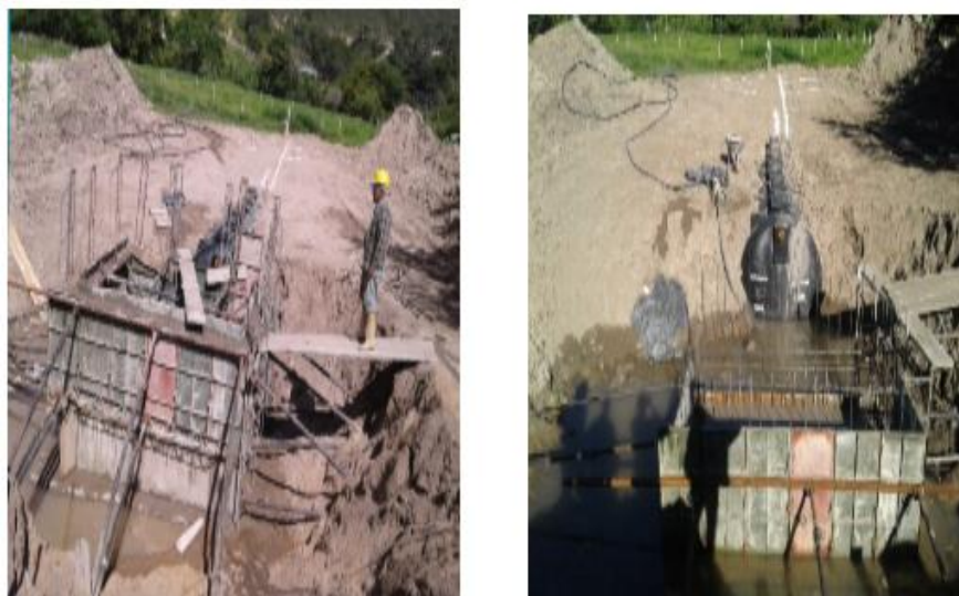
Figura 47. Encofrado de trampa
