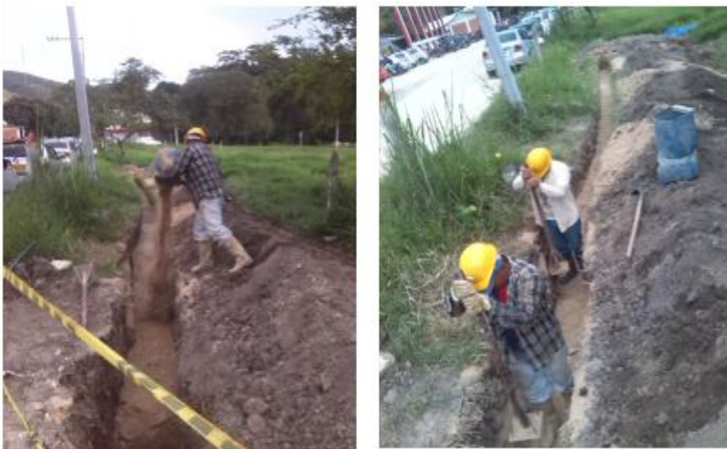
Figura 55. Relleno con material seleccionado
