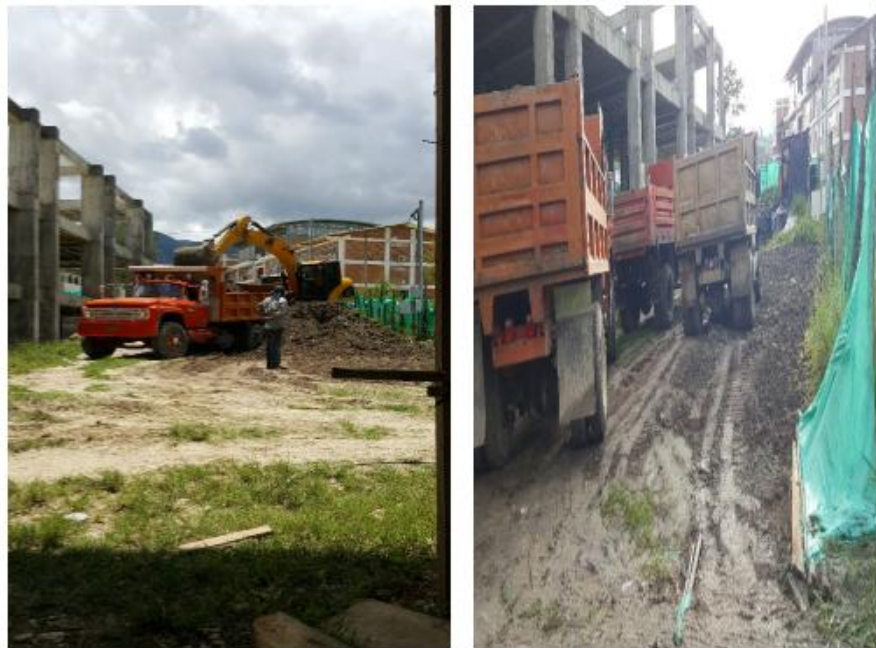
Figura 43. Retiro de Material sobrante
