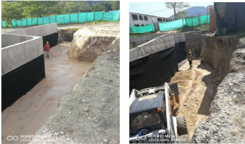
Figura 9. Relleno con material seleccionado
