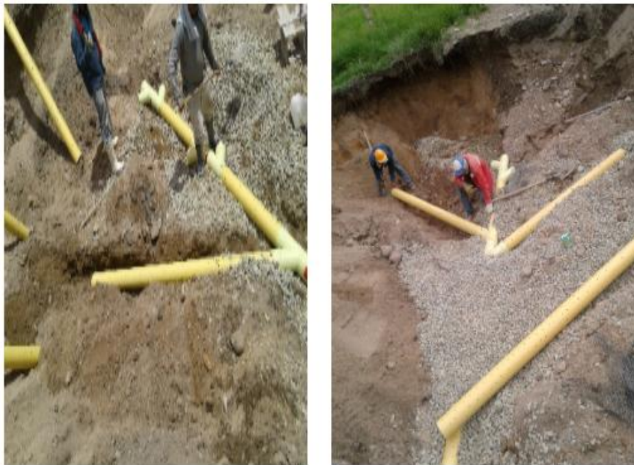
Figura 39. Instalación Tubería 6"
