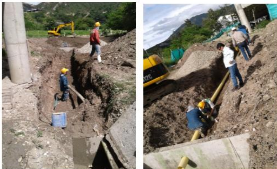
Figura 30. Instalación tubería 6"
