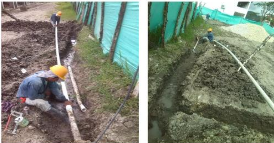
Figura 28. Instalación tubería 2 ½
