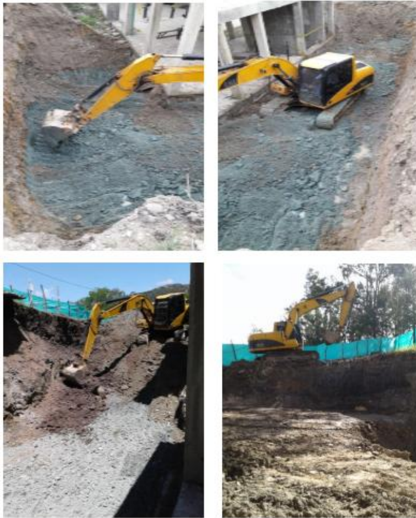
Figura 7. Excavación Mecánica
