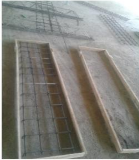
Figura 48. Tapas en Concreto
