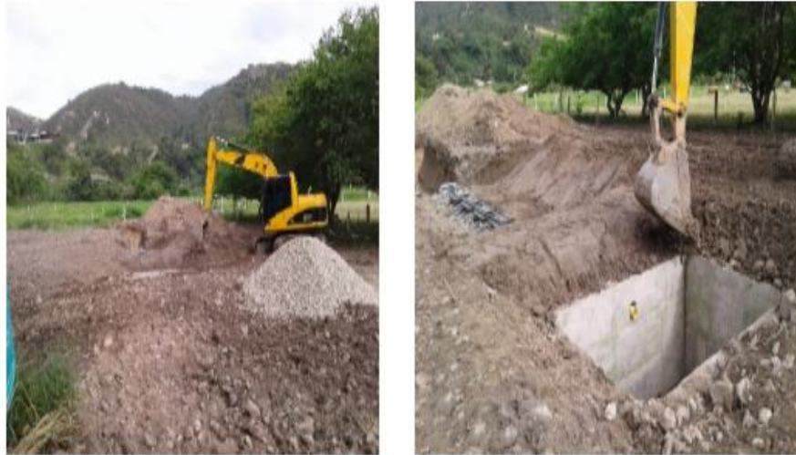
Figura 33. Relleno para tubería 4"
