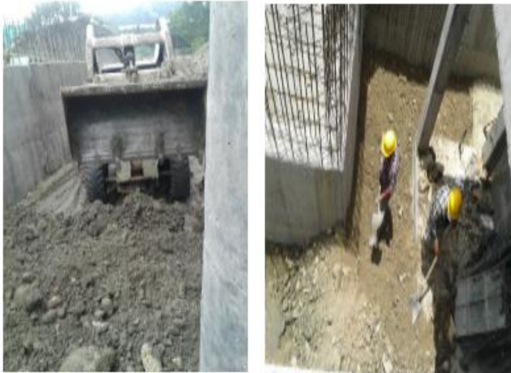
Figura 8. Relleno frente de muro
