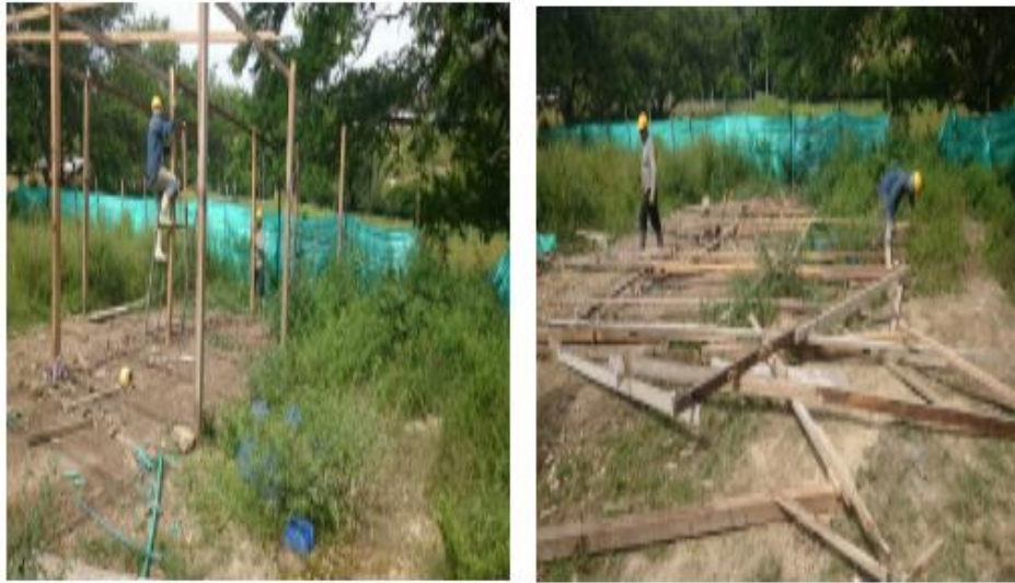
Figura 50. Desmonte de campamento
