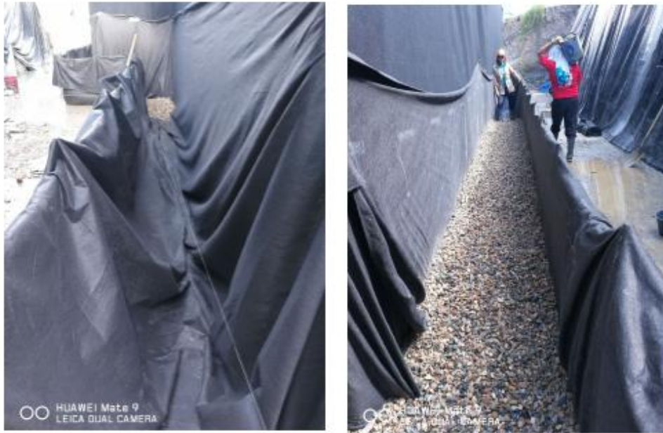
Figura 26. Instalación gravilla triturado 3/4"
