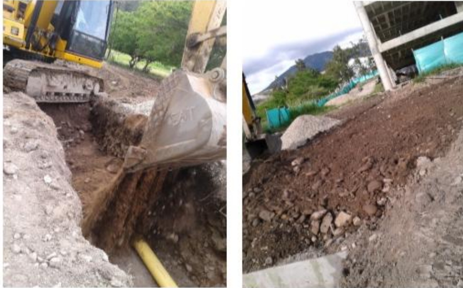
Figura 31. Relleno para tubería de 6"
