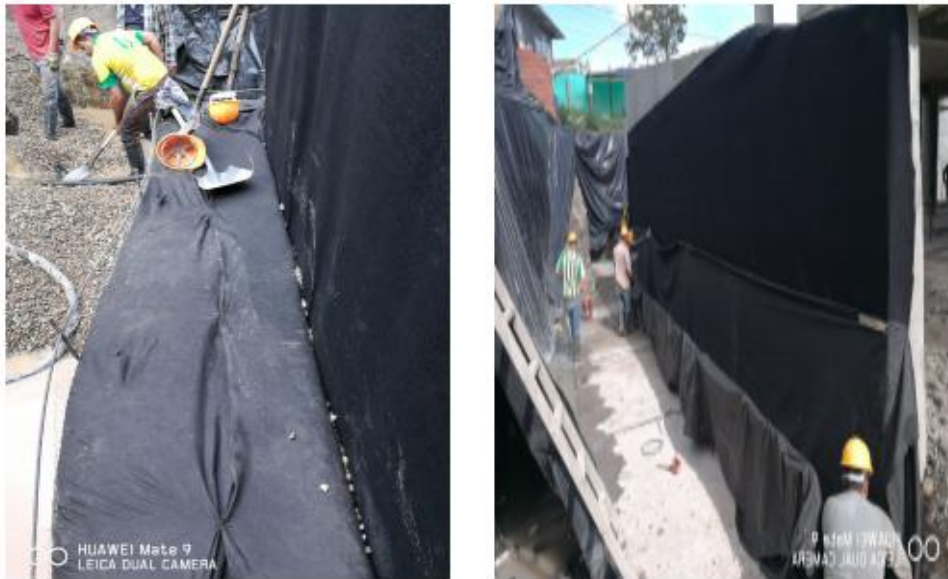
Figura 24. Instalación geotextil para filtro de muro
