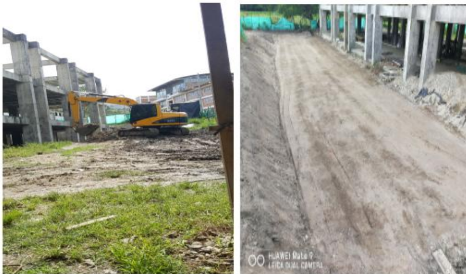
Figura 41. Compactación del terreno
