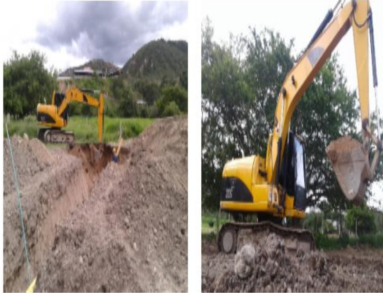
Figura 40. Relleno con Material Existente
