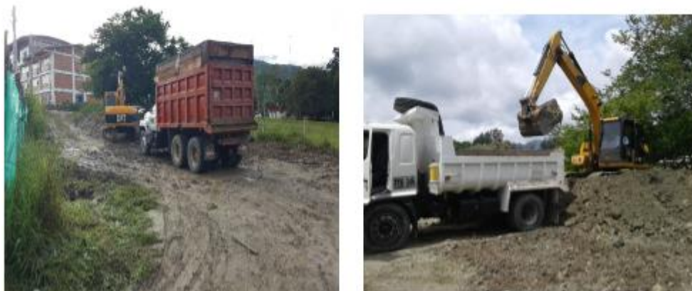
Figura 52. Traslado interno de excavación Mecánica
