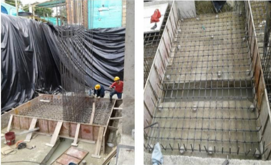
Figura 13. Encofrado de zapatas
