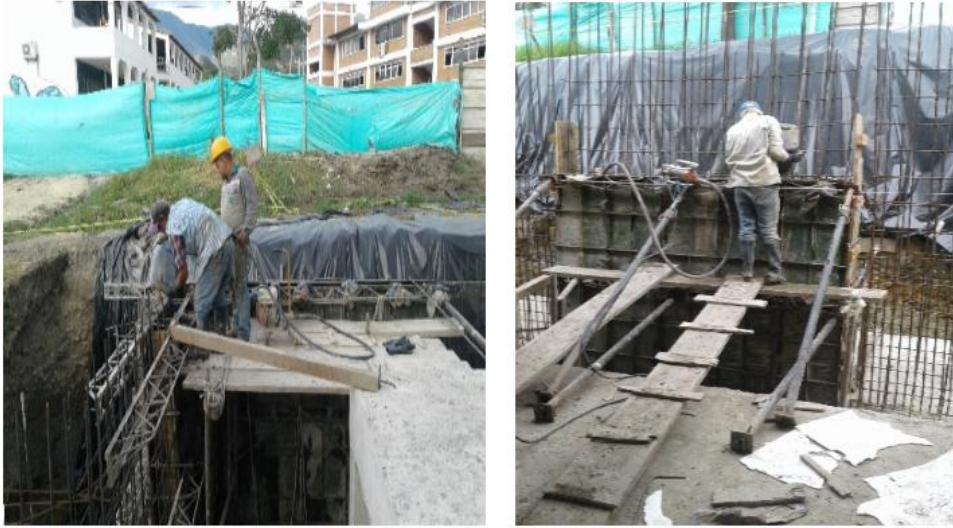
Figura 19. Vaciado de concreto
