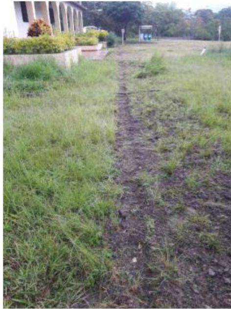
Figura 59. Relleno manual
