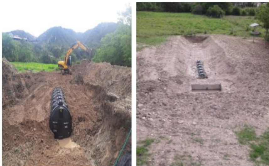
Figura 38. Relleno con material existente
