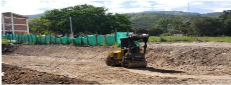
Figura 42. Compactación del terreno
