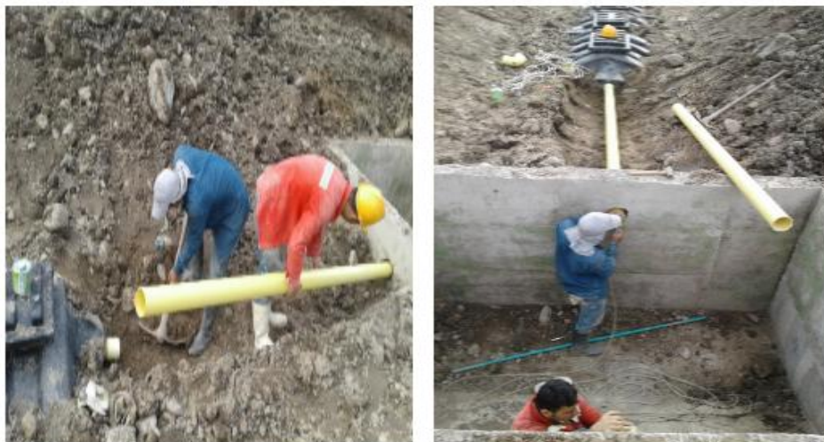
Figura 32. Instalación tubería 4"
