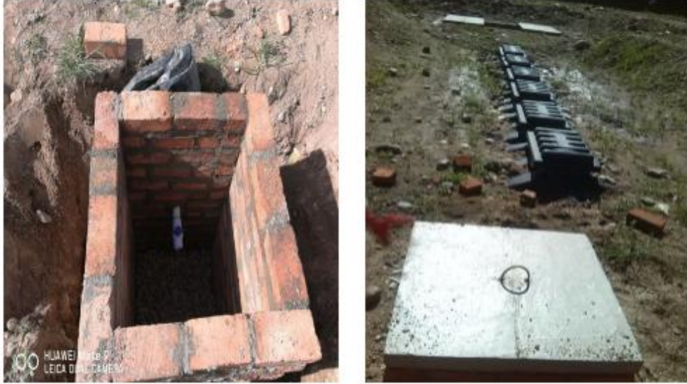
Figura 56. Cajas de muestro
