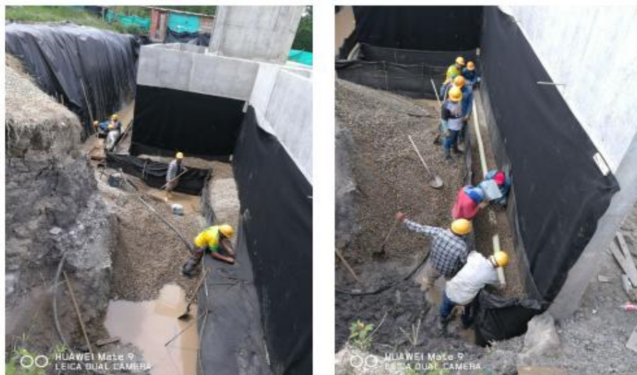
Figura 25. Instalación gravilla triturado 1/2"
