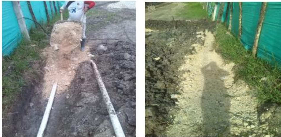
Figura 29. Relleno con material seleccionado
