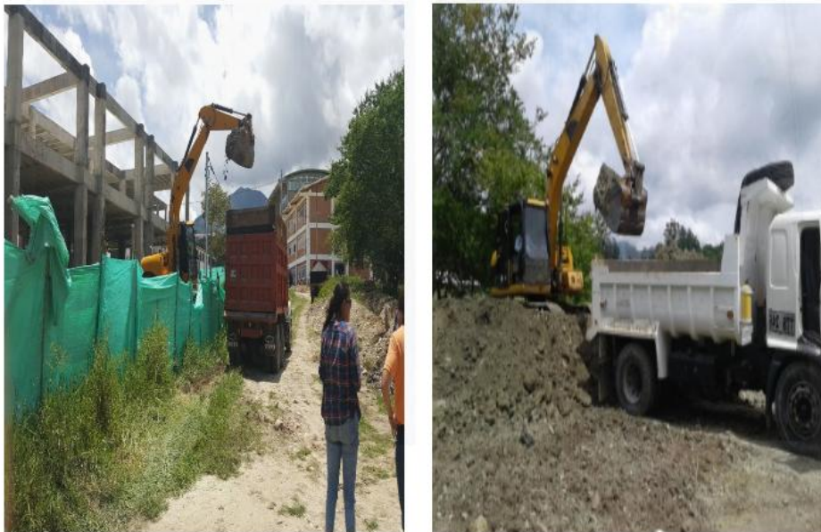
Figura 11. Retiro de material acopiado
