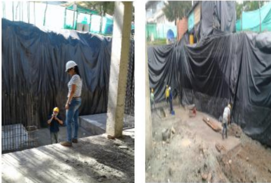
Figura 64. Instalación plástico negro
