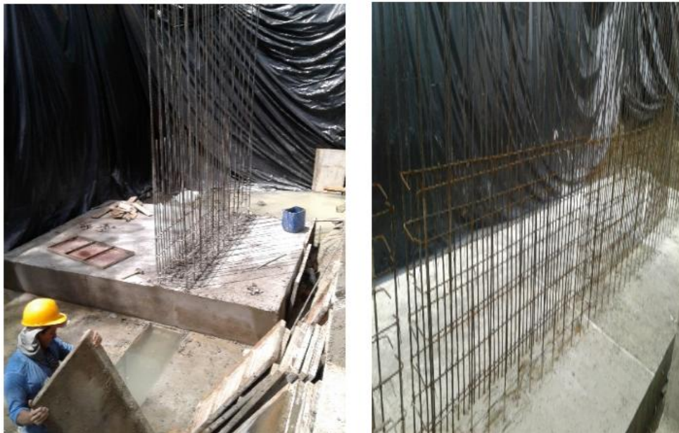
Figura 16. Concreto base de muro
