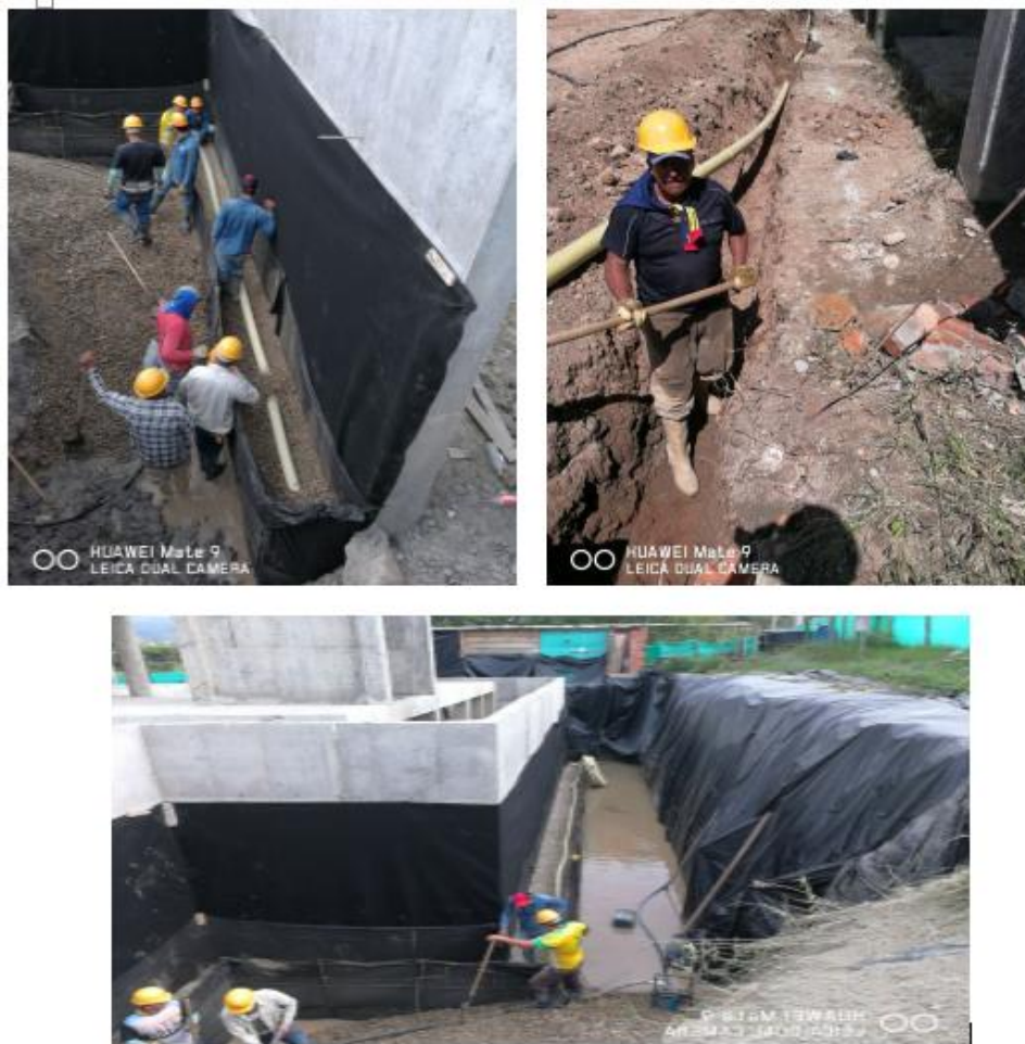
Figura 23. Instalación tubería 4" para filtro
