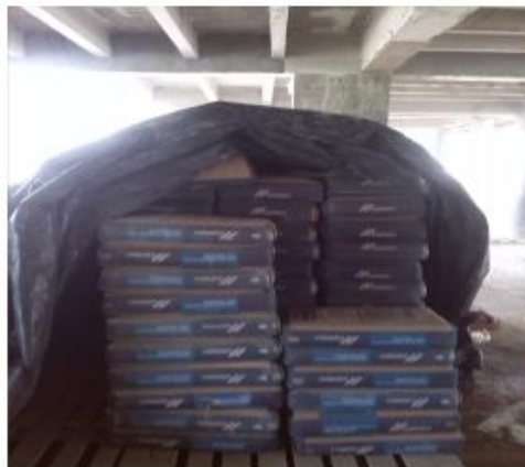
Figura 68. Almacenamiento de cemento
