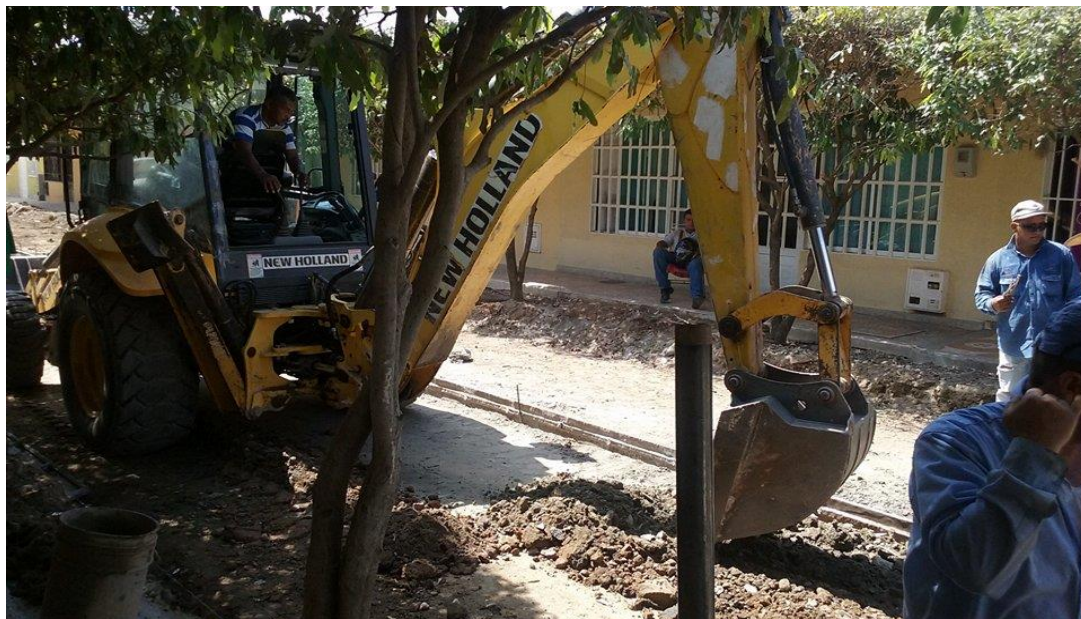
Fotografía 9 Excavación Kr 9 entre calle 22-23.
