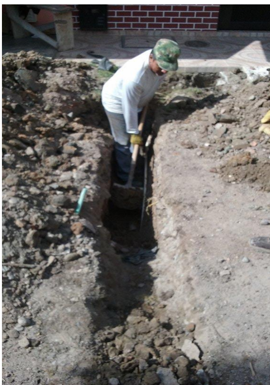
Fotografía 2 Excavación manual de zanja para Cambio de tubería.
