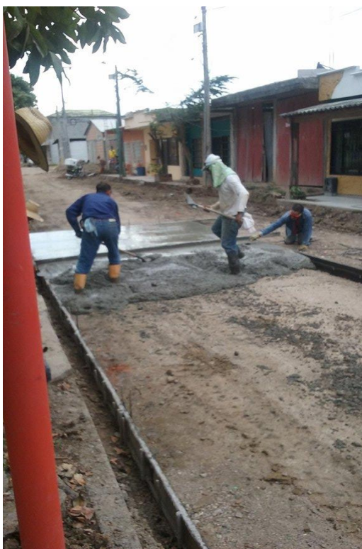
Fotografía 19 y 20 Distribución de la mezcla de concreto método manual, para la formación de la losa.
