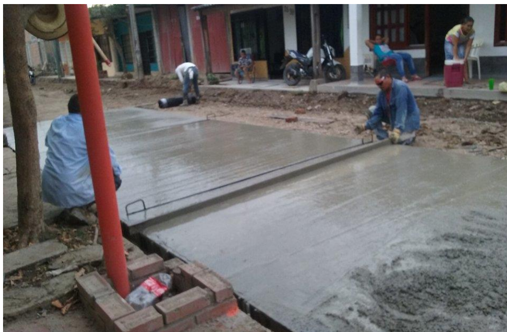
Fotografía 21 Enrazado de la losa en concreto.
