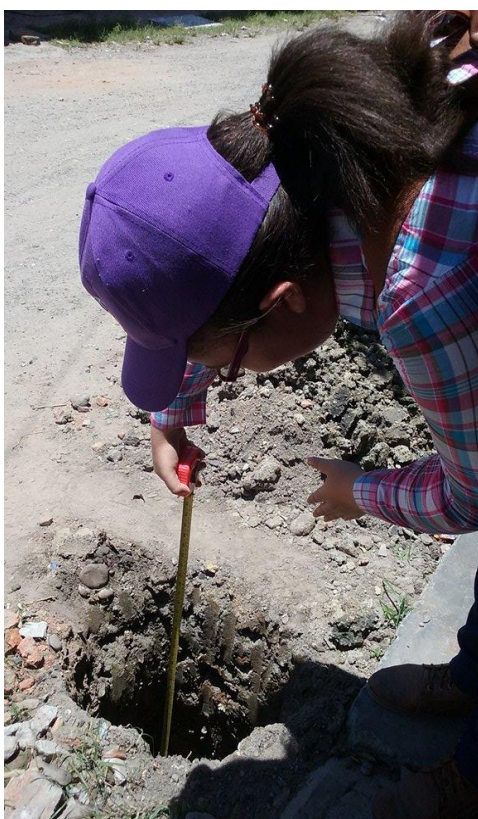
Fotografía 1 Revisión de profundidad.
