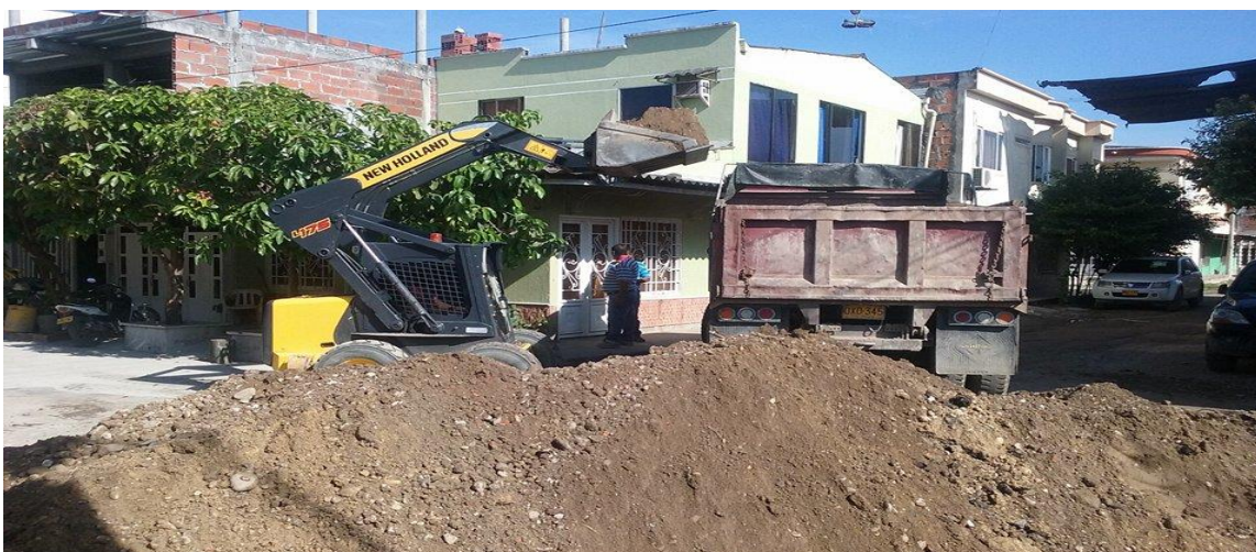
Fotografía 10 Retiro de material Kr 14 entre calle 26-29
