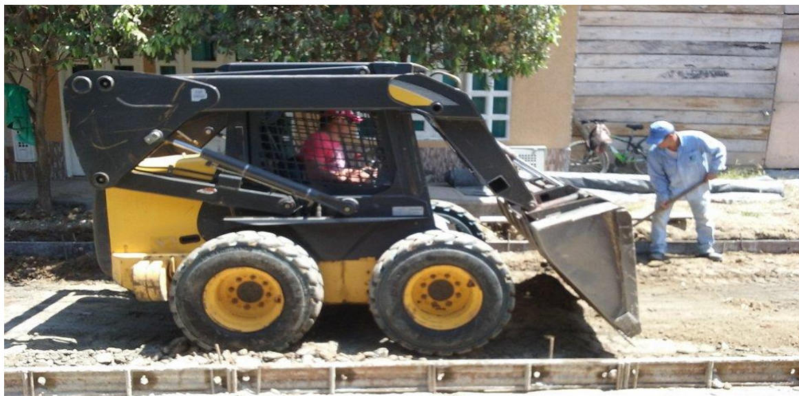
Fotografía 12 Perfilado con Mini cargador Kr 12 entre calle 26-28
