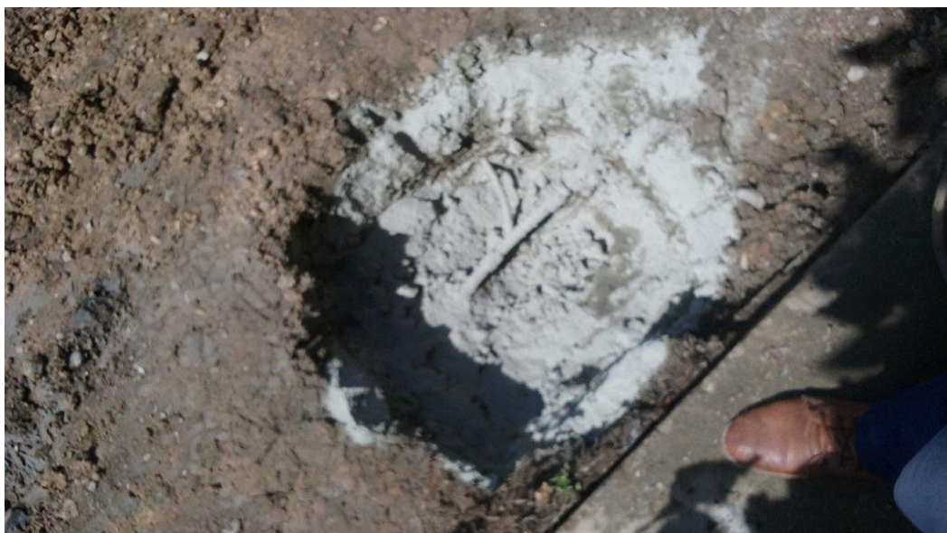
Fotografía 3 Aplicación de cemento como estabilizante.
