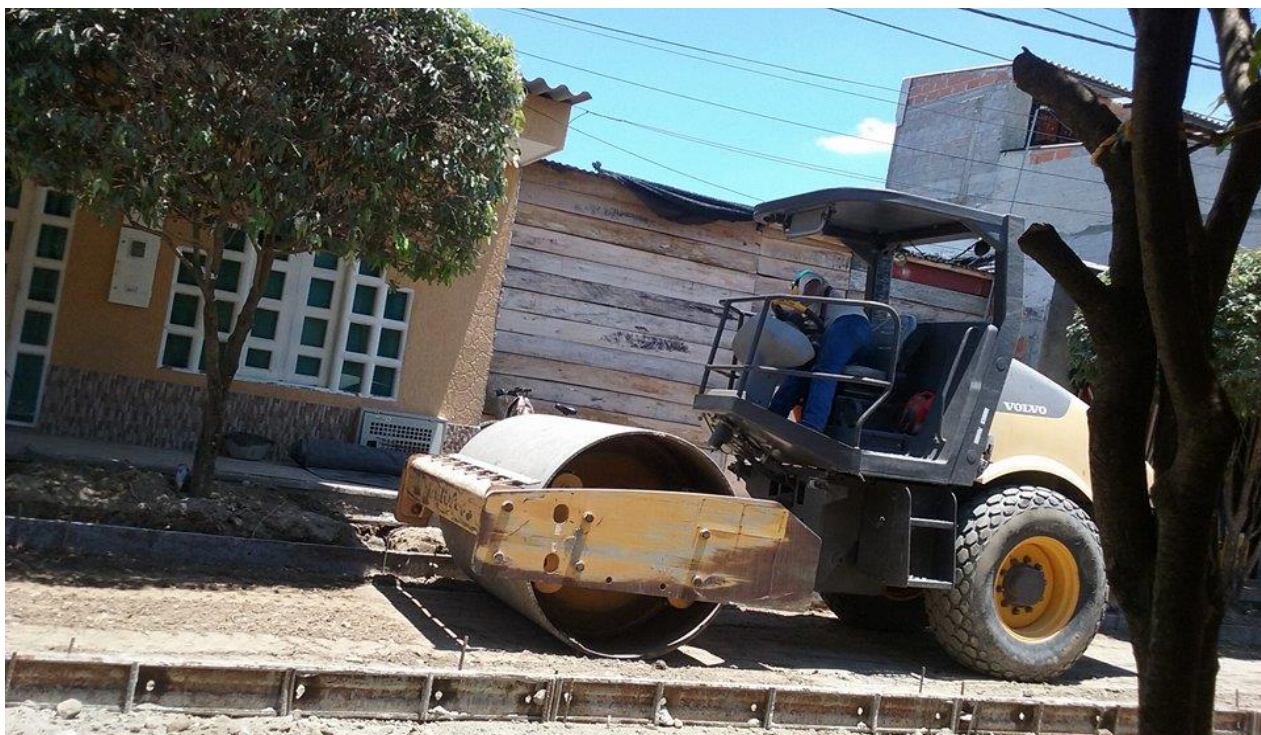
Fotografía 15 Compactación de material seleccionado para sub-base
