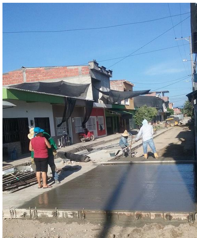
Fotografía 19 y 20 Distribución de la mezcla de concreto método manual, para la formación de la losa.
