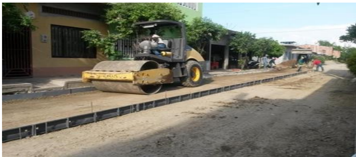
Fotografía 16 Sub-base terminadas en la sección Norte-Este.
