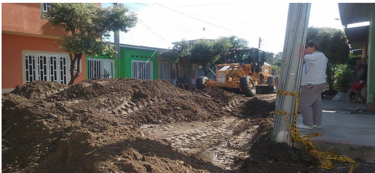
Fotografía 11 Escarificación con motoniveladora Kr 12 entre calle 23-24
