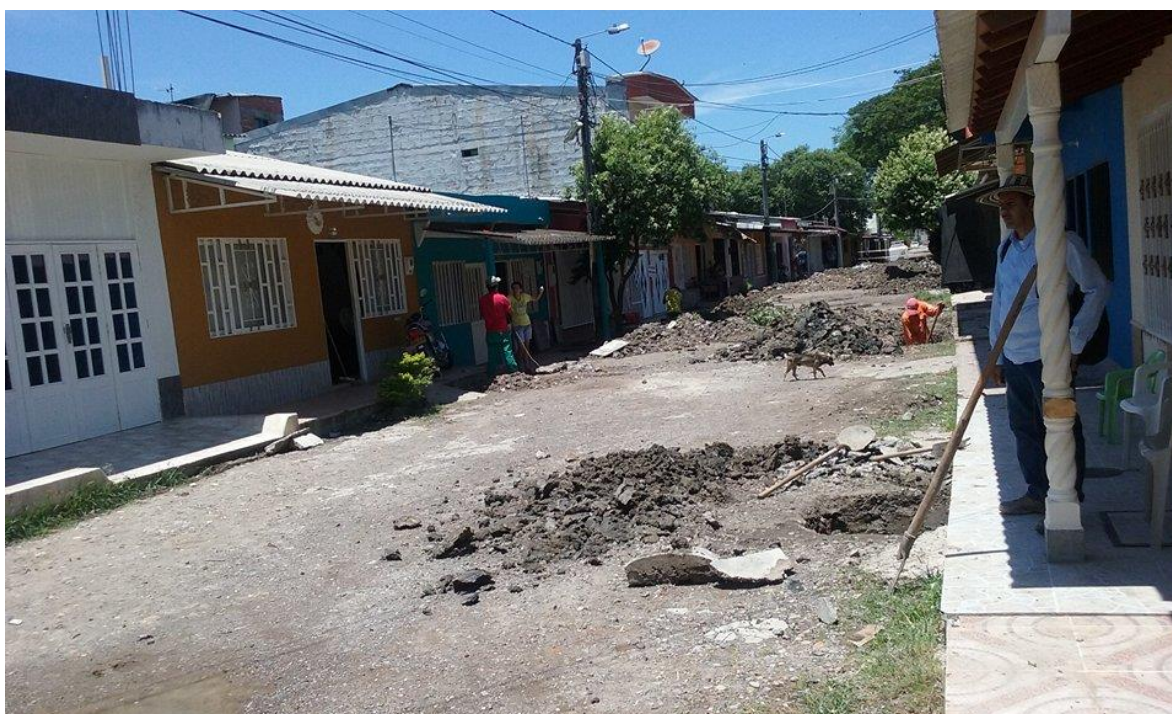
Fotografía 4 Excavación para revisión de acometidas.
