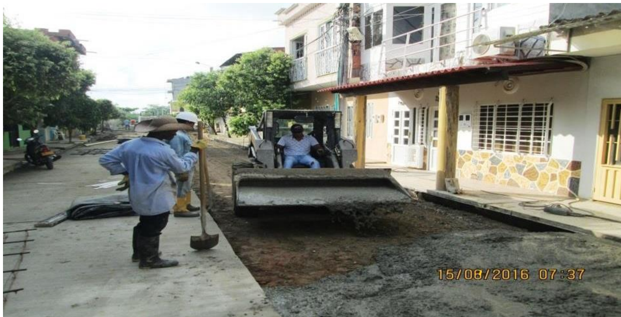
Fotografía 18 Vaciado de Concreto con Mini cargador.
