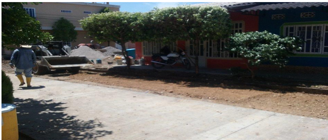
Fotografía 14 Vaciado material seleccionado para sub-base
