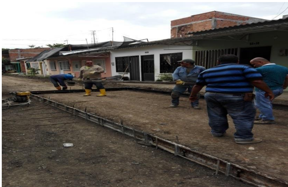
Fotografía 17 Proceso de Formaleteado
