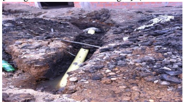
[Fotografía 29 de Fabio Villegas]. (Bolívar. 2016). Instalación tubo de 6" . Cantagallo Bolívar
