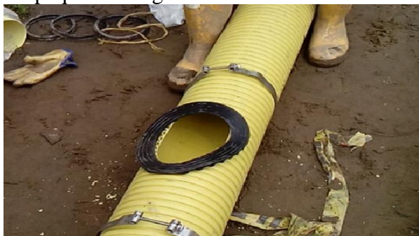
[Fotografía 21 de Fabio Villegas].(Bolivar. 2016). Empaque. Cantagallo Bolivar [Fotografía 22 de Fabio Villegas].(Bolivar. 2016). Instalación silla Y. Núcleo. Cantagallo Bolivar.
