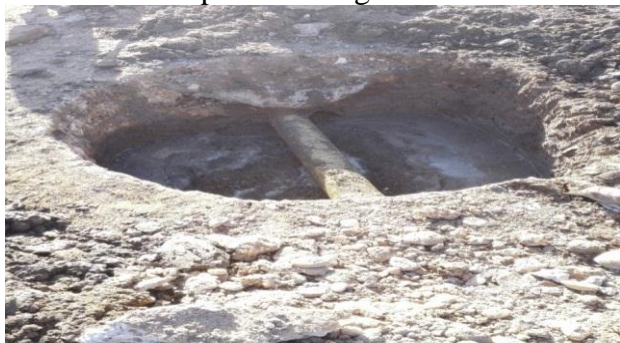
[Fotografía 23 de Fabio Villegas].(Bolivar. 2016) Excavación de pozo. Cantagallo Bolivar
