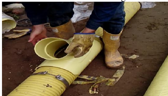
[Fotografía 21 de Fabio Villegas].(Bolivar. 2016). Empaque. Cantagallo Bolivar [Fotografía 22 de Fabio Villegas].(Bolivar. 2016). Instalación silla Y. Núcleo. Cantagallo Bolivar.
