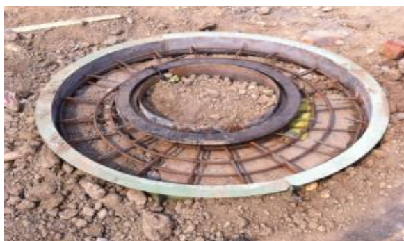
[Fotografía 27 de Fabio Villegas].(Bolívar. 2016). Tapa Núcleo Fundido. Cantagallo Bolívar
