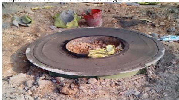
[Fotografía 27 de Fabio Villegas].(Bolívar. 2016). Tapa Núcleo Fundido. Cantagallo Bolívar
