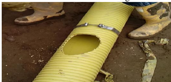
[Fotografía 19 de Fabio Villegas].(Bolivar. 2016) Silla Y. Cantagallo Bolivar [Fotografía 20 de Fabio Villegas].(Bolivar. 2016) Acceso silla Y a Red Matriz. Cantagallo Bolivar.
