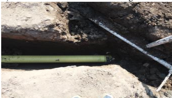
[Fotografía 29 de Fabio Villegas]. (Bolívar. 2016). Instalación tubo de 6" . Cantagallo Bolívar
