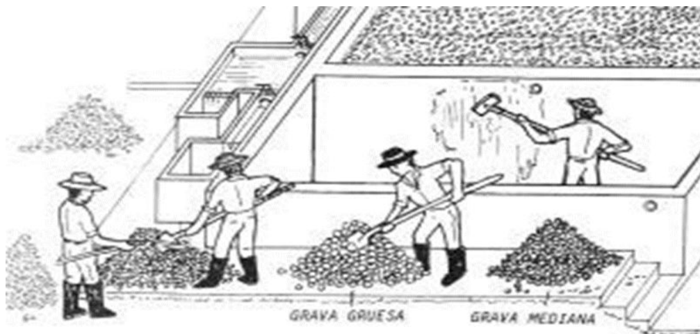
Figura 10. Retiro y lavado de gravas y paredes filtro.
