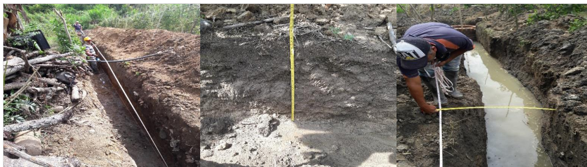
Figura 15. Verificación de dimensiones y pendientes de excavaciones Fuente. Autor del proyecto
