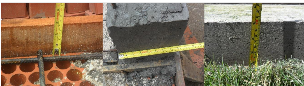
Figura 35. Verificación de espesor de losas y columnas
