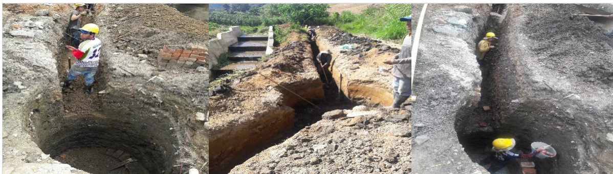
Figura 3. Excavación manual de pozos de inspección
