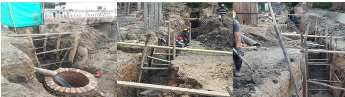
Figura 17. Entibado para la protección de zanjas Fuente. Autor del proyecto
