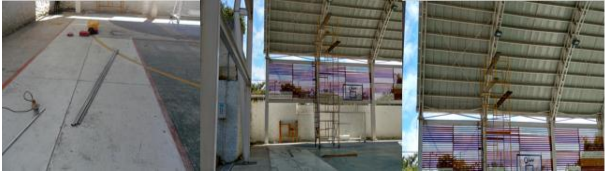
Figura 26. Instalación de acometidas eléctricas y reflectores
