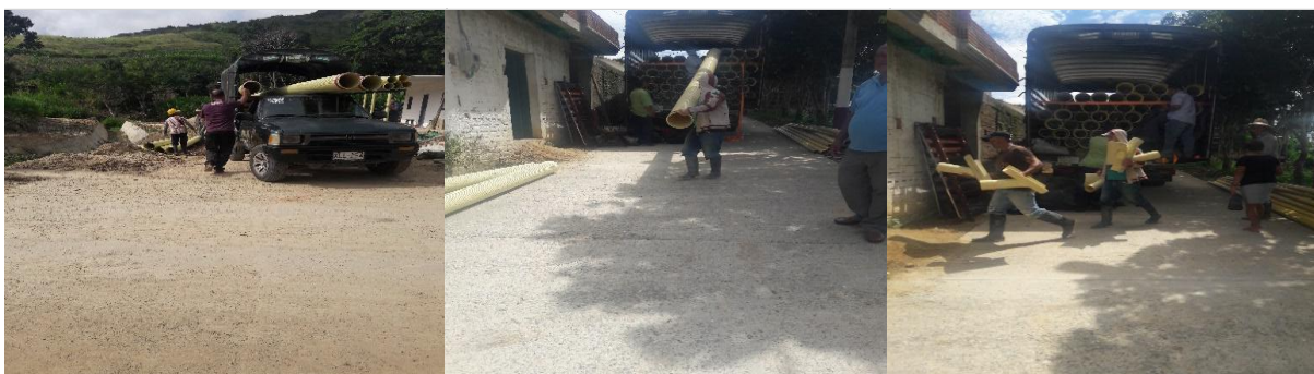
Figura 13. Ingreso de materiales a obra
