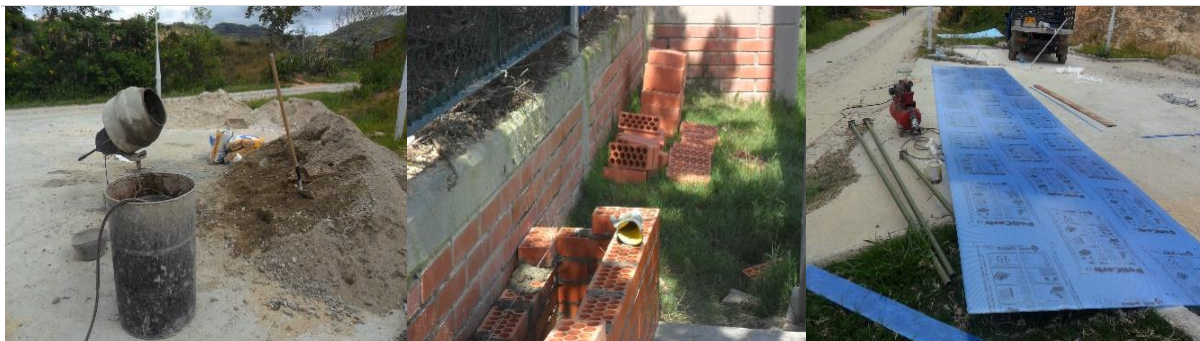
Figura 32. Verificación de materiales empleados para la gradería y los banquillos
