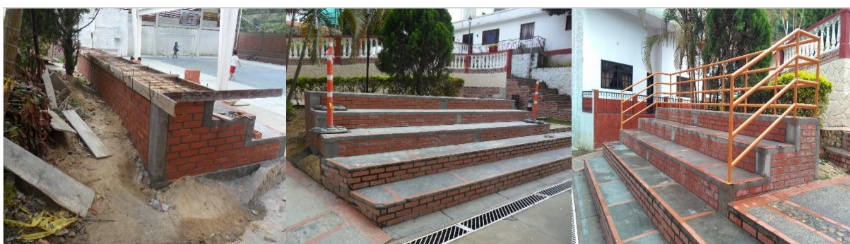
Figura 25. Vaciado de losa e instalación de baranda de protección Fuente. Autor del proyecto
