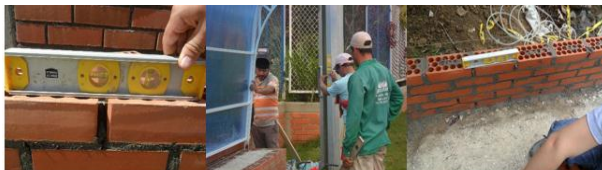
Figura 36. Verificación de niveles de muros y alineamiento de estructura de cubierta
