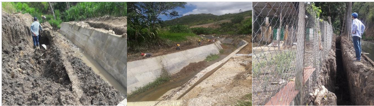
Figura 2. Excavación manual de zanjas
