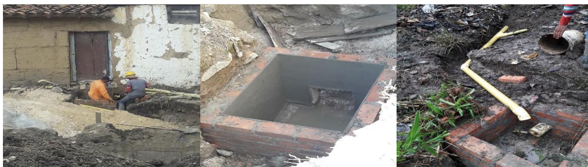
Figura 4. Elaboración de cajas de inspección domiciliarias
