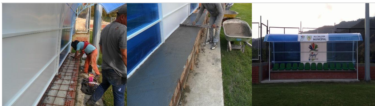
Figura 22. Instalacion de estructura, vaciado de losa y ubicacion de sillas tipo estadio
