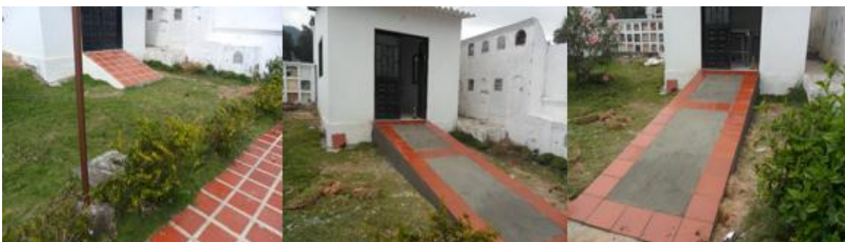
Figura 44. Estado de la rampa de acceso antes y después de su ampliación
