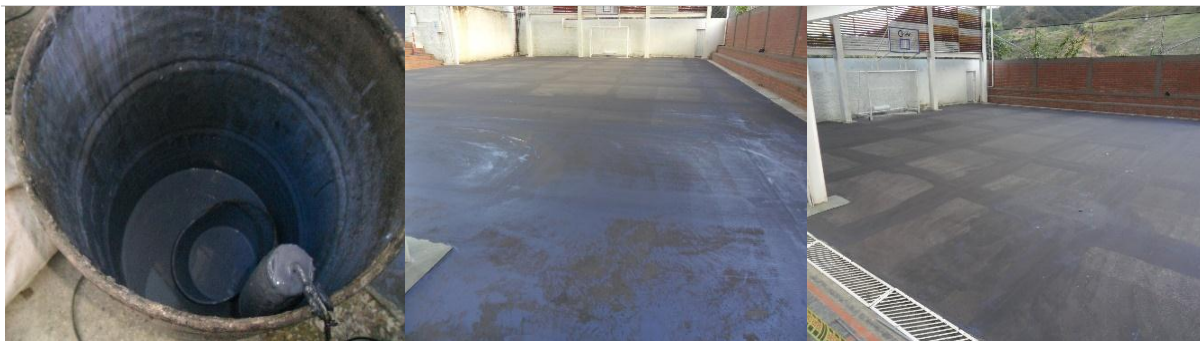
Figura 29. Preparación y aplicación de base gris sobre la superficie de la cancha Fuente. Autor del proyecto
