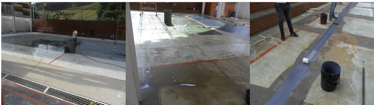
Figura 28. Limpieza, aplicación de impermeabilizante y tratamiento de juntas
