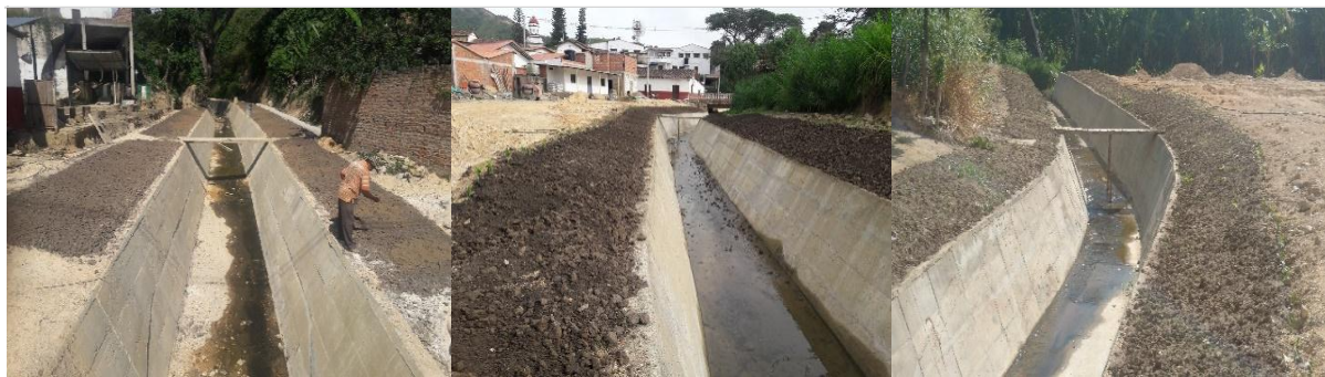
Figura 10. Siembra de gramilla y terminación de la obra
