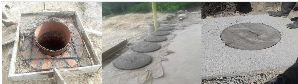
Figura 9. Contrucción de losa de piso y tapas para pozos de inspección
