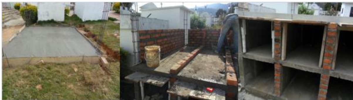
Figura 42. Vaciado de losas y levante de muros en ladrillo común para bóvedas
