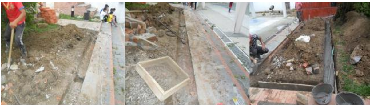
Figura 23. Descapote, excavación y vaciado de viga de cimentación Fuente. Autor del proyecto
