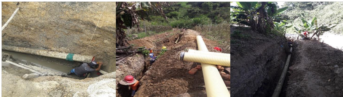
Figura 5. Instalación de tubería pvc corrugada de 10" y 12"
