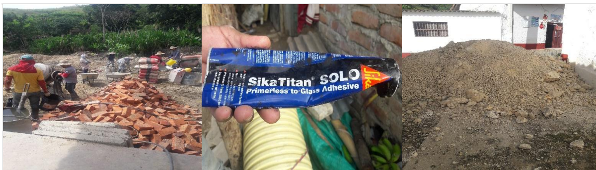
Figura 12. Materiales utilizados en obra
