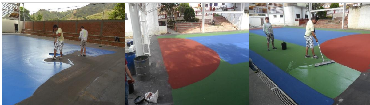
Figura 30. Aplicación de capas de color sobre la superficie de la cancha Fuente. Autor del proyecto
