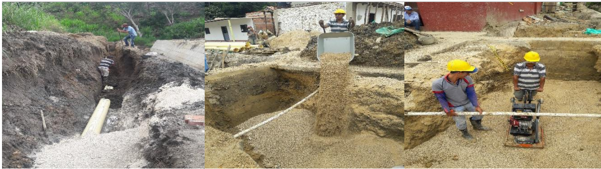
Figura 8. Relleno compactado mecánicamente sobre zanjas y pozos
