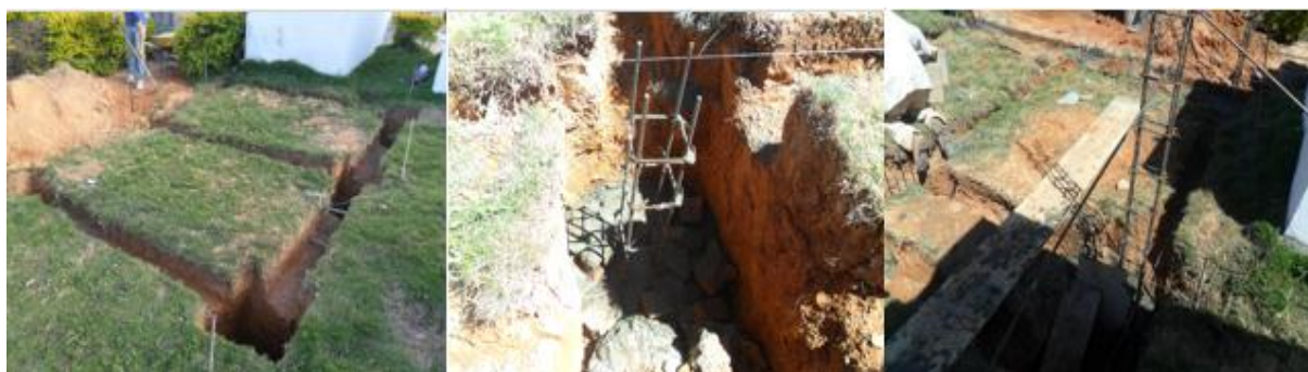
Figura 41. Excavaciones y cimentaciones para bóvedas
