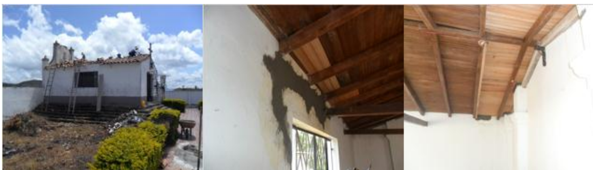
Figura 38. Reparación de la cubierta de la capilla Fuente. Autor del proyecto
