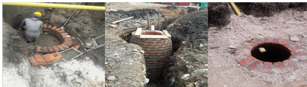
Figura 7. Construcción de pozos de inspección
