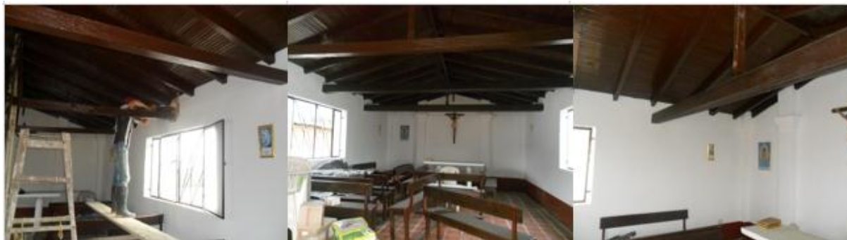
Figura 39. Desmonte de vigas existentes e instalación de vigas nuevas
