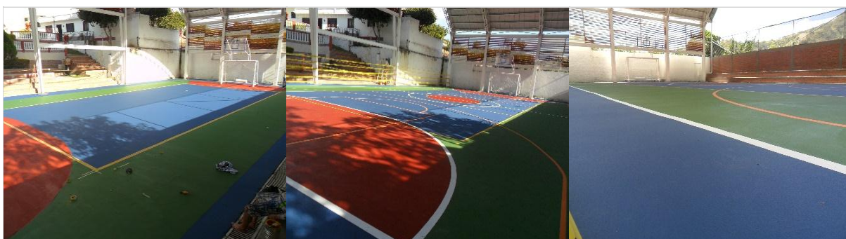
Figura 31. Demarcación y terminado de recubrimiento sintético Fuente. Autor del proyecto
