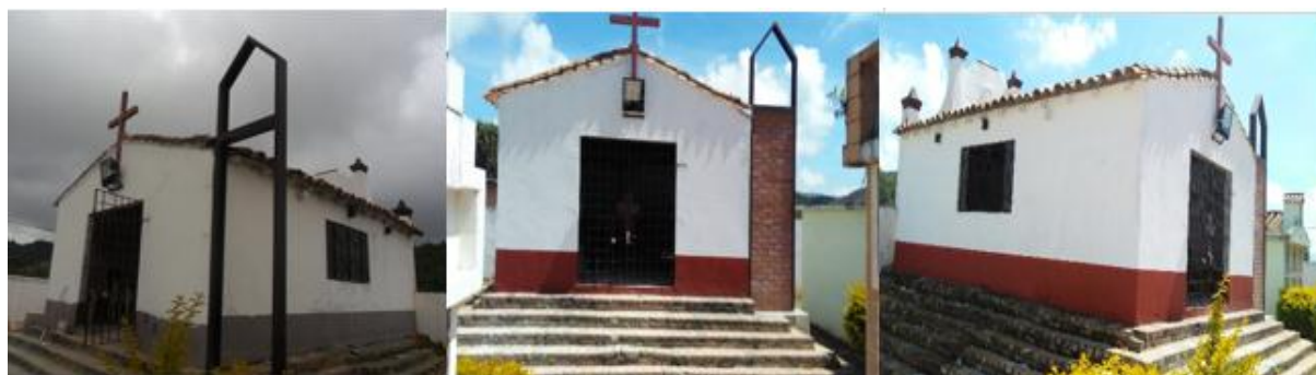
Figura 40. Instalación de estructura para campanario y mejoramiento de capilla terminado
