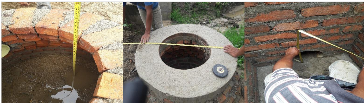
Figura 16. Verificación de dimensiones de pozos y cajas de inspección Fuente. Autor del proyecto
