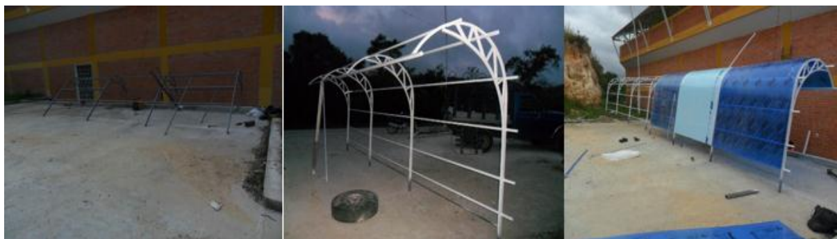
Figura 21. Elaboracion de estructura metalica e instalacion de cubierta
