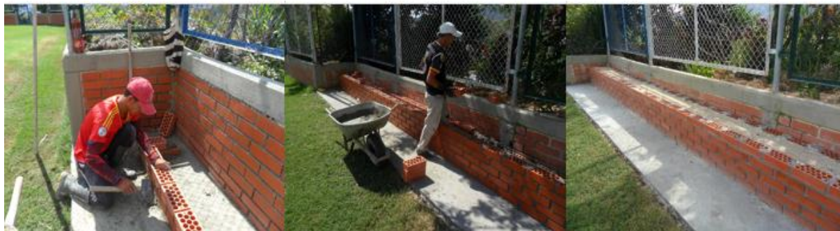
Figura 20. Levante de muro en ladrillo a la vista
