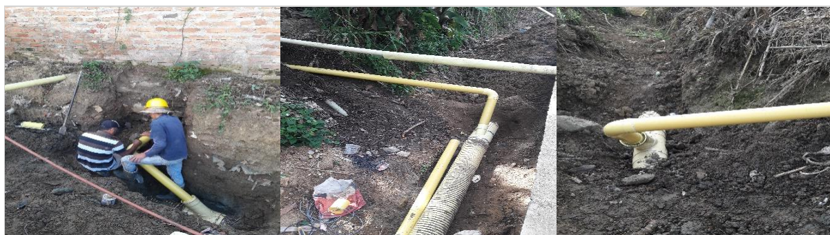
Figura 6. Instalación de acometidas de alcantarillado
