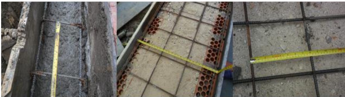
Figura 34. Verificación del acero de refuerzo
