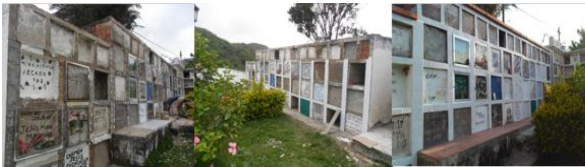
Figura 45. Mejoramiento de fachada de las bóvedas existentes
