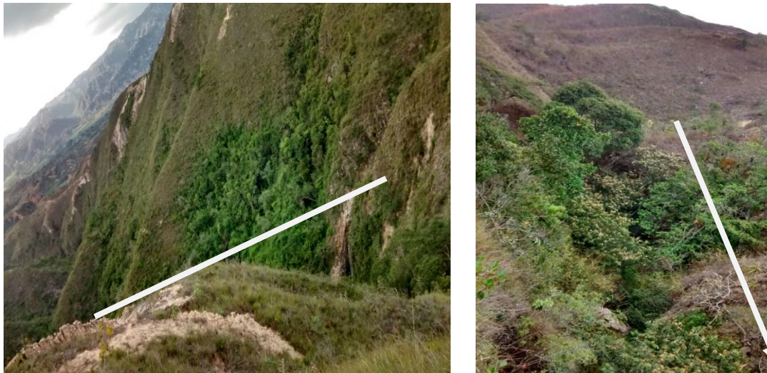
Figura 12. Línea de conducción desarenador – tanque
