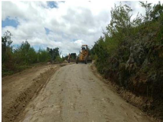
Figura 4. Perfilado de la vía.
