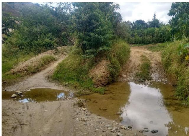
Figura 16. Zonas sin ningún tipo de obra de drenaje en la vía.
