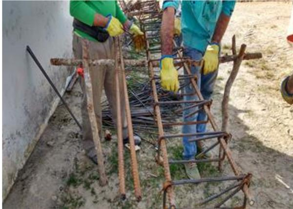
Figura 6. Figurado acero de refuerzo para vigas y viguetas.
