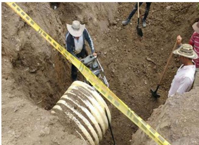
Figura 11. Construcción de obras de drenaje.
