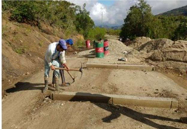
Figura 8. Nivelación manual para la fundición de las huellas.
