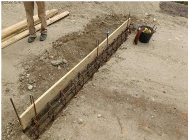
Figura 7. Encofrado para el proceso de fundición de vigas y viguetas.
