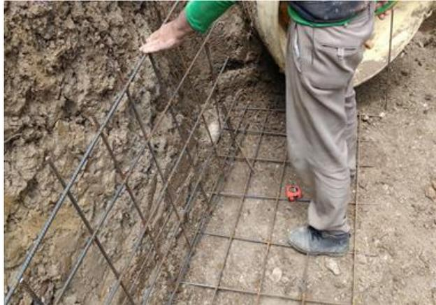
Figura 12. Acero de 1/2" y 3/8" para obras de drenaje.
