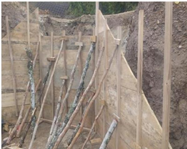
Figura 13. Entibado para función de estructuras complementarias de obras de drenaje.
