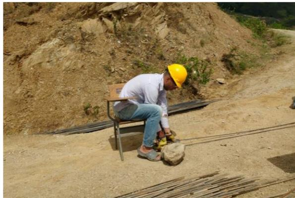
Figura 24. Almacenaje de acero figurado al lado de la vía.
