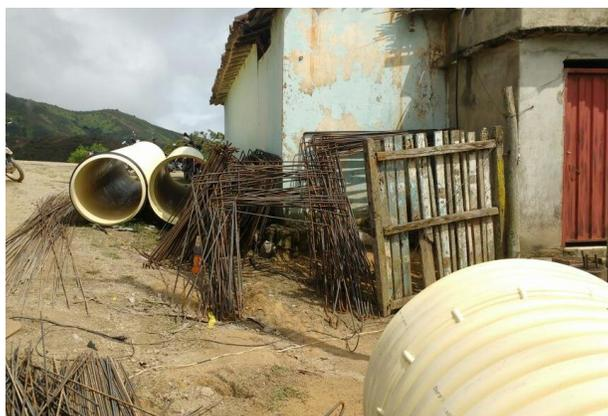
Figura 21. Almacenaje de acero de refuerzo y tubería para obras de drenaje.
