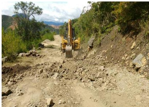
Figura 3. Excavación mecánica en material común.
