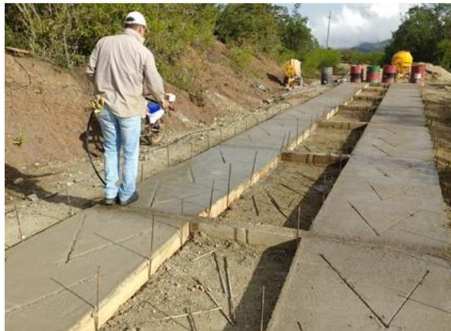
Figura 9. Fundición de huellas en concreto.
