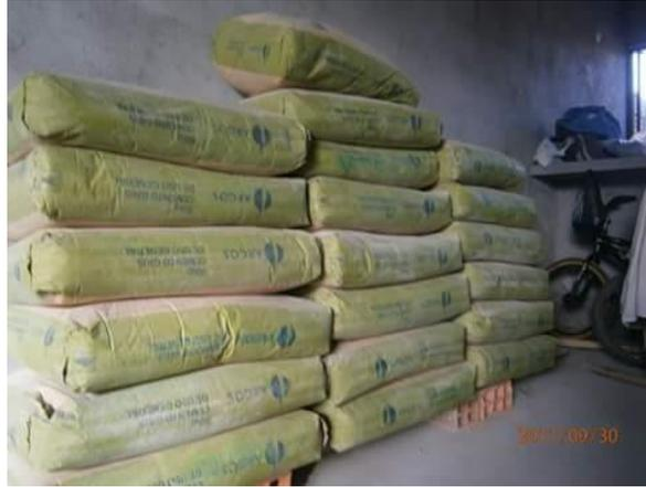
Figura 23. Almacenaje de cemento portland después de recomendación realizada.
