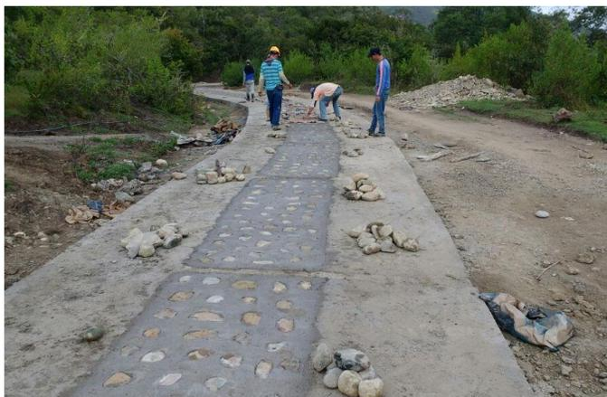
Figura 10. Fundición concreto ciclópeo.
