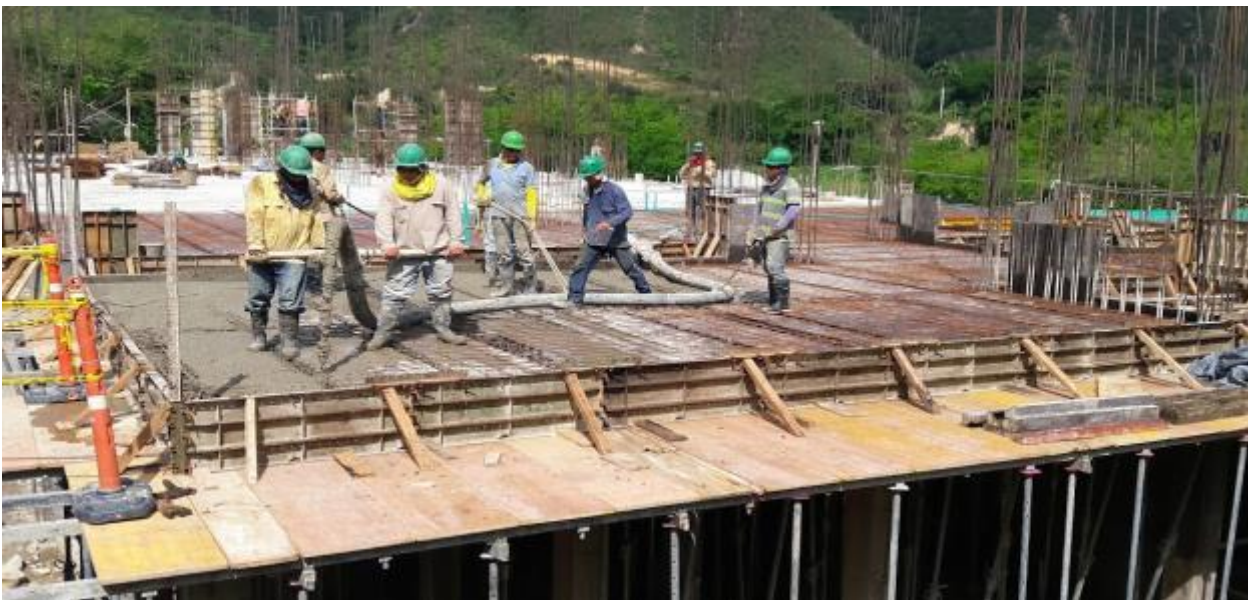
Foto 32. Vaciado de concreto desde Mixer para fundir placa
