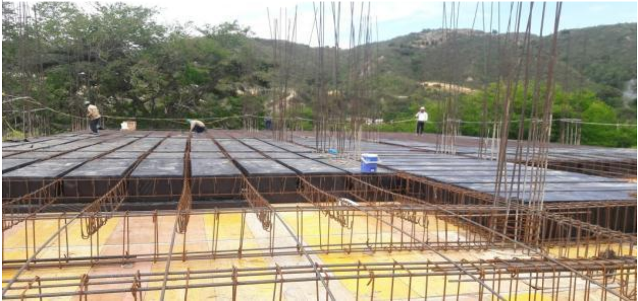
Foto 17. Instalación de casetones
