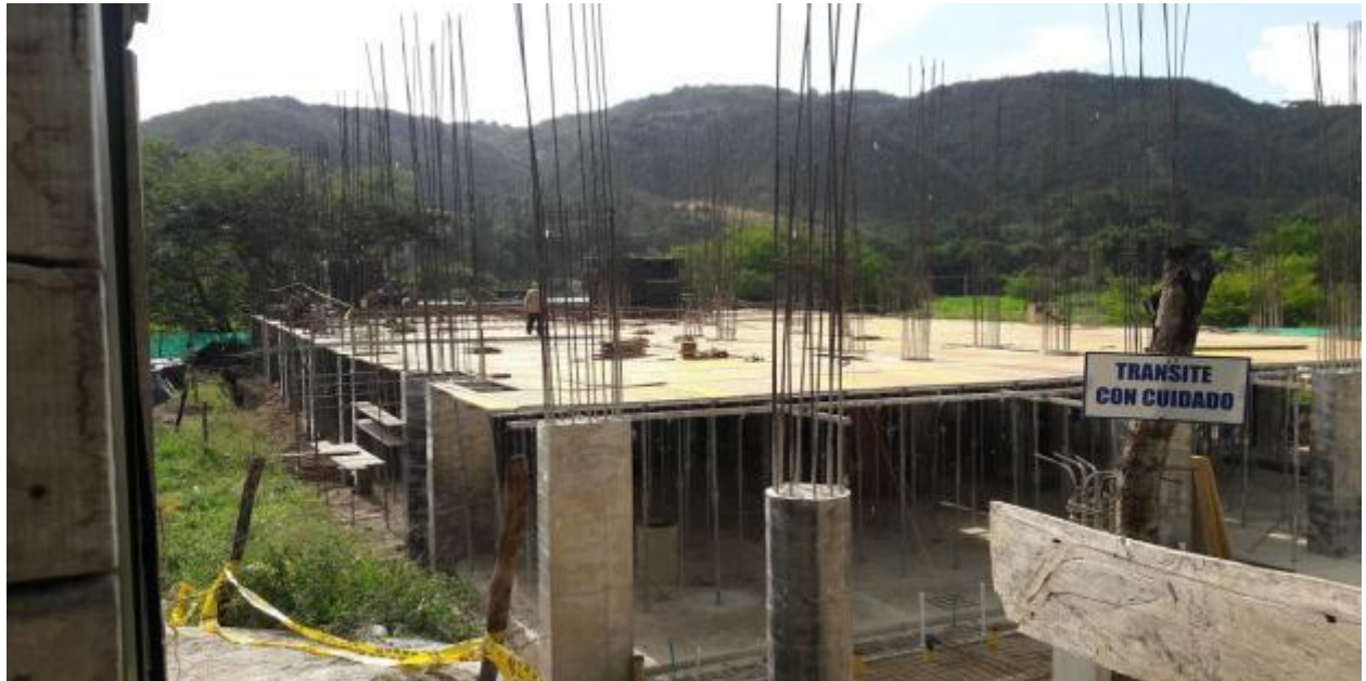
Foto 15. Armado de placa
