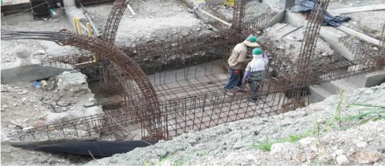
Foto 12. Figurado de acero para fondo de ascensor
