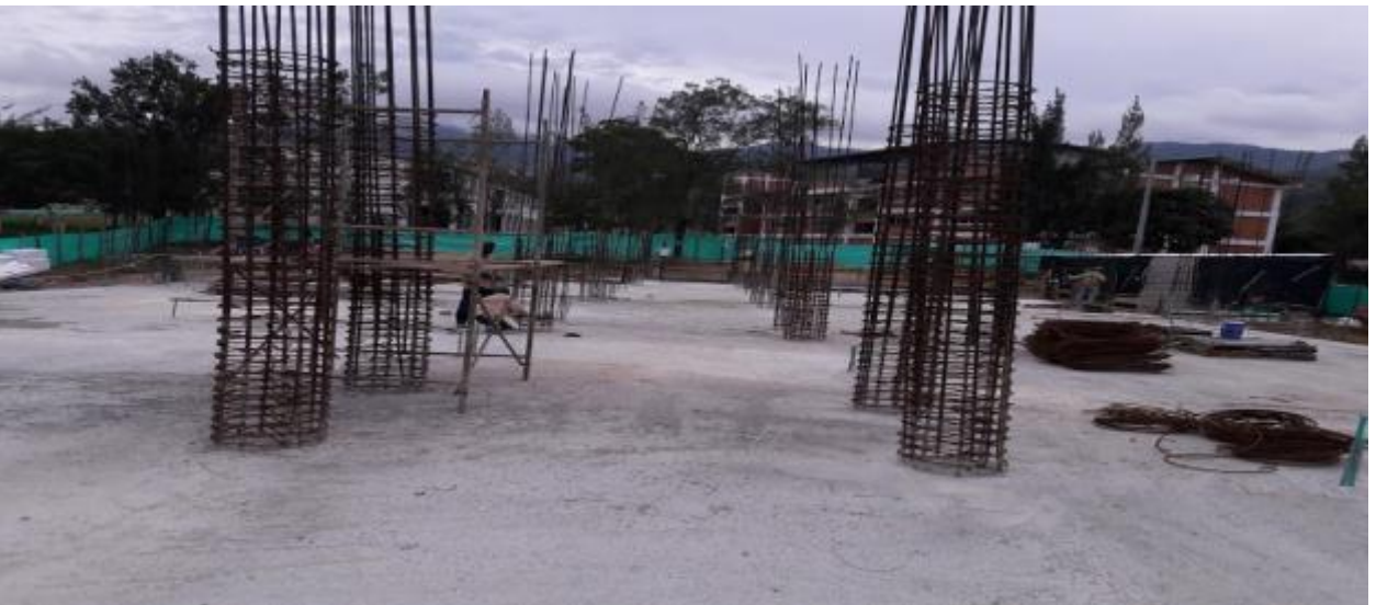
Foto 34. Figurado de acero para columnas del segundo nivel
