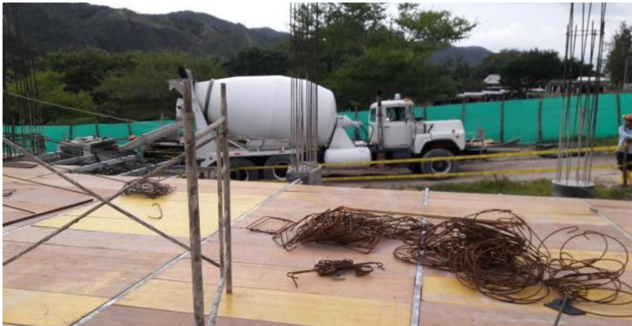
Foto 23. Vaciado para las pantallas del ascensor
