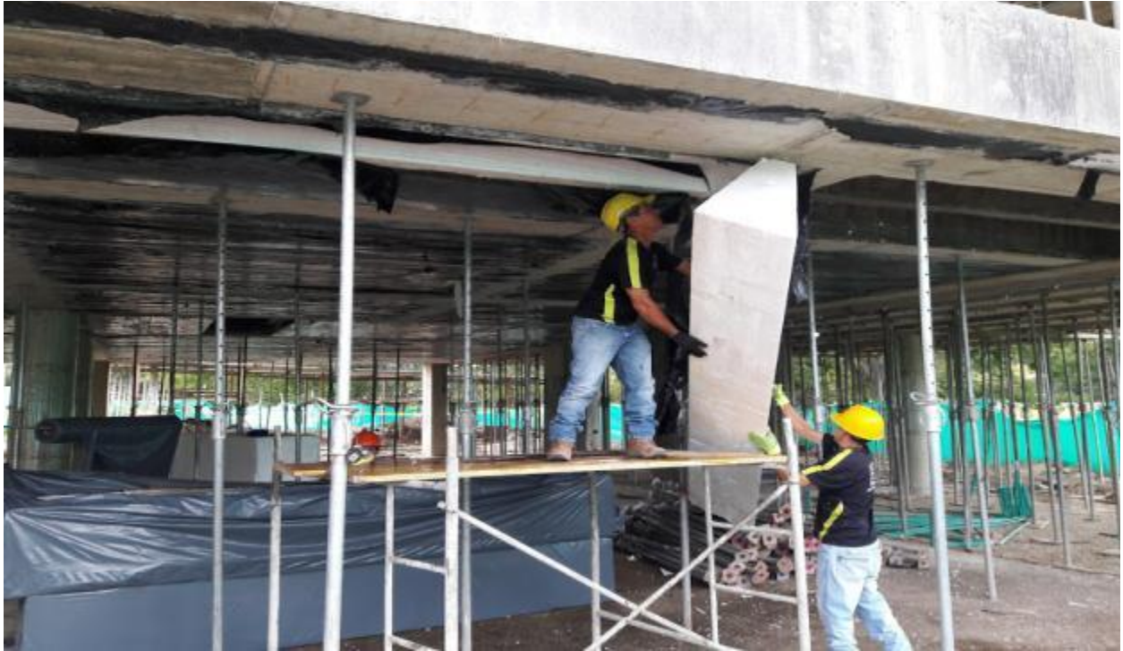
Foto 39. Retiro de casetones
