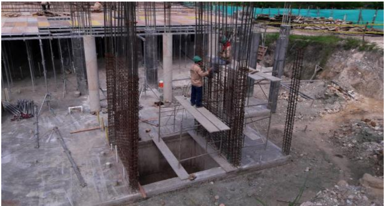
Foto 16. Figurado de acero para pantallas del ascensor
