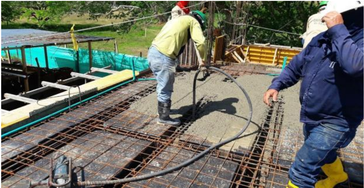
Foto 29. Instalación ductería segundo nivel
