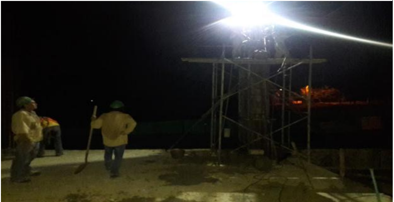
Foto 37. Vaciado de concreto para columnas
