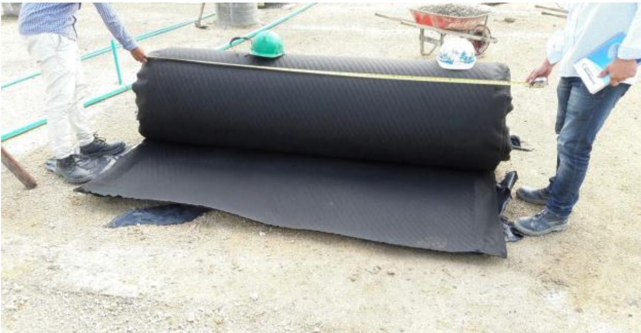
Foto 8. Geodren para recubrimiento del filtro
