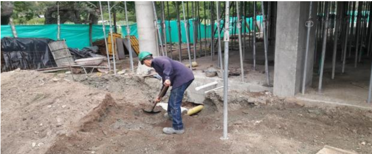
Foto 26. Redimensionamiento de los casetones ya que no se estaba cumpliendo el recubrimiento.
