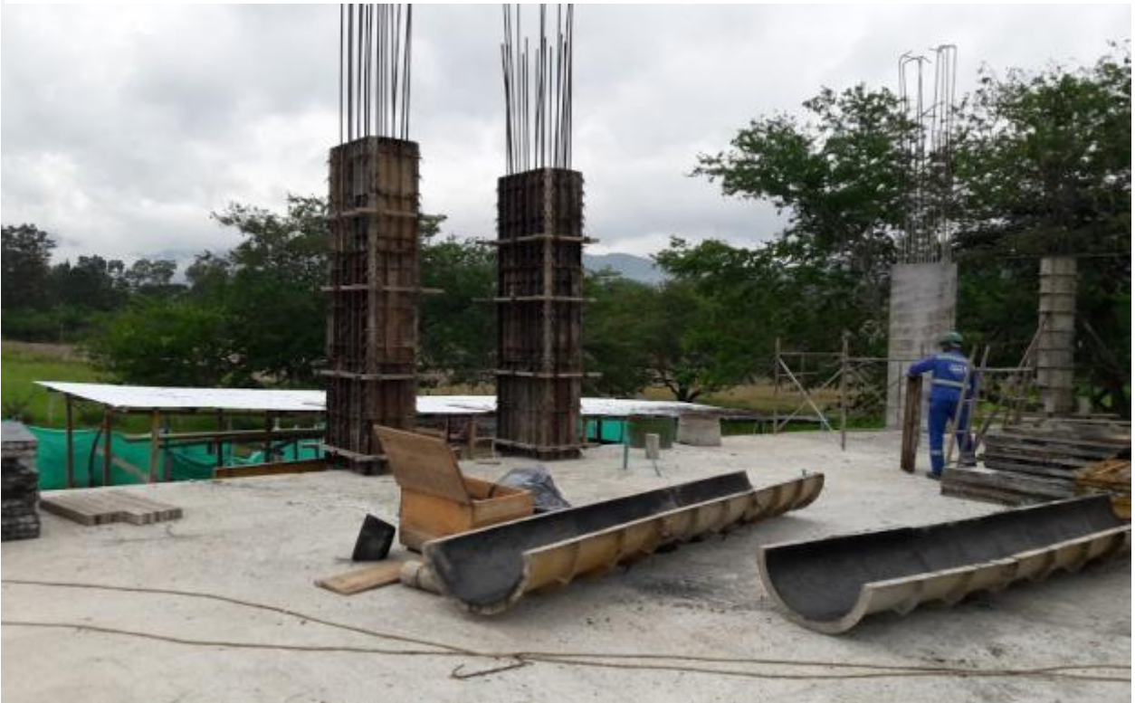
Foto 33. Formateado de columnas segundo nivel
