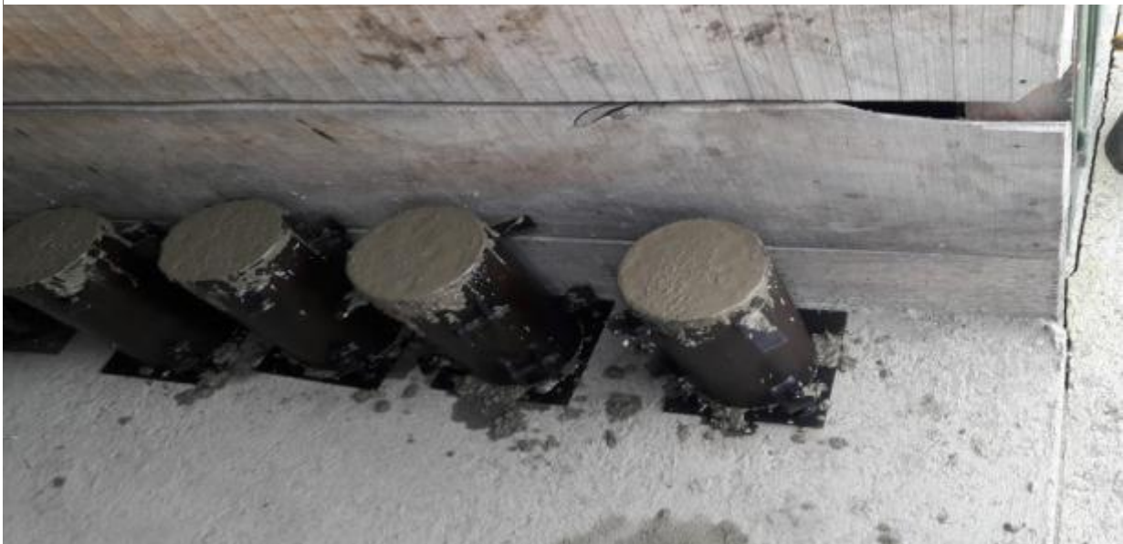
Foto 20. Formateado de para las pantallas del ascensor
