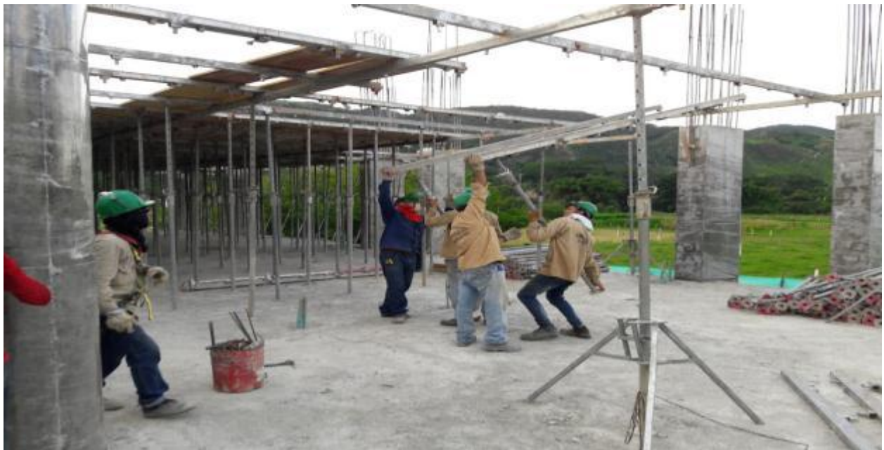
Foto 38. Armado de placa segundo nivel.
