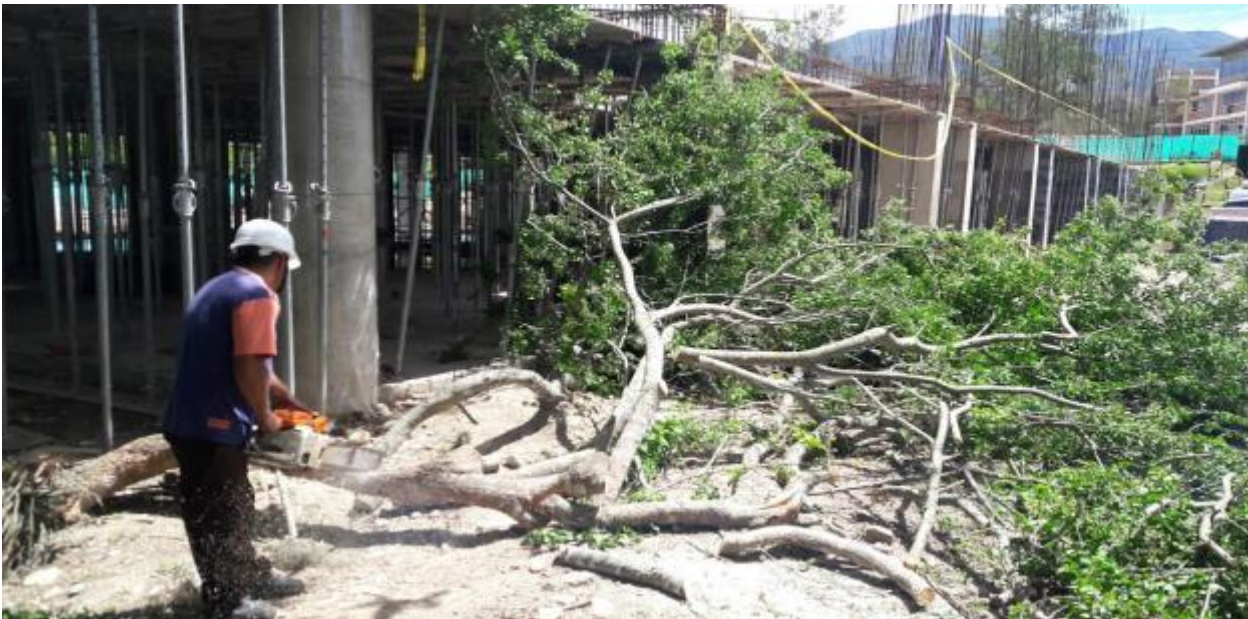
Foto 11. Corte de ramas que impedían el figurado de acero para columnas del segundo nivel.
