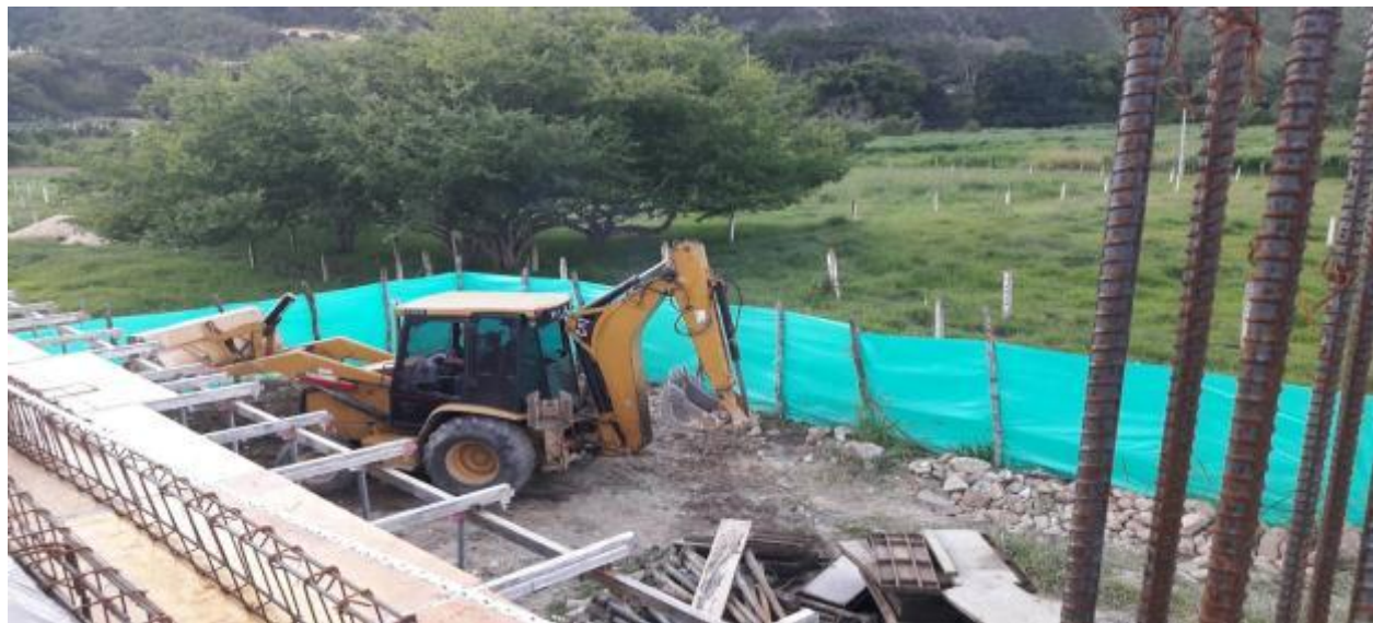
Foto 18. Maquina utilizada para retiro de escombros
