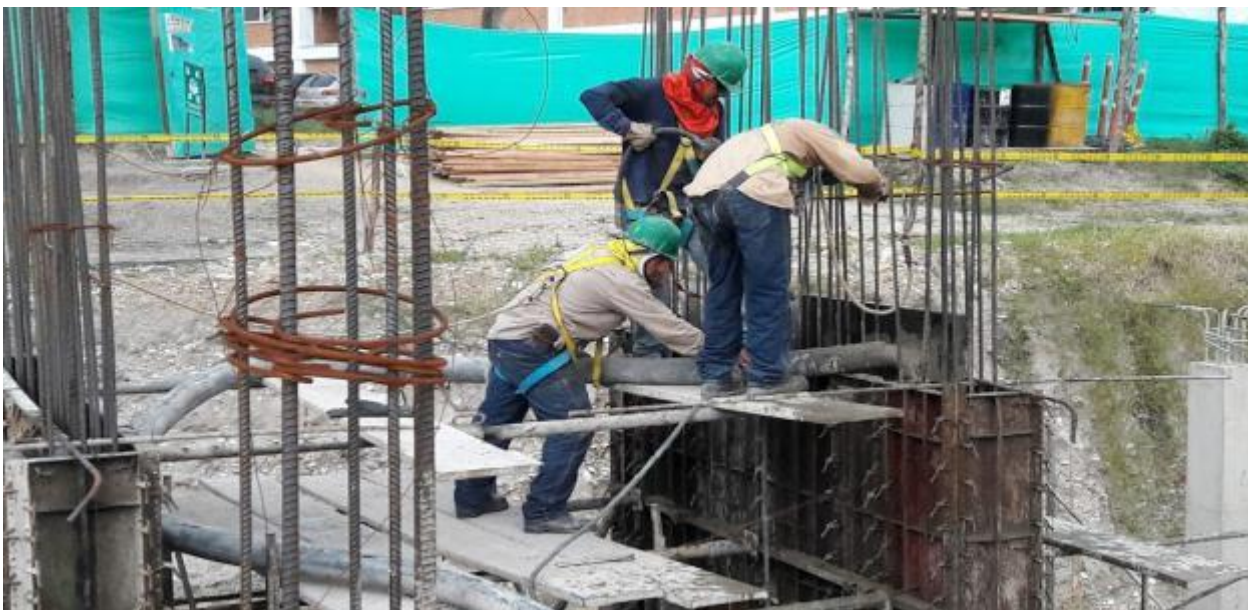
Foto 22. Estos cilindros se utilizaban para aplomar las paredes del ascensor, de modo de que se cumplieran los niveles
