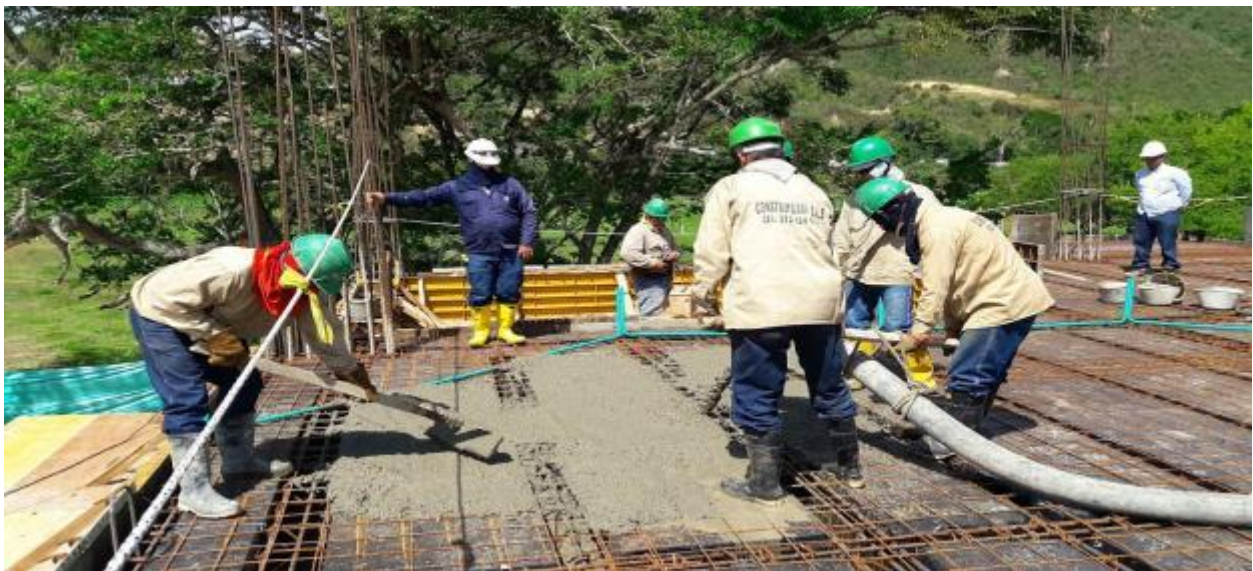
Foto 30. Vaciado de concreto desde Mixer para la placa del primer nivel
