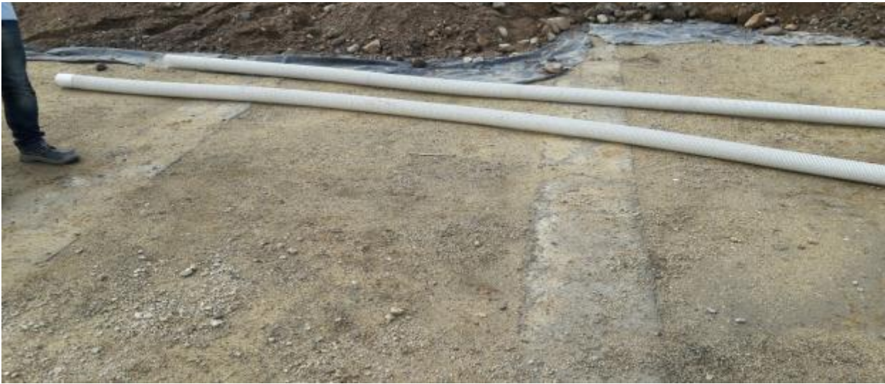
Foto 10. Tubería de 4" perforada y corrugada para filtro
