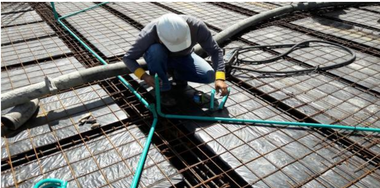
Foto 28. Figurado de acero segundo nivel.
