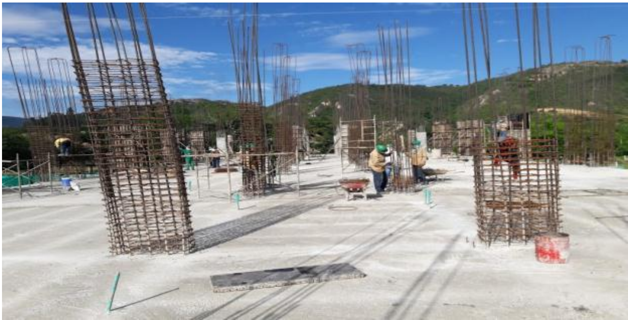
Foto 35. Figurado de acero para columnas del segundo nivel
