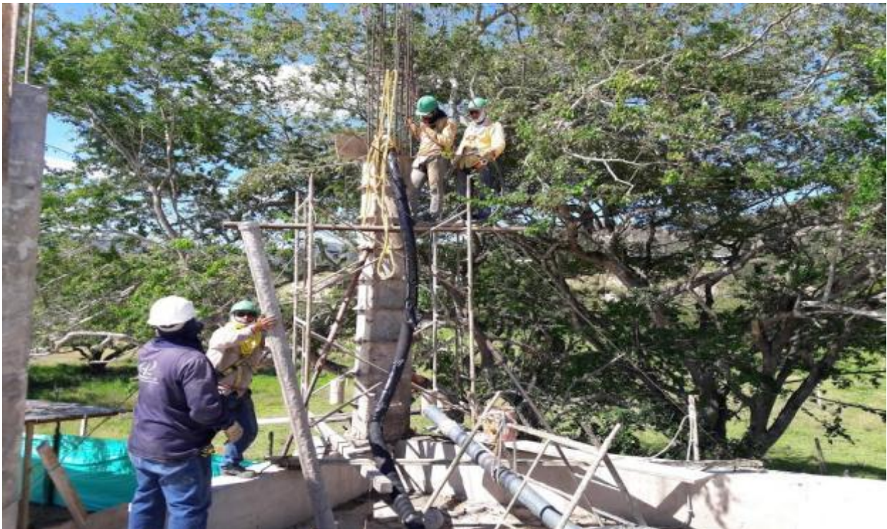
Foto 36. Vaciado de concreto para columnas
