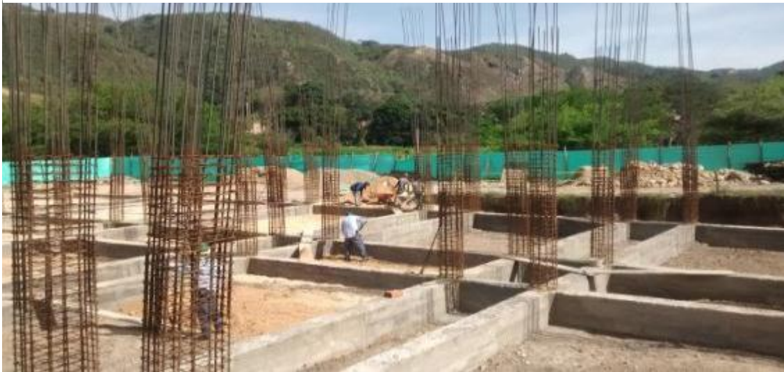
Foto 3. Relleno con capas de 5 cm
