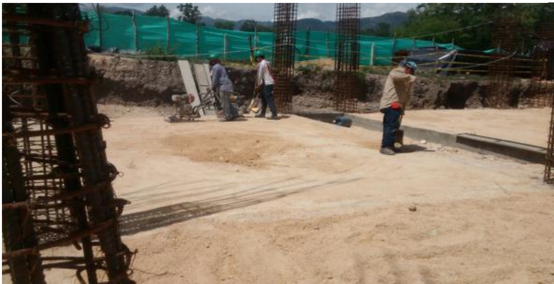
Foto 4. Compactación de cada capa de 5 cm
