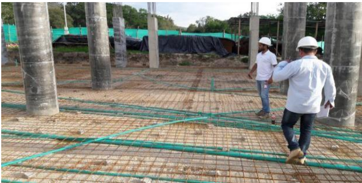
Foto 6. Revisión de ductería
