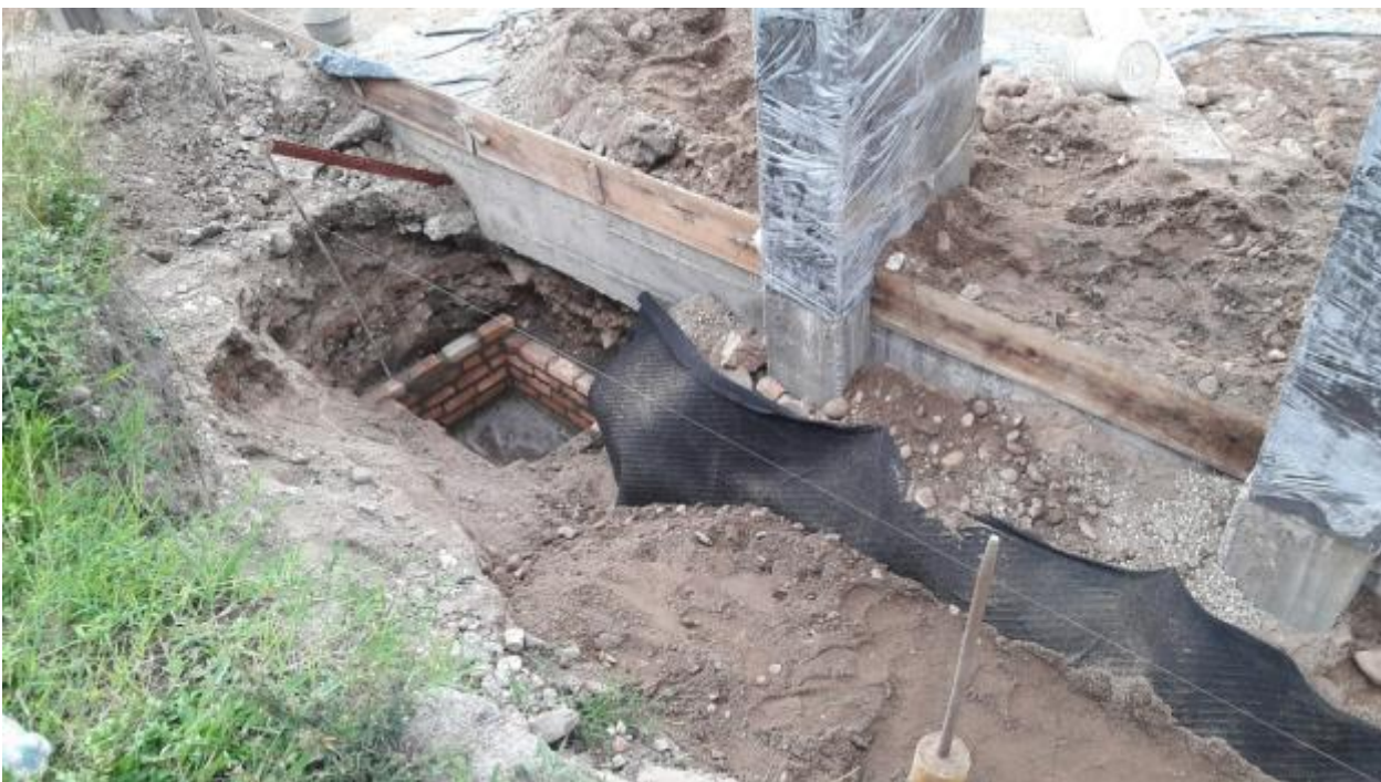
Foto 9. Instalación de Tubería de 4" perforada y corrugada con Geodren para filtro
