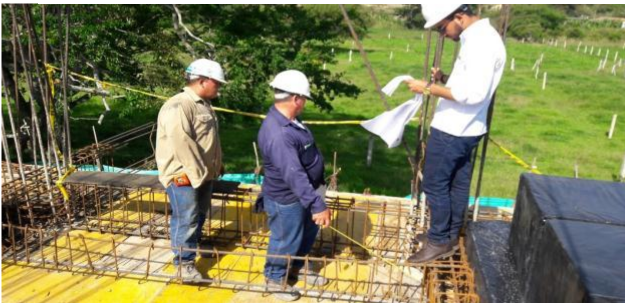
Foto 14. Revisión de especificaciones técnicas con respecto al acero.
