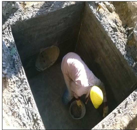
Fotografía 35. Cajas de Inspección.
