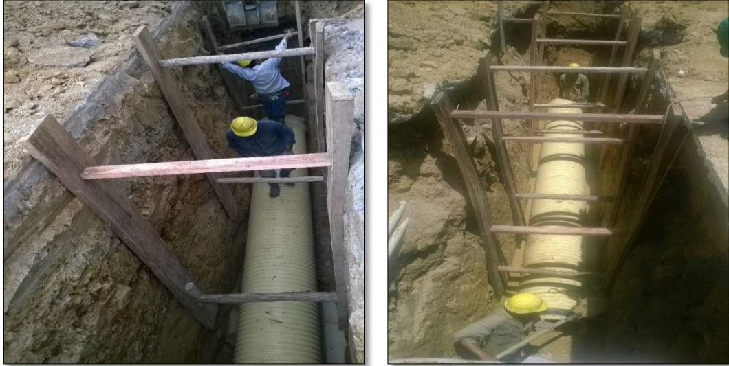
Fotografía 21. Instalación de tubería.
