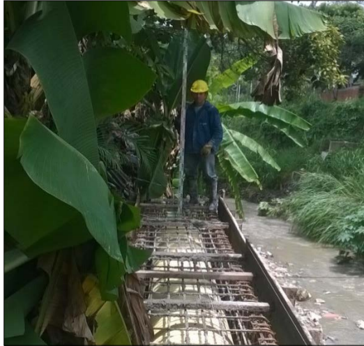
Fotografía 1. Localización y replanteo.
