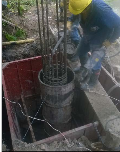
Fotografía 7. Colocación de concreto cimentación.
