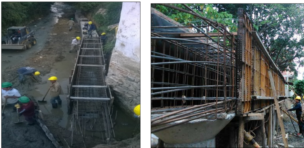
Fotografía 10. Encofrado Viaducto.
