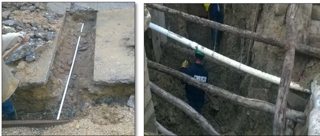
Fotografía 22. Reposición de tubería agua potable.
