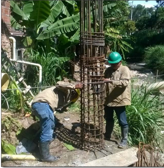
Fotografía 5. Armado de hierro.
