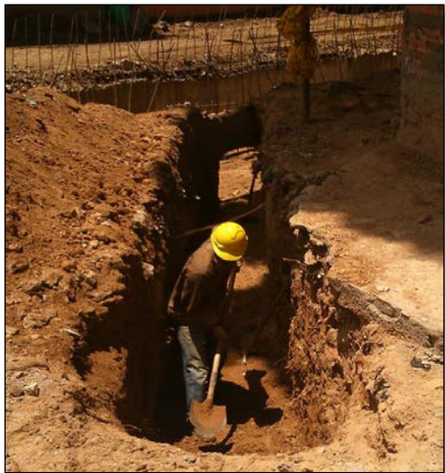
Fotografía 29. Excavación manual sumidero Tacaloa.
