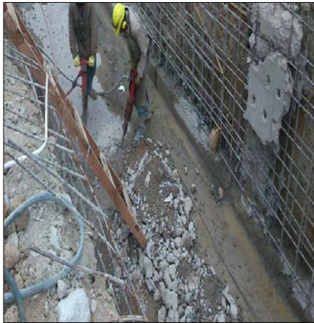
Fotografía 44. Perforación y demolición placa inferior.
