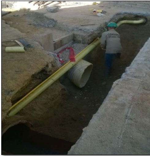
Fotografía 34. Instalación de tubería
