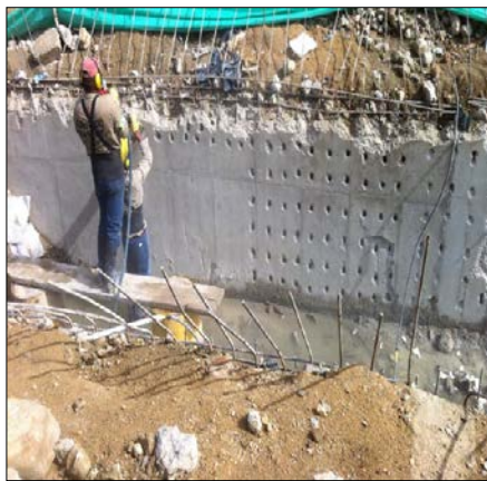
Fotografía 42. Perforaciones muro
