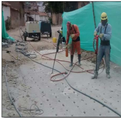
Fotografía 37. Perforación Placa a Demoler.
