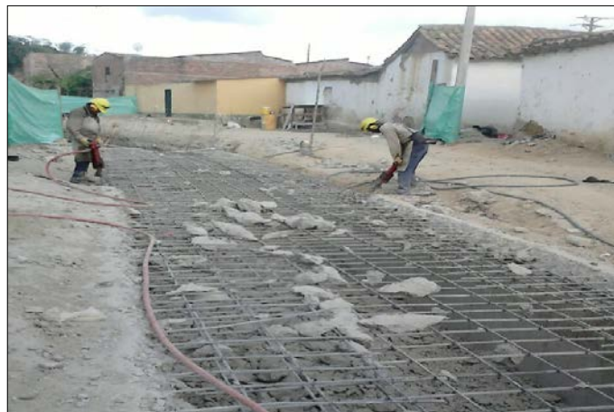
Fotografía 40. Demolición placa.
