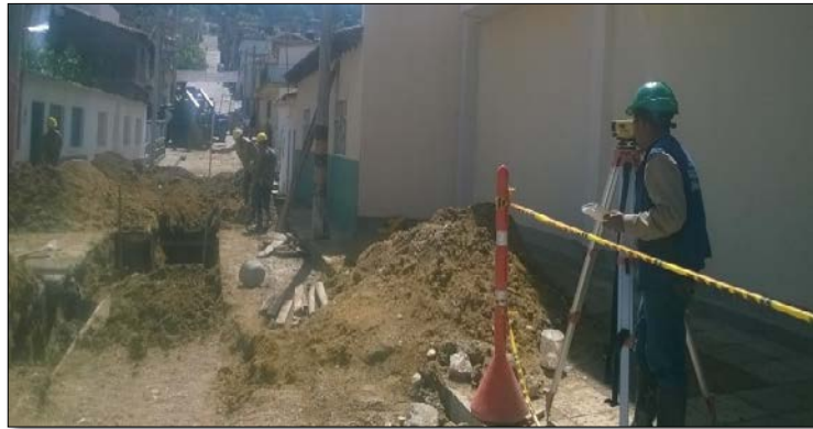
Fotografía 15. Localización y Replanteo.
