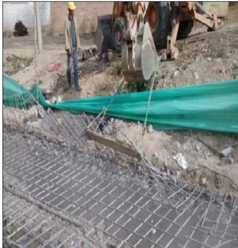
Fotografía 41. Recuperación de Refuerzo.
