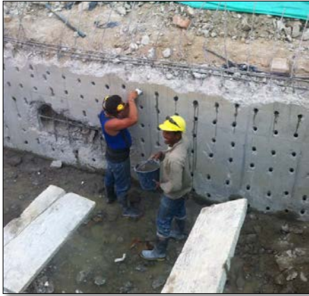
Fotografía 43. Dosificación y Demolición.
