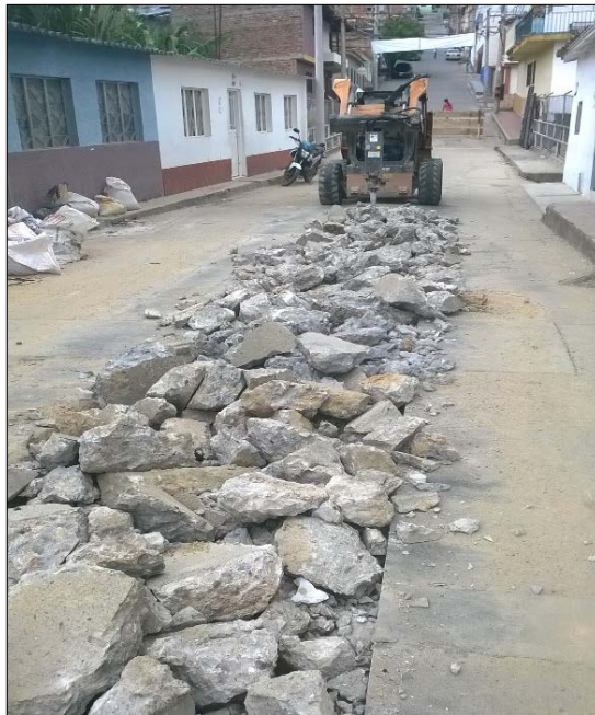
Fotografía 16. Demolición pavimento.
