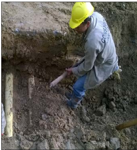
Fotografía 18. Excavación manual.
