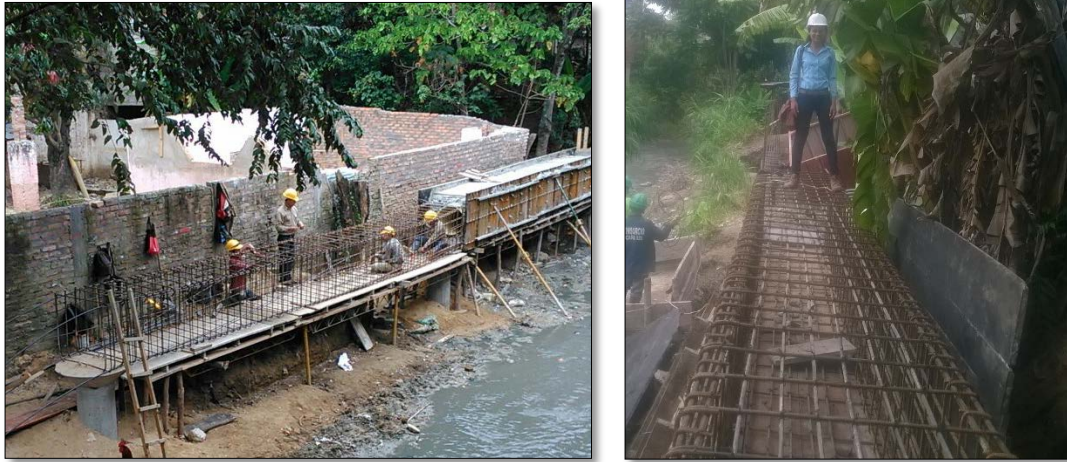
Fotografía 9. Armado de hierro.
