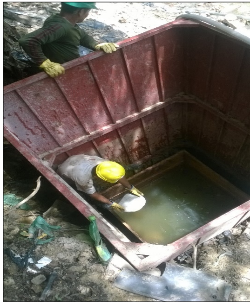
Fotografía 6. Concretos y mejoramientos.
