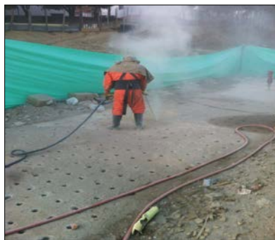
Fotografía 38. Limpieza de Perforaciones.
