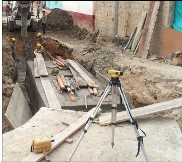
Fotografía 28. Localización y Replanteo
