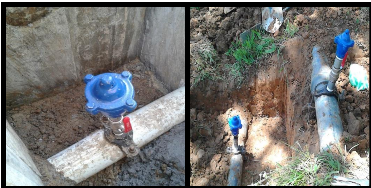
Fotografías N° 6. Instalación de válvulas.
