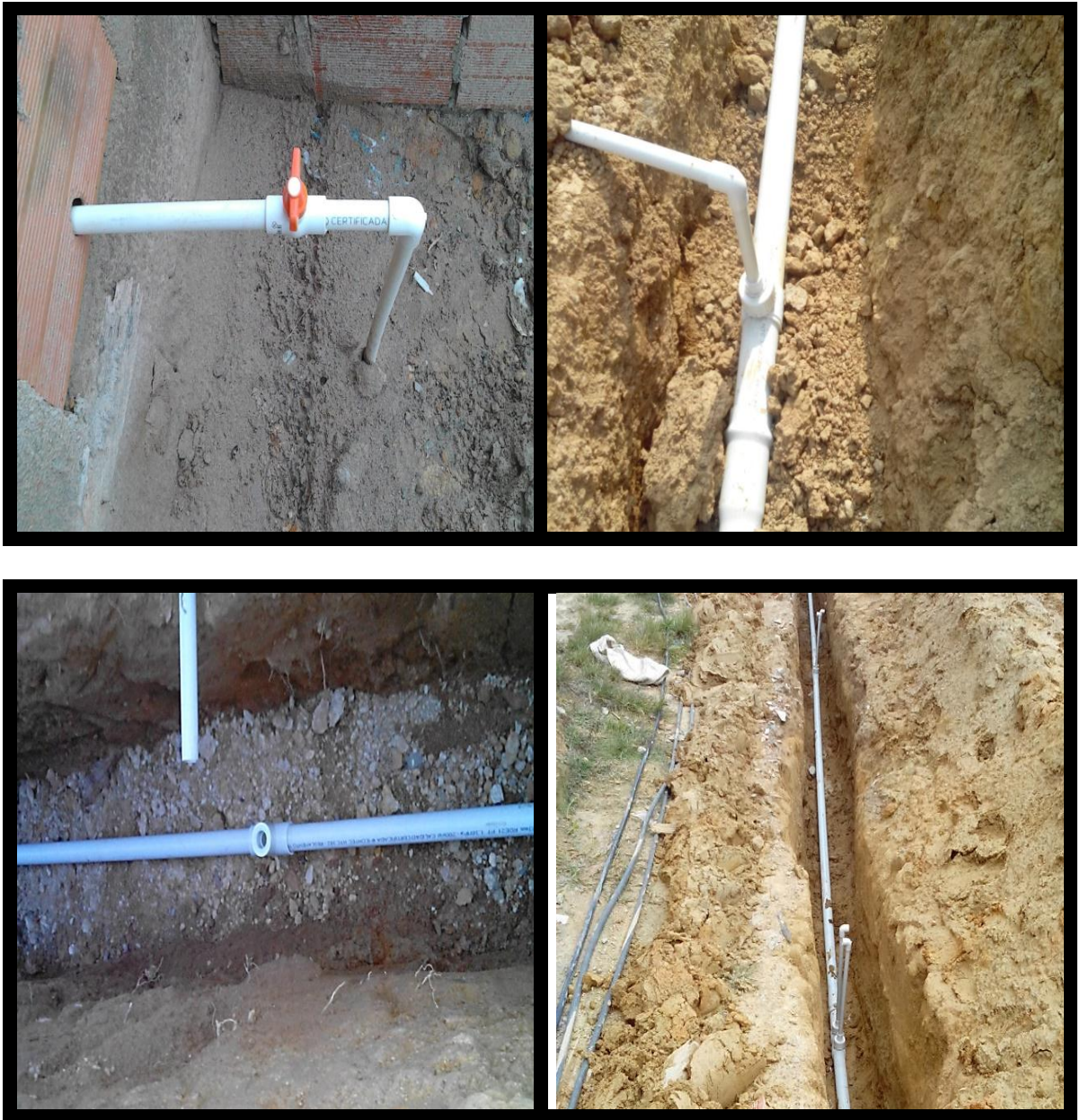
Fotografías N° 7. Instalación de Acometidas domiciliarias.
