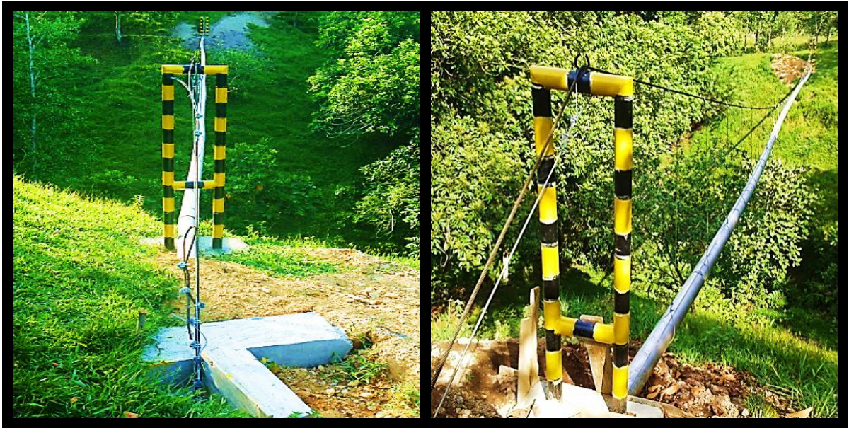
Fotografías N° 8. Instalación de Paso Elevado.
