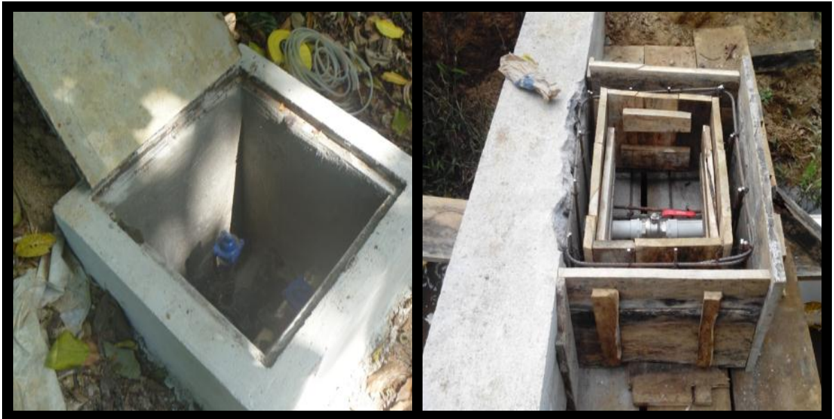
Fotografías N° 4. Concreto.
