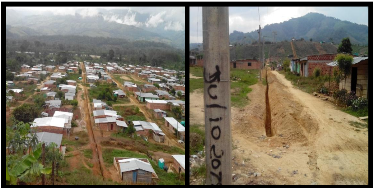
Fotografías N°2. Excavación.
