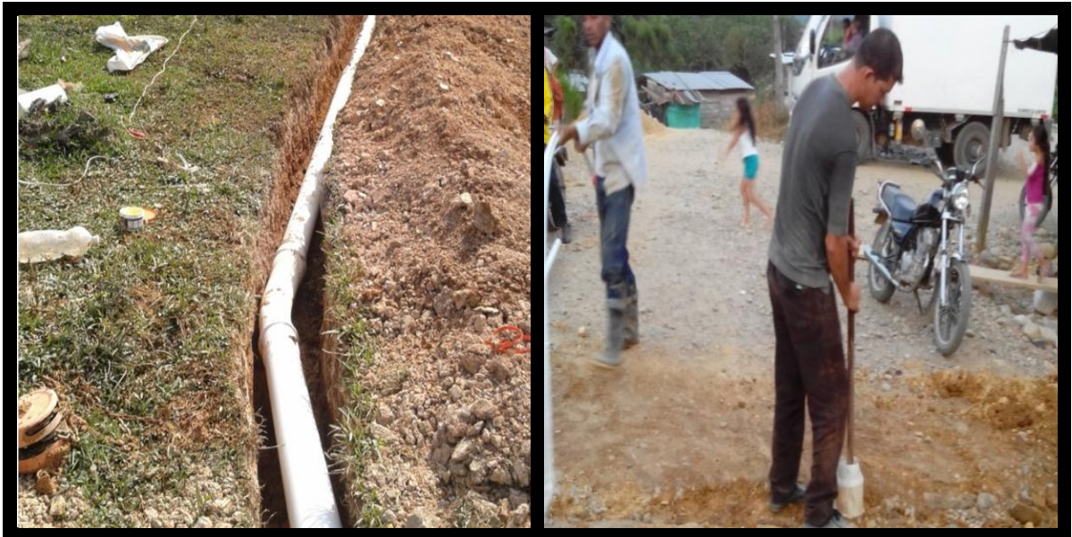
Fotografías N°3. Instalación de tubería.
