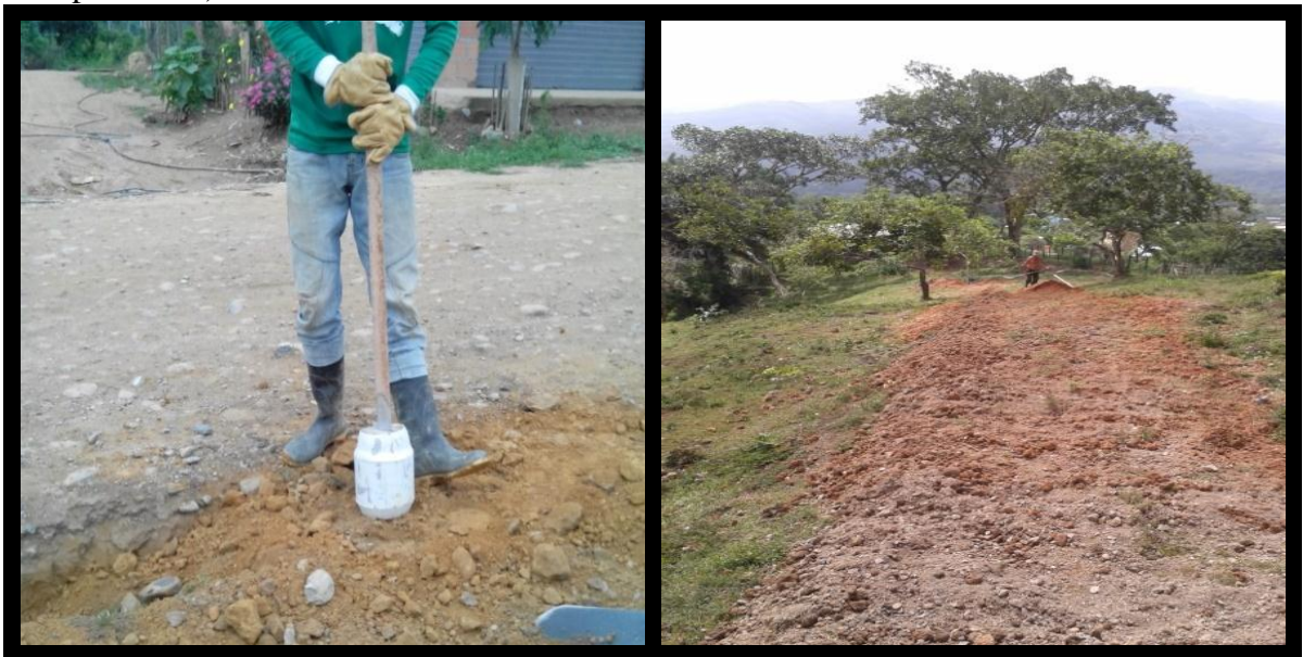
Fotografías N° 5. Relleno y compactación.
