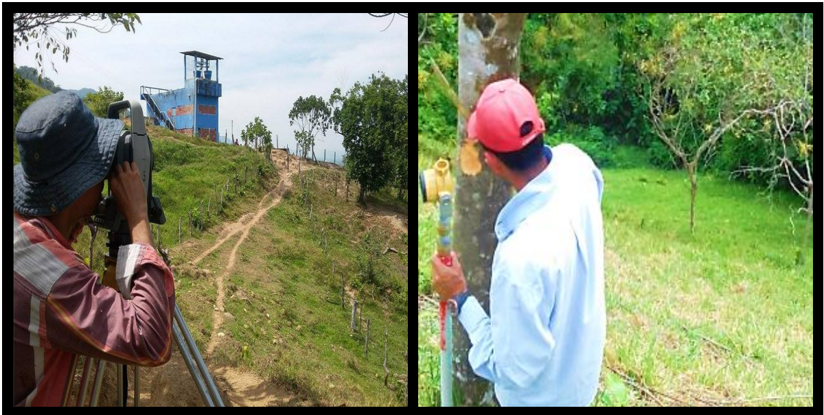
Fotografía N° 1. Nivelación y Replanteo.
